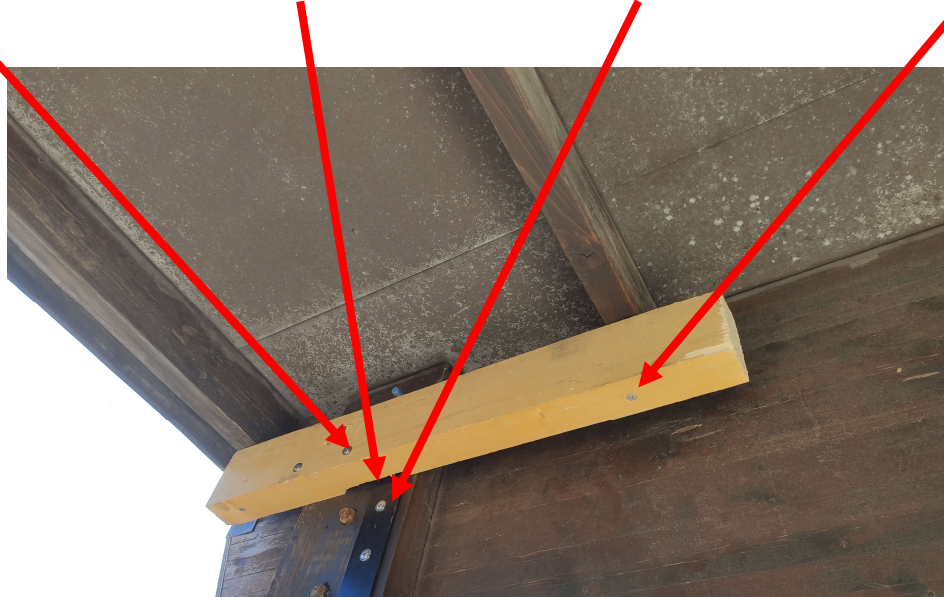
Figure 6 - Photo après intervention confortement panne égout
