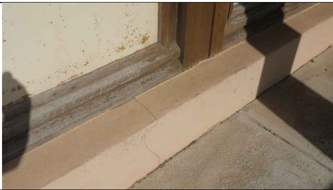
Fissuration de la longrine maçonnée, file 5/E.
