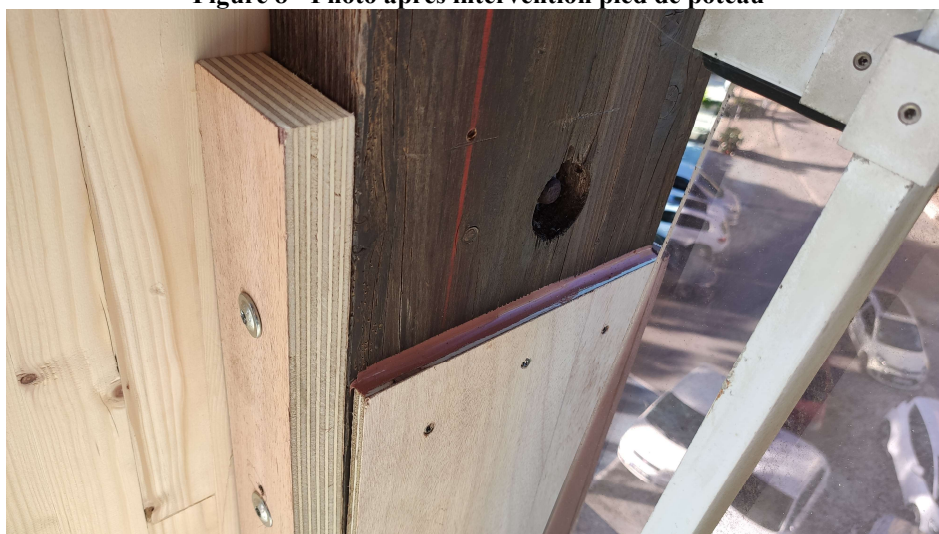
Figure 9 - Photo après intervention pied de poteau avec protection des pieds de poteaux et joint mastic
