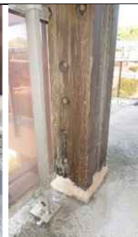
Pied de poteau, file 1, avec fortes dégradations.
