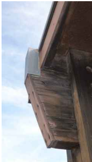
Arbalétrier, file 1, avec dégradations.
