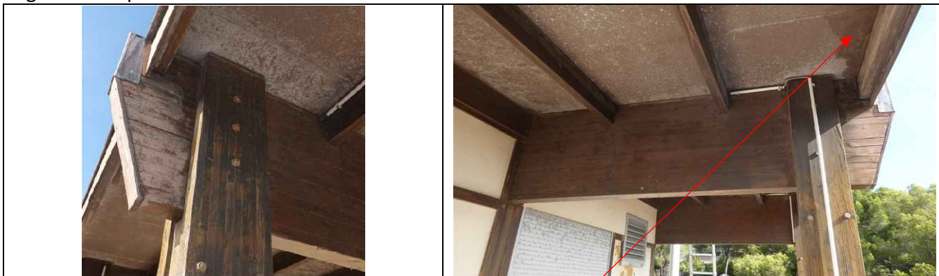
Arbalétrier file 2 avec des dégradations. Présence d'humidité sous le panneau bois.
