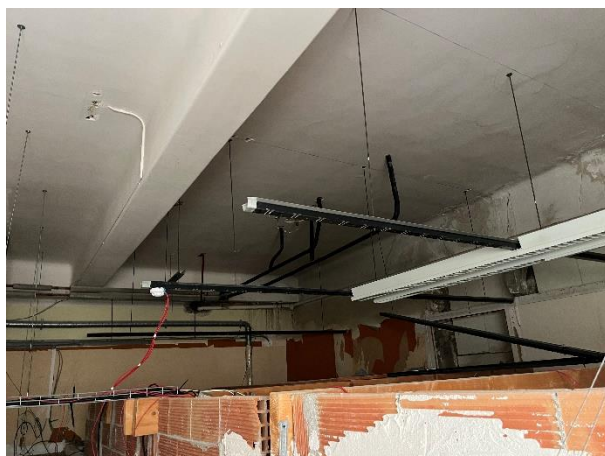
Photo 32 & 33 : Poutre béton 50x70ht du plancher de l'aile Ouest & plan de repérage des poutres béton
