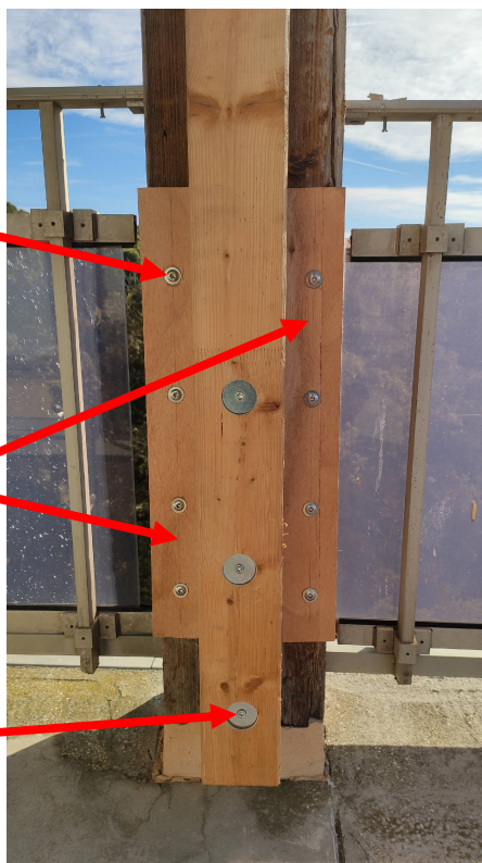
Figure 8 - Photo après intervention pied de poteau
