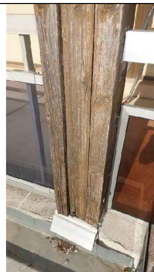
About des poteaux file 2 avec dégradations.
