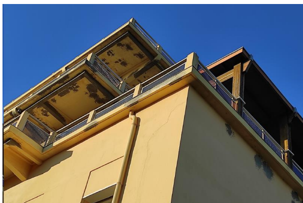
Photo 24 : Fissure angle Sud-Est
