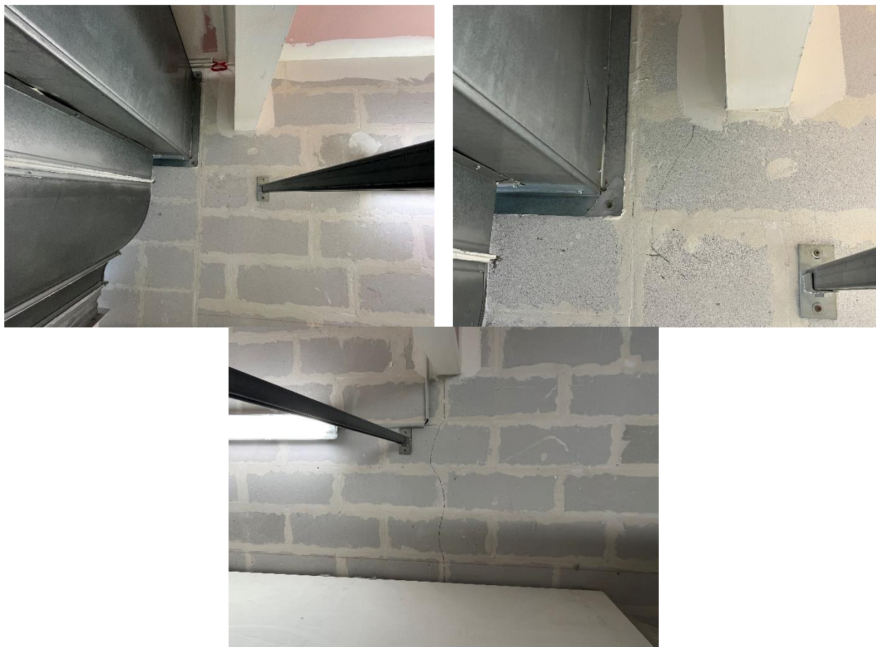
Photo 21 à 23 : Fissure mur local CTA
