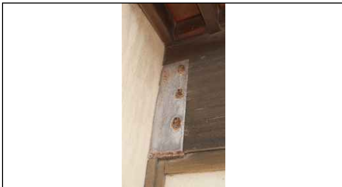
Fixation des arbalétriers contre le mur béton. Platine corrodée.
