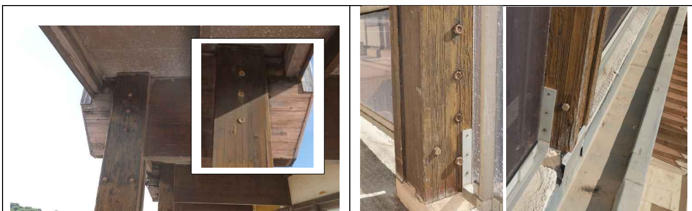
Arbalétrier file 4 avec dégradations.
