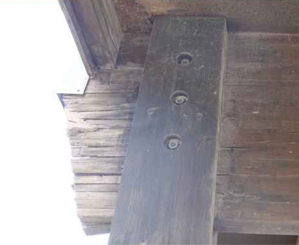
Arbalétrier, file 5, avec de fortes dégradations. Panneaux support de couverture très dégradé.
