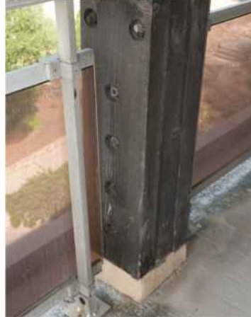
Pied de poteau, file 5, faiblement dégradé.
