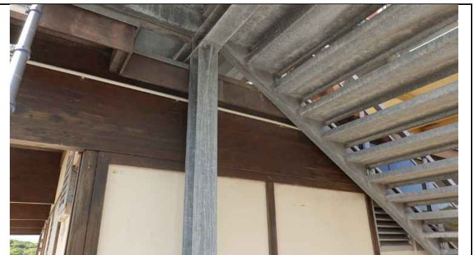
Un escalier métallique est disposé contre la structure bois sans la solliciter, et le bandeau a été modifié : raccourcissement des pannes.
