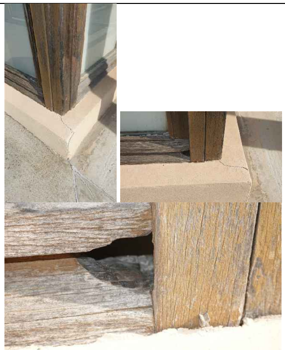
Fissuration de la longrine maçonnée, file 6/E. Présence d'un trou dans la menuiserie. Ancien départ de feu ?
