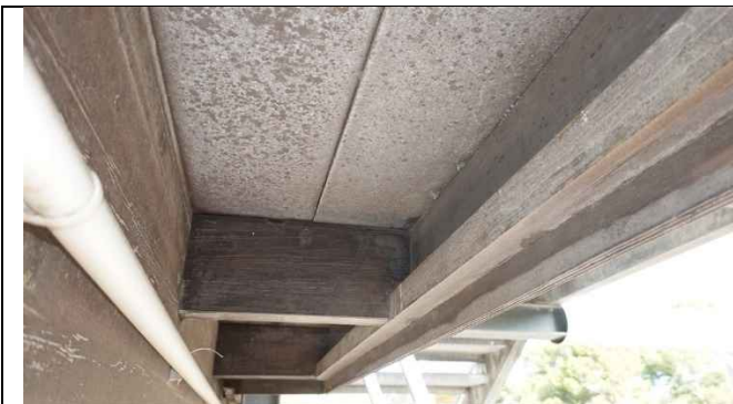
Les pannes débordent au droit des rives et supportent un bandeau bois en contreplaqué
