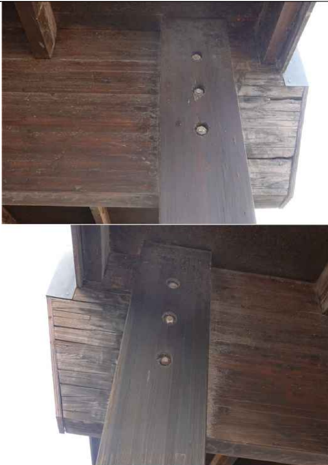
Arbalétrier, file 3, avec dégradations.
