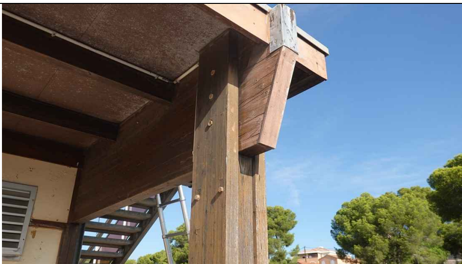
Fissures que l'on retrouve sur l'autre face. On peut noter la présence d'une protection d'about d'arbalétrier réalisée en zinc.
