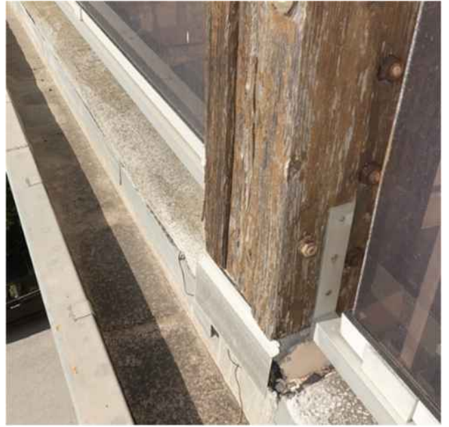
Pied de poteau, file 5, avec dégradations.
