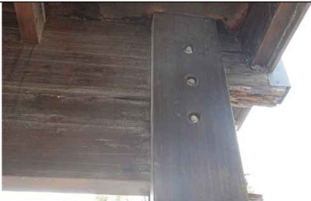
Arbalétrier, file 5, avec de fortes dégradations. Panneaux support de couverture très dégradé.
