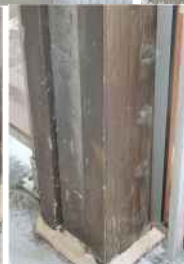
Pied de poteau, file 2, avec fortes dégradations.
