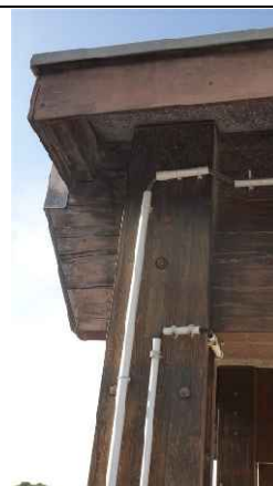
About d'arbalétrier avec fissurations : dégradations.
