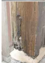
Pied de poteau, file 2, avec fortes dégradations.
