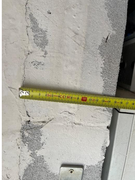
Photo 28 : Epaisseur beton cellulaire 15cm
