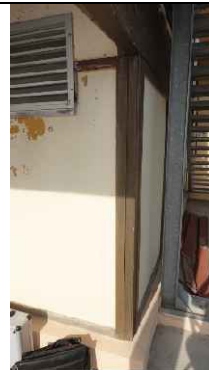
Potelet en appui sur longrine maçonnée.
