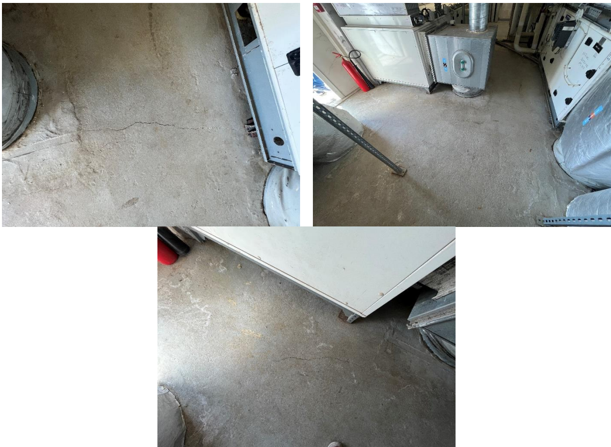
Photo 18 à 20 : Fissure dalle local CTA
