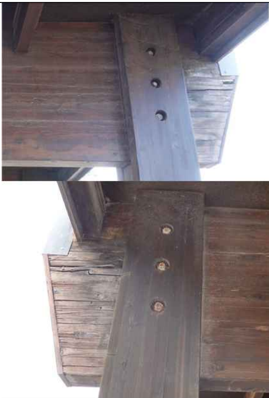
Arbalétrier, file 4, avec dégradations.
