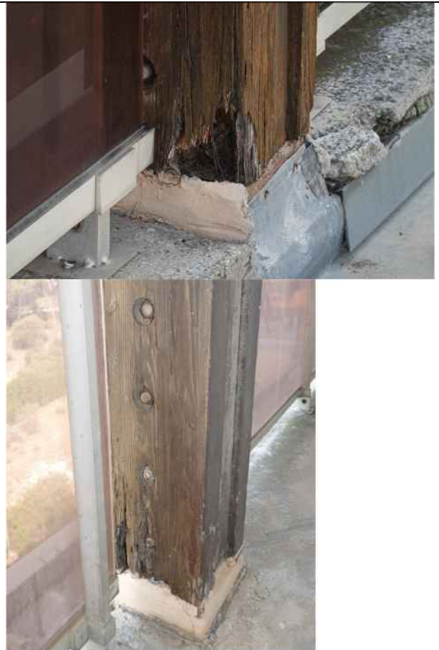
Pied de poteau, file 3, avec de fortes dégradations, des deux côtés.
