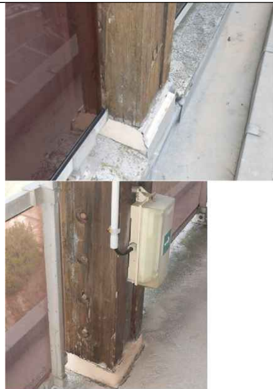
Pied de poteau, file 4, faiblement dégradé.
