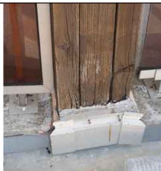
Pied de poteau, file 1, avec fortes dégradations.
