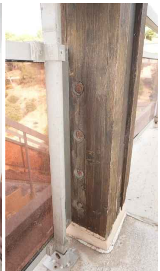
Pied de poteau, file 1, avec fortes dégradations.
