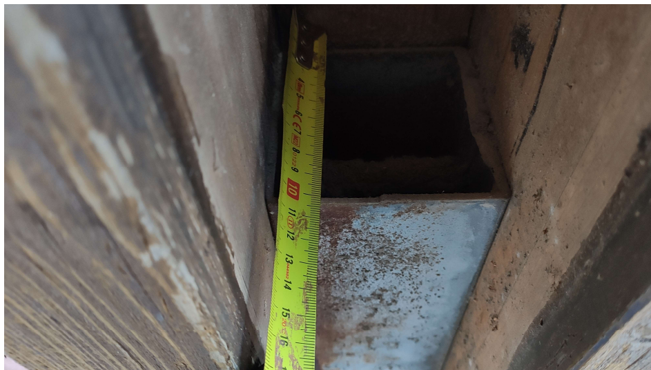
Figure 3 - Photo du vide entre poteaux bois
