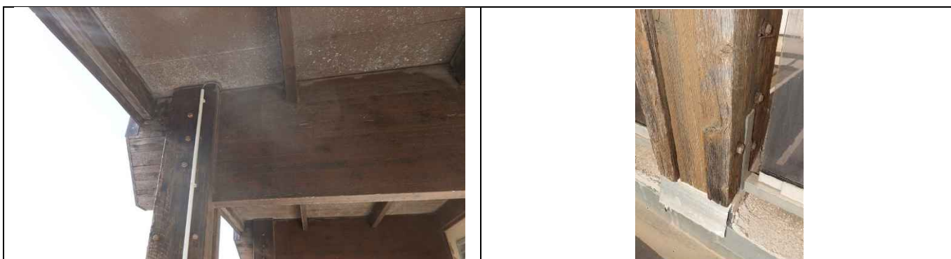
Arbalétrier file 3 avec dégradations.
