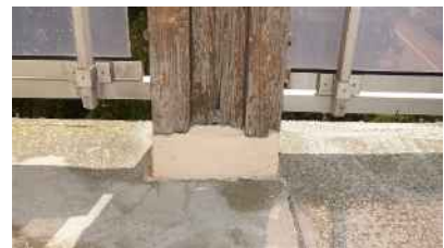
Pied de poteau, file 6, avec dégradations.
