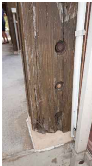
Pied de poteau, file 1, avec fortes dégradations.
