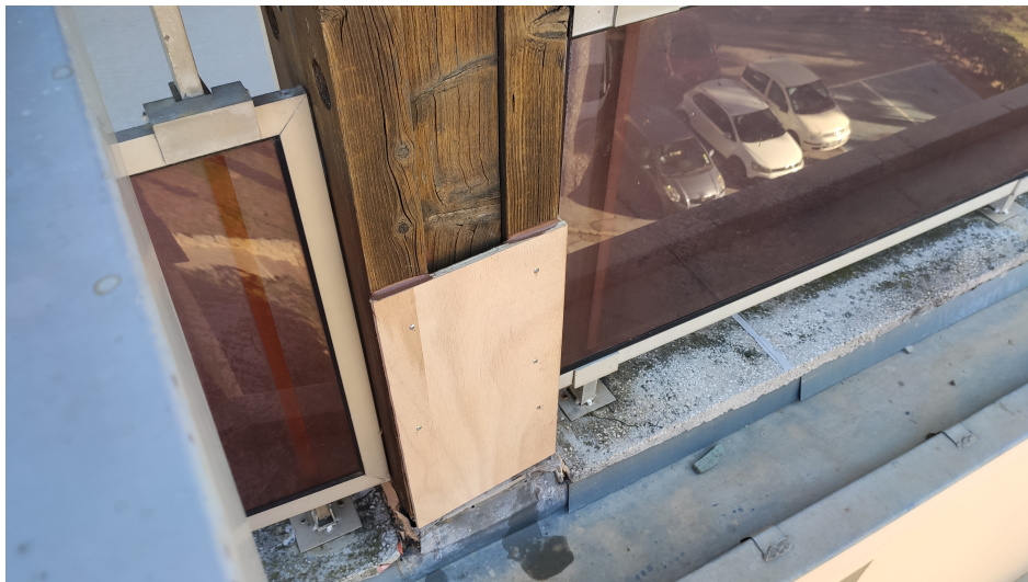
Figure 10 - Photo après intervention pied de poteau avec protection des pieds de poteaux et joint mastic
