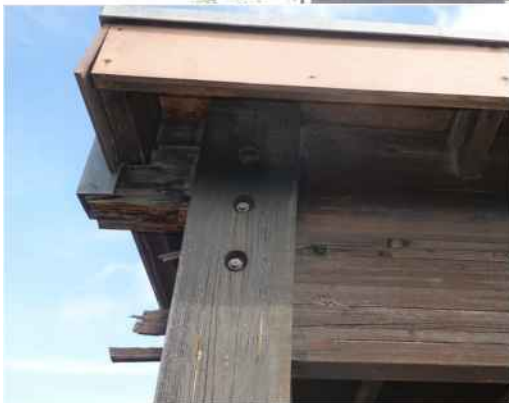
Arbalétrier, file 6, avec de très fortes dégradations.
