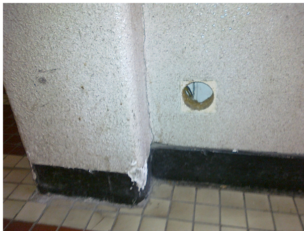
Exemple paroi verticale : panneaux agglomérés bois ép. 50 mm
