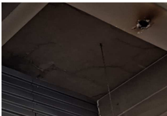
Faïençage en sous-face de dalle haute du RDC
