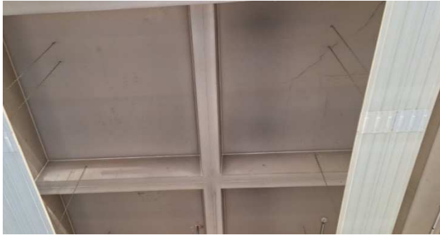
Présence de fissures en sous-face de dalle haute du RDC
