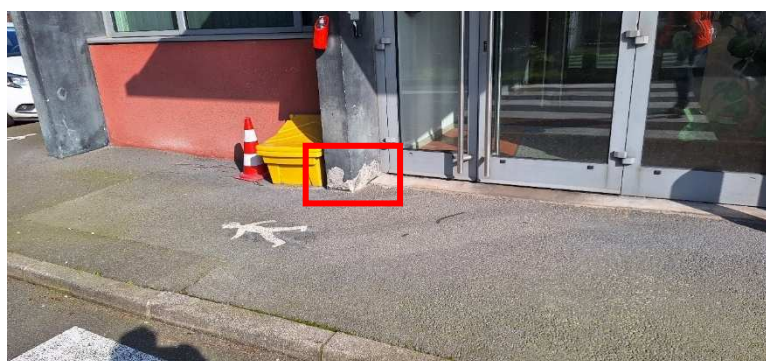
Dégradation de l'enduit en bas de poteau en béton (Annexe du bâtiment A/L10)
