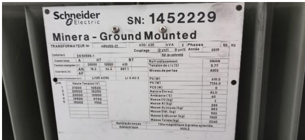
Plaque signalétique du transformateur HT/BT
