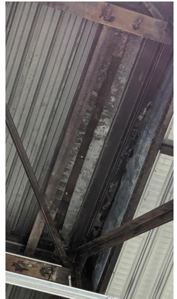
Traces d'infiltration en sous face de la partie centrale
