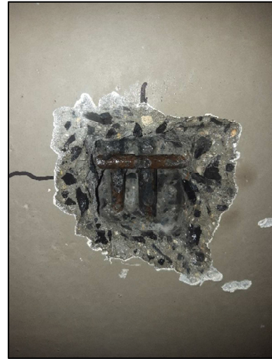
Photos des sondages en sous face de la dalle
