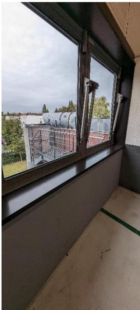
Châssis de désenfumage En façade au R+1
