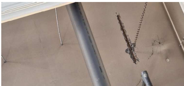
Acier apparent corrodé en sous-face de dalle haute du RDC
