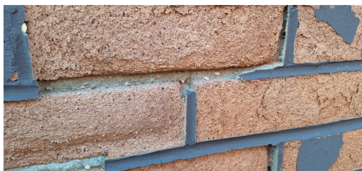
Absence partielle du revêtement de peinture sur les briques : généralisé à tout le bâtiment
