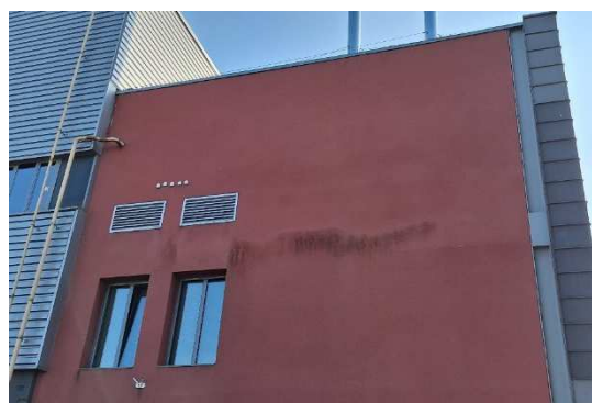
Présence d'humidité sur les façades nord et sud de l'annexe du bâtiment A/L10. Cette humidité peut être liée à la présence d'un pont thermique.
