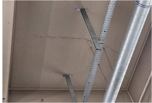
Présence de fissures en sous-face de dalle haute du RDC
