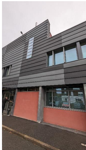
Maçonneries de remplissage dans la hauteur du rez-de-chaussée
