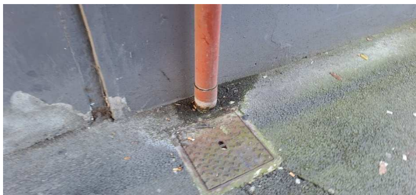
Défaut de l'évacuation des eaux pluviales entraînant une stagnation d'eau et l'apparition de végétation
