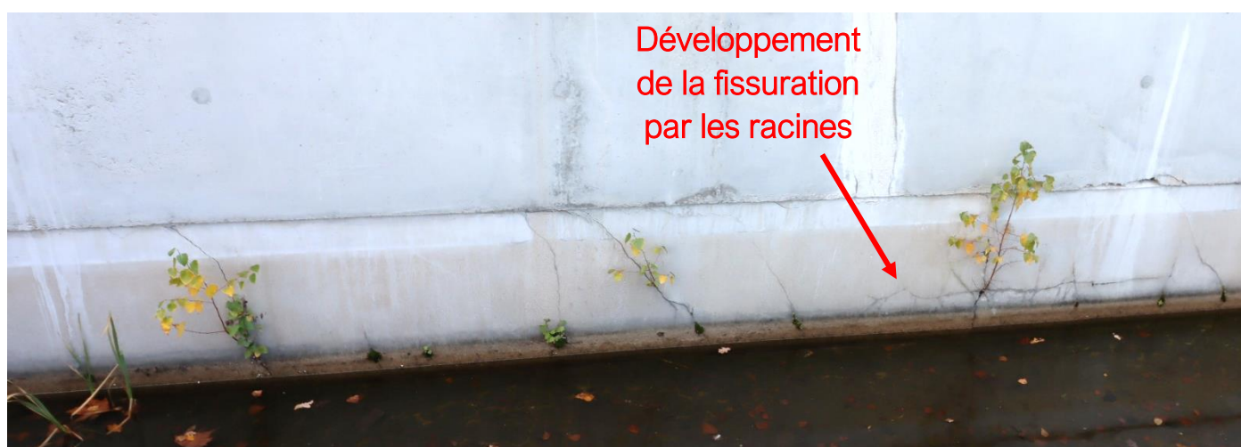
Figure 4 – Mise en valeur de la végétation dans les fissures.
