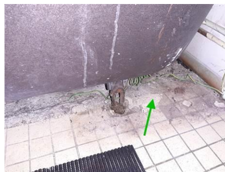
Matériaux : ZPSO-014 Prélèvement : P014 Description : Colle de carrelage Localisation : 2ème étage Logement 05 - SDB; 2ème étage Logement 05 - WC Résultat : Absence d'amiante
