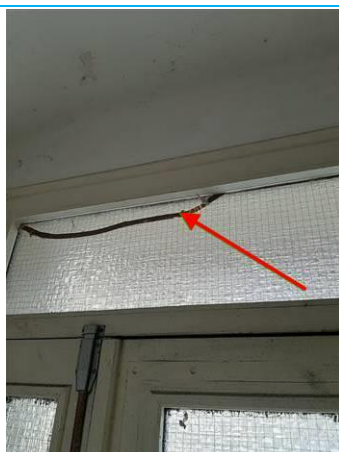
Matériaux : ZPSO-024 Prélèvement : P024 Description : Joint de mastic de vitrage marron Localisation : Rez de chaussée - Parties communes Résultat : Présence d'amiante
