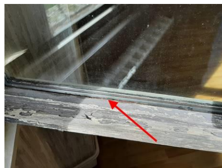
Matériaux : ZPSO-011 Prélèvement : P011 Description : Joint de mastic de vitrage Localisation : 2ème étage - Salon / Séjour Résultat : Présence d'amiante
