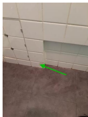
Matériaux : ZPSO-007 Prélèvement : P014 Description : Colle de faïence blanche Localisation : Logement 03 RDC - SDB Résultat : Absence d'amiante
