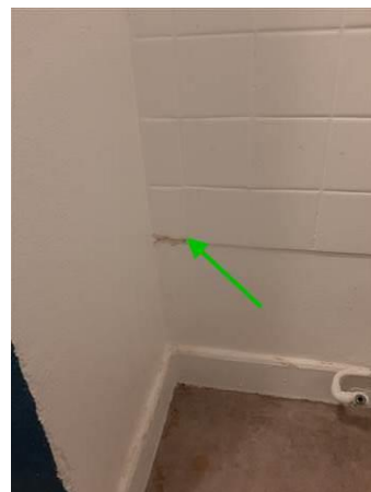
Matériaux : ZPSO-014 Prélèvement : P014 Description : Colle de faïence blanche Localisation : Bâtiment 11 Logement 02 1er étage - SDB Résultat : Absence d'amiante
