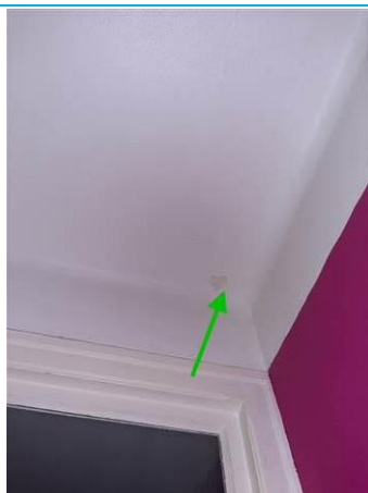
Matériaux : ZPSO-013 Prélèvement : P013 Description : Enduit à base de plâtre Localisation : Logement 02 au RDC - WC Résultat : Absence d'amiante
