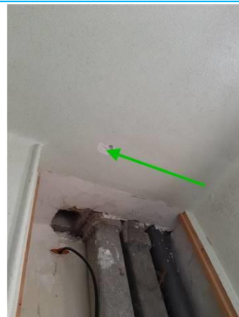
Matériaux : ZPSO-007 Prélèvement : P007 Description : Enduit à base de plâtre Localisation : 2ème étage - WC Résultat : Absence d'amiante
