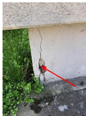
Matériaux : ZPSO-018 Prélèvement : P018 Description : Enduit extérieur + peinture Localisation : Extérieur - Façades bât 42-43 Résultat : Présence d'amiante
