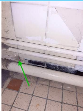
Matériaux : ZPSO-003 Prélèvement : P003 Description : Colle de plinthes Localisation : Rez de chaussée Logement 01 - SDB Résultat : Absence d'amiante
