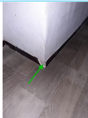
Matériaux : ZPSO-016 Prélèvement : P016 Description : Colle de plinthes noires Localisation : Logement 02 au RDC - SDB Résultat : Absence d'amiante
