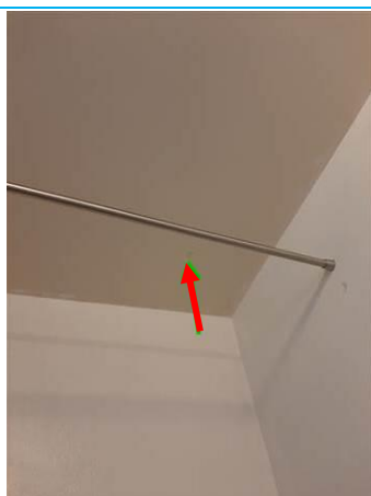
Matériaux : ZPSO-015 Prélèvement : P015 Description : Enduit à base de plâtre Localisation : Rez de chaussée Logement 01 - SDB Résultat : Présence d'amiante
