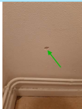
Matériaux : ZPSO-002 Prélèvement : P002 Description : Enduit à base de plâtre Localisation : Logement 01 RDC - SDB Résultat : Absence d'amiante
