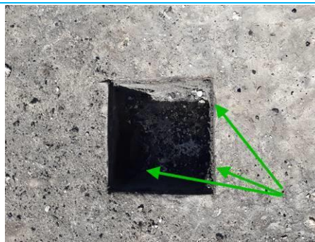
Matériaux : ZPSO-007 Prélèvement : P007 Description : Partie plane : pare vapeur Localisation : Extérieur - Toiture bât 44 Résultat : Absence d'amiante
