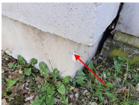
Matériaux : ZPSO-014 Prélèvement : P014 Description : Enduit extérieur + peinture Localisation : Extérieur - Façades bât 40 Résultat : Présence d'amiante
