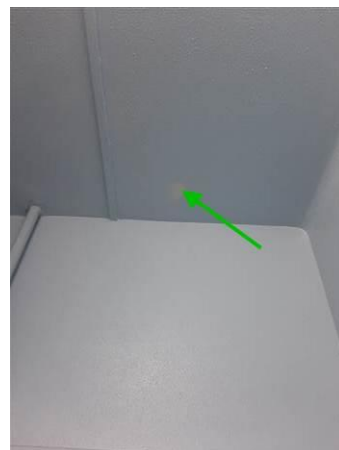
Matériaux : ZPSO-010 Prélèvement : P010 Description : Enduit à base de plâtre Localisation : Logement 08 au 1er étage - SDB Résultat : Absence d'amiante
