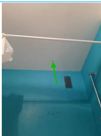
Matériaux : ZPSO-015 Prélèvement : P015 Description : Enduit à base de plâtre Localisation : 1er étage Logement 03 - SDB; 1er étage Logement 03 - WC Résultat : Absence d'amiante
