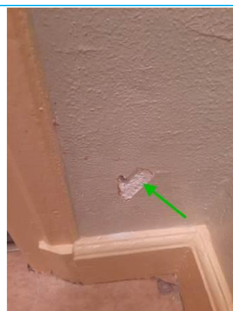
Matériaux : ZPSO-002 Prélèvement : P006 Description : Enduit à base de plâtre Localisation : Logement 01 RDC - WC Résultat : Absence d'amiante
