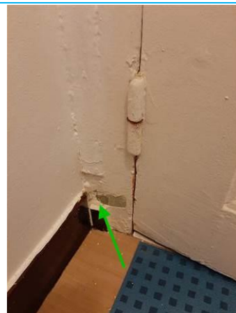
Matériaux : ZPSO-002 Prélèvement : P002 Description : Colle de plinthes noires Localisation : 1er étage - SDB gauche Résultat : Absence d'amiante
