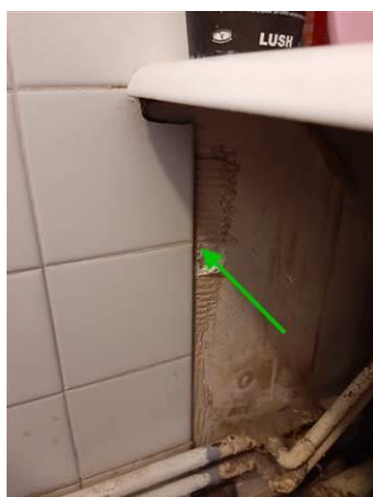
Matériaux : ZPSO-013 Prélèvement : P013 Description : Colle de faïence Localisation : Rez de chaussée Logement 01 - SDB Résultat : Absence d'amiante
