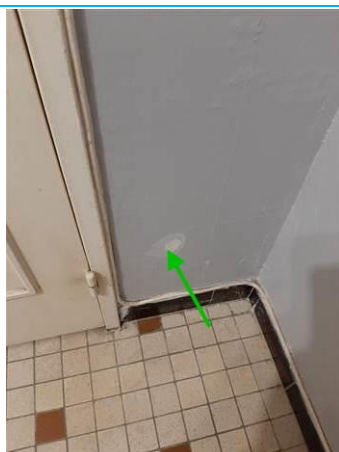
Matériaux : ZPSO-017 Prélèvement : P017 Description : Enduit à base de plâtre Localisation : 2ème étage Logement 05 - SDB; 2ème étage Logement 05 - WC Résultat : Absence d'amiante
