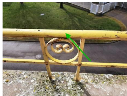
Matériaux : ZPSO-009 Prélèvement : P009 Description : Peinture décorative sur garde corps Localisation : 2ème étage - Salon / Séjour Résultat : Absence d'amiante
