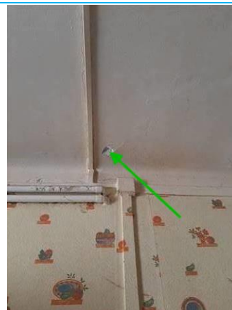
Matériaux : ZPSO-002 Prélèvement : P002 Description : Enduit à base de plâtre + peinture Localisation : 2ème étage - Cuisine Résultat : Absence d'amiante
