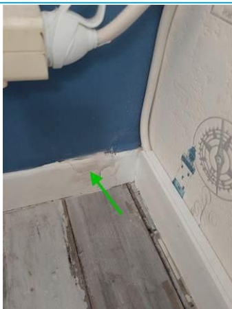
Matériaux : ZPSO-001 Prélèvement : P001 Description : Colle de plinthes Localisation : 1er étage Logement 02 - SDB; 1er étage Logement 02 - WC Résultat : Absence d'amiante
