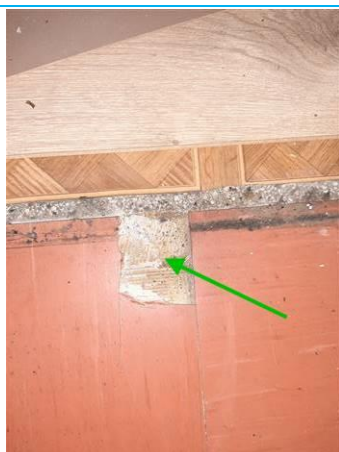
Matériaux : ZPSO-018 Prélèvement : P018 Description : Dalle de sol rouge + colle Localisation : 2ème étage - Parties communes Résultat : Absence d'amiante
