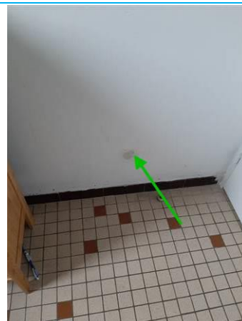
Matériaux : ZPSO-010 Prélèvement : P010 Description : Enduit à base de plâtre Localisation : 1er étage Logement 04 - SDB; 1er étage Logement 04 - WC Résultat : Absence d'amiante
