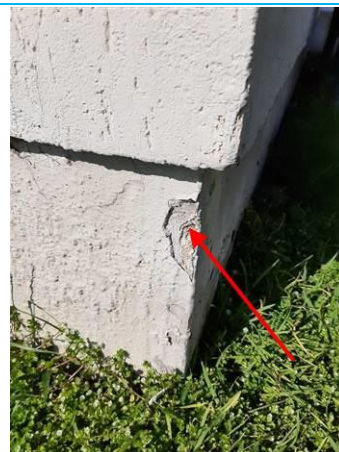
Matériaux : ZPSO-011 Prélèvement : P011 Description : Enduit extérieur + peinture Localisation : Extérieur - Façades bât 41 Résultat : Présence d'amiante
