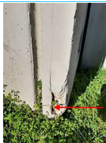
Matériaux : ZPSO-009 Prélèvement : P009 Description : Crépis extérieur + peinture Localisation : Extérieur - Façades bât 44 Résultat : Présence d'amiante
