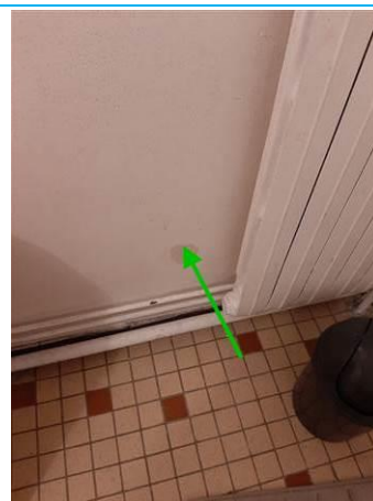
Matériaux : ZPSO-008 Prélèvement : P008 Description : Enduit à base de plâtre Localisation : 2ème étage Logement 04 - SDB; 2ème étage Logement 04 - WC Résultat : Absence d'amiante
