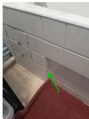
Matériaux : ZPSO-007 Prélèvement : P010 Description : Colle de faïence blanche Localisation : Logement 02 RDC - SDB Résultat : Absence d'amiante
