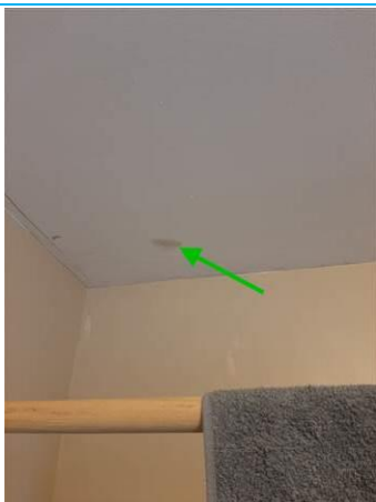
Matériaux : ZPSO-009 Prélèvement : P009 Description : Enduit à base de plâtre Localisation : 1er étage Logement 04 - SDB Résultat : Absence d'amiante
