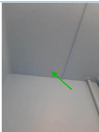
Matériaux : ZPSO-008 Prélèvement : P011 Description : Enduit à base de plâtre Localisation : Logement 02 RDC - SDB; Logement 02 RDC - WC Résultat : Absence d'amiante
