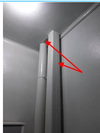
Matériaux : ZPSO-020 Prélèvement : / Description : Conduit en amiante ciment au dessus des grilles de ventilation Localisation : Logement 06 au RDC - SDB; Logement 06 au RDC - WC; Logement 08 au 1er étage - SDB; Logement 08 au 1er étage - WC; Logement 02 au RDC - SDB; Logement 02 au RDC - WC Résultat : Présence d'amiante
