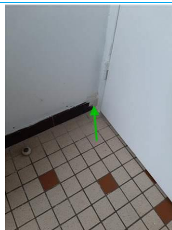
Matériaux : ZPSO-008 Prélèvement : P008 Description : Colle de plinthes Localisation : 1er étage Logement 04 - SDB; 1er étage Logement 04 - WC Résultat : Absence d'amiante
