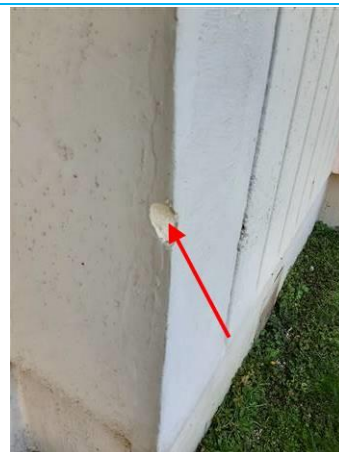
Matériaux : ZPSO-013 Prélèvement : P013 Description : Enduit extérieur + peinture Localisation : Extérieur - Façades bât 41 Résultat : Présence d'amiante
