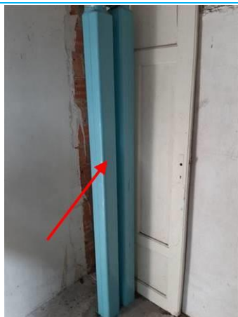
Matériaux : ZPSO-007 Prélèvement : Description : Conduits en fibres-ciment Localisation : Combles - Grenier Résultat : Présence d'amiante
