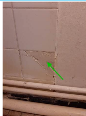
Matériaux : ZPSO-004 Prélèvement : P004 Description : Colle de faïence Localisation : Rez de chaussée Logement 01 - SDB Résultat : Absence d'amiante
