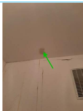
Matériaux : ZPSO-012 Prélèvement : P012 Description : Enduit à base de plâtre Localisation : 1er étage Logement 04 - WC Résultat : Absence d'amiante
