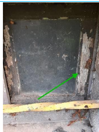
Matériaux : ZPSO-023 Prélèvement : P023 Description : Joint de mastic de vitrage Localisation : Extérieur - Façades Résultat : Absence d'amiante
