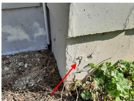
Matériaux : ZPSO-010 Prélèvement : P010 Description : Enduit extérieur + peinture Localisation : Extérieur - Façades bât 44 Résultat : Présence d'amiante
