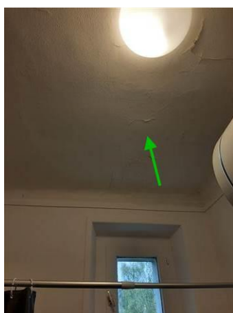
Matériaux : ZPSO-009 Prélèvement : P015 Description : Enduit à base de plâtre Localisation : Logement 8 1er étage - SDB; Logement 8 1er étage - WC Résultat : Absence d'amiante
