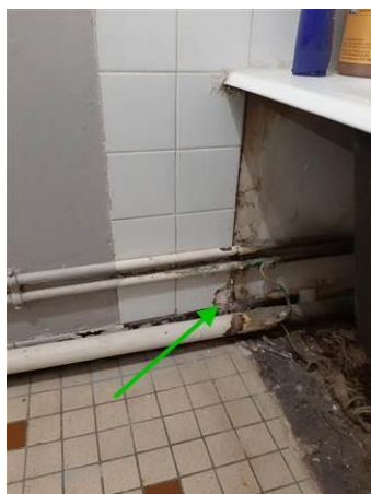
Matériaux : ZPSO-015 Prélèvement : P015 Description : Colle de faïence Localisation : 2ème étage Logement 05 - SDB Résultat : Absence d'amiante
