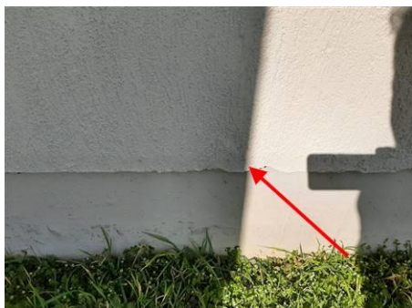
Matériaux : ZPSO-012 Prélèvement : P012 Description : Crépis extérieur + peinture Localisation : Extérieur - Façades bât 41 Résultat : Présence d'amiante
