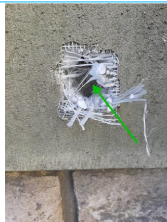
Matériaux : ZPSO-021 Prélèvement : P021 Description : Enduit projeté sur ITE Localisation : Extérieur - Façades Résultat : Absence d'amiante
