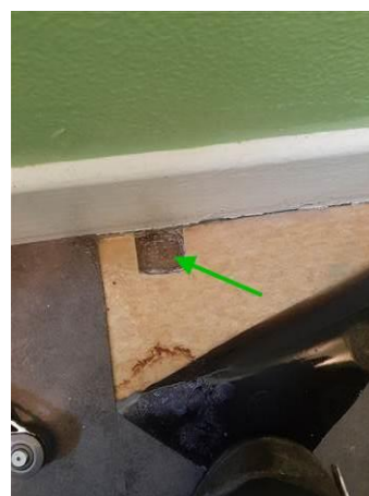
Matériaux : ZPSO-005 Prélèvement : P012 Description : Ragrée sous lino Localisation : Logement 03 RDC - SDB; Logement 03 RDC - WC Résultat : Absence d'amiante
