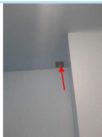
Matériaux : ZPSO-009 Prélèvement : / Description : Conduit en amiante ciment au dessus des grilles de ventilation Localisation : Logement 01 RDC - SDB; Logement 01 RDC - WC; Logement 02 RDC - SDB; Logement 02 RDC - WC; Logement 03 RDC - SDB; Logement 03 RDC - WC Résultat : Présence d'amiante
