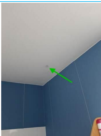
Matériaux : ZPSO-003 Prélèvement : P003 Description : Enduit à base de plâtre Localisation : 1er étage Logement 02 - SDB; 1er étage Logement 02 - WC Résultat : Absence d'amiante
