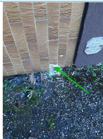
Matériaux : ZPSO-014 Prélèvement : P014 Description : Colle de carrelage marron Localisation : Pavillon 38 - Façade Résultat : Absence d'amiante
