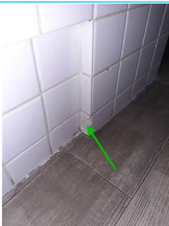
Matériaux : ZPSO-017 Prélèvement : P017 Description : Colle de faïence blanche Localisation : Logement 02 au RDC - SDB Résultat : Absence d'amiante
