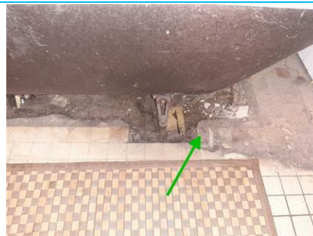
Matériaux : ZPSO-010 Prélèvement : P010 Description : Colle de carrelage Localisation : Rez de chaussée Logement 01 - SDB; Rez de chaussée Logement 01 - WC Résultat : Absence d'amiante
