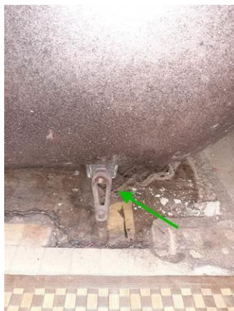
Matériaux : ZPSO-011 Prélèvement : P011 Description : Isolant intérieur fibreux sous baignoire Localisation : Rez de chaussée Logement 01 - SDB Résultat : Absence d'amiante
