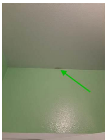
Matériaux : ZPSO-008 Prélèvement : P015 Description : Enduit à base de plâtre Localisation : Logement 03 RDC - SDB Résultat : Absence d'amiante
