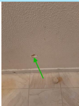
Matériaux : ZPSO-007 Prélèvement : P007 Description : Enduit à base de plâtre Localisation : Bâtiment 11 Logement 07 RDC - SDB Résultat : Absence d'amiante
