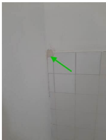
Matériaux : ZPSO-009 Prélèvement : P009 Description : Colle de faïence Localisation : 1er étage Logement 04 - SDB Résultat : Absence d'amiante
