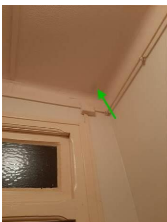
Matériaux : ZPSO-004 Prélèvement : P011 Description : Enduit à base de plâtre Localisation : Logement 7 RDC - WC Résultat : Absence d'amiante
