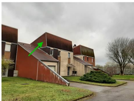
Matériaux : ZPSO-011 Prélèvement : P011 Description : Ardoises composites rouges Localisation : Pavillon 38 - Toiture Résultat : Absence d'amiante
