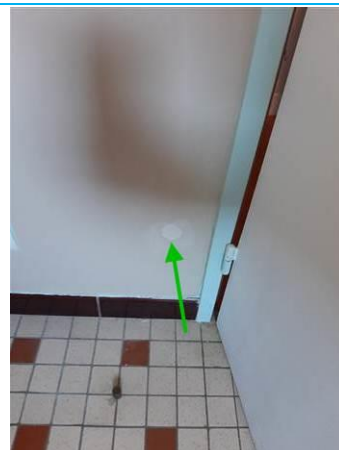
Matériaux : ZPSO-008 Prélèvement : P008 Description : Enduit à base de plâtre Localisation : 1er étage Logement 04 - SDB Résultat : Absence d'amiante
