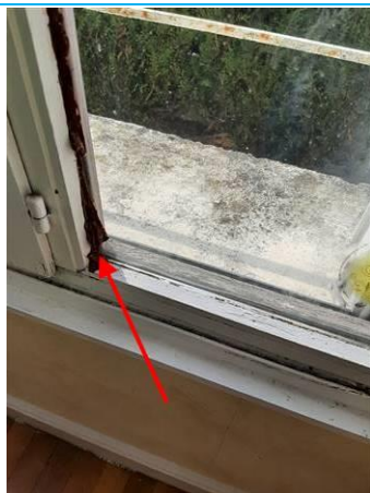
Matériaux : ZPSO-001 Prélèvement : P001 Description : Joint de mastic de vitrage marron Localisation : Rez de chaussée - Séjour Résultat : Présence d'amiante
