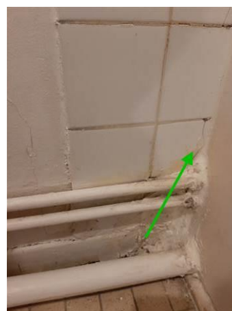
Matériaux : ZPSO-010 Prélèvement : P010 Description : Colle de faïence Localisation : Rez de chaussée Logement 02 - SDB Résultat : Absence d'amiante
