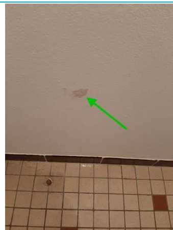
Matériaux : ZPSO-011 Prélèvement : P011 Description : Enduit à base de plâtre Localisation : 1er étage Logement 04 - WC Résultat : Absence d'amiante
