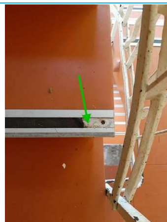
Matériaux : ZPSO-019 Prélèvement : P019 Description : Nez de marche Localisation : 2ème étage - Parties communes Résultat : Absence d'amiante
