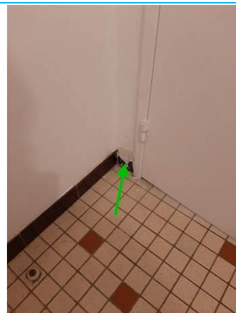
Matériaux : ZPSO-006 Prélèvement : P006 Description : Colle de plinthes Localisation : 2ème étage Logement 04 - SDB; 2ème étage Logement 04 - WC Résultat : Absence d'amiante
