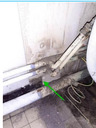
Matériaux : ZPSO-012 Prélèvement : P012 Description : Colle de plinthes Localisation : Rez de chaussée Logement 01 - SDB; Rez de chaussée Logement 01 - WC Résultat : Absence d'amiante
