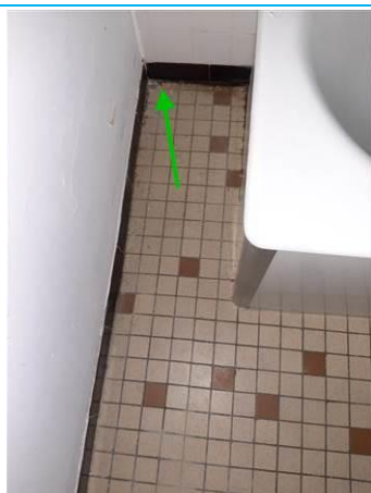
Matériaux : ZPSO-007 Prélèvement : P007 Description : Colle de carrelage Localisation : 1er étage Logement 04 - SDB; 1er étage Logement 04 - WC Résultat : Absence d'amiante
