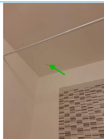
Matériaux : ZPSO-006 Prélèvement : P006 Description : Enduit à base de plâtre Localisation : Rez de chaussée Logement 01 - SDB; Rez de chaussée Logement 01 - WC Résultat : Absence d'amiante
