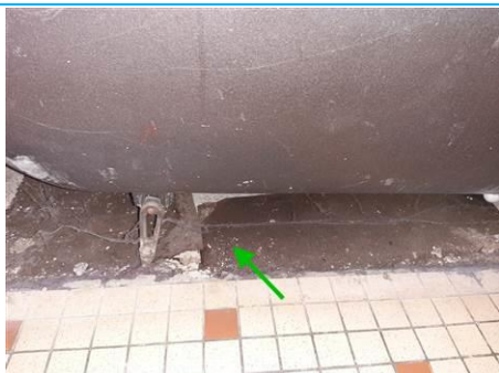
Matériaux : ZPSO-001 Prélèvement : P001 Description : Colle de carrelage Localisation : Rez de chaussée Logement 01 - SDB; Rez de chaussée Logement 01 - WC Résultat : Absence d'amiante
