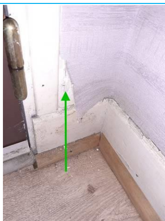
Matériaux : ZPSO-016 Prélèvement : P016 Description : Enduit à base de plâtre Localisation : 2ème étage - Entrée Résultat : Absence d'amiante
