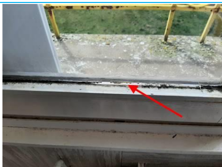
Matériaux : ZPSO-010 Prélèvement : P010 Description : Joint de mastic de vitrage Localisation : 2ème étage - SDB; 2ème étage - Chambre 3; 2ème étage - Chambre 2; 2ème étage - Chambre 1; 2ème étage - Salon / Séjour; 2ème étage - Cuisine; 2ème étage - Parties communes; Rez de chaussée - Parties communes Résultat : Présence d'amiante
