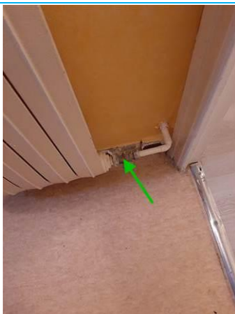
Matériaux : ZPSO-013 Prélèvement : P013 Description : Colle de plinthes noires Localisation : Bâtiment 11 Logement 02 1er étage - SDB; Bâtiment 11 Logement 02 1er étage - WC Résultat : Absence d'amiante
