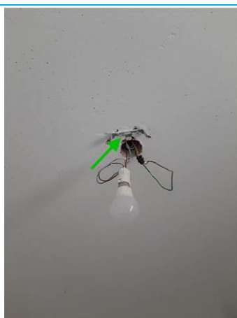
Matériaux : ZPSO-011 Prélèvement : P011 Description : Enduit à base de plâtre Localisation : 1er étage Logement 04 - SDB; 1er étage Logement 04 - WC Résultat : Absence d'amiante
