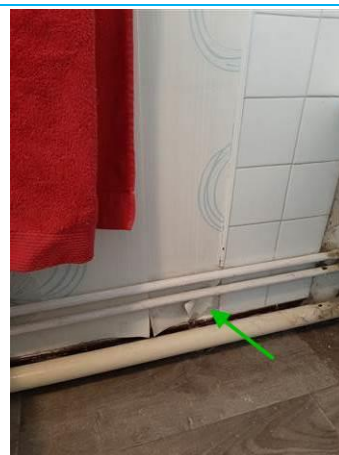
Matériaux : ZPSO-004 Prélèvement : P004 Description : Enduit à base de plâtre Localisation : 1er étage Logement 03 - SDB; 1er étage Logement 03 - WC Résultat : Absence d'amiante
