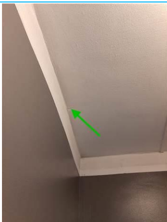
Matériaux : ZPSO-004 Prélèvement : P009 Description : Enduit à base de plâtre Localisation : Logement 7 RDC - SDB Résultat : Absence d'amiante
