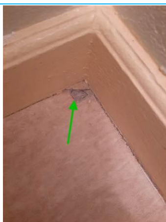
Matériaux : ZPSO-001 Prélèvement : P005 Description : Ragréage sous lino Localisation : Logement 01 RDC - WC Résultat : Absence d'amiante
