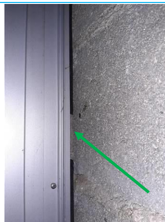
Matériaux : ZPSO-004 Prélèvement : P004 Description : Joint d'étanchéité entre menuiserie et structure Localisation : Pavillon 38 1er étage - Grenier Résultat : Absence d'amiante
