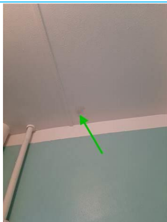
Matériaux : ZPSO-005 Prélèvement : P005 Description : Enduit à base de plâtre Localisation : Logement 06 au RDC - SDB; Logement 06 au RDC - WC Résultat : Absence d'amiante
