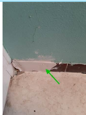
Matériaux : ZPSO-002 Prélèvement : P002 Description : Colle de plinthes Localisation : Logement 06 au RDC - SDB; Logement 06 au RDC - WC Résultat : Absence d'amiante
