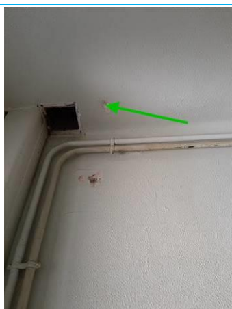
Matériaux : ZPSO-003 Prélèvement : P003 Description : Enduit à base de plâtre Localisation : 2ème étage - Sanitaires Résultat : Absence d'amiante
