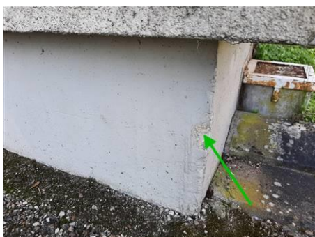
Matériaux : ZPSO-008 Prélèvement : P008 Description : Enduit extérieur + peinture Localisation : Extérieur - Façades bât 44 Résultat : Absence d'amiante
