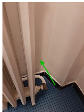
Matériaux : ZPSO-003 Prélèvement : P004 Description : Enduit à base de plâtre Localisation : 1er étage - SDB gauche Résultat : Absence d'amiante
