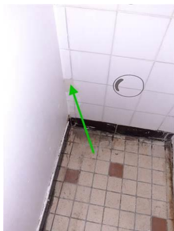
Matériaux : ZPSO-007 Prélèvement : P007 Description : Colle de faïence Localisation : 2ème étage Logement 04 - SDB Résultat : Absence d'amiante
