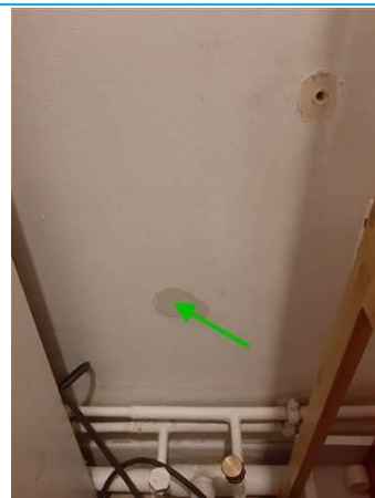
Matériaux : ZPSO-008 Prélèvement : P008 Description : Enduit à base de plâtre Localisation : Rez de chaussée Logement 02 - SDB; Rez de chaussée Logement 02 - WC Résultat : Absence d'amiante
