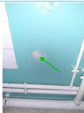
Matériaux : ZPSO-004 Prélèvement : P004 Description : Enduit à base de plâtre Localisation : Logement 06 au RDC - SDB; Logement 06 au RDC - WC Résultat : Absence d'amiante
