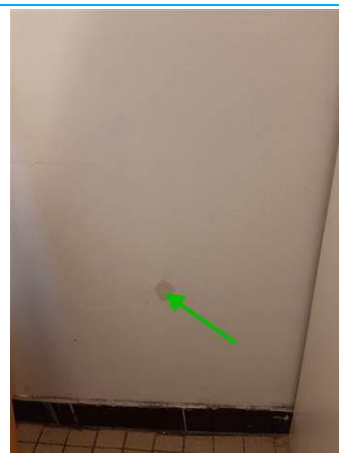
Matériaux : ZPSO-014 Prélèvement : P014 Description : Enduit à base de plâtre Localisation : Rez de chaussée Logement 01 - SDB; Rez de chaussée Logement 01 - WC Résultat : Absence d'amiante
