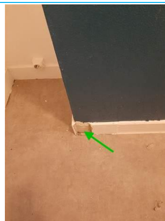
Matériaux : ZPSO-016 Prélèvement : P016 Description : Colle de plinthes Localisation : Bâtiment 11 Logement 02 1er étage - SDB Résultat : Absence d'amiante
