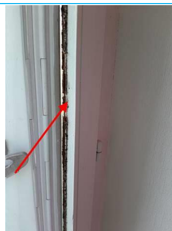
Matériaux : ZPSO-004 Prélèvement : P004 Description : Joint de mastic de vitrage marron Localisation : 1er étage - Chambre 1 Résultat : Présence d'amiante
