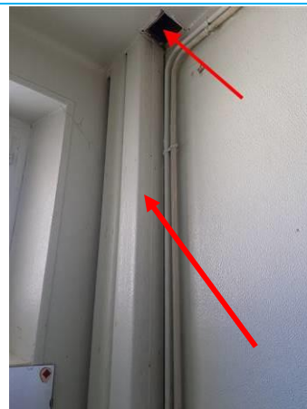
Matériaux : ZPSO-006 Prélèvement : P006 Description : Conduits en fibres-ciment Localisation : 2ème étage - SDB; 2ème étage - WC; 2ème étage - Sanitaires Résultat : Présence d'amiante
