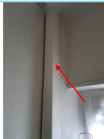
Matériaux : ZPSO-008 Prélèvement : Description : Conduit en fibres-ciment Localisation : Rez de chaussée - WC Résultat : Présence d'amiante
