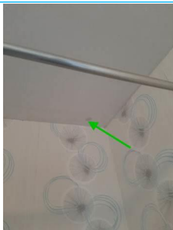
Matériaux : ZPSO-005 Prélèvement : P005 Description : Enduit à base de plâtre Localisation : 1er étage Logement 03 - SDB; 1er étage Logement 03 - WC Résultat : Absence d'amiante
