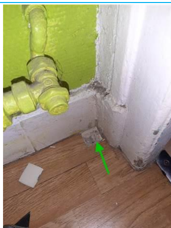
Matériaux : ZPSO-011 Prélèvement : P011 Description : Ragréage sous lino Localisation : Logement 02 au RDC - SDB; Logement 02 au RDC - WC Résultat : Absence d'amiante
