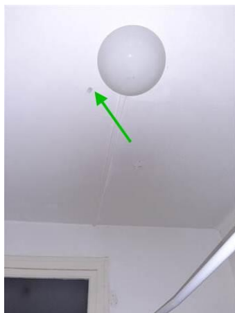
Matériaux : ZPSO-019 Prélèvement : P019 Description : Enduit à base de plâtre Localisation : Logement 02 au RDC - SDB Résultat : Absence d'amiante
