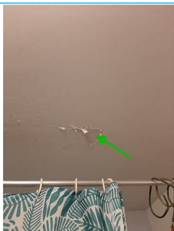
Matériaux : ZPSO-005 Prélèvement : P005 Description : Enduit à base de plâtre Localisation : Rez de chaussée Logement 01 - SDB; Rez de chaussée Logement 01 - WC Résultat : Absence d'amiante
