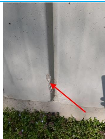
Matériaux : ZPSO-015 Prélèvement : P015 Description : Crépis extérieur + peinture Localisation : Extérieur - Façades bât 40 Résultat : Présence d'amiante
