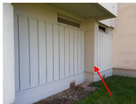
Matériaux : ZPSO-020 Prélèvement : P020 Description : Enduit extérieur + peinture Localisation : Extérieur - Façades bât 42-43 Résultat : Présence d'amiante
