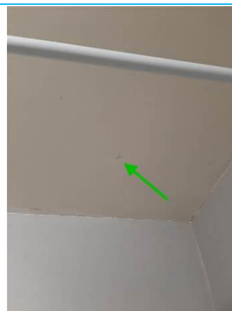
Matériaux : ZPSO-018 Prélèvement : P018 Description : Enduit à base de plâtre Localisation : 2ème étage Logement 05 - SDB; 2ème étage Logement 05 - WC Résultat : Absence d'amiante
