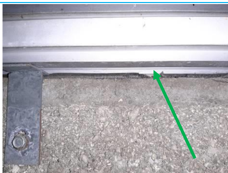
Matériaux : ZPSO-003 Prélèvement : P003 Description : Joint d'étanchéité entre menuiserie et structure Localisation : Pavillon 38 1er étage - Grenier Résultat : Absence d'amiante
