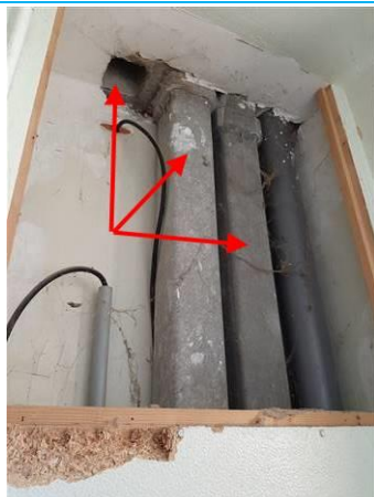
Matériaux : ZPSO-006 Prélèvement : P006 Description : Conduit en fibres-ciment Localisation : 2ème étage - SDB; 2ème étage - WC; 2ème étage - Sanitaires Résultat : Présence d'amiante
