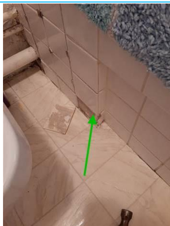
Matériaux : ZPSO-009 Prélèvement : P009 Description : Colle de faïence blanche Localisation : Bâtiment 11 Logement 07 RDC - SDB Résultat : Absence d'amiante
