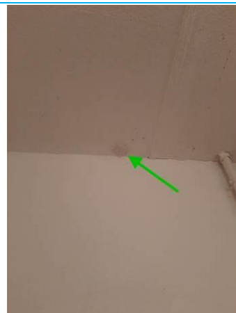
Matériaux : ZPSO-010 Prélèvement : P010 Description : Enduit à base de plâtre Localisation : Bâtiment 11 Logement 07 RDC - SDB Résultat : Absence d'amiante
