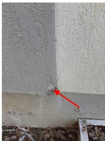
Matériaux : ZPSO-016 Prélèvement : P016 Description : Enduit extérieur + peinture Localisation : Extérieur - Façades bât 40 Résultat : Présence d'amiante
