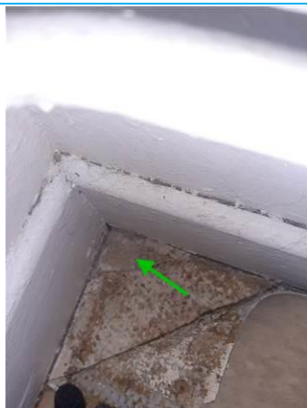
Matériaux : ZPSO-001 Prélèvement : P001 Description : Ragréage sous lino Localisation : Logement 01 RDC - SDB Résultat : Absence d'amiante
