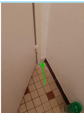
Matériaux : ZPSO-010 Prélèvement : P010 Description : Colle de plinthes noires Localisation : 1er étage Logement 04 - WC Résultat : Absence d'amiante
