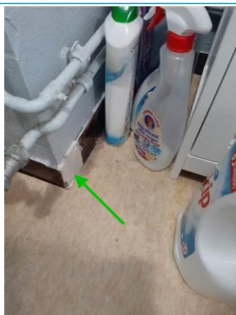
Matériaux : ZPSO-007 Prélèvement : P007 Description : Colle de plinthes noires Localisation : Logement 08 au 1er étage - SDB; Logement 08 au 1er étage - WC Résultat : Absence d'amiante
