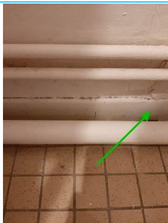
Matériaux : ZPSO-007 Prélèvement : P007 Description : Colle de plinthes Localisation : Rez de chaussée Logement 02 - SDB; Rez de chaussée Logement 02 - WC Résultat : Absence d'amiante
