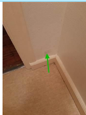
Matériaux : ZPSO-002 Prélèvement : P010 Description : Enduit à base de plâtre Localisation : Logement 7 RDC - WC Résultat : Absence d'amiante
