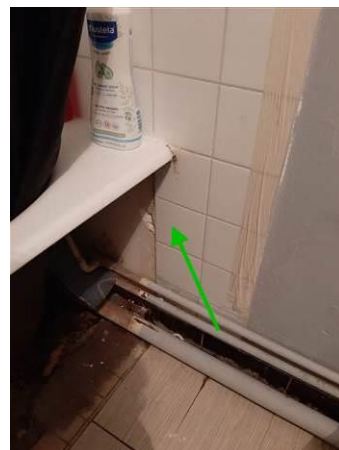
Matériaux : ZPSO-006 Prélèvement : P006 Description : Colle de faïence Localisation : 1er étage Logement 03 - SDB Résultat : Absence d'amiante
