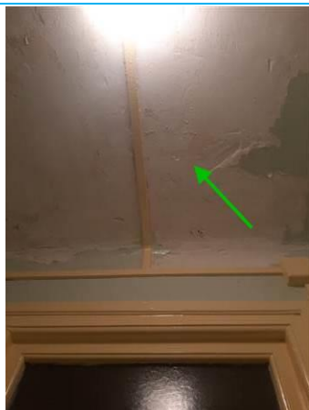
Matériaux : ZPSO-004 Prélèvement : P007 Description : Enduit à base de plâtre Localisation : Logement 01 RDC - WC Résultat : Absence d'amiante
