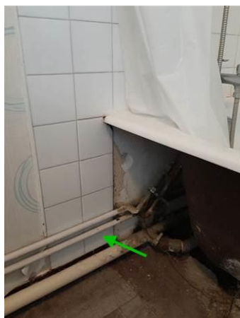
Matériaux : ZPSO-003 Prélèvement : P003 Description : Colle de faïence Localisation : 1er étage Logement 03 - SDB Résultat : Absence d'amiante
