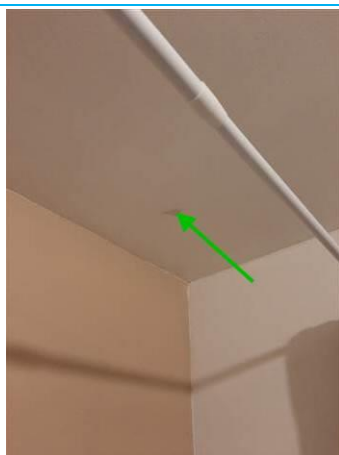
Matériaux : ZPSO-009 Prélèvement : P009 Description : Enduit à base de plâtre Localisation : Rez de chaussée Logement 02 - SDB; Rez de chaussée Logement 02 - WC Résultat : Absence d'amiante
