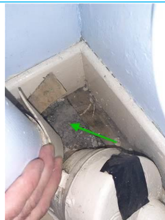
Matériaux : ZPSO-005 Prélèvement : P008 Description : Ragrée sous lino Localisation : Logement 02 RDC - SDB; Logement 02 RDC - WC Résultat : Absence d'amiante
