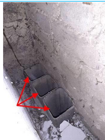
Matériaux : ZPSO-026 Prélèvement : P006 Description : Conduit en fibres-ciment Localisation : 2ème étage - Combles Résultat : Présence d'amiante
