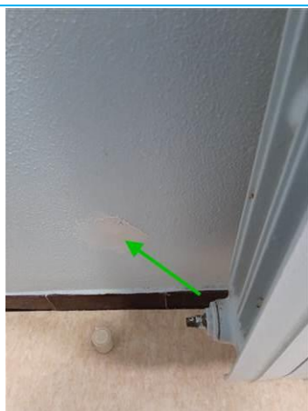
Matériaux : ZPSO-009 Prélèvement : P009 Description : Enduit à base de plâtre Localisation : Logement 08 au 1er étage - SDB; Logement 08 au 1er étage - WC Résultat : Absence d'amiante
