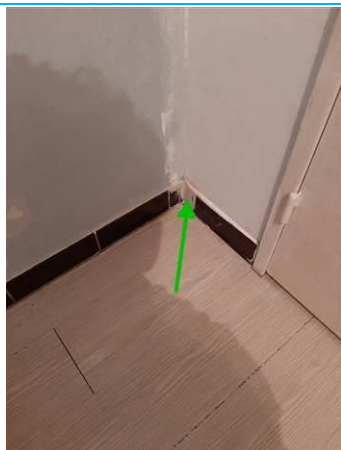
Matériaux : ZPSO-005 Prélèvement : P005 Description : Colle de plinthes Localisation : 1er étage Logement 03 - SDB; 1er étage Logement 03 - WC Résultat : Absence d'amiante
