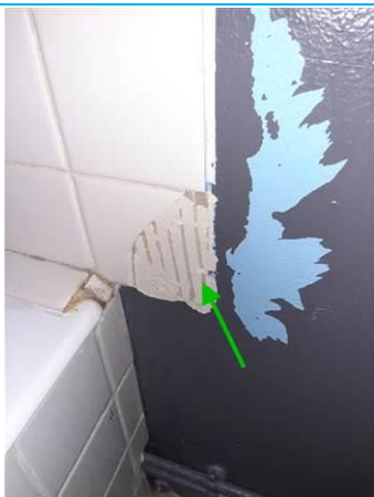
Matériaux : ZPSO-003 Prélèvement : P007 Description : Colle de faïence blanche Localisation : Logement 7 RDC - SDB Résultat : Absence d'amiante
