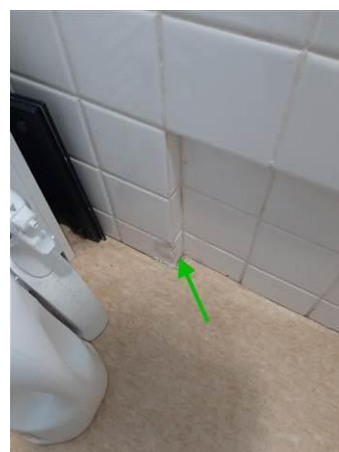
Matériaux : ZPSO-008 Prélèvement : P008 Description : Colle de faïence blanche Localisation : Logement 08 au 1er étage - SDB Résultat : Absence d'amiante
