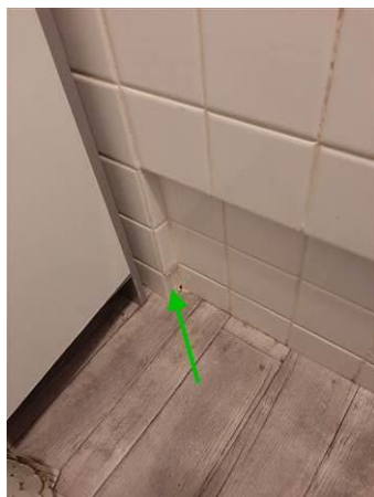
Matériaux : ZPSO-007 Prélèvement : P013 Description : Colle de faïence blanche Localisation : Logement 8 1er étage - SDB Résultat : Absence d'amiante
