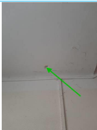
Matériaux : ZPSO-020 Prélèvement : P020 Description : Enduit à base de plâtre Localisation : Rez de chaussée - Parties communes Résultat : Absence d'amiante
