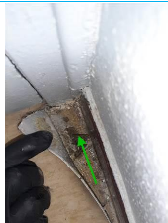
Matériaux : ZPSO-006 Prélèvement : P006 Description : Ragréage sous lino Localisation : Logement 08 au 1er étage - SDB; Logement 08 au 1er étage - WC Résultat : Absence d'amiante
