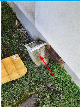
Matériaux : ZPSO-017 Prélèvement : P017 Description : Conduit en fibres-ciment Localisation : Extérieur - Façades bât 44; Extérieur - Façades bât 42-43; Extérieur - Façades bât 40; Extérieur - Façades bât 41 Résultat : Présence d'amiante
