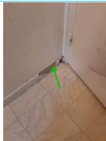
Matériaux : ZPSO-008 Prélèvement : P008 Description : Colle de plinthes noires Localisation : Bâtiment 11 Logement 07 RDC - SDB Résultat : Absence d'amiante
