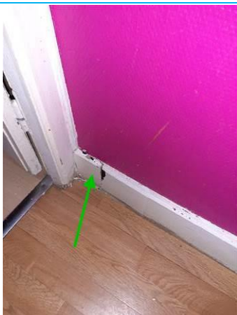
Matériaux : ZPSO-015 Prélèvement : P015 Description : Colle de plinthes Localisation : Logement 02 au RDC - WC Résultat : Absence d'amiante
