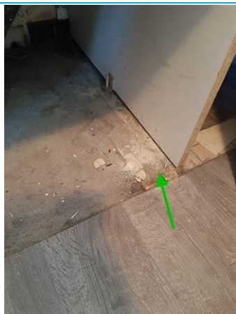
Matériaux : ZPSO-001 Prélèvement : P001 Description : Colle de carrelage Localisation : 1er étage Logement 03 - SDB; 1er étage Logement 03 - WC Résultat : Absence d'amiante
