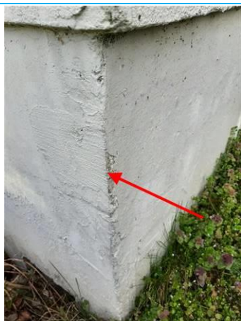
Matériaux : ZPSO-021 Prélèvement : P021 Description : Enduit extérieur + peinture Localisation : Extérieur - Façades bât 42-43 Résultat : Présence d'amiante
