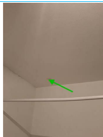
Matériaux : ZPSO-008 Prélèvement : P008 Description : Enduit à base de plâtre Localisation : 1er étage Logement 03 - SDB; 1er étage Logement 03 - WC Résultat : Absence d'amiante
