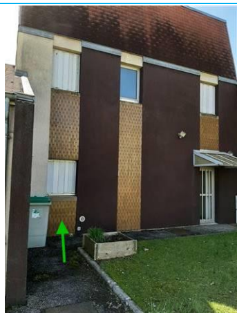
Matériaux : ZPSO-015 Prélèvement : P015 Description : Colle de carrelage marron Localisation : Pavillon 38 - Façade Résultat : Absence d'amiante
