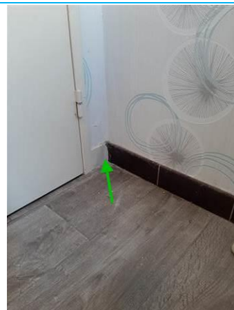
Matériaux : ZPSO-002 Prélèvement : P002 Description : Colle de plinthes Localisation : 1er étage Logement 03 - SDB; 1er étage Logement 03 - WC Résultat : Absence d'amiante
