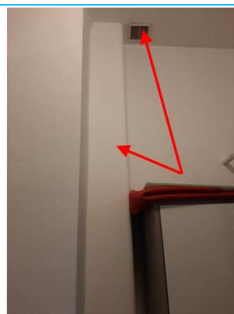
Matériaux : ZPSO-010 Prélèvement : Rapport n° 2103CGENADE2105606-3 du 12/04/2021 par SOCOTEC Description : Conduit en amiante ciment Localisation : Logement 6 RDC - SDB; Logement 6 RDC - WC; Logement 7 RDC - SDB; Logement 7 RDC - WC; Logement 8 1er étage - SDB; Logement 8 1er étage - WC Résultat : Présence d'amiante
