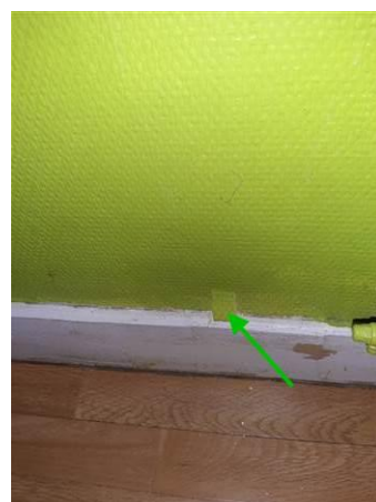
Matériaux : ZPSO-012 Prélèvement : P012 Description : Enduit à base de plâtre Localisation : Logement 02 au RDC - WC Résultat : Absence d'amiante
