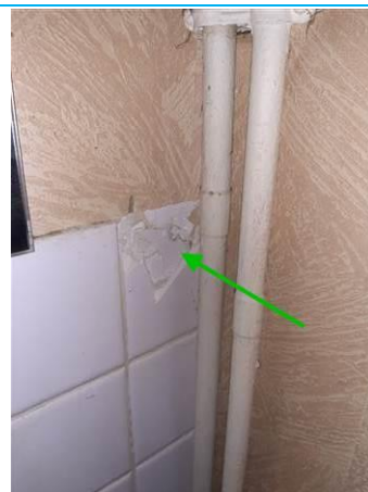
Matériaux : ZPSO-014 Prélèvement : P014 Description : Colle de faïence blanche Localisation : Logement 02 au RDC - WC Résultat : Absence d'amiante
