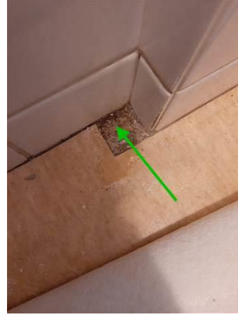
Matériaux : ZPSO-006 Prélèvement : P012 Description : Ragraillage sous linoléum Localisation : Logement 8 1er étage - SDB; Logement 8 1er étage - WC Résultat : Absence d'amiante
