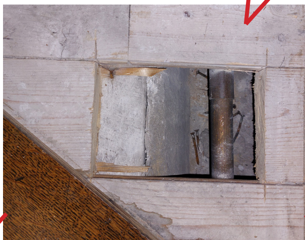
POINTS D'ACCÈS POUR L'AIGUILLAGE DES RÉSEAUX (CI-DESSUS LES RÉSEAUX HISTORIQUES PASSANT DÉJÀ PAR LÀ)
