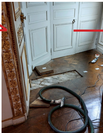
DÉPOSE DU PARQUET D'ASSEMBLAGE
