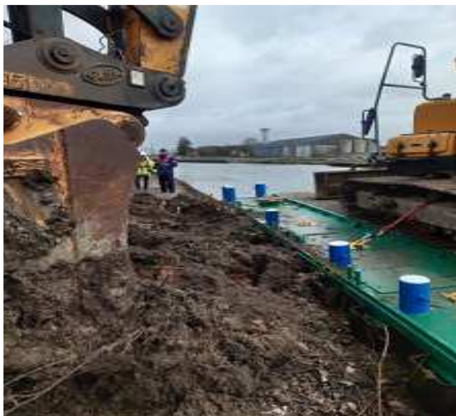
Photo 8 : Décaissement derrière les palplanches
