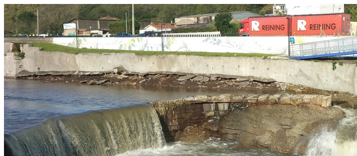
Vue du mur Gier 2 avant et après la crue d'octobre 2024 – Vue de la zone d'affouillement à combler
