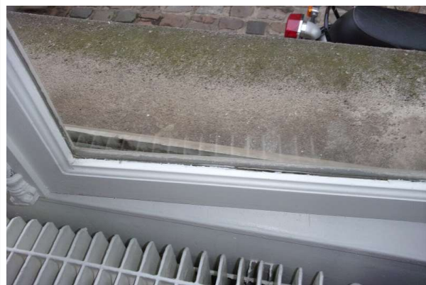
Prélèvement - P316 : R+0 / D29 - Joint de vitrage- (Absence d'amiante)
