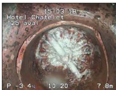
Fissure circulaire ouverte au niveau d'un té de visite
