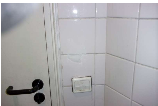
Prélèvement - P365 : R+0 / G29 - Colle de faïence- (Absence d'amiante)
