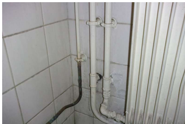
Prélèvement - P364 : R+0 / G29 - Colle de faïence- (Absence d'amiante)
