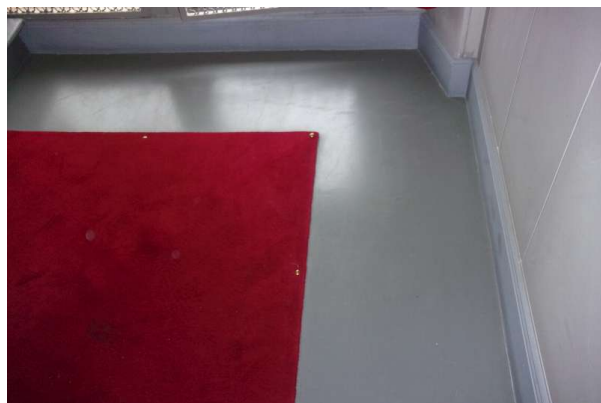
Prélèvement - P078 : R+3 / H303 - Enduit de ragréage- (Absence d'amiante)
