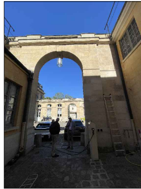
Détail façade courrette Est • Enduit, perte de matière • Pierre, traces d'humidité
