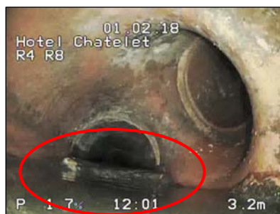
Dépôt dur incrusté (entre 25 et 50 %) sur l'ensemble de la canalisation entre R4 et R8
