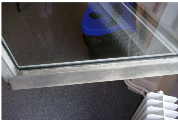
Prélèvement - P127 : R+1 / D104 - Joint de vitrage- (Absence d'amiante)
