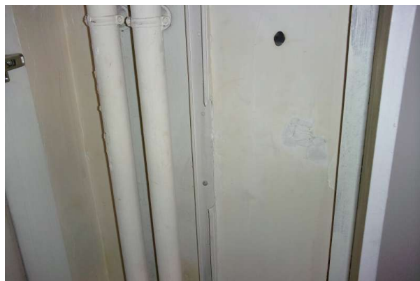
Prélèvement - P070 : R+1 / H100 - Enduit- (Absence d'amiante)
