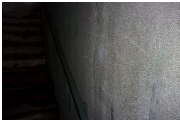
Prélèvement - P372 : R-1 / Escalier vers chaufferie - Enduit- (Absence d'amiante)
