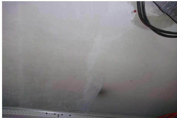
Prélèvement - P264 : R+2 / H205 - Enduit- (Absence d'amiante)
