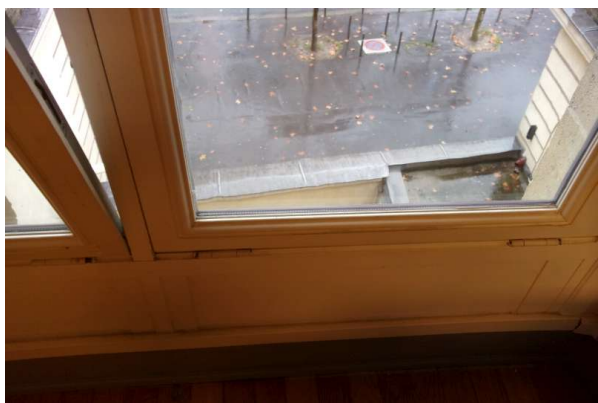
Prélèvement - P073 : R+3 / H302 - Joint de vitrage- (Absence d'amiante)
