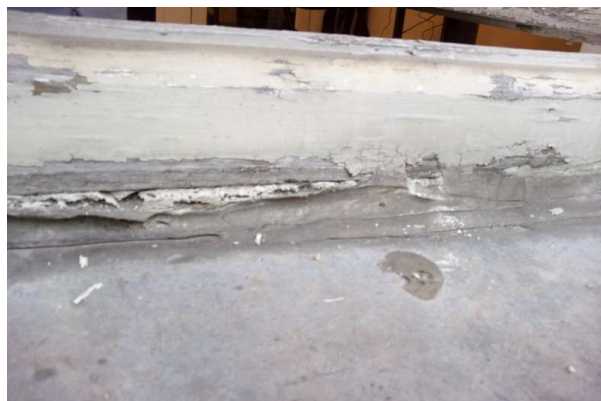
Prélèvement - P018 : R+1 / G105 - Joint d'étanchéité entre menuiserie et structure- (Absence d'amiante)
