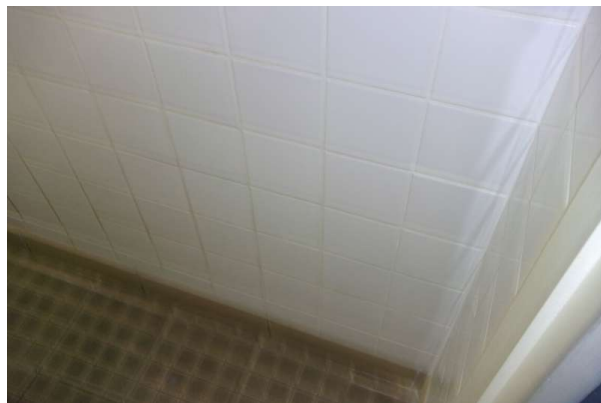
Prélèvement - P428 : R-1 / S9 - Colle de faïence- (Absence d'amiante)
