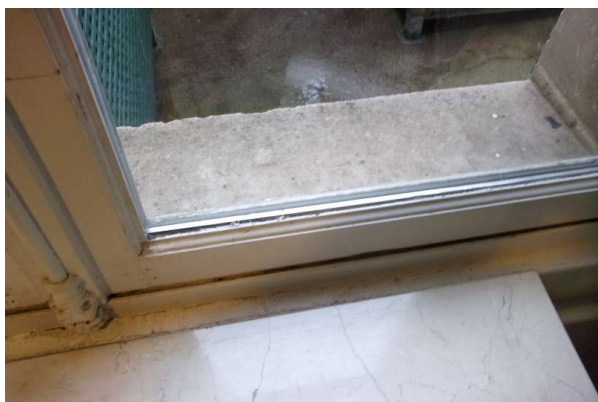
Prélèvement - P279 : R+0 / H8 - Joint de vitrage- (Absence d'amiante)
