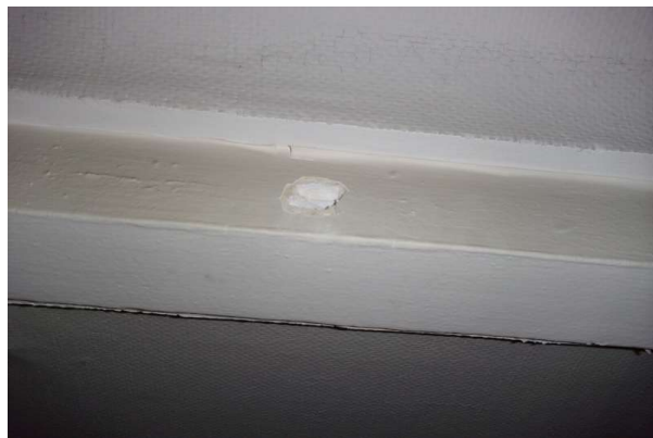
Prélèvement - P194 : R+4 / H411 bis - Enduit- (Absence d'amiante)
