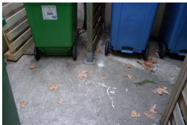
Prélèvement - P334 : R+0 / Cour intérieure - Enduit de ragréage- (Absence d'amiante)
