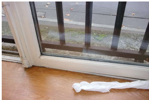
Prélèvement - P324 : R+0 / D27 - Joint de vitrage- (Absence d'amiante)
