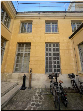
Détail façade courrette Sud • Socle pierre, remontée capillaire • Enduit, perte de matière • Enduit, traces d'humidité
