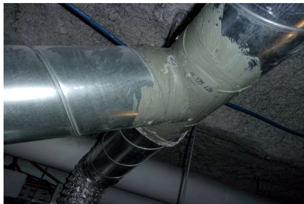
Prélèvement - P418 : R-1 / S2 - Mastic- (Absence d'amiante)
