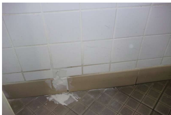
Prélèvement - P438 : R-1 / S4 - Colle de plinthe- (Absence d'amiante)
