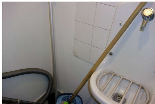
Prélèvement - P350 : R+0 / D19 - Colle de faïence- (Absence d'amiante)
