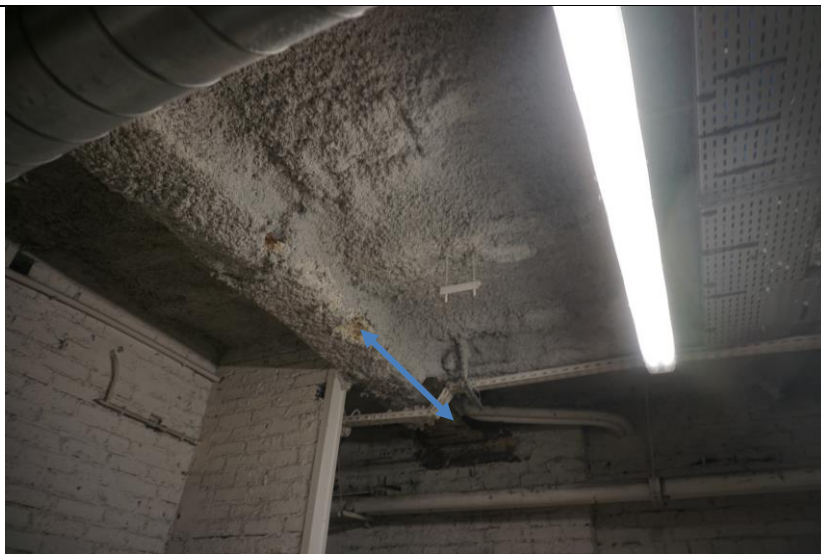
Sondage – zone C : continuité de la poutre dans le mur et présence plat 2
