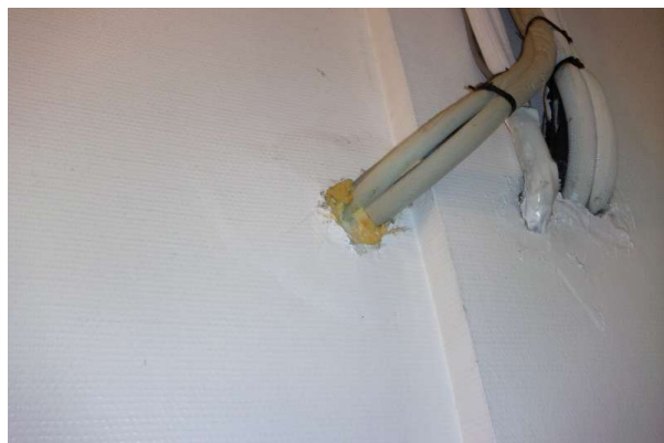
Prélèvement - P240 : R+2 / H216 - Rebouchage- (Absence d'amiante)
