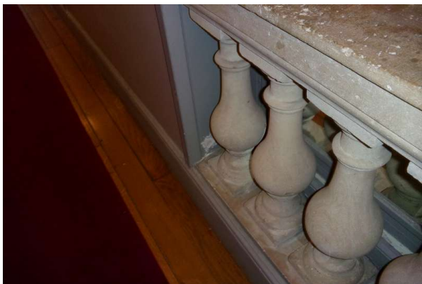
Prélèvement - P263 : R+2 / H206 - Enduit- (Absence d'amiante)
