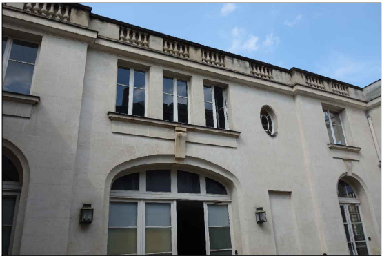
Détail façade courrette Nord • Balustrade: salissures • Appui baie: salissures
