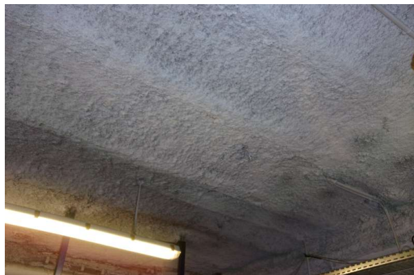
Prélèvement - P370 : R-1 / S10 - Flocage- (Absence d'amiante)
