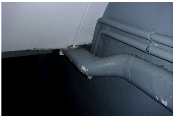
Prélèvement - P355 : R+0 / D2 - Enveloppe de calorifugeage- (Absence d'amiante)
