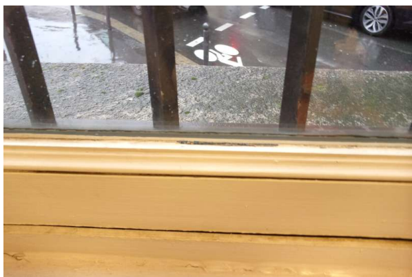
Prélèvement - P301 : R+0 / D11 - Joint de vitrage- (Absence d'amiante)
