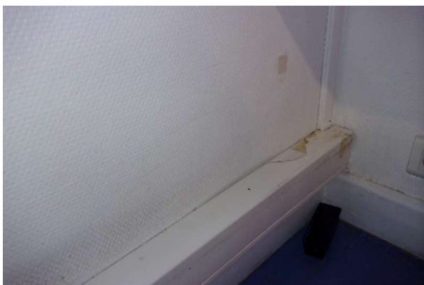
Prélèvement - P255 : R+3 / H301 - Enduit- (Absence d'amiante)
