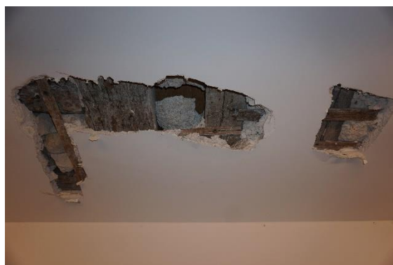
Exemple : sondage sur un plancher haut en bois
