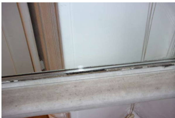
Prélèvement - P093 : R+2 / D202 - Joint de vitrage- (Absence d'amiante)
