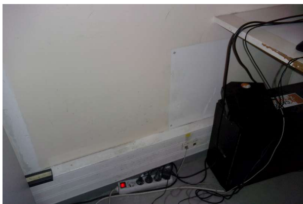
Prélèvement - P211 : R+1 / D140 - Enduit- (Absence d'amiante)
