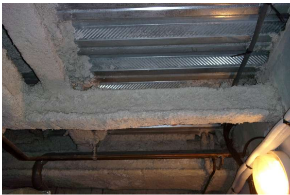
Prélèvement - P253 : R+3 / H300 - Flocage- (Absence d'amiante)
