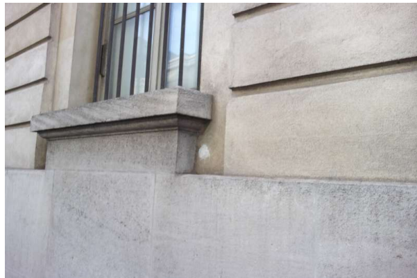
Prélèvement - P368 : R+0 / D11 - Enduit taloché- (Absence d'amiante)
