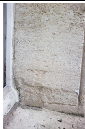
Prélèvement - P058 : R+0 / G7 - Joint d'étanchéité entre menuiserie et structure- (Absence d'amiante)
