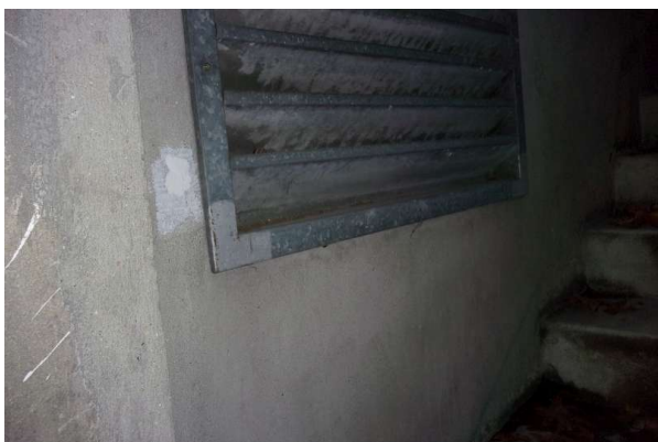
Prélèvement - P371 : R-1 / Escalier vers chaufferie - Enduit- (Absence d'amiante)
