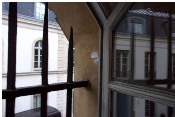
Prélèvement - P020 : R+1 / G118 - Enduit taloché- (Absence d'amiante)
