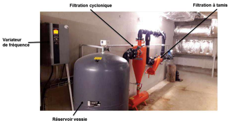
(37) Equipements spécifiques pour la géothermie en local chaufferie
