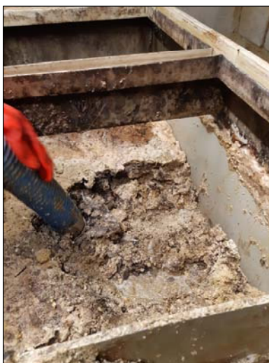
Pompage en cours Dépôt important de graisse solidifiée
