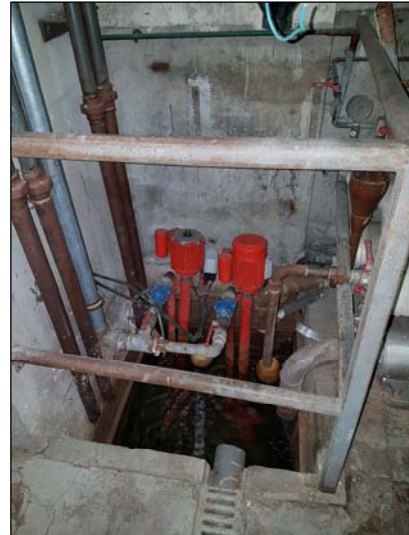
Poste de refoulement salle S11, il reprend des purges de la chaufferie ainsi que les eaux des sanitaires (S12).
