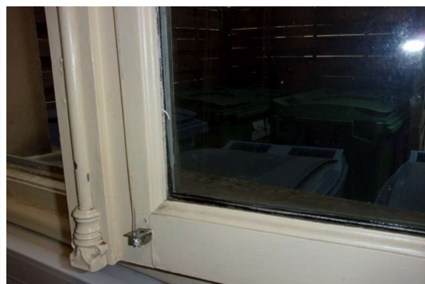
Prélèvement - P330 : R+0 / H5 - Joint de vitrage- (Absence d'amiante)
