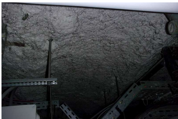
Prélèvement - P417 : R-1 / S2 - Flocage- (Absence d'amiante)
