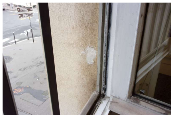
Prélèvement - P120 : R+1 / D109 - Enduit taloché- (Absence d'amiante)
