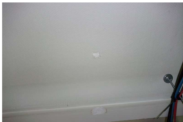
Prélèvement - P196 : R+4 / H411 bis - Enduit- (Absence d'amiante)
