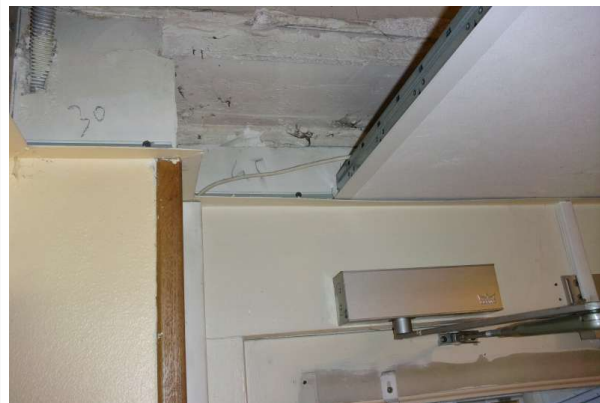
Prélèvement - P314 : R+0 / D22 - Enduit- (Absence d'amiante)
