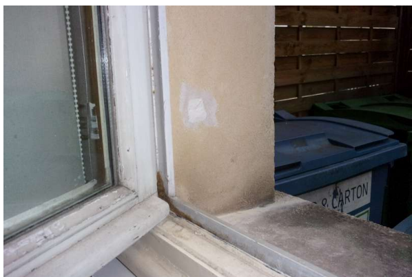
Prélèvement - P331 : R+0 / H5 - Enduit taloché- (Absence d'amiante)
