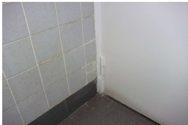
Prélèvement - P274 : R+1 / D127 - Colle de faïence- (Absence d'amiante)
