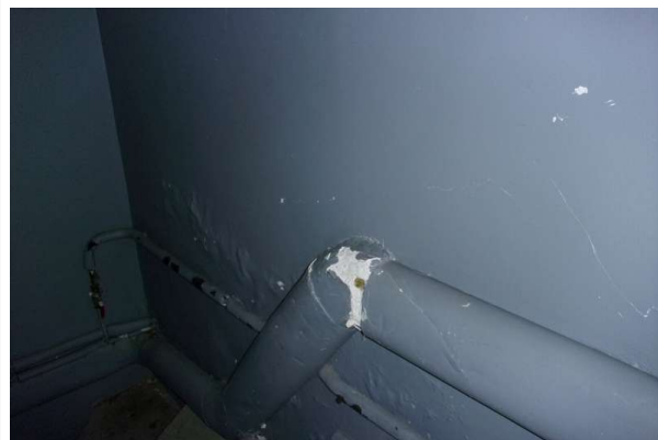
Prélèvement - P354 : R+0 / D2 - Enveloppe de calorifugeage- (Absence d'amiante)
