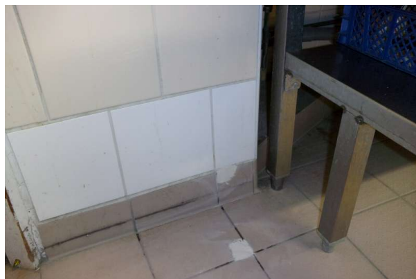
Prélèvement - P234 : R+2 / H216 - Colle de plinthe- (Absence d'amiante)
