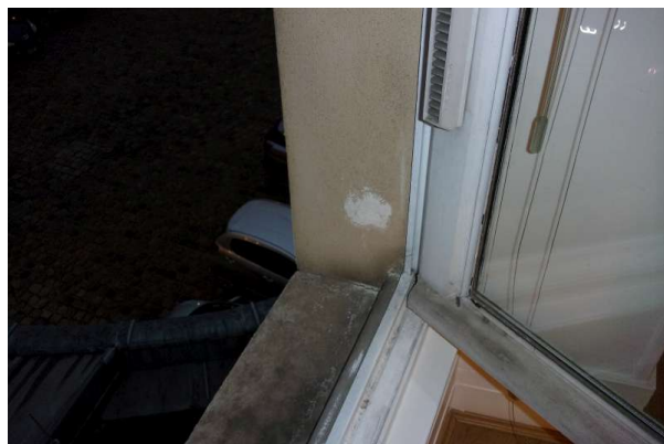
Prélèvement - P100 : R+2 / D201 - Enduit taloché- (Absence d'amiante)
