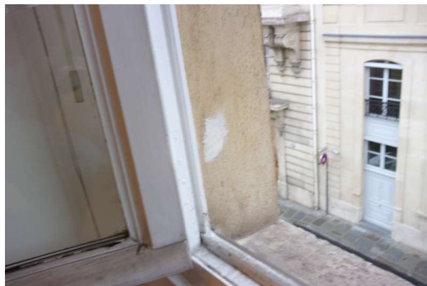
Prélèvement - P092 : R+2 / D202 - Enduit taloché- (Absence d'amiante)
