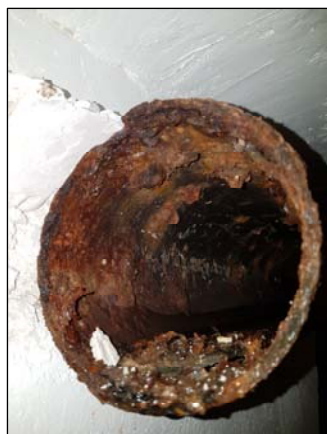
Corrosion et dégradation du revêtement au niveau du té de visite T17
