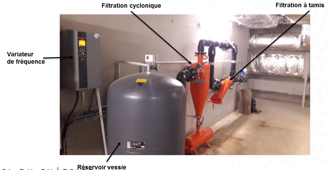
Équipement spécifiques pour la géothermie en local :
