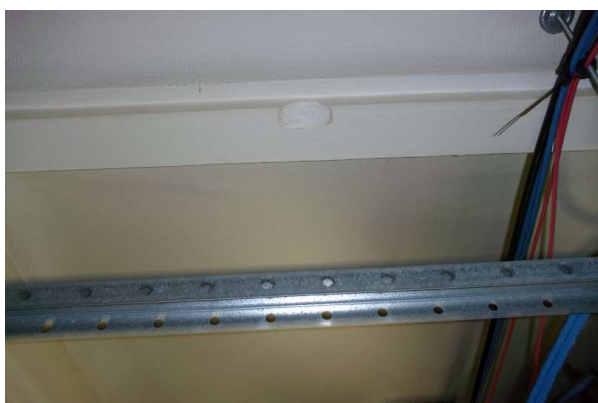
Prélèvement - P197 : R+4 / H411 bis - Enduit- (Absence d'amiante)
