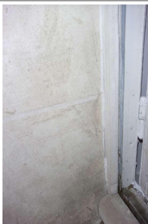
Prélèvement - P317 : R+0 / D29 - Joint d'étanchéité entre menuiserie et structure- (Absence d'amiante)
