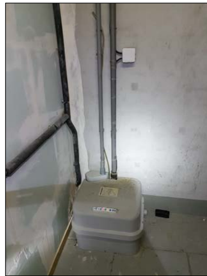
Poste de refoulement hors-sol salle S3, il reprend les eaux des WC (S9).
