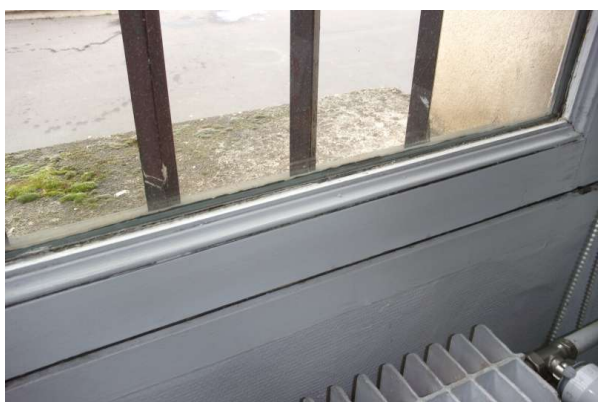
Prélèvement - P357 : R+0 / D15 - Joint de vitrage- (Absence d'amiante)
