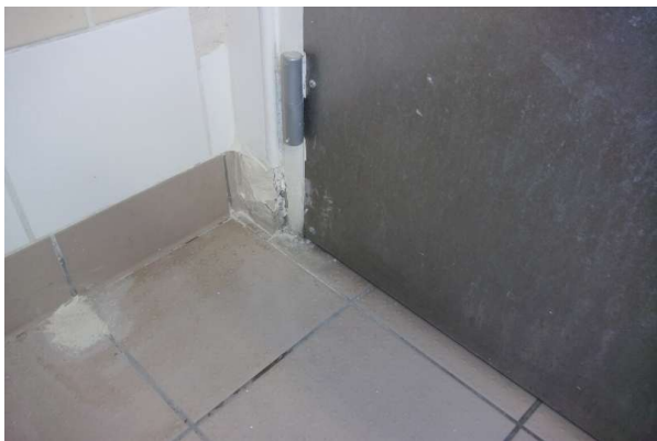
Prélèvement - P235 : R+2 / H216 - Colle de plinthe- (Absence d'amiante)
