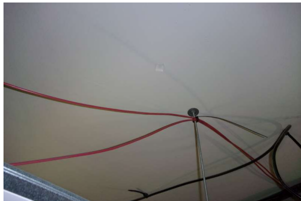
Prélèvement - P208 : R+4 / H407 - Enduit- (Absence d'amiante)
