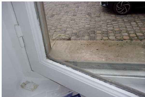
Prélèvement - P320 : R+0 / D29 - Joint de vitrage- (Absence d'amiante)
