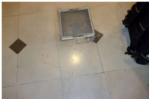
Prélèvement - P312 : R+0 / D22 - Colle de carrelage- (Absence d'amiante)
