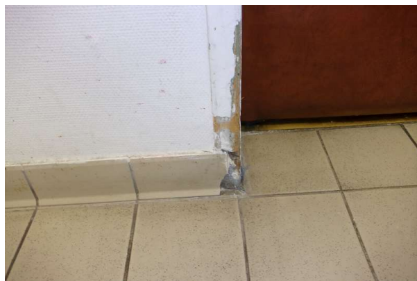
Prélèvement - P246 : R+2 / H215 - Colle de plinthe- (Absence d'amiante)
