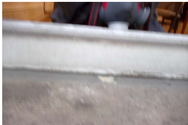
Prélèvement - P094 : R+2 / D202 - Joint d'étanchéité entre menuiserie et structure- (Absence d'amiante)
