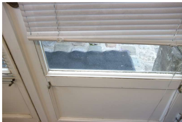
Prélèvement - P340 : R+0 / D17 - Joint de vitrage- (Absence d'amiante)
