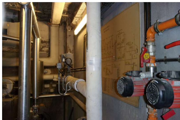
Prélèvement - P028 : R-1 / S11 - Enveloppe de calorifugeage- (Absence d'amiante)
