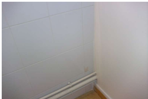
Prélèvement - P012 : R+2 / G207 - Colle de faïence- (Absence d'amiante)
