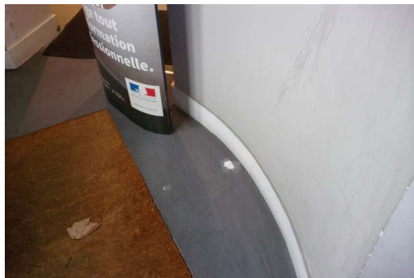
Prélèvement - P050 : R+0 / G1 - Enduit de ragréage- (Absence d'amiante)
