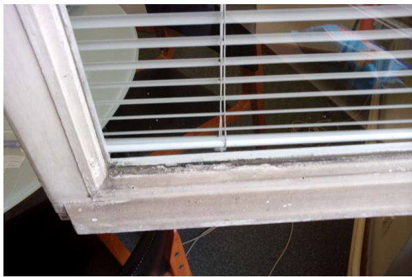
Prélèvement - P149 : R+1 / D125 - Joint de vitrage- (Absence d'amiante)
