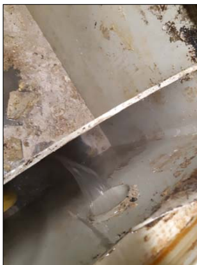
Canalisation d'arrivée débouchée
