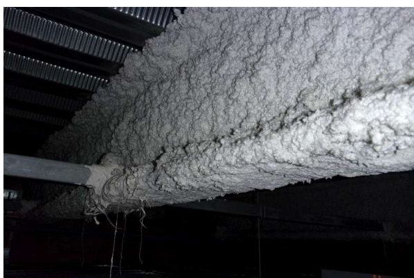
Prélèvement - P225 : R+0 / G14 - Flocage- (Absence d'amiante)
