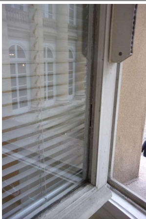
Prélèvement - P145 : R+1 / D125 - Joint de vitrage- (Absence d'amiante)
