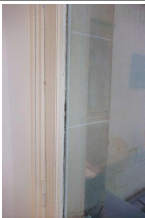
Prélèvement - P109 : R+1 / D111 - Joint de vitrage- (Absence d'amiante)
