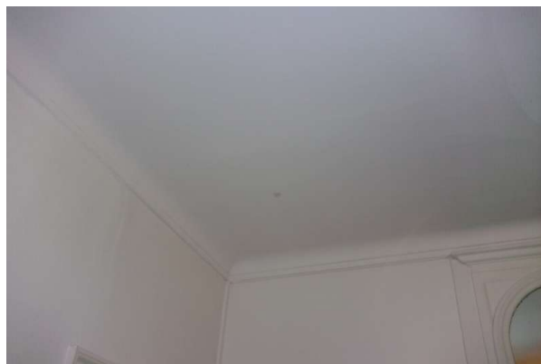
Prélèvement - P160 : R+4 / H400 - Enduit- (Absence d'amiante)
