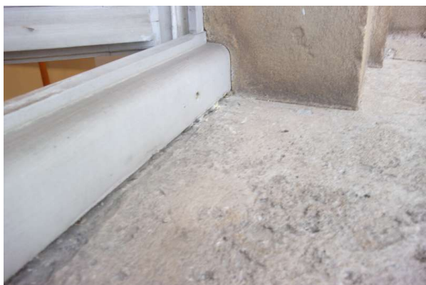
Prélèvement - P227 : R+1 / G102 - Rebouchage- (Absence d'amiante)
