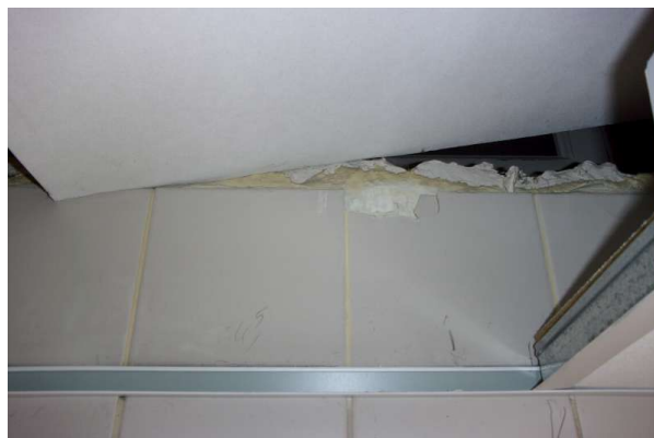
Prélèvement - P084 : R+0 / G30 - Colle de faïence- (Absence d'amiante)
