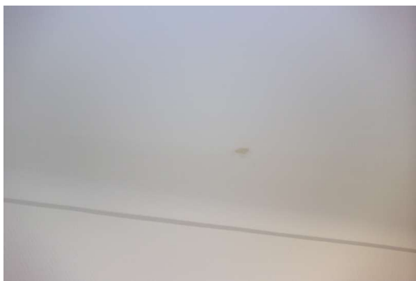
Prélèvement - P095 : R+2 / D202 - Enduit- (Absence d'amiante)
