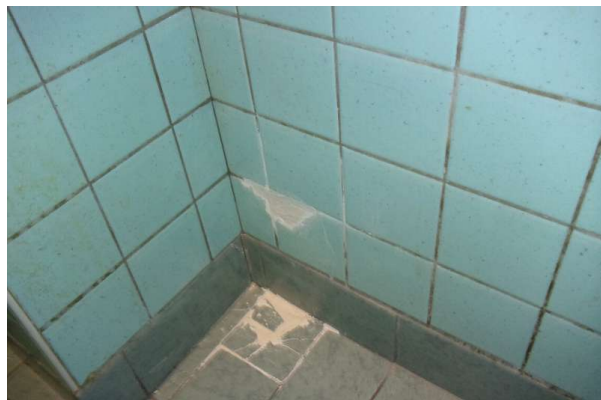
Prélèvement - P310 : R+0 / D21 - Colle de faïence- (Absence d'amiante)
