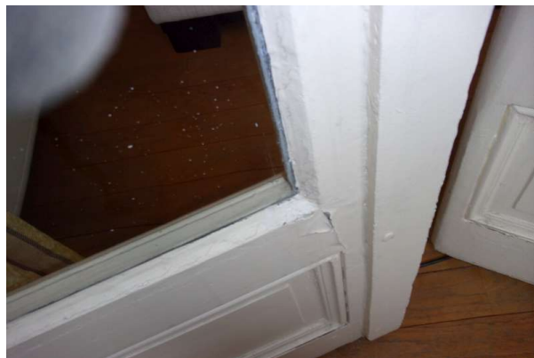
Prélèvement - P260 : R+2 / H201 - Mastic- (Absence d'amiante)
