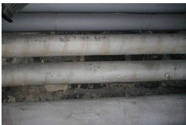
Prélèvement - P393 : R-1 / S15 - Enveloppe de calorifugeage- (Absence d'amiante)
