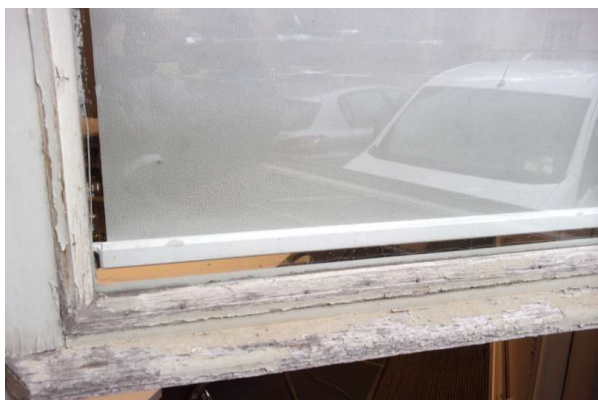
Prélèvement - P057 : R+0 / G7 - Joint de vitrage- (Absence d'amiante)
