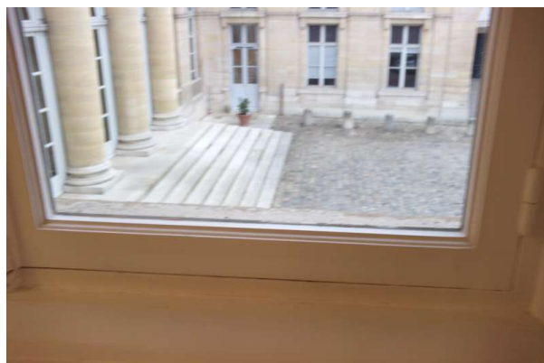
Prélèvement - P226 : R+1 / G102 - Joint de vitrage- (Absence d'amiante)
