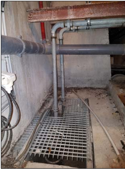
Poste de refoulement salle S36, d'environ 0,4 m 3 , il reprend les eaux de ruissellement de la salle.
