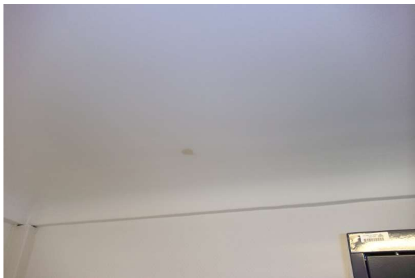
Prélèvement - P097 : R+2 / D202 - Enduit- (Absence d'amiante)
