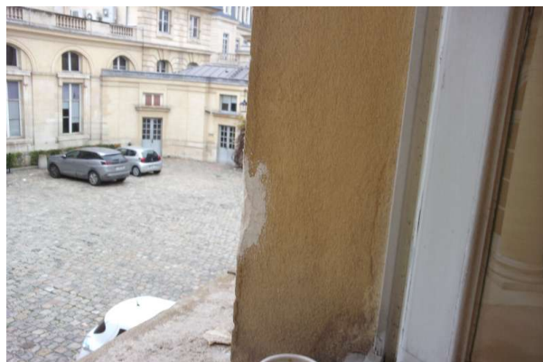
Prélèvement - P228 : R+1 / G102 - Enduit taloché- (Absence d'amiante)
