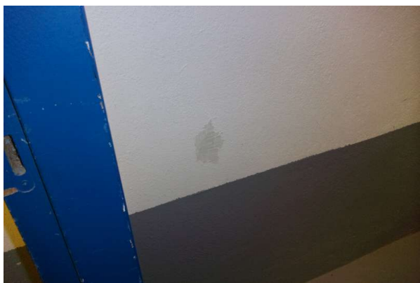
Prélèvement - P403 : R-1 / S30 - Enduit- (Absence d'amiante)
