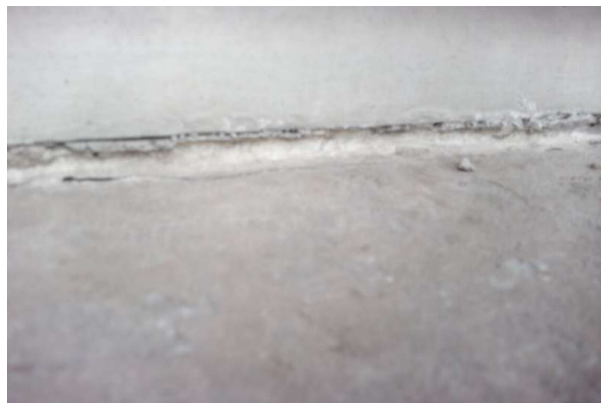
Prélèvement - P146 : R+1 / D125 - Rebouchage- (Absence d'amiante)
