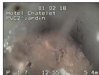
Casse avec pénétration de terre obstruant totalement la canalisation
