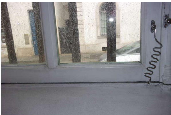
Prélèvement - P047 : R+0 / G5 - Joint de vitrage- (Absence d'amiante)
