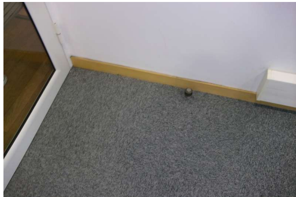
Prélèvement - P008 : R+2 / G202 - Ragréage- (Absence d'amiante)
