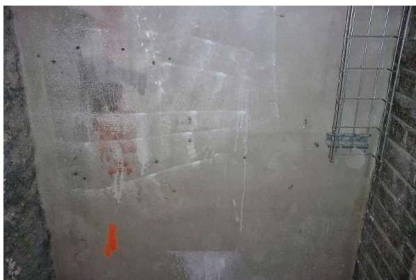
Prélèvement - P389 : R-1 / S14 - Enduit- (Absence d'amiante)
