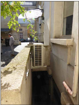
Détail façade courrette Ouest • Garde corps: mousses et lichens • Appui baie: salissures
