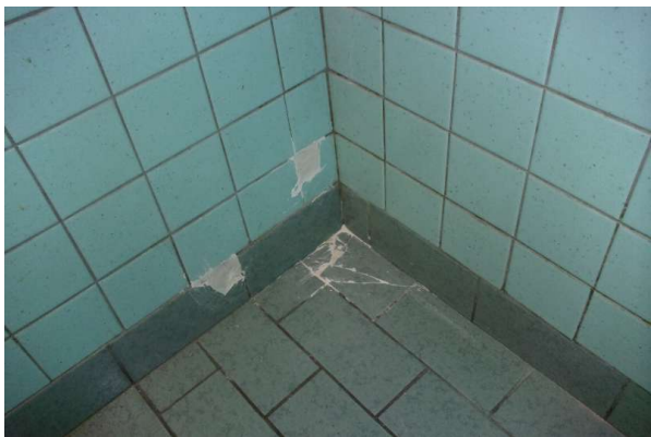
Prélèvement - P307 : R+0 / D20 - Colle de faïence- (Absence d'amiante)
