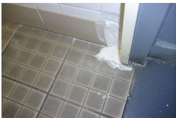
Prélèvement - P429 : R-1 / S9 - Colle de carrelage- (Absence d'amiante)
