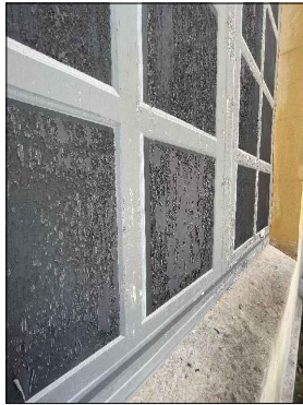
Détail façade courrette Sud • Fausse fenêtre, perte de décors
