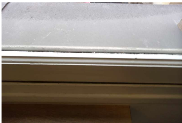
Prélèvement - P151 : R+1 / D125 - Joint de vitrage- (Absence d'amiante)
