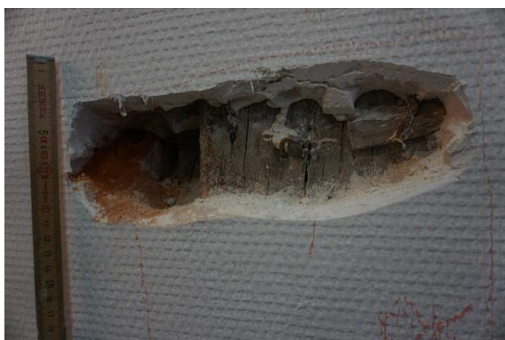
Exemple : sondage sur un mur en ban de bois remplissage brique
