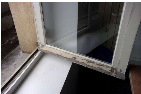
Prélèvement - P023 : R+1 / G105 - Mastic- (Absence d'amiante)
