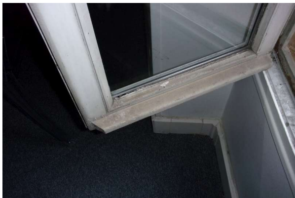
Prélèvement - P059 : R+1 / H105 - Joint de vitrage- (Absence d'amiante)
