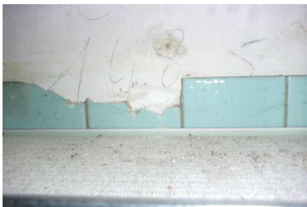
Prélèvement - P137 : R+1 / D139 - Colle de faïence- (Absence d'amiante)
