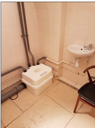
Poste de refoulement hors-sol salle S29, il reprend les eaux des sanitaires.
