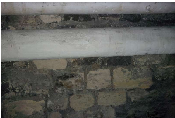
Prélèvement - P391 : R-1 / S15 - Enveloppe de calorifugeage- (Absence d'amiante)
