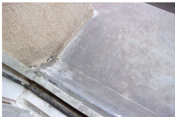
Prélèvement - P130 : R+1 / D104 - Joint d'étanchéité entre menuiserie et structure- (Absence d'amiante)
