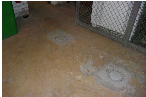
Prélèvement - P374 : R-1 / S13 - Enduit de ragréage- (Absence d'amiante)
