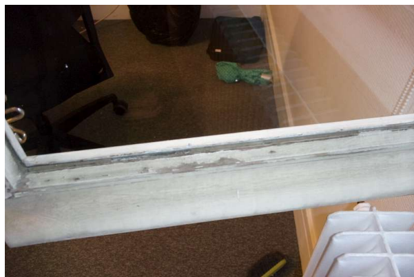
Prélèvement - P106 : R+1 / D111 - Joint de vitrage- (Absence d'amiante)
