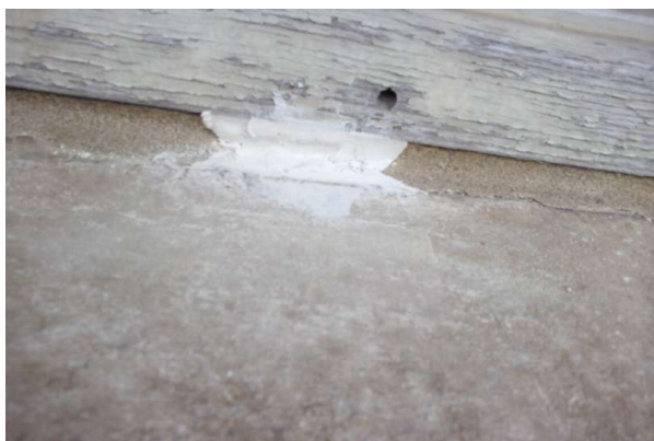
Prélèvement - P035 : R+1 / G104 - Rebouchage- (Absence d'amiante)
