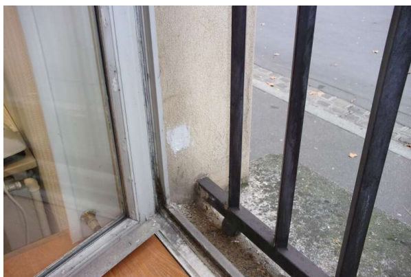
Prélèvement - P325 : R+0 / D27 - Enduit taloché- (Absence d'amiante)
