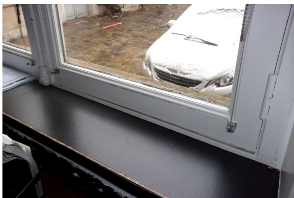
Prélèvement - P295 : R+0 / D18 - Joint de vitrage- (Absence d'amiante)
