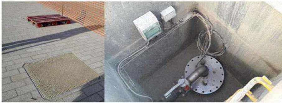
(36) Chambre de forage avec regard carrossable de type Fibrelite
