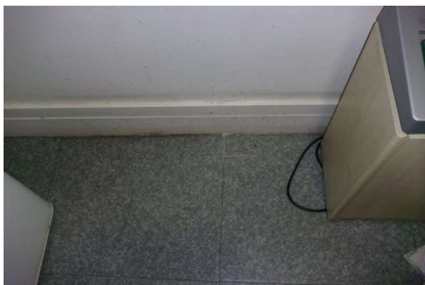
Prélèvement - P111 : R+1 / D113 - Colle- (Absence d'amiante)
