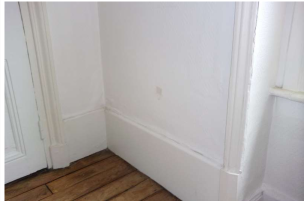
Prélèvement - P184 : R+4 / H404 bis - Enduit- (Absence d'amiante)
