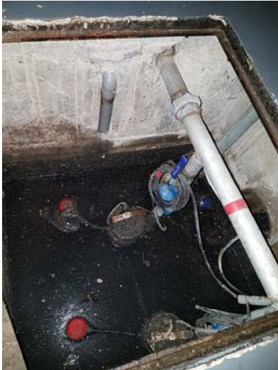
Poste de refoulement salle S7, il reprend les eaux des sanitaires hommes et femmes, et des siphons de sol.
