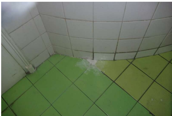
Prélèvement - P367 : R+0 / G29 - Colle de carrelage- (Absence d'amiante)
