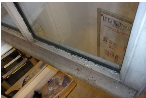
Prélèvement - P299 : R+0 / D8 bis - Joint de vitrage- (Absence d'amiante)
