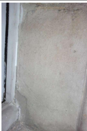
Prélèvement - P321 : R+0 / D29 - Joint d'étanchéité entre menuiserie et structure- (Absence d'amiante)
