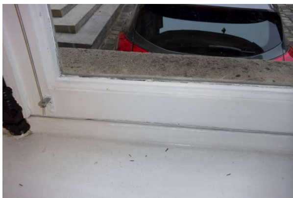
Prélèvement - P217 : R+0 / G14 - Joint de vitrage- (Absence d'amiante)
