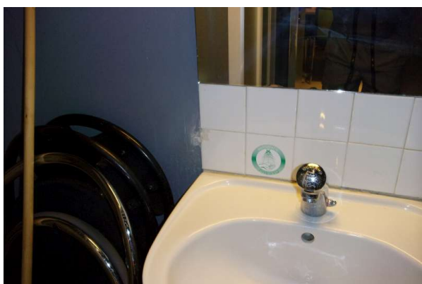
Prélèvement - P213 : R+1 / D140 - Colle de faïence- (Absence d'amiante)
