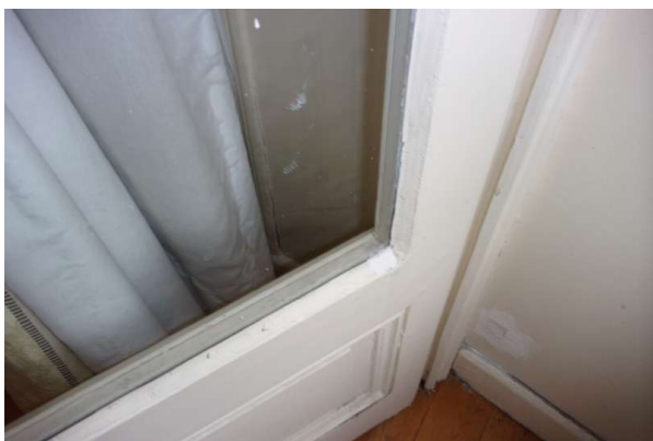
Prélèvement - P259 : R+2 / H201 - Mastic- (Absence d'amiante)
