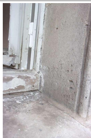
Prélèvement - P346 : R+0 / D17 - Joint d'étanchéité entre menuiserie et structure- (Absence d'amiante)
