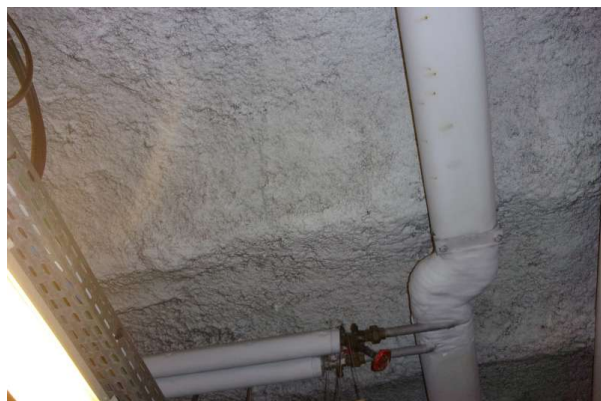
Prélèvement - P426 : R-1 / S3 - Flocage- (Absence d'amiante)
