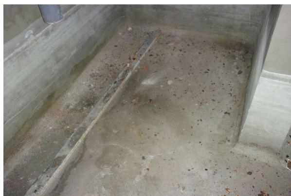
Prélèvement - P384 : R-2 / S13 bis - Enduit de ragréage- (Absence d'amiante)
