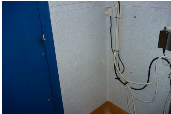
Prélèvement - P398 : R-1 / S17 - Enduit- (Absence d'amiante)
