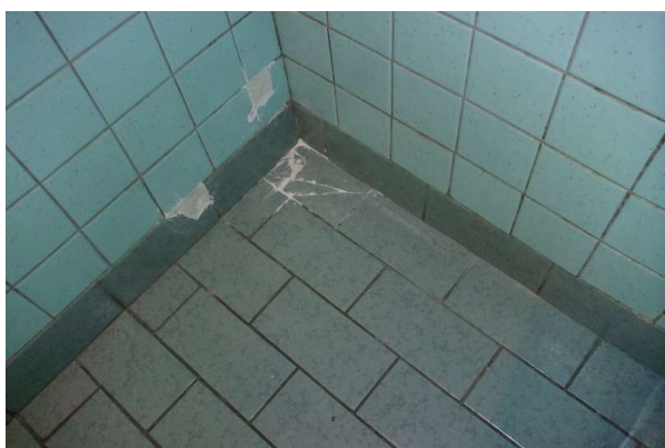
Prélèvement - P305 : R+0 / D20 - Colle de carrelage- (Absence d'amiante)
