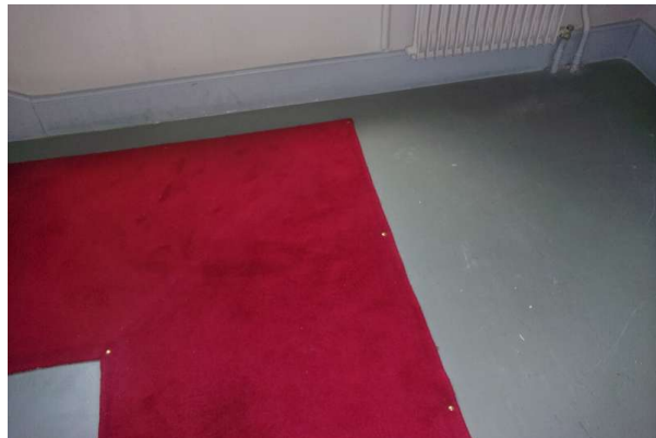
Prélèvement - P200 : R+4 / H421 - Ragréage- (Absence d'amiante)
