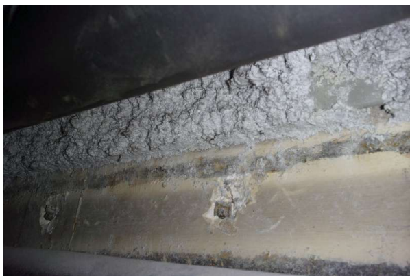
Prélèvement - P223 : R+0 / G12 - Flocage- (Absence d'amiante)
