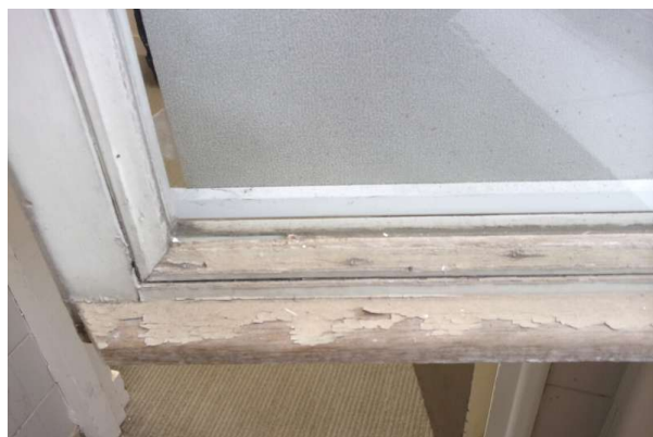
Prélèvement - P088 : R+0 / G30 - Joint de vitrage- (Absence d'amiante)
