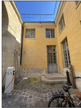
Détail façade courrette Nord • Fausse fenêtre, perte de décors • Enduit, perte de matière • Enduit, traces d'humidité
