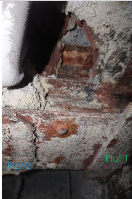
Sondage – zone C : continuité de la poutre dans le mur avec plat 1 au niveau de l'appui et présence d'un plat 2 (sur une longueur d'environ 1m)
