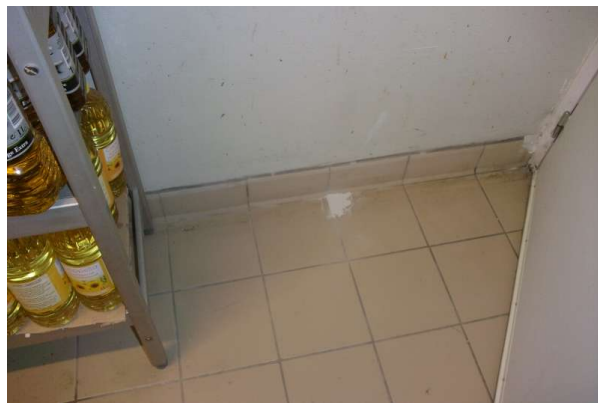
Prélèvement - P404 : R-1 / S18 / Réserve - Colle de carrelage- (Absence d'amiante)
