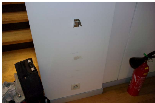
Prélèvement - P042 : R+1 / G118 - Enduit- (Absence d'amiante)
