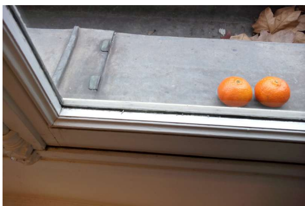
Prélèvement - P131 : R+1 / D104 - Joint de vitrage- (Absence d'amiante)
