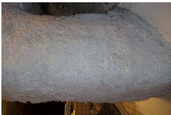
Prélèvement - P413 : R-1 / S24 - Flocage- (Absence d'amiante)
