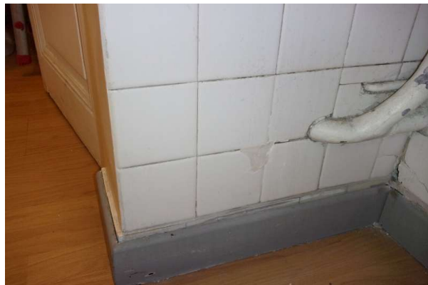
Prélèvement - P268 : R+2 / H203 - Colle de faïence- (Présence d'amiante)
