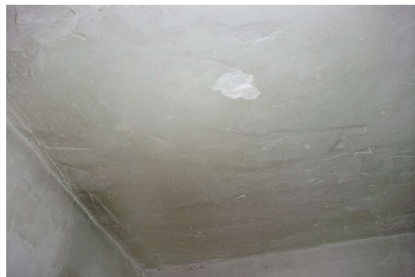
Prélèvement - P138 : R+1 / D139 - Enduit- (Absence d'amiante)
