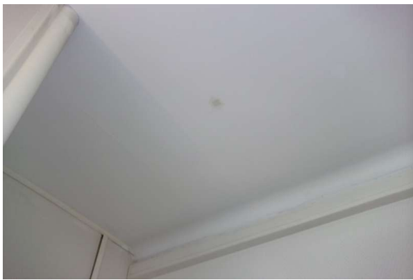
Prélèvement - P185 : R+4 / H405 bis - Enduit- (Absence d'amiante)
