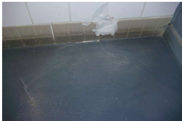
Prélèvement - P424 : R-1 / S9 - Colle de plinthe- (Absence d'amiante)
