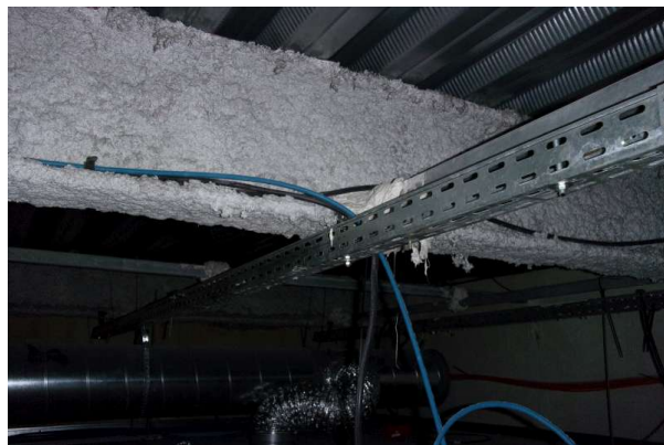
Prélèvement - P056 : R+0 / G7 - Flocage- (Absence d'amiante)
