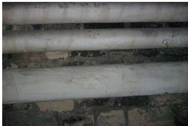
Prélèvement - P392 : R-1 / S15 - Enveloppe de calorifugeage- (Absence d'amiante)
