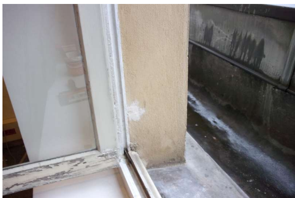
Prélèvement - P017 : R+1 / G105 - Enduit taloché- (Absence d'amiante)
