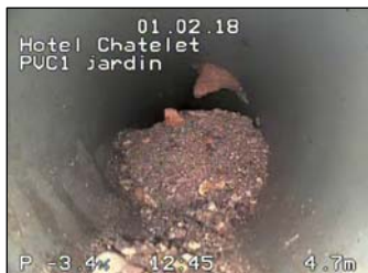
Casse sur le dessus avec pénétration de terre
