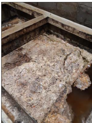
Bac dégraisseur rempli Canalisation d'arrivée quasi- totalement obstruée
