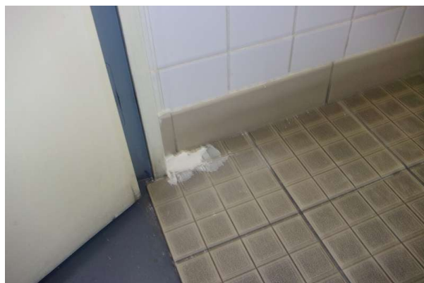
Prélèvement - P430 : R-1 / S9 - Colle de carrelage- (Absence d'amiante)
