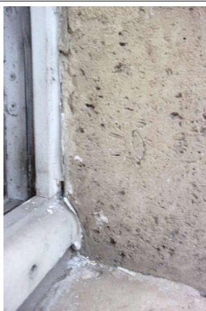
Prélèvement - P089 : R+0 / G30 - Joint d'étanchéité entre menuiserie et structure- (Absence d'amiante)
