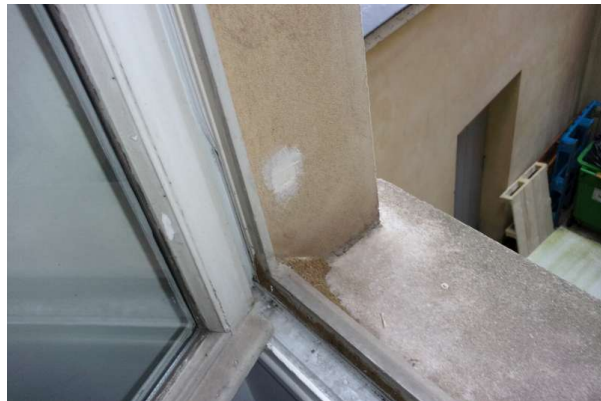
Prélèvement - P060 : R+1 / H105 - Enduit taloché- (Absence d'amiante)
