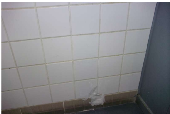
Prélèvement - P423 : R-1 / S9 - Colle de faïence- (Absence d'amiante)
