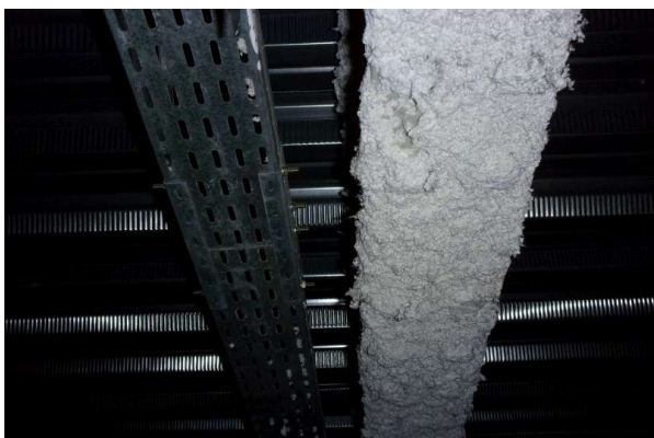
Prélèvement - P045 : R+0 / G5 - Flocage- (Absence d'amiante)
