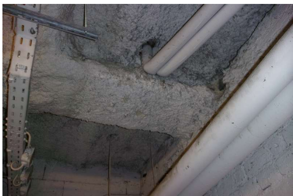
Prélèvement - P375 : R-1 / S13 - Flocage- (Absence d'amiante)
