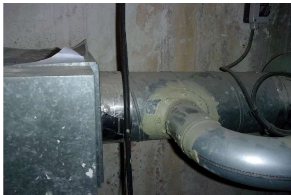
Prélèvement - P232 : R+1 / G117 / Placard technique - Mastic- (Absence d'amiante)
