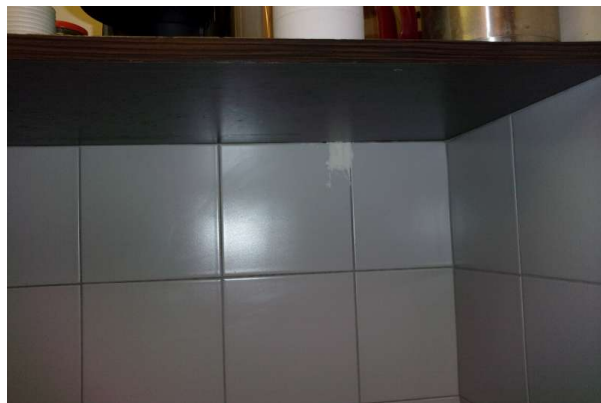
Prélèvement - P212 : R+1 / D140 - Colle de faïence- (Absence d'amiante)
