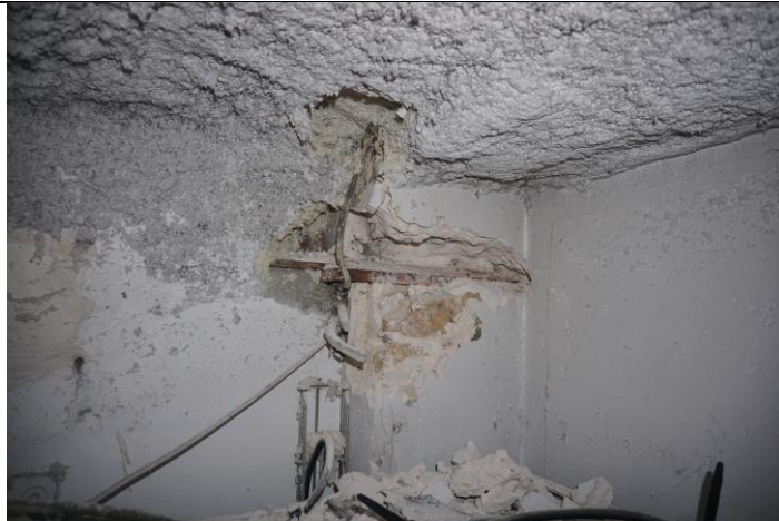
Sondage – zone D : continuité de la poutre dans le poteau en maçonnerie
