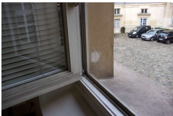
Prélèvement - P147 : R+1 / D125 - Enduit taloché- (Absence d'amiante)
