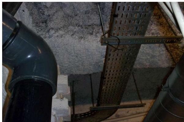
Prélèvement - P376 : R-1 / S13 - Flocage- (Absence d'amiante)
