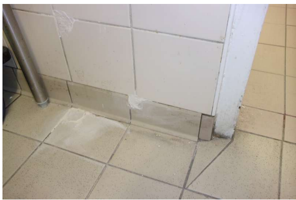
Prélèvement - P245 : R+2 / H215 - Colle de plinthe- (Absence d'amiante)
