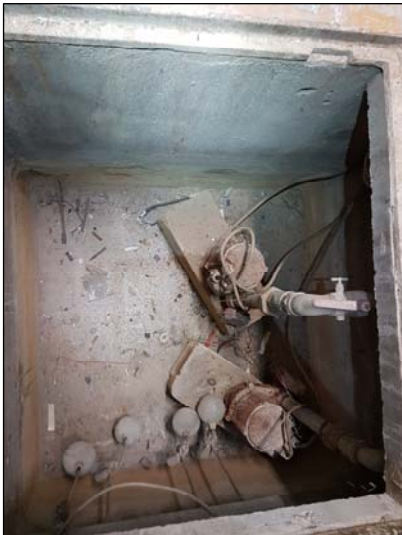
Poste de refoulement salle S28, il reprend les eaux de ruissellement de la salle.
