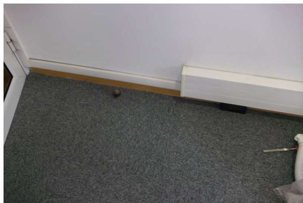
Prélèvement - P036 : R+1 / G104 - Ragréage- (Absence d'amiante)
