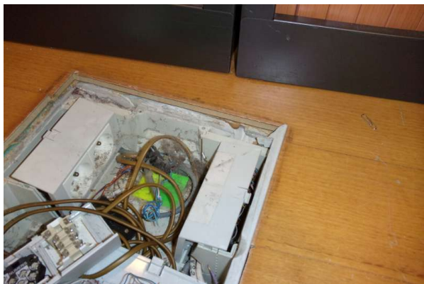
Prélèvement - P289 : R+0 / H10 - Colle- (Absence d'amiante)
