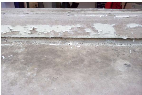
Prélèvement - P347 : R+0 / D17 - Rebouchage- (Absence d'amiante)
