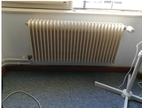
Radiateurs fonte avec robinet thermostatique
