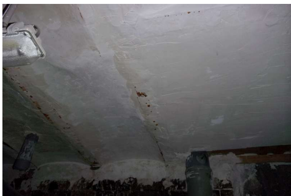
Prélèvement - P387 : R-2 / S13 bis - Enduit- (Absence d'amiante)
