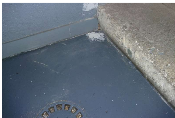
Prélèvement - P420 : R-1 / S2 - Enduit de ragréage- (Absence d'amiante)
