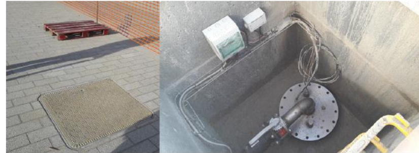
Exemple d'un regard de forage de pompage géothermique
