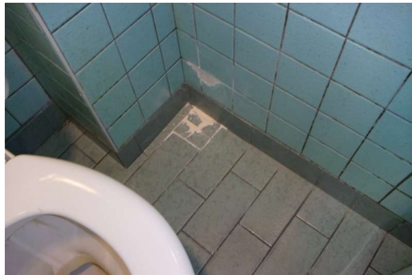
Prélèvement - P308 : R+0 / D21 - Colle de carrelage- (Absence d'amiante)
