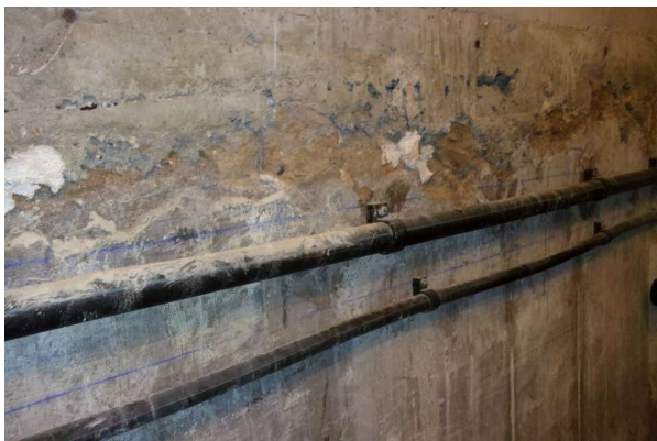
Prélèvement - P443 : R-1 / S36 - Enduit- (Absence d'amiante)
