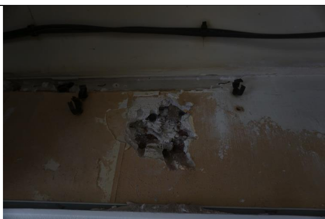
Sondage SC – mur en brique
