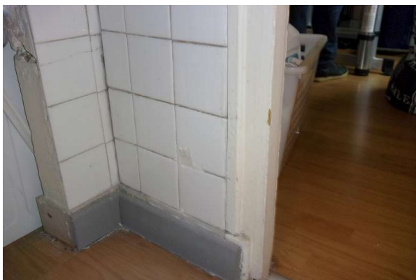
Prélèvement - P267 : R+2 / H203 - Colle de faïence- (Présence d'amiante)
