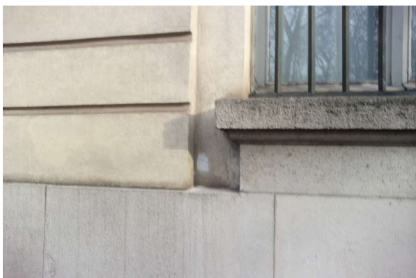
Prélèvement - P369 : R+0 / D14 - Enduit taloché- (Absence d'amiante)
