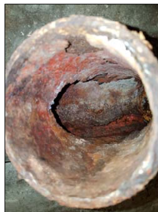
Corrosion et dégradation du revêtement au niveau de la culotte remplacée par le té de visite T27
