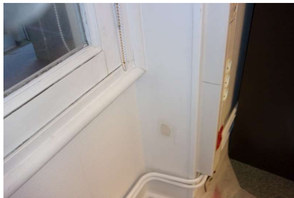
Prélèvement - P110 : R+1 / D111 - Enduit- (Absence d'amiante)
