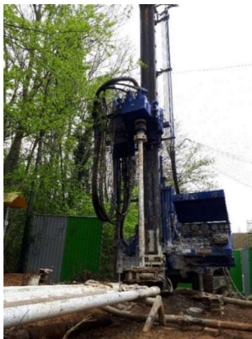
(34) Atelier de forage de 22 tonnes
