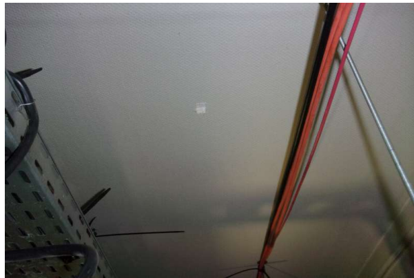
Prélèvement - P206 : R+4 / H412 - Enduit- (Absence d'amiante)
