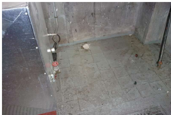
Prélèvement - P030 : R-1 / S11 - Colle de carrelage- (Absence d'amiante)
