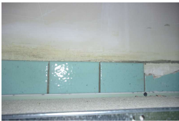
Prélèvement - P133 : R+1 / D138 - Colle de faïence- (Absence d'amiante)
