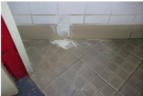
Prélèvement - P439 : R-1 / S4 - Colle de carrelage- (Absence d'amiante)
