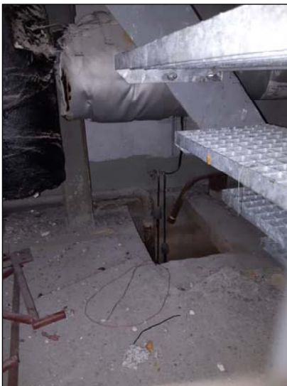
Poste de refoulement salle S3, il reprend les eaux de ruissellement de la salle et une purge.
