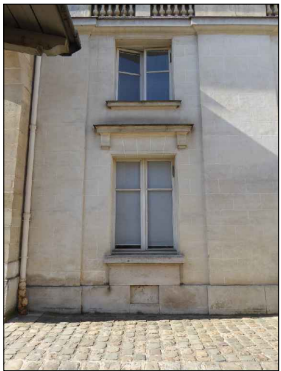
Détail façade courrette Ouest • Socle pierre: traces d'humidité • Appui baie: salissures
