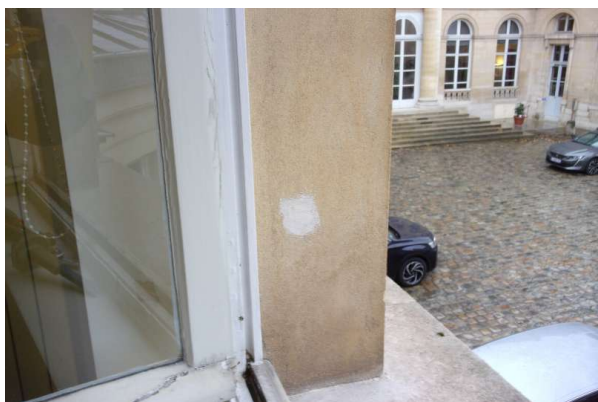
Prélèvement - P033 : R+1 / G104 - Enduit taloché- (Absence d'amiante)
