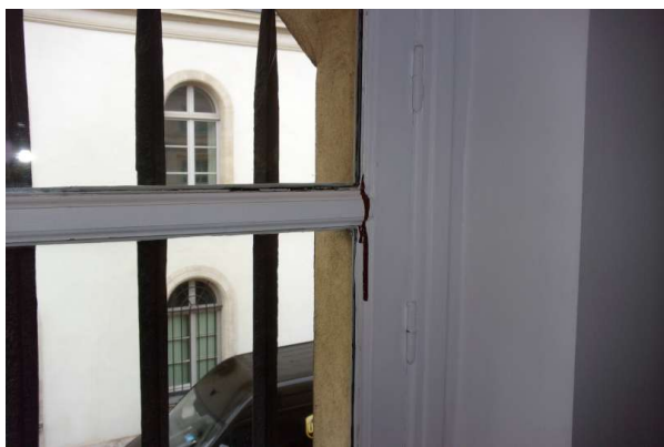
Prélèvement - P019 : R+1 / G118 - Joint de vitrage- (Absence d'amiante)
