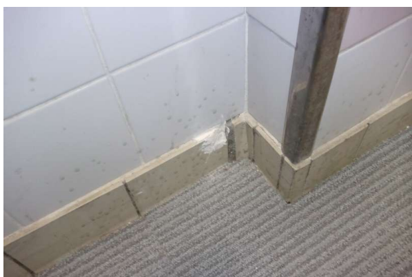
Prélèvement - P087 : R+0 / G30 - Colle de plinthe- (Absence d'amiante)
