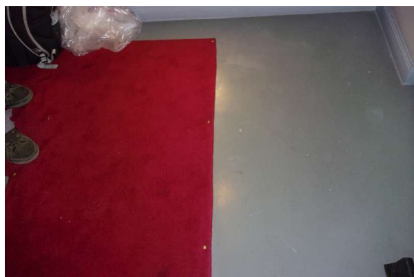
Prélèvement - P072 : R+1 / H100 - Ragréage- (Absence d'amiante)
