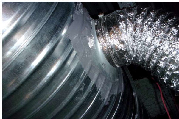
Prélèvement - P046 : R+0 / G5 - Mastic- (Absence d'amiante)
