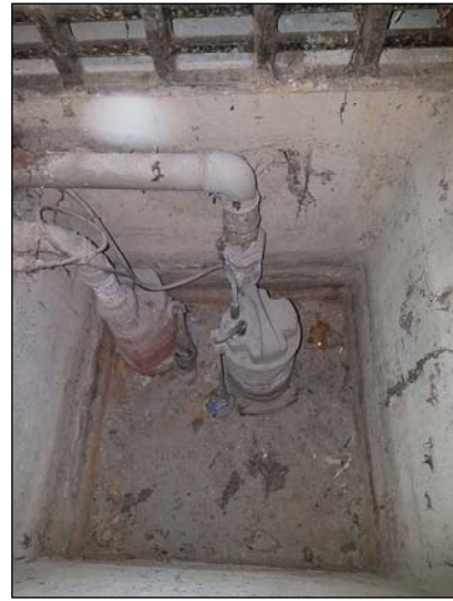
Poste de refoulement salle S36, d'environ 0,25 m 3 , il reprend les eaux de ruissellement de la salle.
