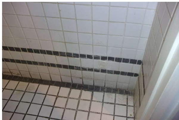
Prélèvement - P038 : R+2 / G208 - Colle de faïence- (Absence d'amiante)
