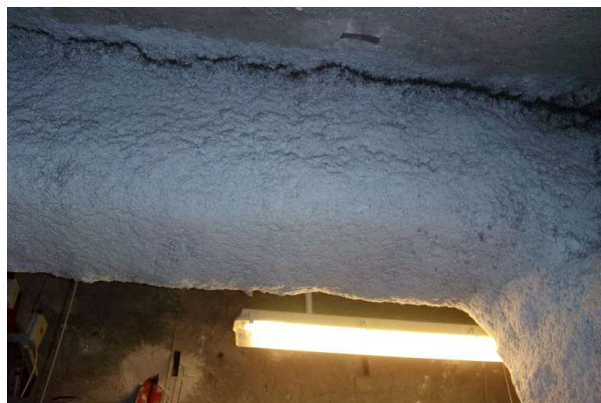
Prélèvement - P414 : R-1 / S24 - Flocage- (Absence d'amiante)
