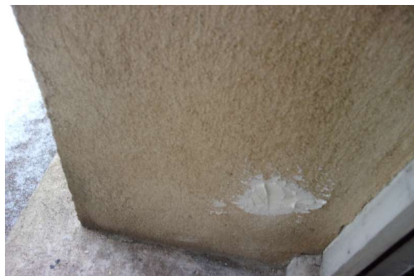
Prélèvement - P276 : R+1 / D127 - Enduit taloché- (Absence d'amiante)
