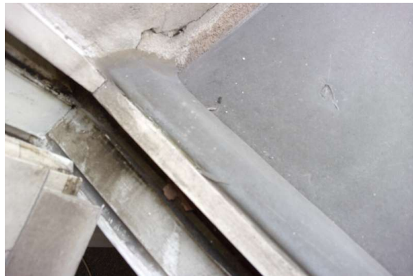
Prélèvement - P150 : R+1 / D125 - Joint d'étanchéité entre menuiserie et structure- (Absence d'amiante)
