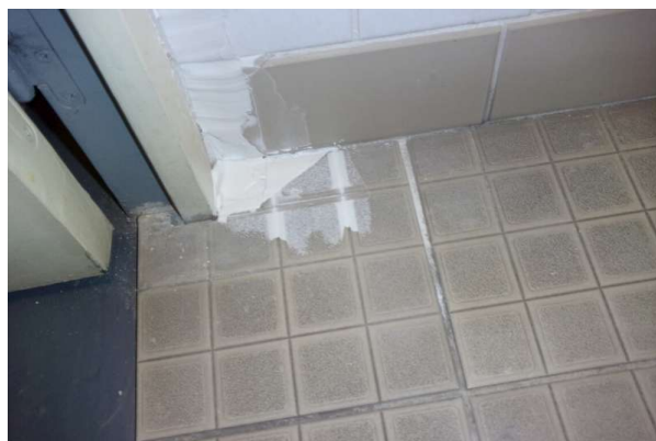
Prélèvement - P436 : R-1 / S4 - Colle de carrelage- (Absence d'amiante)
