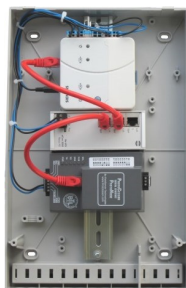
Passerelles GTC/GTB Le kit comprend une interface permettant de raccorder la chaudière aux systèmes GTC et GTB. Il existe 4 kits : - 1 chaudière via passerelles KNX, BACnet et Modbus - 4 chaudières maxi via passerelles KNX, BACnet et Modbus - 1 chaudière via passerelle LON - 4 chaudières maxi via passerelle LON
