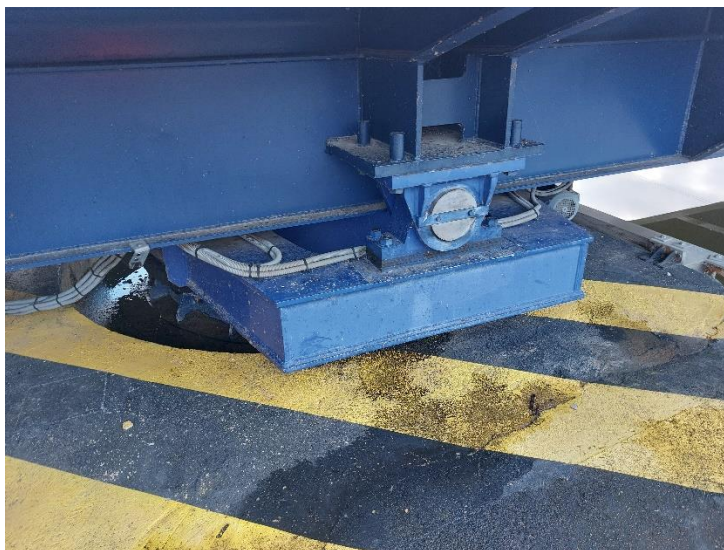
Figure 4 Axe pivot du pont permettant son basculement
