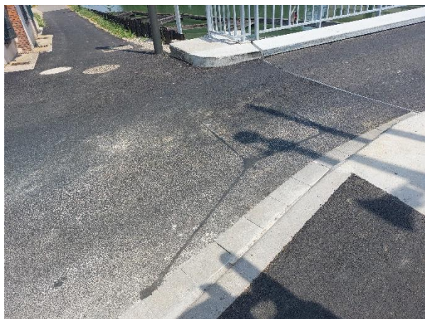
Figure 34 - Boucle de détection de véhicules
