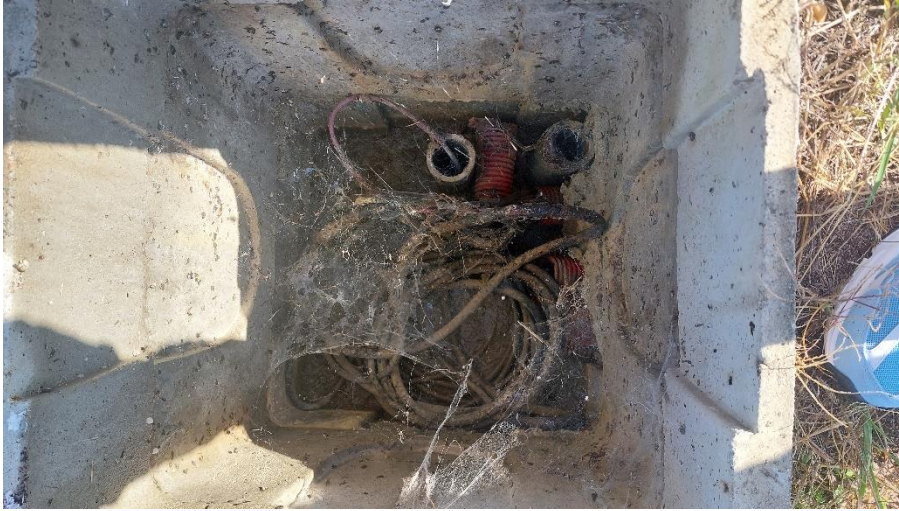
Figure 8 - Etat de la chambre de tirage en rive gauche
