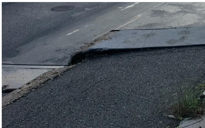
Figure 3 Discontinuité altimétrique à l'interface entre voirie et ouvrage
