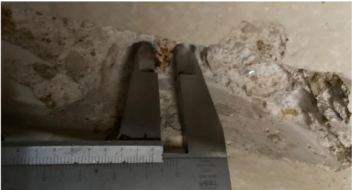
Sondage en sous face de dalle du PHt RDC – Aile gauche
