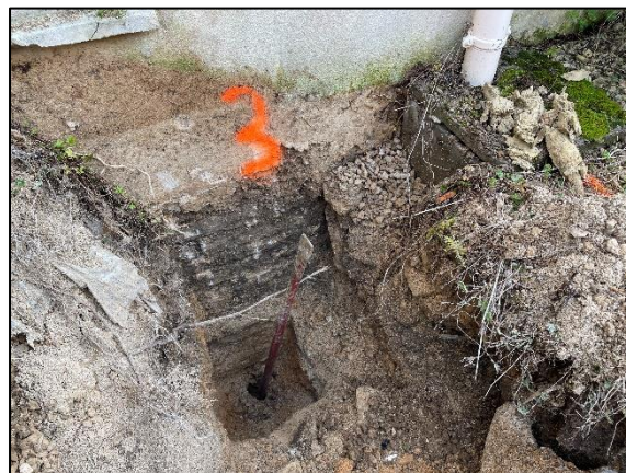
20/03/2023 : Sondage à la pelle mécanique RF3
