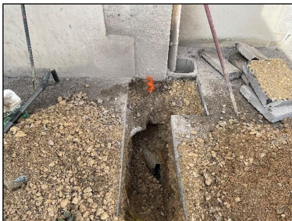
20/03/2023 : Sondage à la pelle mécanique RF4
