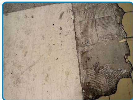
PRLV n° 51 sur Sol Colle carrelage PRLV n° 54 sur Sol devant entrée Ragréage
