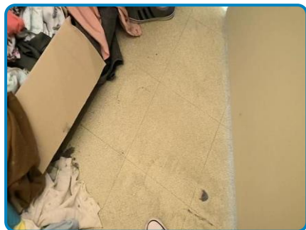
Prélèvement n° 75 : Sol Dalles de sol plastique + colle + ragréage (dans Bâtiment RDC Local (Futur local info))
