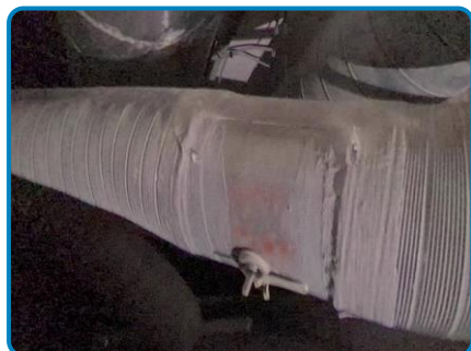
Prélèvement n° 70 : Conduits Joint (dans Bâtiment RDC Plénum Dégagement 4 pièce 7 pièce 8)
