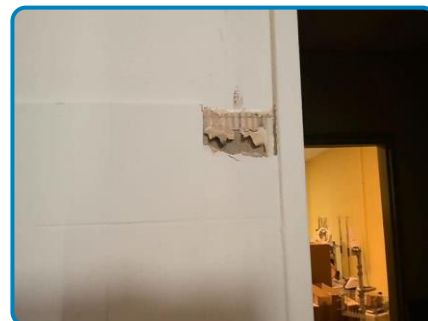
Prélèvement n° 71 : Faïence Colle / A (dans Bâtiment RDC Pièce 7)
