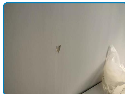
Prélèvement n° 74 : Murs cloison Plaque plâtre + Bande raccord + enduit / ABCD (dans Bâtiment RDC Pièce 7)
