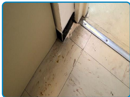
PRLV n° 11 sur Sol Dalles de sol plastique PRLV n° 12 sur Sol Ragréage + colle
