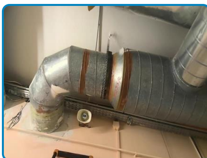
Prélèvement n° 60 : Conduits Joint antivitratile (dans Bâtiment RDC Pièce 5)
