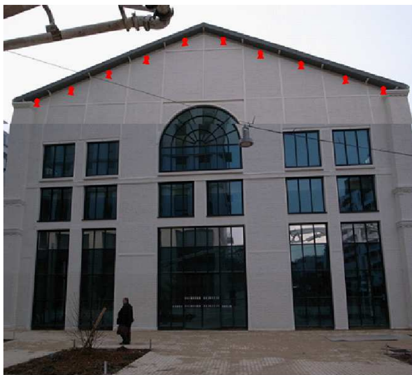
Intégration des luminaires (retour de toit), faisceaux lumineux dirigés vers le parvis.
