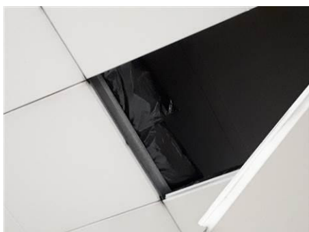
Matériaux : ZPSO-054 Prélèvement : P054 Description : Isolant posé dans le plénum au-dessus du panneau de faux plafond Localisation : Bâtiment 8 / R+1 - Pièce 22; Bâtiment 8 / R+1 - Pièce 23 Résultat : Absence d'amiante
