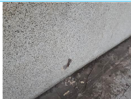
Matériaux : ZPSO-015 Prélèvement : P041 Description : Enduit + peinture pailletée Localisation : Bâtiment 8 / R+1 - Coursive; Bâtiment 8 / R+1 - Pièce 21 Résultat : Absence d'amiante
