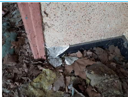
Matériaux : ZPSO-017 Prélèvement : P017 Description : Colle beige de plinthe noire Localisation : Bâtiment 8 / RDC - Pièce 8 Résultat : Absence d'amiante
