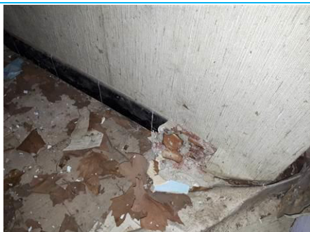
Matériaux : ZPSO-006 Prélèvement : P006 Description : Colle de plinthe noire Localisation : Bâtiment 8 / RDC - Pièce 2; Bâtiment 8 / RDC - Pièce 3; Bâtiment 8 / RDC - Pièce 4 Résultat : Présence d'amiante
