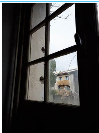
Matériaux : ZPSO-020 Prélèvement : P020 Description : Joint de mastic de vitrage Localisation : Bâtiment 8 / RDC - Pièce 11; Bâtiment 8 / RDC - Pièce 13; Bâtiment 8 / RDC - Pièce 14 Résultat : Absence d'amiante
