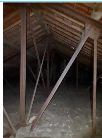
Matériaux : ZPSO-055 Prélèvement : P055 Description : Isolant fibreux posé au sol Localisation : Bâtiment 8 / R+2 - Combles Résultat : Absence d'amiante
