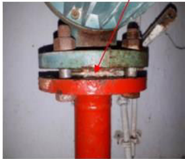
P038 - Amianté Joint plat prédécoupé pour brides
