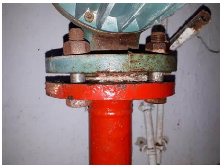
Matériaux : ZPSO-038 Prélèvement : P038 Description : Joint plat prédécoupé pour brides Localisation : Bâtiment 8 / RDC - Pièce 18 Résultat : Présence d'amiante
