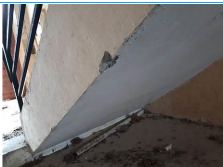
Matériaux : ZPSO-016 Prélèvement : P016 Description : Enduit en sous face d'escalier Localisation : Bâtiment 8 / RDC - Pièce 8 Résultat : Absence d'amiante
