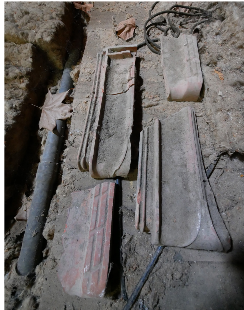
TUILE MÉCANIQUE D'ORIGINE (retrouvée dans les combles du bâtiment 15)
