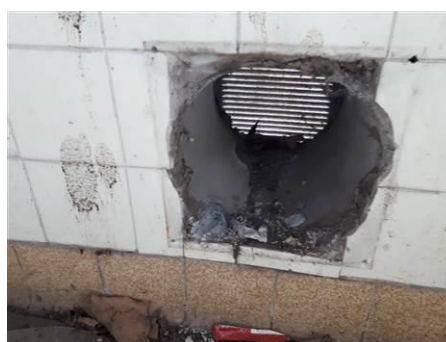
Matériaux : ZPSO-053 Prélèvement : P053 Description : 2 conduits de ventilation en fibres-ciment dans le mur Localisation : Bâtiment 8 / R+1 - Pièce 23 Résultat : Présence d'amiante
