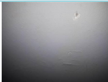
Matériaux : ZPSO-013 Prélèvement : P013 Description : Enduit de plafond dans plenum Localisation : Bâtiment 8 / RDC - Pièce 1; Bâtiment 8 / RDC - Pièce 14; Bâtiment 8 / RDC - Pièce 15; Bâtiment 8 / RDC - Pièce 16; Bâtiment 8 / RDC - Pièce 17; Bâtiment 8 / RDC - Pièce 18 Résultat : Absence d'amiante
