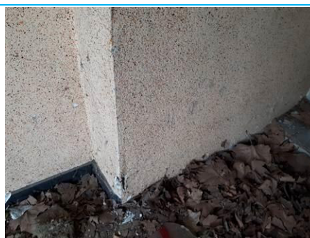
Matériaux : ZPSO-015 Prélèvement : P015 Description : Enduit mural + peinture pailleté Localisation : Bâtiment 8 / RDC - Pièce 8; Bâtiment 8 / RDC - Pièce 13; Bâtiment 8 / R+1 - Palier Résultat : Absence d'amiante
