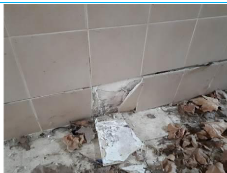
Matériaux : ZPSO-023 Prélèvement : P023 Description : Colle de faïence Localisation : Bâtiment 8 / RDC - Pièce 13 Résultat : Absence d'amiante
