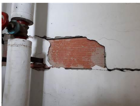
Matériaux : ZPSO-036 Prélèvement : P036 Description : Enduit à base de ciment taloché Localisation : Bâtiment 8 / RDC - Pièce 18 Résultat : Absence d'amiante
