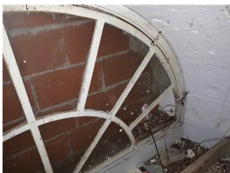
Matériaux : ZPSO-011 Prélèvement : P011 Description : Joint de mastic de vitrage métal dans plenum Localisation : Bâtiment 8 / RDC - Pièce 1 Résultat : Absence d'amiante
