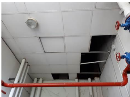
Matériaux : ZPSO-040 Prélèvement : P040 Description : Plaques de faux-plafond Localisation : Bâtiment 8 / RDC - Pièce 18 Résultat : Présence d'amiante
