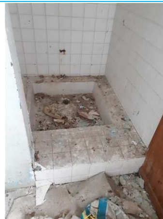
Matériaux : ZPSO-007 Prélèvement : P007 Description : Colle de carrelage dans douche Localisation : Bâtiment 8 / RDC - Pièce 3 Résultat : Absence d'amiante
