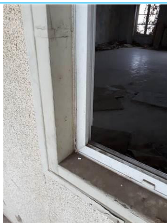
Matériaux : ZPSO-042 Prélèvement : P042 Description : Joint d'étanchéité entre menuiserie PVC et menuiserie bois Localisation : Bâtiment 8 / R+1 - Coursive; Bâtiment 8 / R+1 - Pièce 19; Bâtiment 8 / R+1 - Pièce 20; Bâtiment 8 / R+1 - Pièce 27; Bâtiment 8 / R+1 - Pièce 28 Résultat : Absence d'amiante
