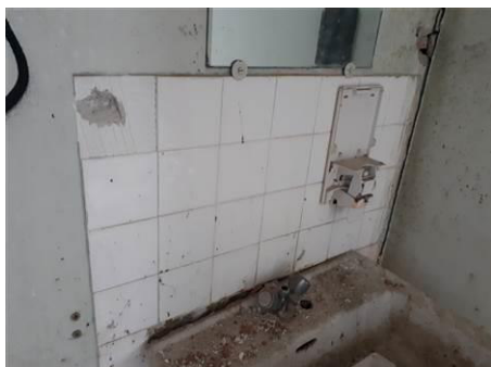
Matériaux : ZPSO-008 Prélèvement : P008 Description : Colle de faïence blanche Localisation : Bâtiment 8 / RDC - Pièce 3 Résultat : Absence d'amiante
