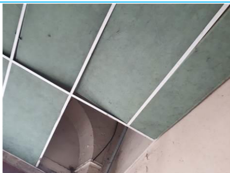
Matériaux : ZPSO-018 Prélèvement : P018 Description : Plaques de faux-plafond Localisation : Bâtiment 8 / RDC - Pièce 8; Bâtiment 8 / RDC - Pièce 18 Résultat : Absence d'amiante
