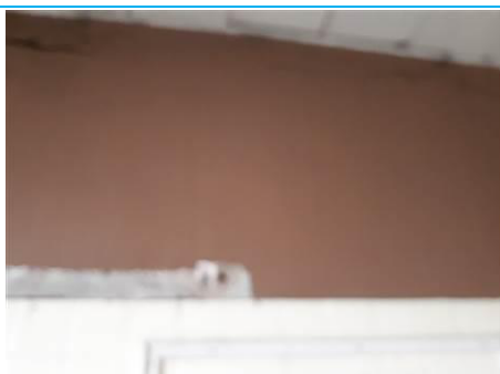
Matériaux : ZPSO-052 Prélèvement : P052 Description : Enduit à base de ciment taloché Localisation : Bâtiment 8 / R+1 - Pièce 22; Bâtiment 8 / R+1 - Pièce 23 Résultat : Absence d'amiante
