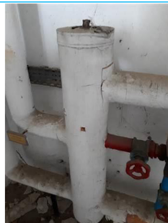
Matériaux : ZPSO-037 Prélèvement : P037 Description : Calorifuge + isolant Localisation : Bâtiment 8 / RDC - Pièce 18 Résultat : Présence d'amiante
