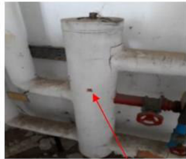
P037 - Amianté Calorifuge + isolant
