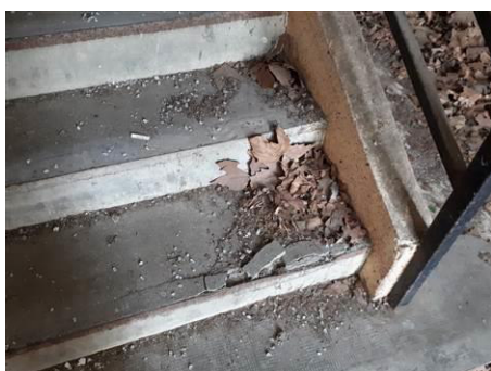
Matériaux : ZPSO-014 Prélèvement : P014 Description : Chape sur marches Localisation : Bâtiment 8 / RDC - Pièce 8 Résultat : Absence d'amiante
