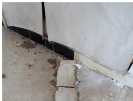
Matériaux : ZPSO-019 Prélèvement : P019 Description : Colle grise de plinthe noire Localisation : Bâtiment 8 / RDC - Pièce 11 Résultat : Présence d'amiante
