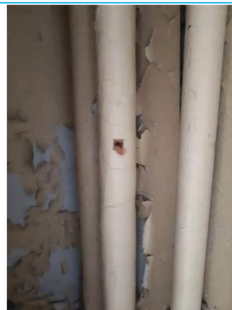
Matériaux : ZPSO-009 Prélèvement : P009 Description : Calorifuge Localisation : Bâtiment 8 / RDC - Pièce 4 Résultat : Présence d'amiante
