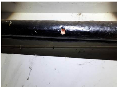
Matériaux : ZPSO-012 Prélèvement : P012 Description : Calorifuge bitumineux dans plenum Localisation : Bâtiment 8 / RDC - Pièce 1 Résultat : Absence d'amiante
