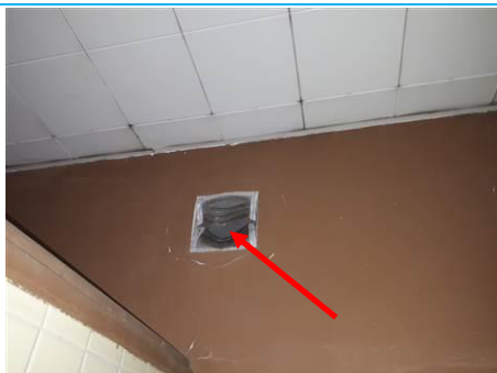
Matériaux : ZPSO-053 Prélèvement : P053 Description : 2 conduits de ventilation en fibres-ciment dans le mur Localisation : Bâtiment 8 / R+1 - Pièce 23 Résultat : Présence d'amiante
