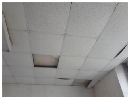
Matériaux : ZPSO-010 Prélèvement : P010 Description : Plaques de faux-plafond Localisation : Bâtiment 8 / RDC - Pièce 4; Bâtiment 8 / RDC - Pièce 16; Bâtiment 8 / RDC - Pièce 17 Résultat : Absence d'amiante
