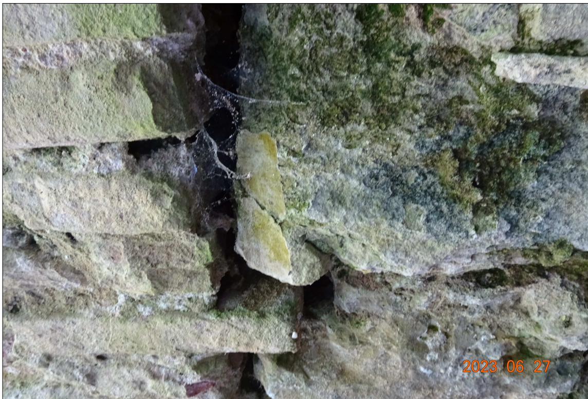
Photo 15: zone de disjoiement préférentiel au droit du bandeau (partie aval)
