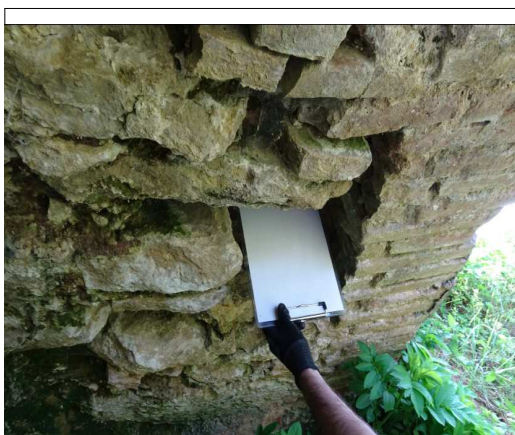
Illustration 12 : Lacune derrière bandeau.
