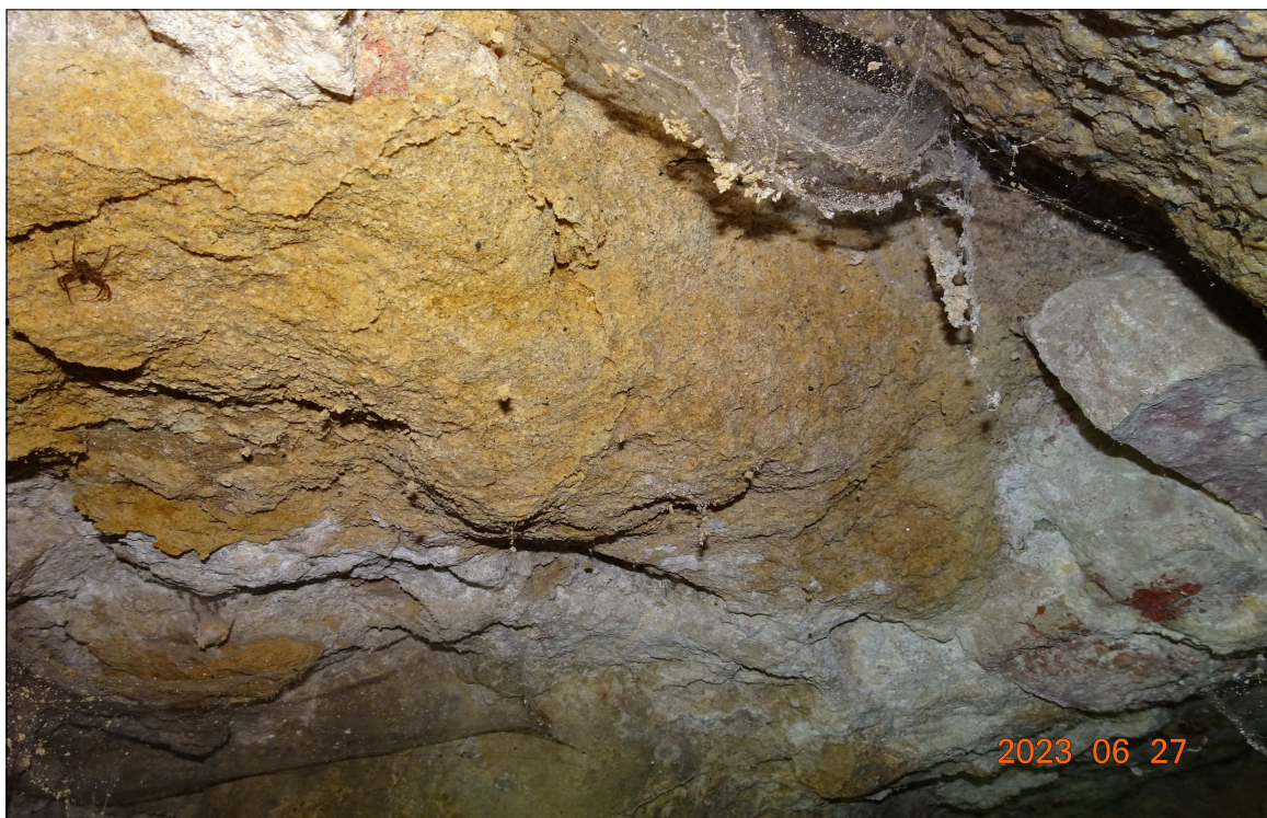
Photo 17: vue type d'altération du matériau - ici moellon d'environ 20x30 cm
