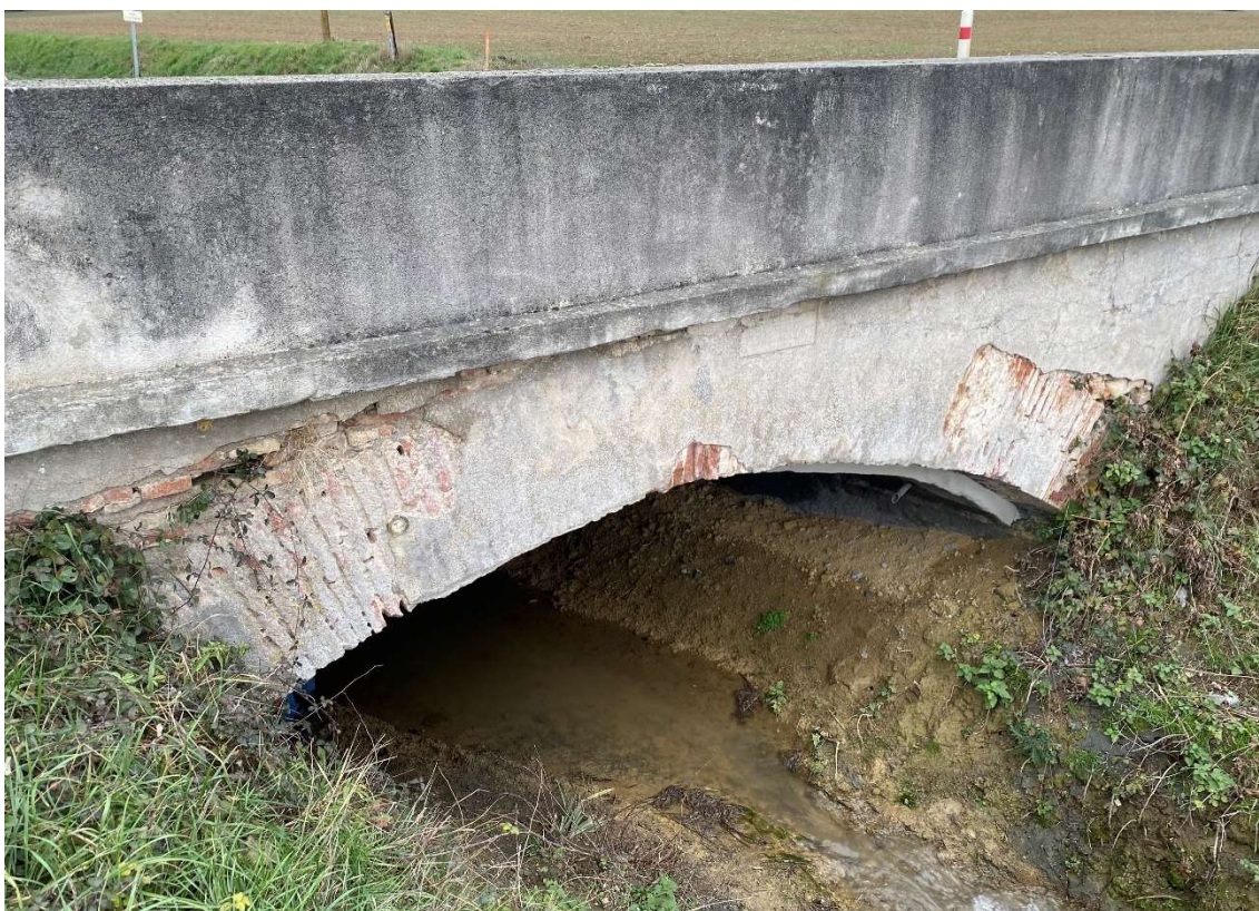
Figure 8 : Photo de la partie en aval du pont avec la partie en maçonnerie prise le 10/01/24
