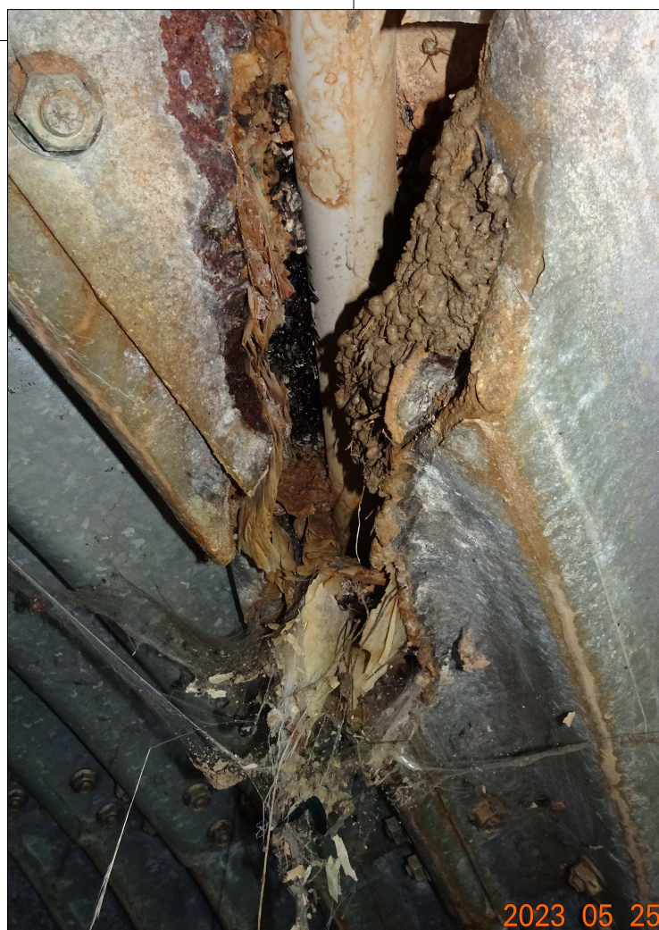
Photo 11: Détail déchirure avec réseau apparent
