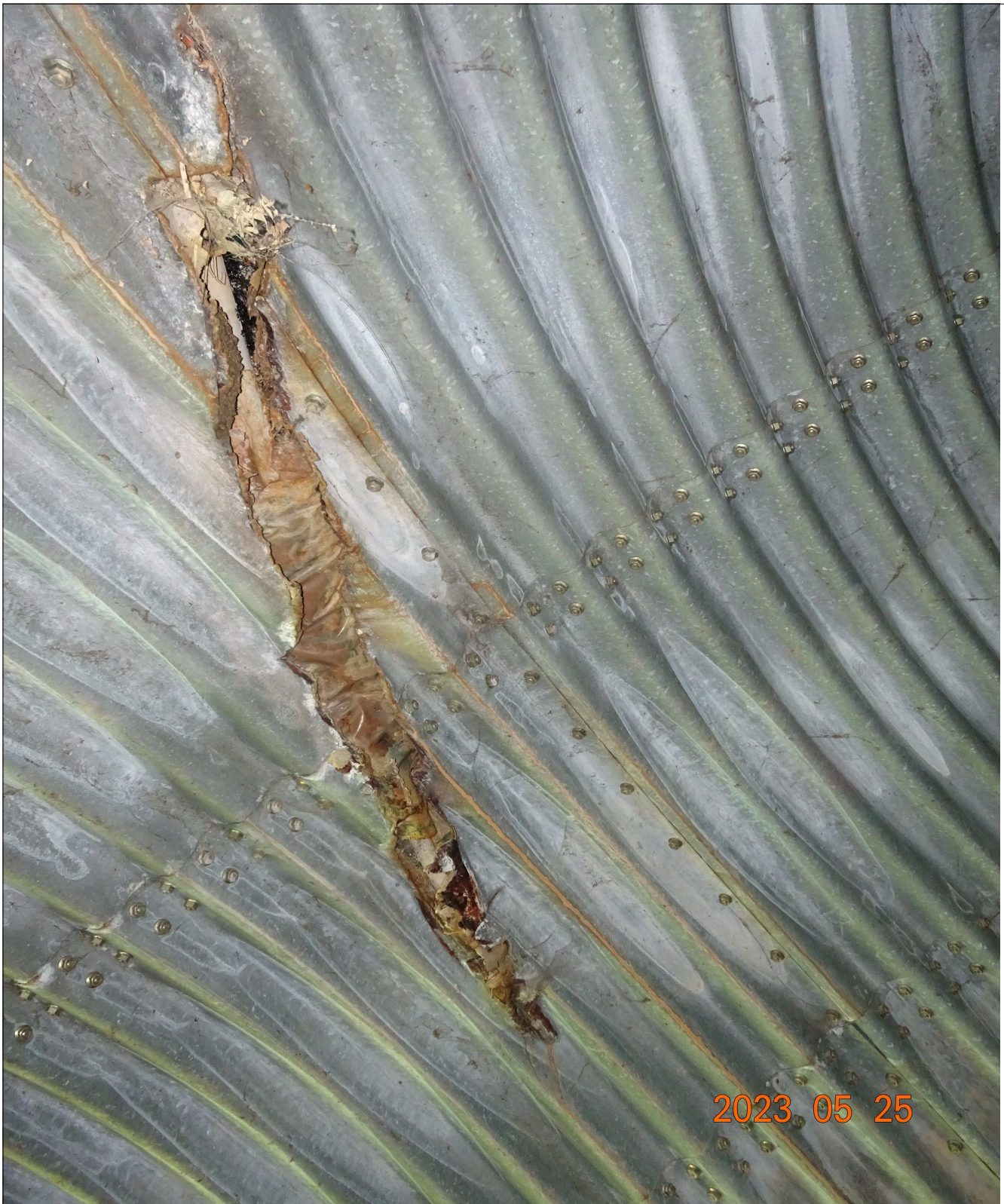
Photo 7: déchirure biaise en clé (longueur de 2 m, ouverture entre 6 et 12 cm)
