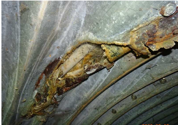
Illustration 14 : Déchirure en clé de buse métallique.
