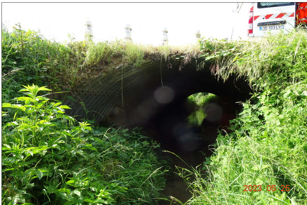
Photo 3: amont de l'ouvrage (buse métallique)
