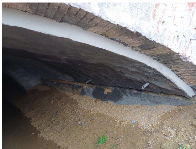
Illustration 4: Confortement provisoire de la voûte.
