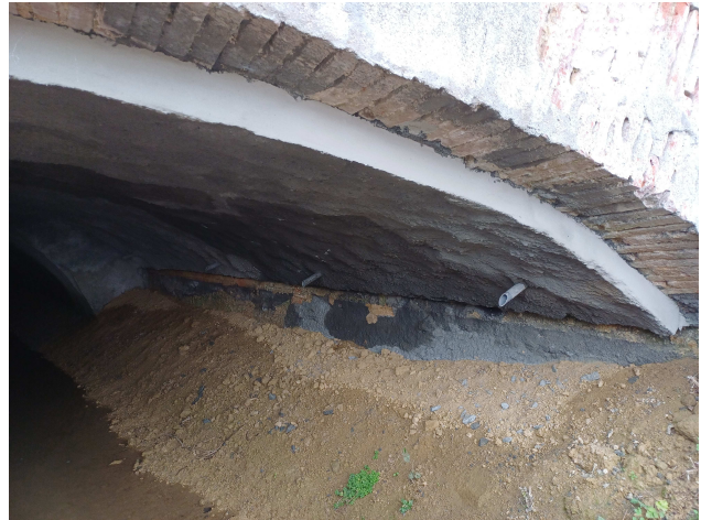
Illustration 15: Confortement provisoire de la voûte.
