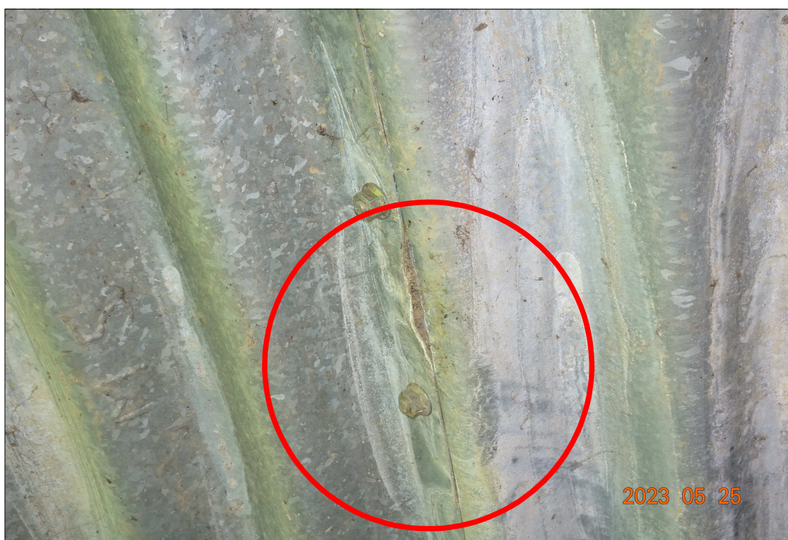
Photo 4: défaut de type décollement de plaque
