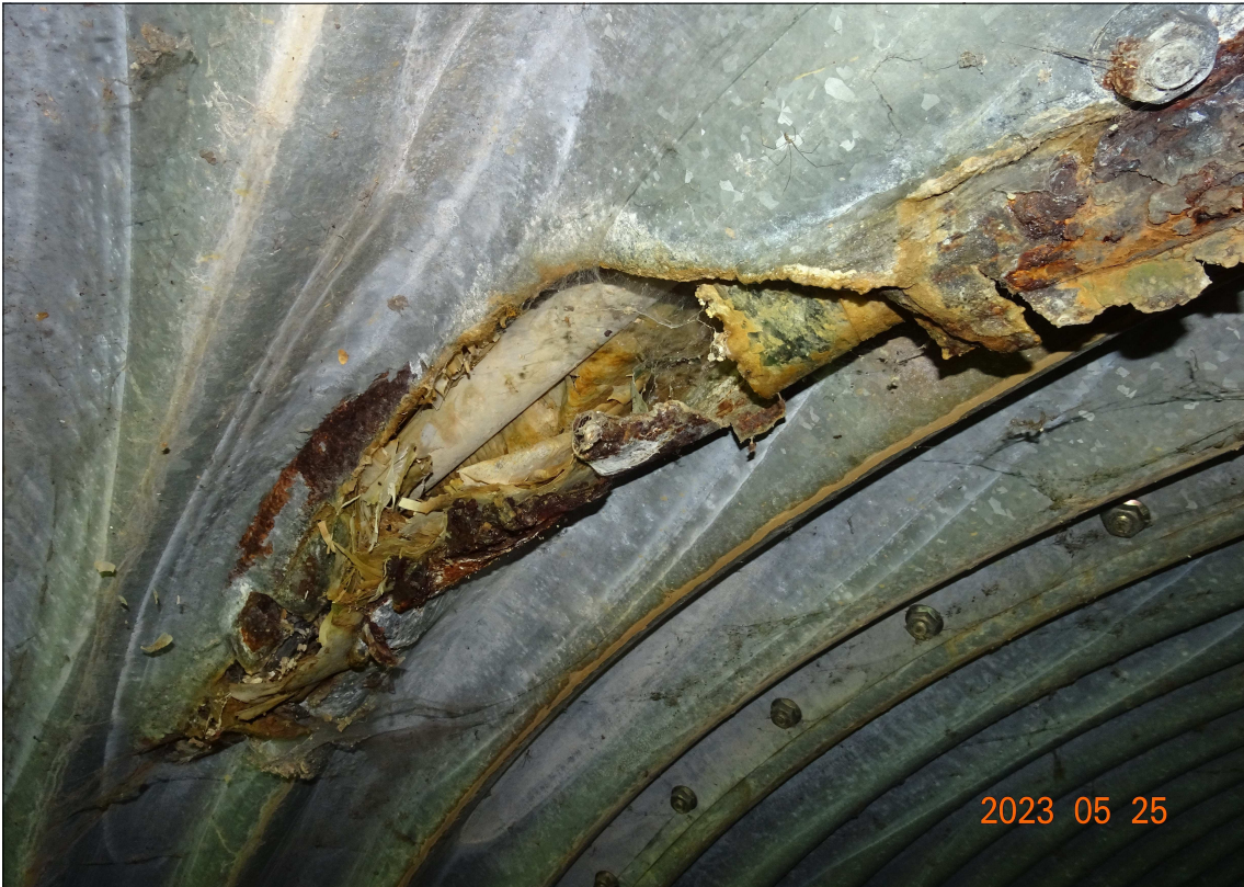
Photo 8: Détail déchirure partie RG
