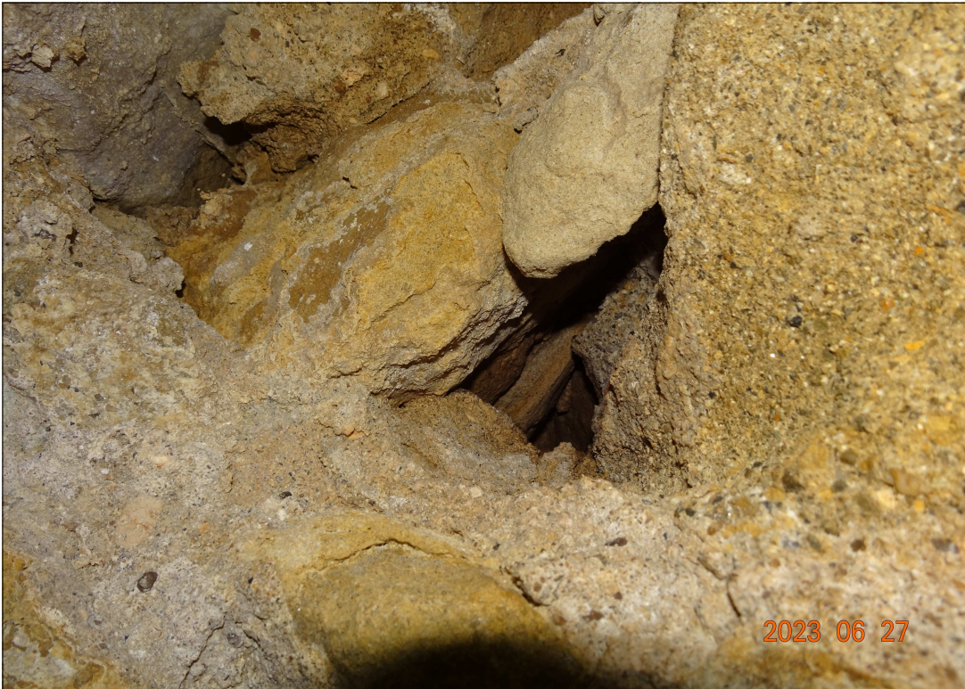
Photo 18: Disjointement avec fuite probable de matériaux jusqu'à la zone de queutage _ profondeur de 30 cm
