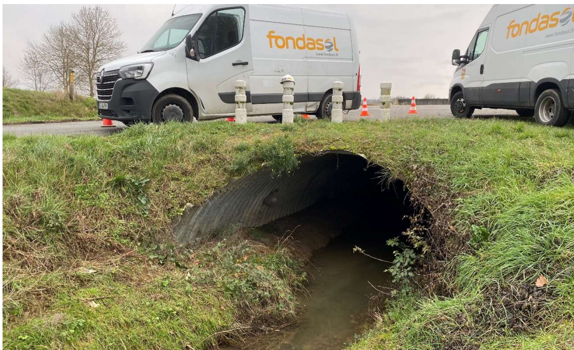
Figure 7 : Photo de la partie amont du pont avec la buse métallique prise le 10/01/24
