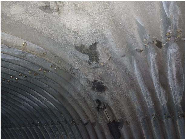
Illustration 17 : Projection de la déchirure de buse.
