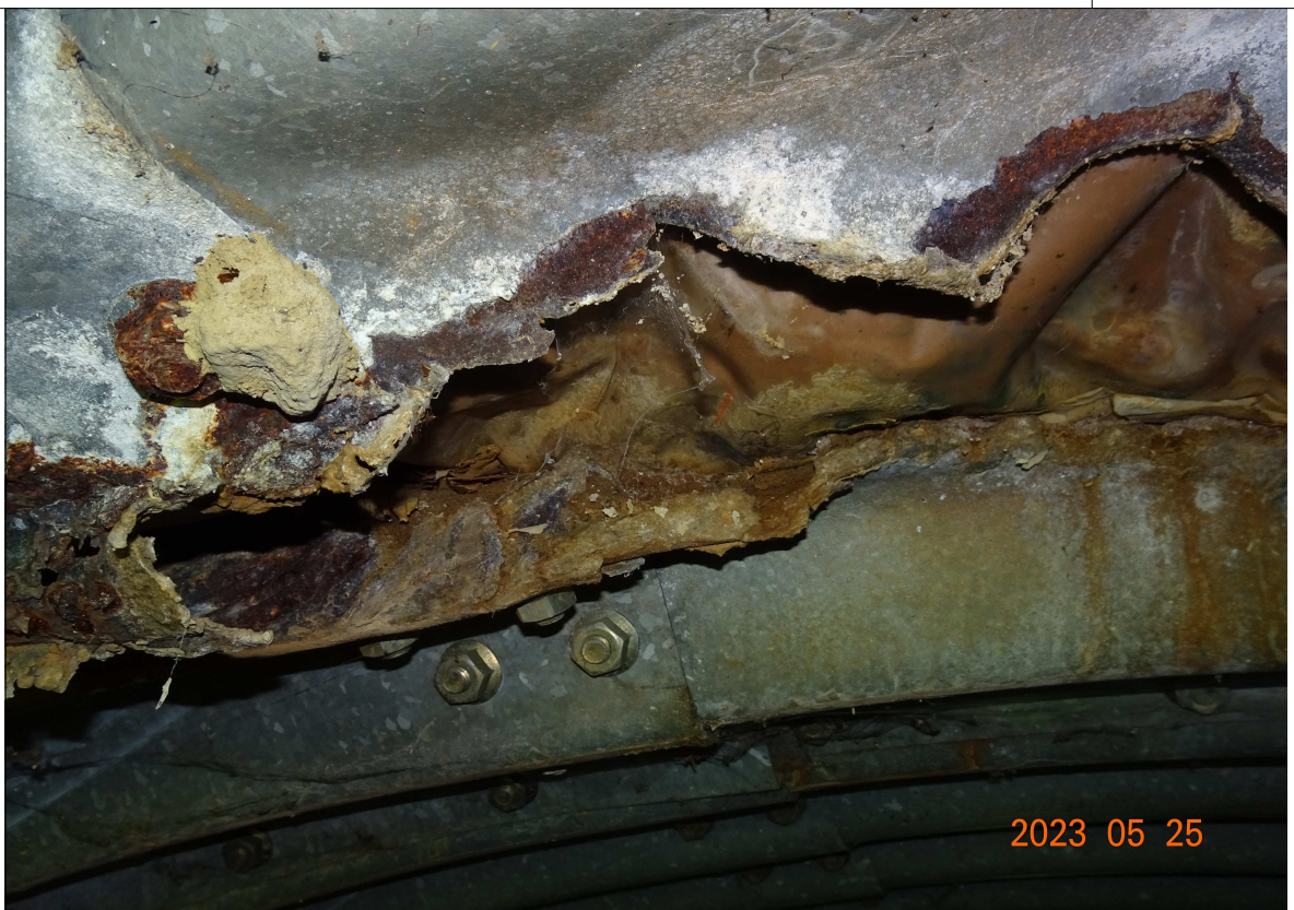
Photo 9: Détail déchirure partie clé
