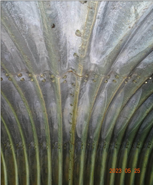
Photo 5: amorce de corrosion avec traces de coulures
