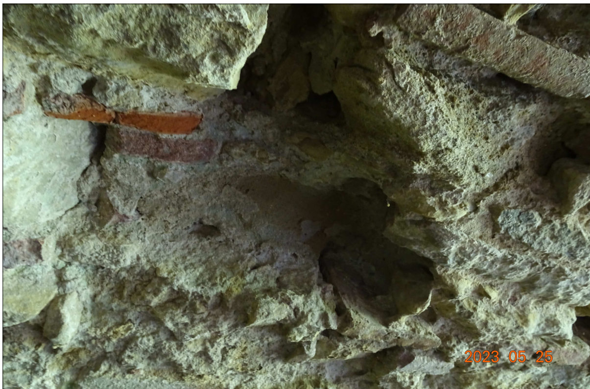
Photo 13: cavité-lacune partie amont au droit de la clé (RG)
