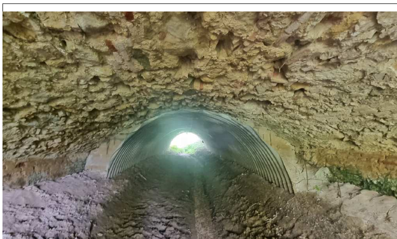
Illustration 13 : Dégradation de la maçonnerie.
