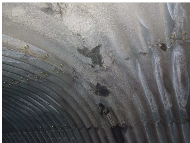
Illustration 6 : Projection de la déchirure de buse.
