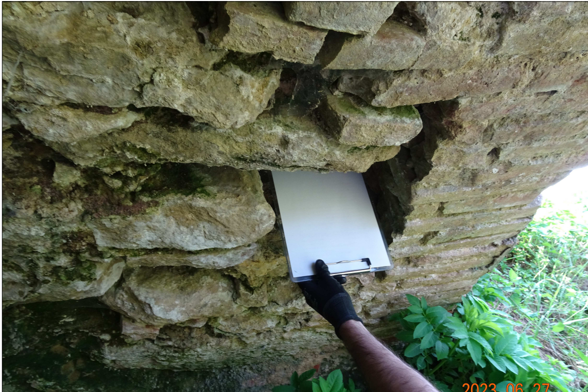
Photo 14: cavité-lacune partie aval au droit bandeau (RG)
