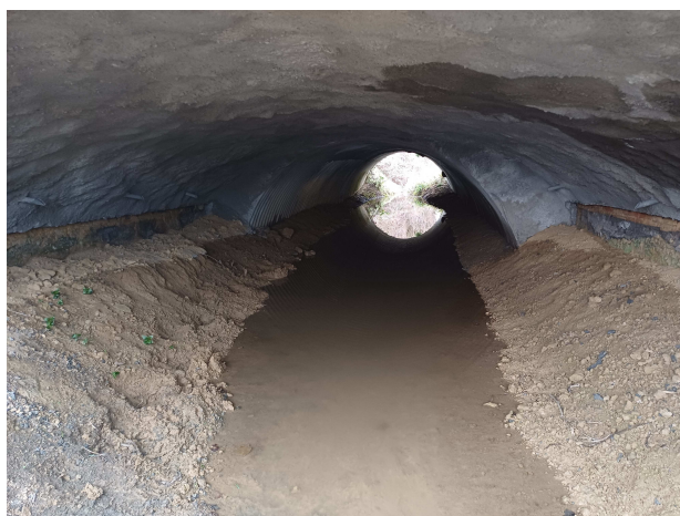
Illustration 5 : Confortement provisoire de la voûte.
