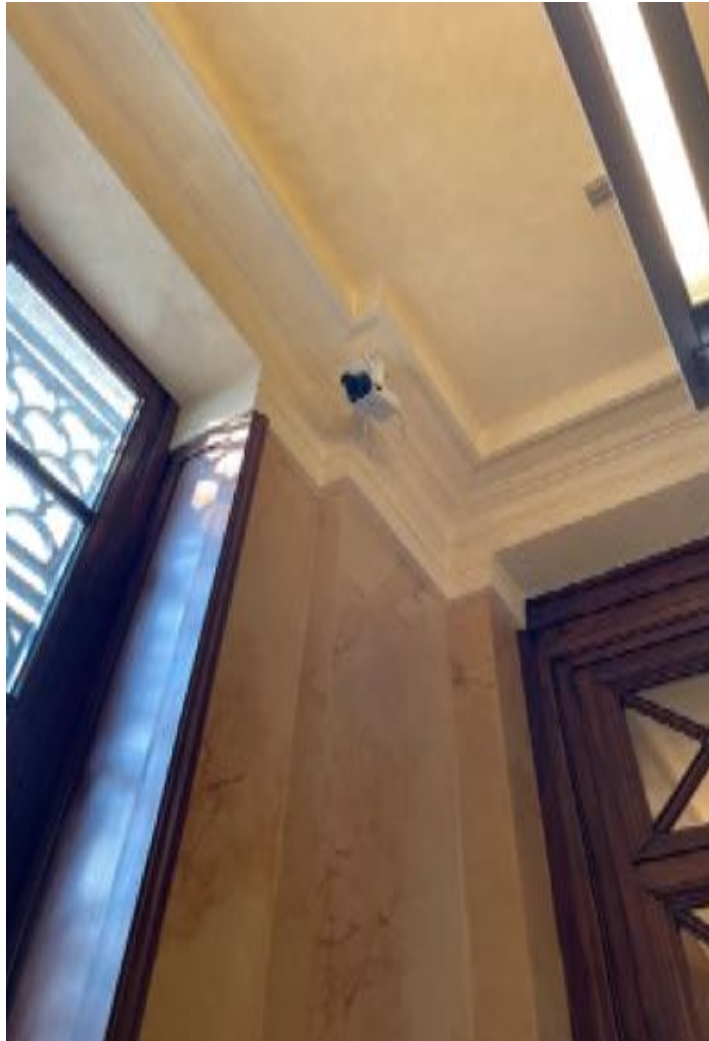
Caméra fixation par platine sur moulure
