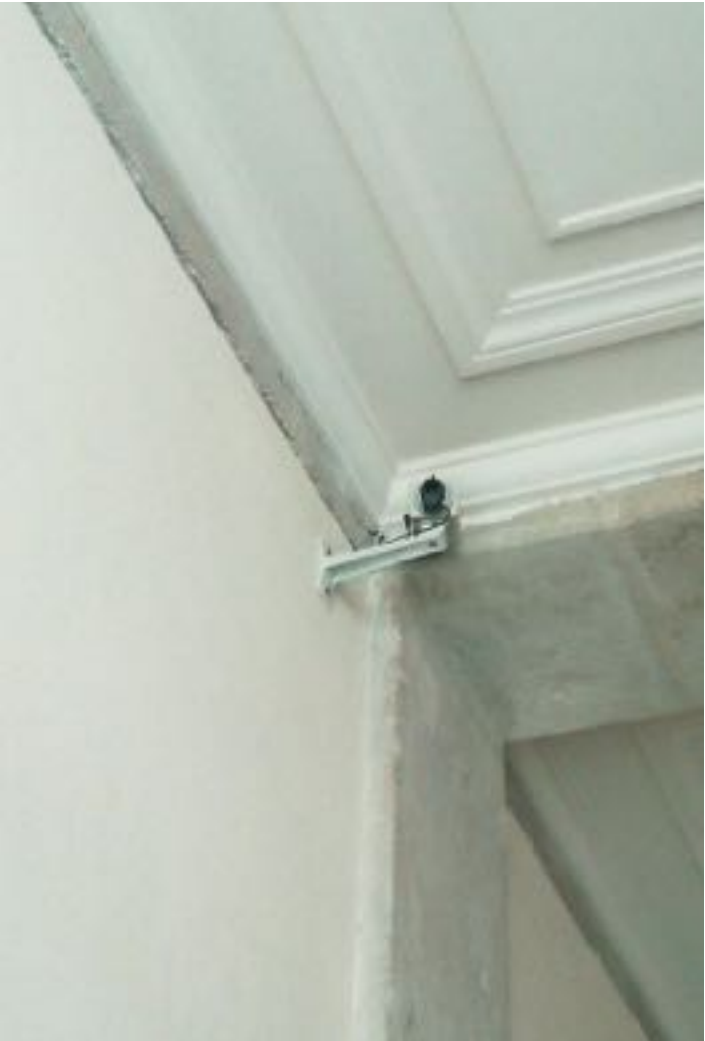
Caméra Fixation par platine sur enduit
