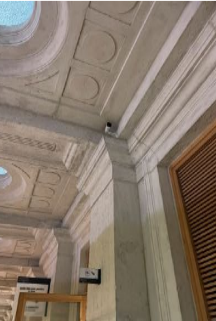
Caméra Fixation par platine sur caisson pierre
