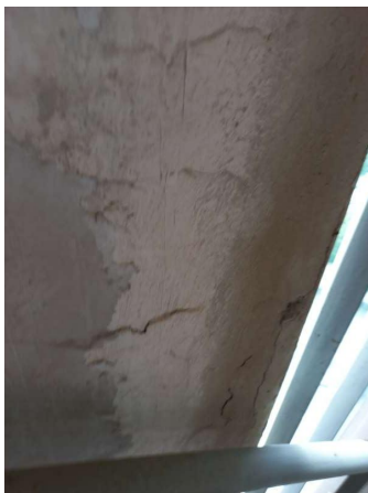
Prélèvement - P011 : RECTORAT NICE / R+3 / Cage escalier OUEST - Enduit- (Absence d'amiante)
