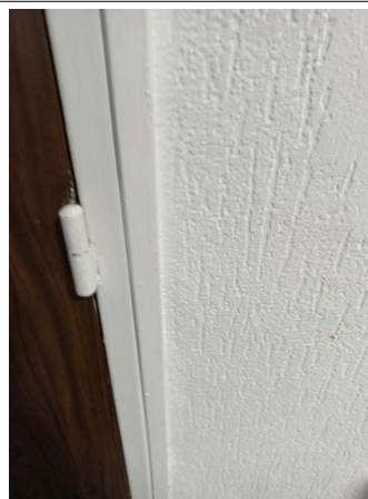
Prélèvement - P010 : RECTORAT NICE / R+4 / Local 404 Dégagement - Joint- (Absence d'amiante)
