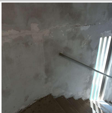
Prélèvement - P041 : RECTORAT - BÂTIMENT PRINCIPAL / NIVEAU R+5 / ESCALIER EST - Enduit- (Présence d'amiante)
