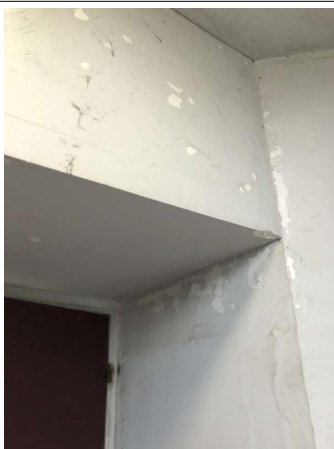
Prélèvement - P032 : RECTORAT - BÂTIMENT PRINCIPAL / NIVEAU R+1 / ESCALIER OUEST - Enduit- (Absence d'amiante)
