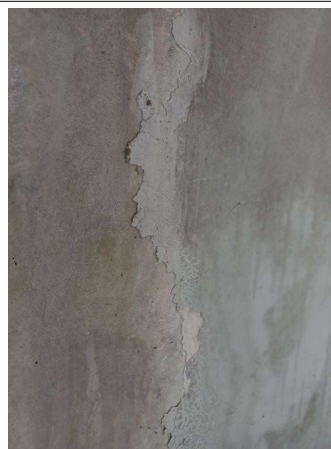
Prélèvement - P020 : RECTORAT NICE / RDC / Cage escalier EST - Enduit- (Présence d'amiante)
