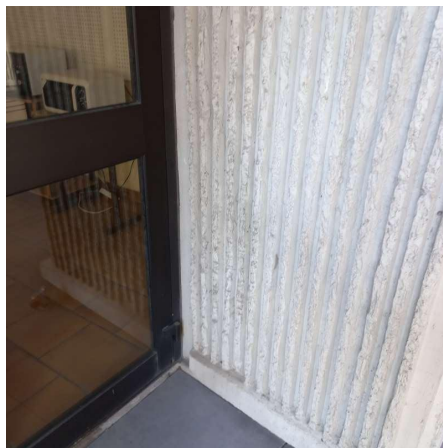
Prélèvement - P047 : RECTORAT - BÂTIMENT PRINCIPAL / EXTERIEUR / FACADES SALLES COMMISSIONS - RECEPTION - Enduit- (Absence d'amiante)
