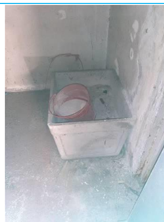
Matériaux : ZPSO-006 Prélèvement : P011 Description : Élément en fibres-ciment Localisation : Rectorat Sous-sol - Local 1 Résultat : Présence d'amiante Quantité : 0,1 T
