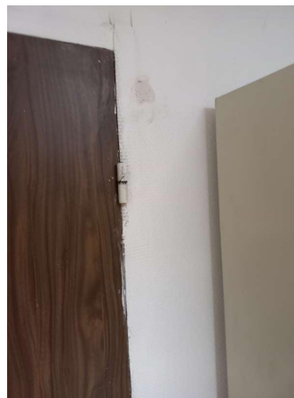
Prélèvement - P024 : RECTORAT NICE / RDC / Local 019 reprographie - Joint- (Absence d'amiante)
