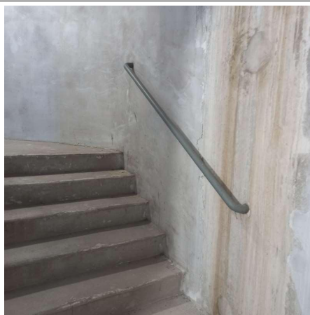
Prélèvement - P045 : RECTORAT - BÂTIMENT PRINCIPAL / NIVEAU RDC / ESCALIER OUEST - Enduit- (Absence d'amiante)
