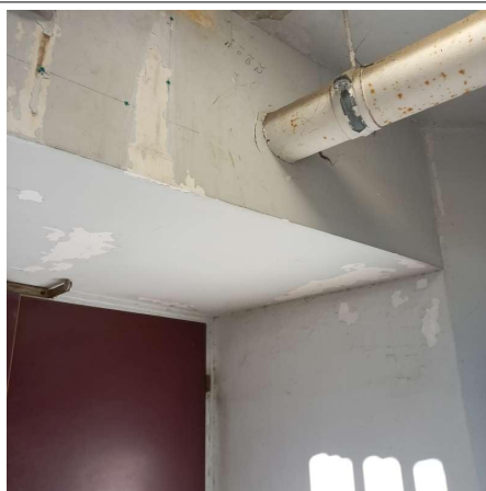
Prélèvement - P037 : RECTORAT - BÂTIMENT PRINCIPAL / NIVEAU R+3 / ESCALIER EST - Enduit- (Absence d'amiante)
