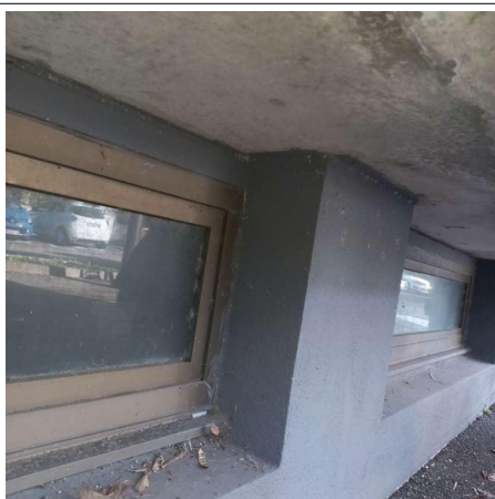
Prélèvement - P015 : RECTORAT - BÂTIMENT PRINCIPAL / EXTERIEUR / FACADE NORD - Enduit- (Absence d'amiante)
