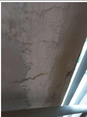
Prélèvement - P007 : RECTORAT NICE / R+4 / Cage escalier EST - Enduit- (Absence d'amiante)
