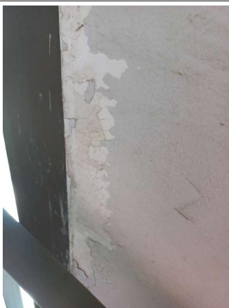
Prélèvement - P015 : RECTORAT NICE / R+2 / Cage escalier OUEST - Enduit- (Absence d'amiante)
