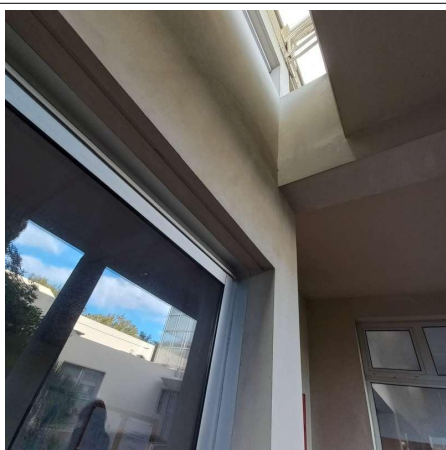
Prélèvement - P015 : RECTORAT - DSDEN-CANOPE / EXTERIEUR / FACADE NORD - Enduit- (Absence d'amiante)
