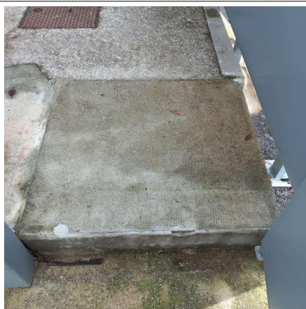
Prélèvement - P002 : RECTORAT / EXTERIEUR / ENTREE AV CAP DE CROIX - Sol coulé- (Absence d'amiante)
