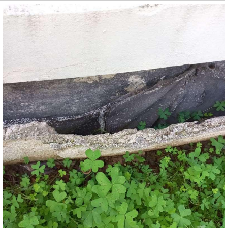
Prélèvement - P008 : RECTORAT - DSDEN-CANOPE / EXTERIEUR / FACADE SUD - Revêtement bitumineux des fondations- (Absence d'amiante)
