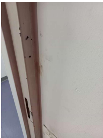
Prélèvement - P023 : RECTORAT NICE / RDC / Local 002 Sécurité - Joint- (Absence d'amiante)
