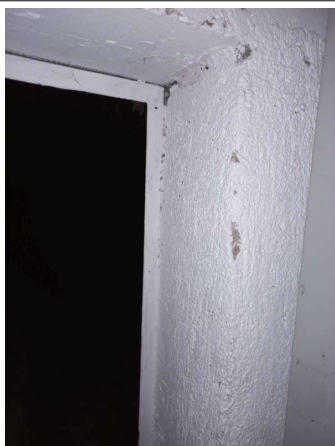
Prélèvement - P003 : RECTORAT NICE / R-1 / Local 049 Vide sanitaire - Joint- (Absence d'amiante)
