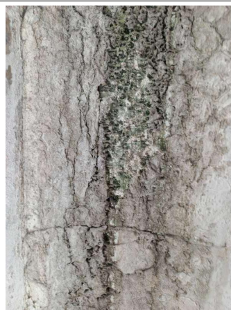
Prélèvement - P016 : RECTORAT NICE / R+2 / Cage escalier EST - Enduit- (Absence d'amiante)
