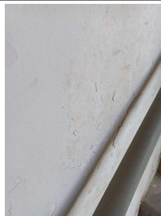
Prélèvement - P006 : RECTORAT NICE / R+4 / Cage escalier OUEST - Enduit- (Absence d'amiante)
