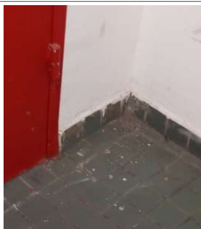
Prélèvement - P004 : RECTORAT - DSDEN-CANOPE / NIVEAU 100 / SAS 122 - Colle- (Absence d'amiante)
