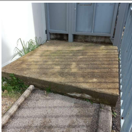
Prélèvement - P001 : RECTORAT / EXTERIEUR / ENTREE AV CAP DE CROIX - Sol coulé- (Absence d'amiante)
