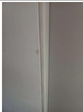
Prélèvement - P014 : RECTORAT NICE / R+2 / Local 248 - Joint- (Absence d'amiante)
