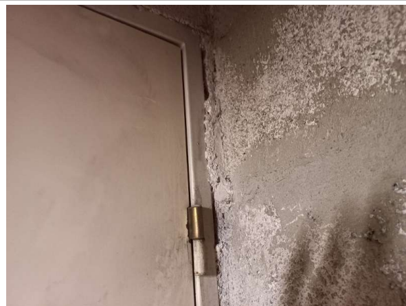
Prélèvement - P002 : RECTORAT NICE / R-1 / Local 013 Autocommutateur - Joint- (Absence d'amiante)
