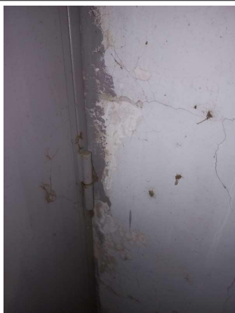
Prélèvement - P005 : RECTORAT NICE / R+5 / Cage escalier OUEST - Enduit- (Absence d'amiante)
