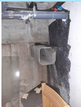
Matériaux : ZPSO-005 Prélèvement : P010 Description : Conduits fibrociment gris Localisation : Rectorat Sous-sol - Hall; Rectorat Sous-sol - TGBT; Rectorat Sous-sol - Vide sanitaire; Rectorat Sous-sol - Couloir Résultat : Présence d'amiante Quantité : 3 ml
