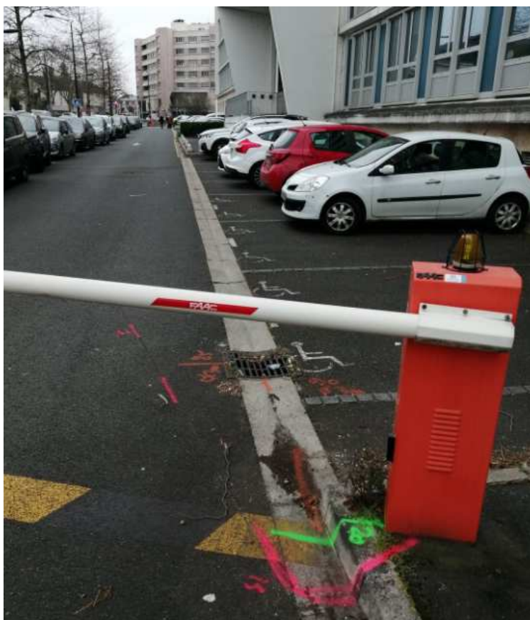
Photo n°12 – Présence du réseau d'alimentation de la barrière, d'un réseau Enedis et d'un réseau d'assainissement.
