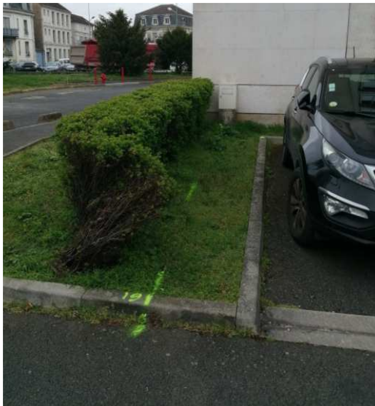
Photos n°2 – Présence d'un branchement GRDF à 60cm de profondeur.
