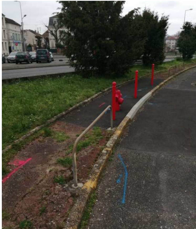
Photo n°10 – Zone de doute sur l'emplacement exacte du réseau d'eau et présence d'un réseau Enedis à 65cm de profondeur.
