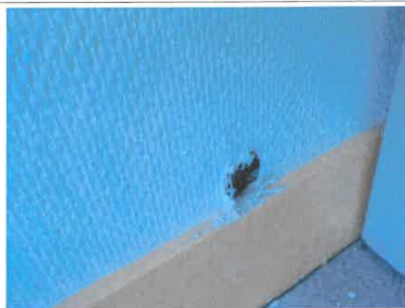
Prélèvement - P004 : R+4 / BUREAU N° 430 - Plaque- (Absence d'amiante)
