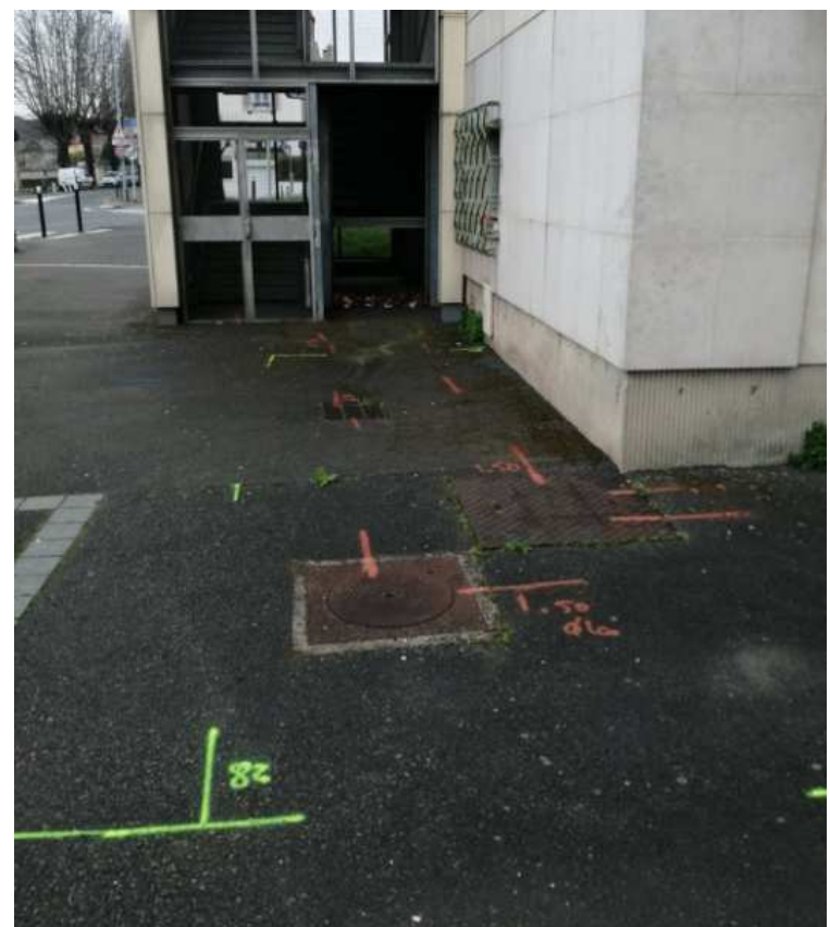
Photo n°3 – Détection d'un réseau gaz et de plusieurs réseaux d'assainissement.
