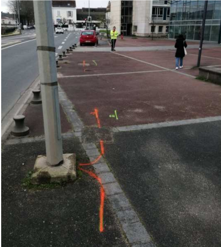
Photo n°4 – Détection du réseau d'éclairage par branchement directe sur la câblette de cuivre.
