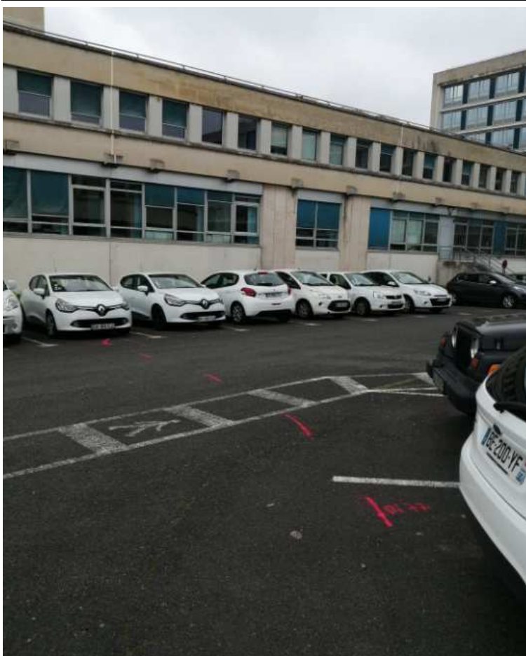
Photo n°11 – Détection d'un réseau inconnu entre 70 et 80cm de profondeur.
