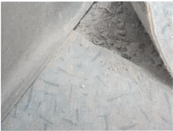
Prélèvement - P009 : R+1 / BUREAU N° 10 C - Ragréage- (Absence d'amiante)
