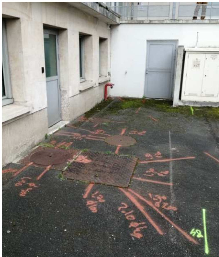
Photo n°5 – Présence de plusieurs réseaux d'assainissement.
