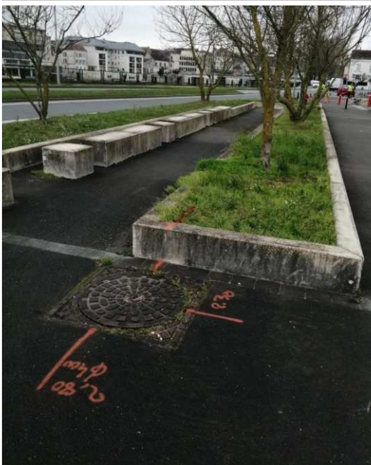
Photo n°8 – Réseau d'assainissement à 2m80 de profondeur de diamètre 400.
