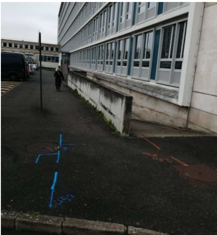
Photos n°1 – Détection d'un réseau AEP à 1m45 de profondeur.
