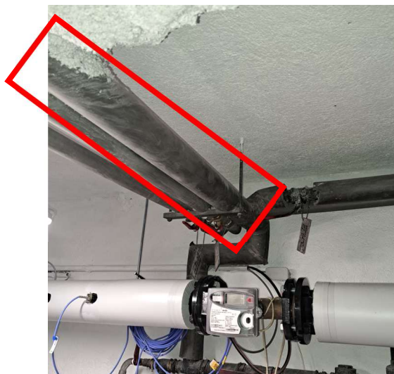
Point de raccordement sur la conduite EF
