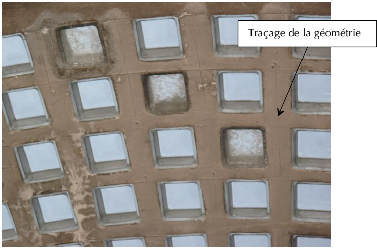
Figure 5 – Pavés de verre fissurés, infiltrations au niveau des joints
