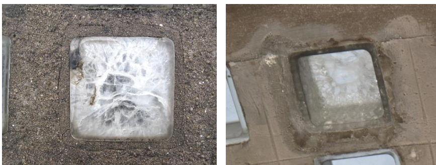
Figure 21 - Joint (et pavé ?) ayant été remplacé et n'assurant plus l'étanchéité
