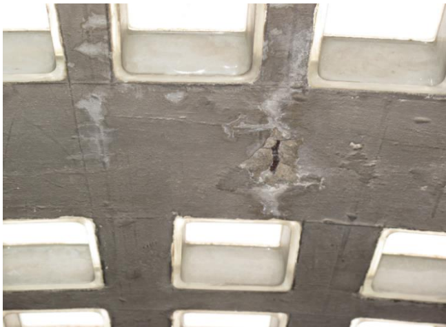
Figure 7 – Epaufrure, concrétions salines et armature corrodée
