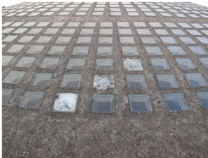
Figure 9 – Pavés de verre fissurés, encrouement superficiel du béton
