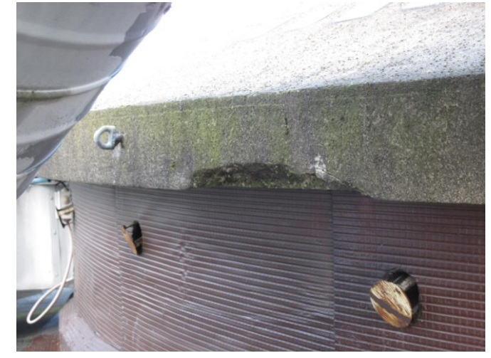
Figure 15 – Colonisation biologique, épaufrure du béton
