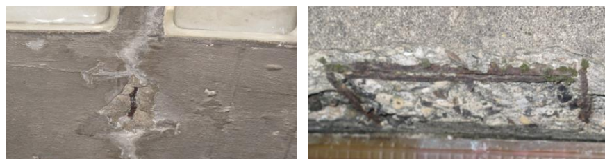
Figure 19 - exemple d'armatures relevées présentant des traces de corrosion
