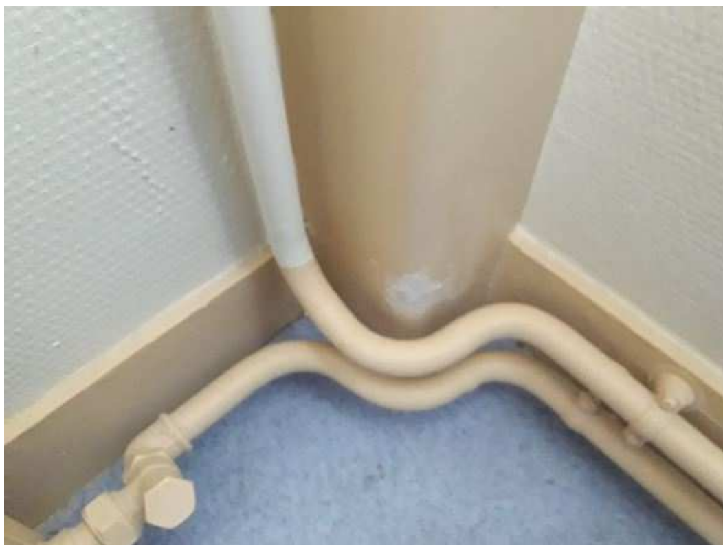
P25 - Bureau 133 (1er étage- FINANCES PUBLIQUES) - Gaines/coffres verticaux - Gaines/coffres en fibres-ciment
