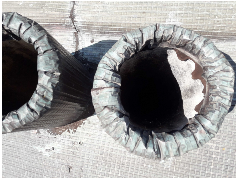
TOITURE (Enveloppe)- Conduits de ventilation, aération fibres-ciment
