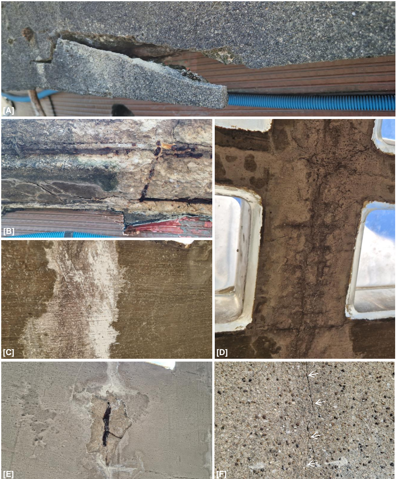
[A] : épaufrure induite par le gonflement par corrosion des armatures sous-jacentes. [B] : détail d'une perte de matière laissant apparaître une armature sous-jacente corrodée. [C] : détail d'une efflorescence blanche [D] : détail de concrétion saline sur l'intrados du dôme. [E] : détail d'une fissure affectant l'extrados du dôme.
