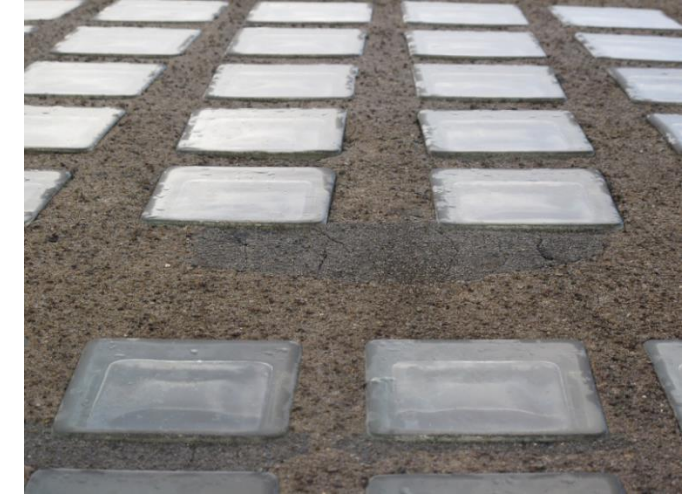
Figure 16 – Reprise au mortier de réparation de teinte différente
