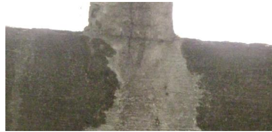
Figure 20 - Exemple de trace de calcite relevée sur l'intrados du dôme
