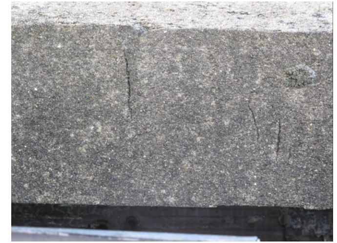
Figure 14 – Faïençage superficiel
