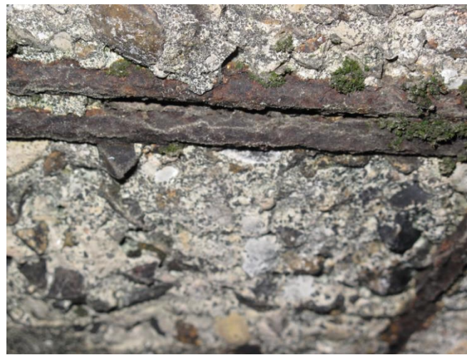
Figure 13 – Perte de matière importante laissant à nue des armatures corrodées
