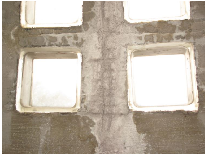
Figure 8 – Voile blanchâtre et concrétions salines
