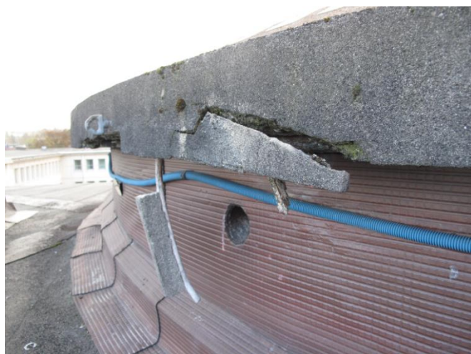
Figure 10 – Eclatement du béton, recouvrement biologique, encrouement noirâtre
