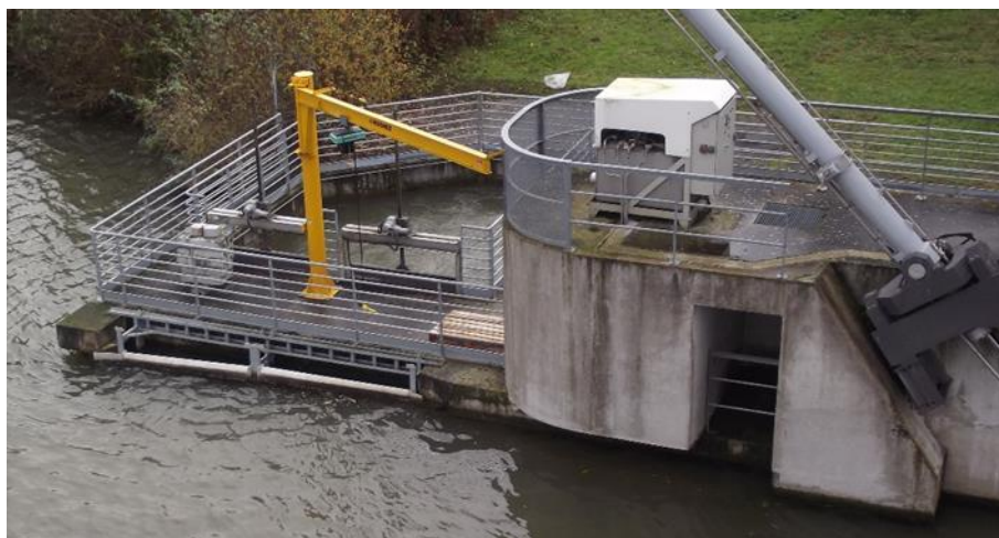
Figure 12 : Creil - Palan à l'entrée de la passe à poisson
