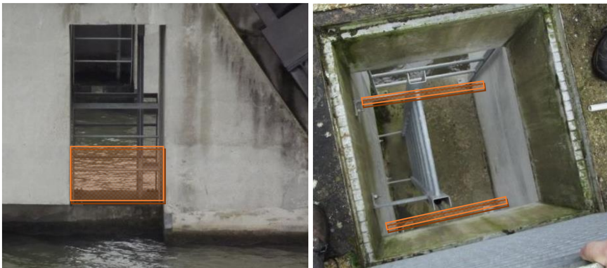
Figure 53 : Principe de batardage des galeries d'accès en amont des piles
