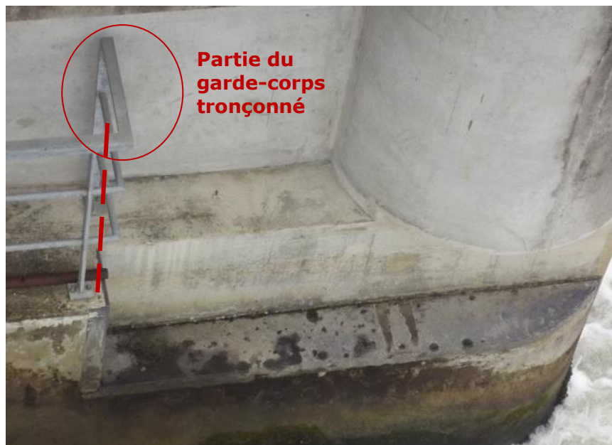
Figure 52 : Principe de modification du garde-corps aval
