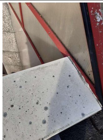
Prélèvement - P023 : CPAM Laon / Verrière - Joint- (Absence d'amiante)
