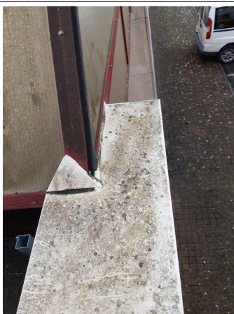
Prélèvement - P024 : CPAM Laon / Verrière - Joint- (Absence d'amiante)
