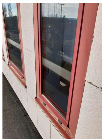
Prélèvement - P010 : CPAM Laon / Façade Sud-Est - Joint- (Absence d'amiante)
