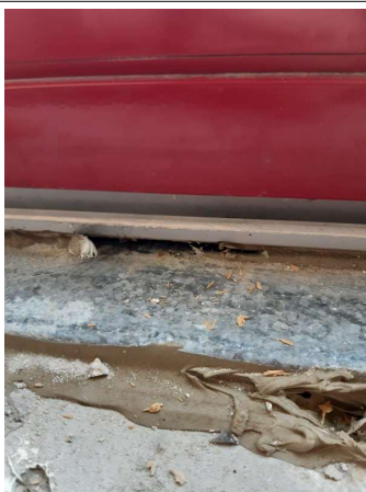
Prélèvement - P032 : CPAM Laon / Façade Sud-Est - Joint d'étanchéité entre menuiserie et structure- (Absence d'amiante)
