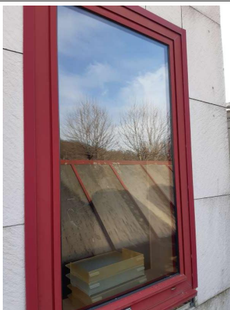
Prélèvement - P020 : CPAM Laon / Façade Nord - Joint- (Absence d'amiante)
