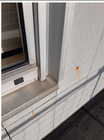
Prélèvement - P014 : CPAM Laon / Façade Sud - Joint- (Absence d'amiante)
