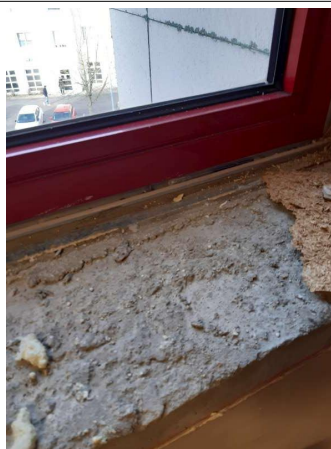
Prélèvement - P033 : CPAM Laon / Façade Nord - Joint d'étanchéité entre menuiserie et structure- (Absence d'amiante)
