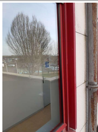
Prélèvement - P013 : CPAM Laon / Façade Nord-Ouest - Joint- (Absence d'amiante)
