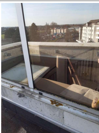
Prélèvement - P005 : CPAM Laon / Façade côté entrée - Joint- (Absence d'amiante)
