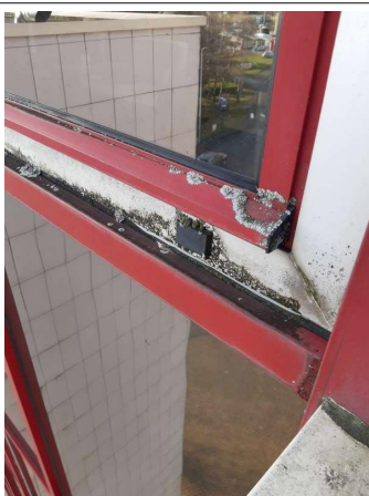
Prélèvement - P003 : CPAM Laon / Façade côté entrée - Joint- (Absence d'amiante)
