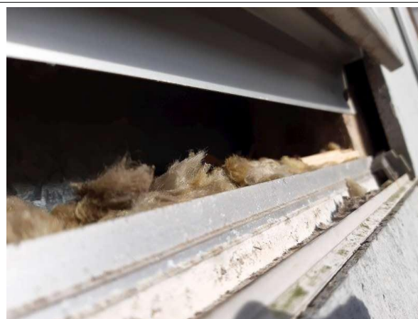
Prélèvement - P017 : CPAM Laon / Façade Nord-Ouest - Joint- (Absence d'amiante)
