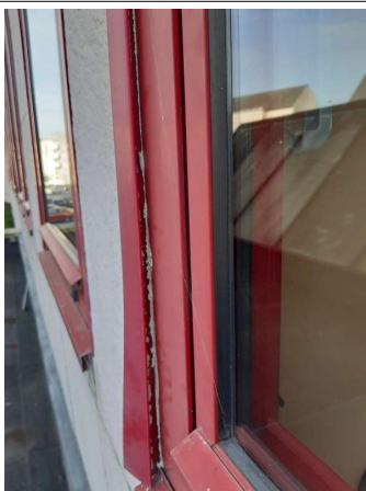
Prélèvement - P022 : CPAM Laon / Façade Nord - Joint d'assemblage- (Absence d'amiante)
