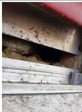
Prélèvement - P021 : CPAM Laon / Façade Nord - Joint- (Absence d'amiante)
