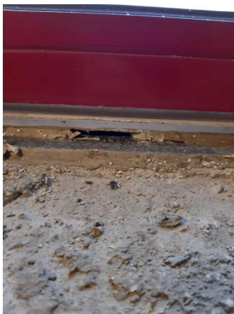
Prélèvement - P034 : CPAM Laon / Façade Nord - Joint d'étanchéité entre menuiserie et structure- (Absence d'amiante)
