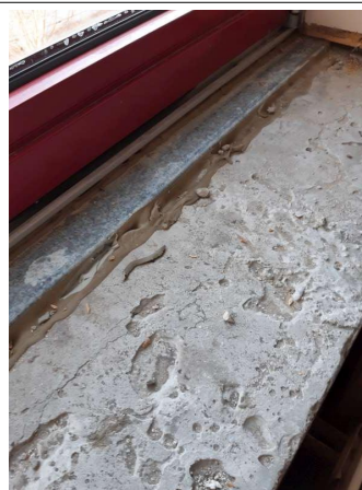
Prélèvement - P031 : CPAM Laon / Façade Sud-Est - Joint d'étanchéité entre menuiserie et structure- (Absence d'amiante)
