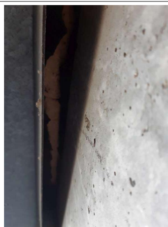
Prélèvement - P004 : CPAM Laon / Façade côté entrée - Pare- vapeur- (Absence d'amiante)
