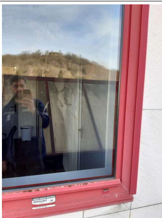
Prélèvement - P018 : CPAM Laon / Façade Nord - Joint- (Absence d'amiante)
