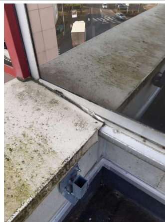
Prélèvement - P002 : CPAM Laon / Façade côté entrée - Joint- (Absence d'amiante)
