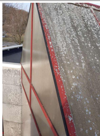
Prélèvement - P025 : CPAM Laon / Verrière - Joint- (Absence d'amiante)
