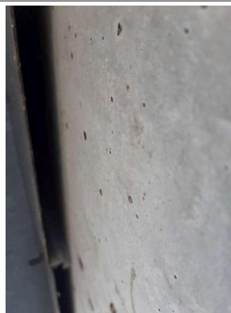
Prélèvement - P008 : CPAM Laon / Façade côté entrée - Pare- vapeur- (Absence d'amiante)
