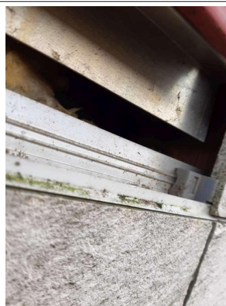
Prélèvement - P019 : CPAM Laon / Façade Nord - Joint- (Absence d'amiante)
