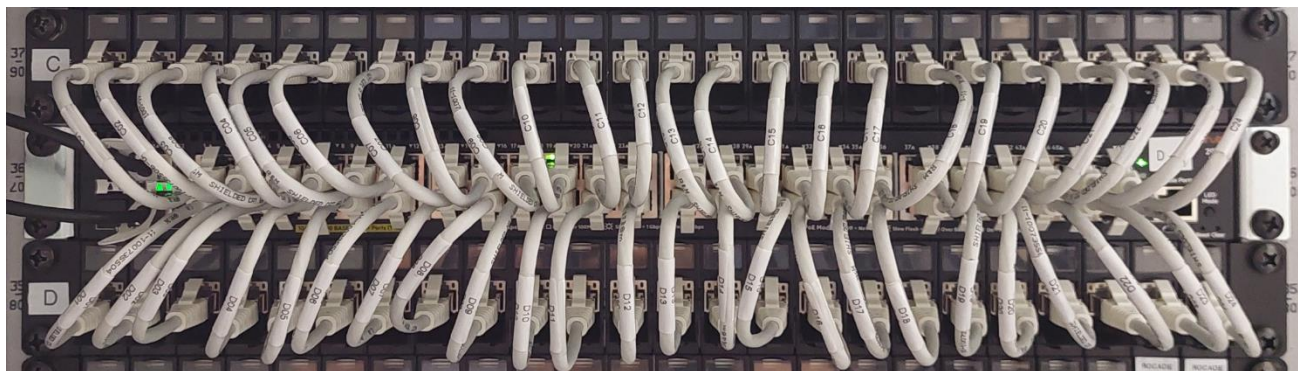
Figure 11 - Brassage de deux panneaux RJ45 sur un commutateur 48 ports positionné entre les 2 panneaux
