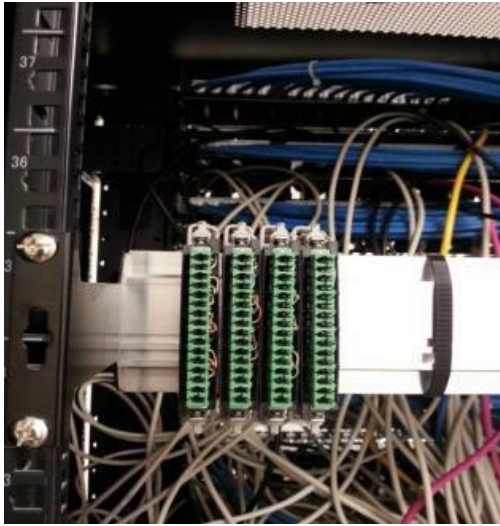
Figure 2 : Fixation d'une tête de ligne opérateur dans la baie principale
