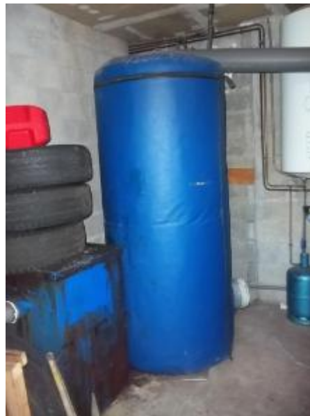
Ballon d'eau chaude électrique
