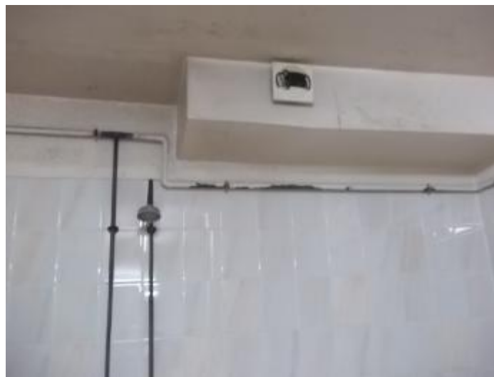
Ventilation simple flux des vestiaires
