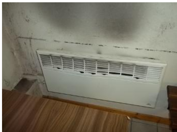
Convecteurs électriques détériorés
