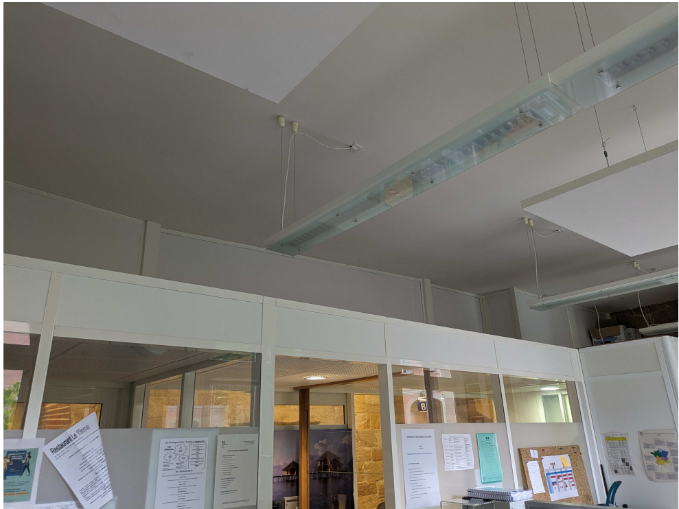
Les équipements techniques seront positionnés dans le plénum au-dessus des bureaux. un habillage bois à claire voie entre les cloisons modulaires et le faux-plafond sera réalisé afin de les dissimuler.
