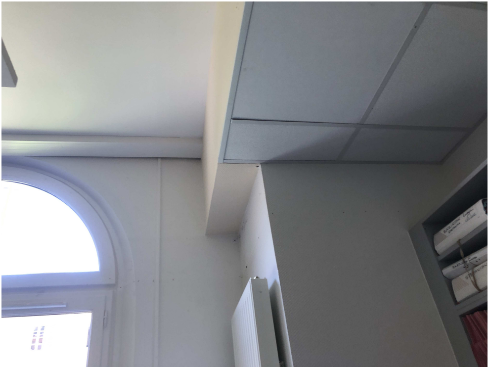
La sortie en façade sera prévue à droite de la fenêtre. Un caisson technique sera réalisé au droit de la retombée de faux-plafond existante pour le passage de la canalisation.
