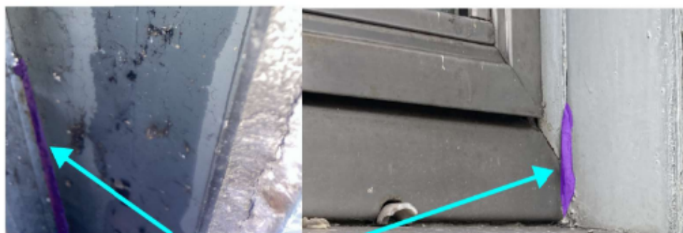
ZPSO-003 Joint d'étanchéité (bitumineux) P003; P061; P067 Présence d'amiante Après analyse en laboratoire
