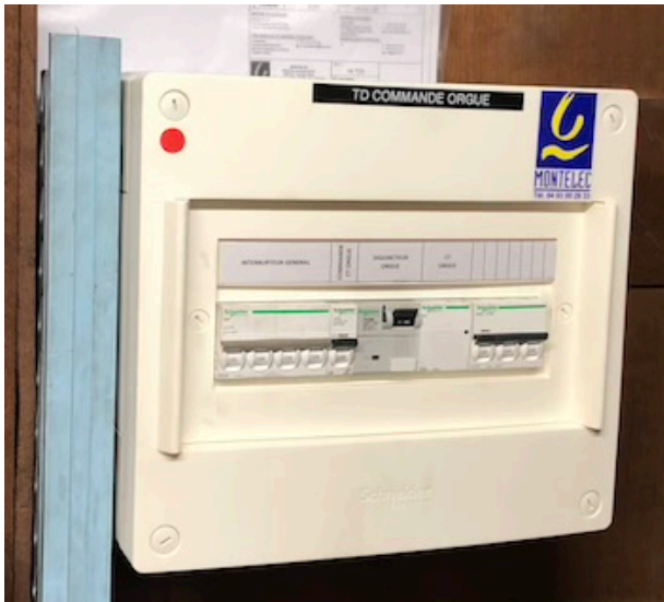
Photo 37 : Nouveau coffret de commande de démarrage des turbines
