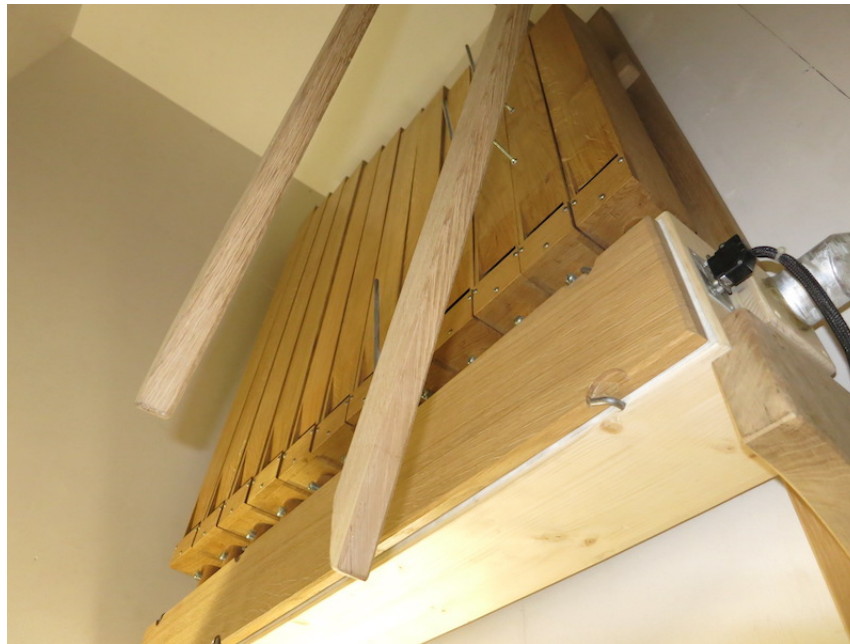
Photo 20 : Exemple de sommier (orgue, ND de Paris) les actionneurs sous coffret sont alimentés par câble unique avec connecteur.
