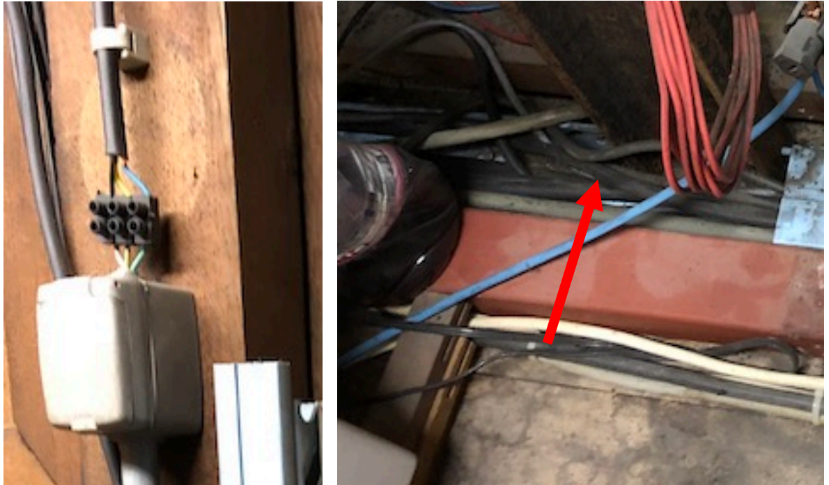
Photo 40 : Exemple de câbles obsolète et de connexions hors normes.
