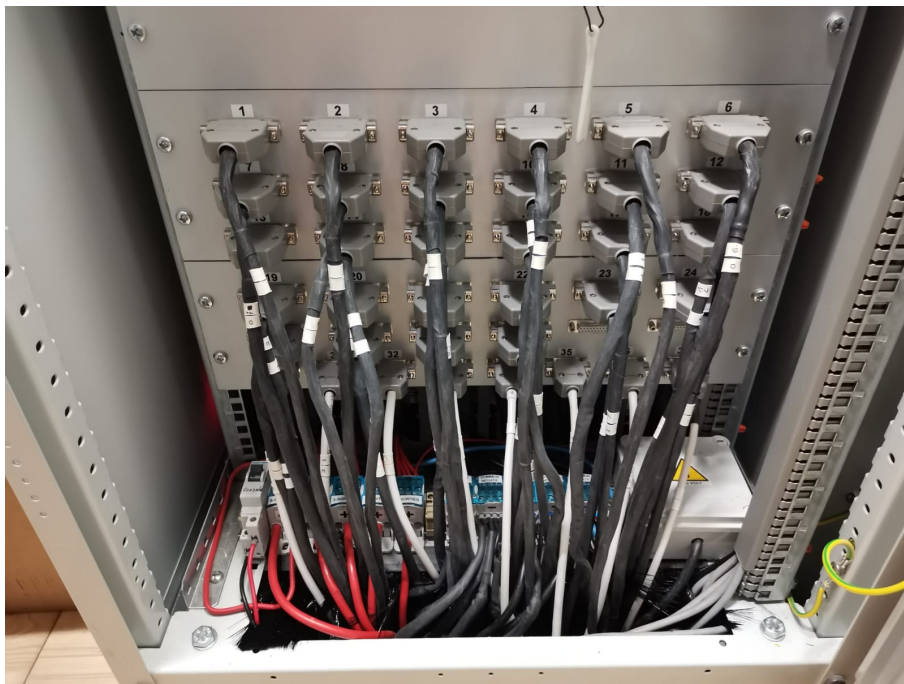
Photo 19 : exemple d'armoire de brassage des câbles de sortie aux actionneurs.
