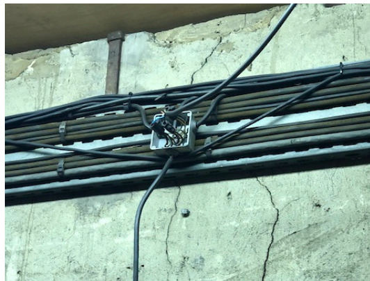
Photo 39 : Chemin de câbles et branchements divers au-dessus de la boîte expressive du plan sonore de Récit
