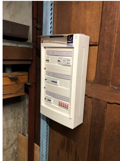
Photo 38 : tableau de commande des éclairages internes à l'orgue, état antérieur et après travaux de août 2022
