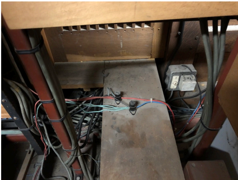
Photo 25 : Exemple de prolifération anarchique des câbles au revers de la console
