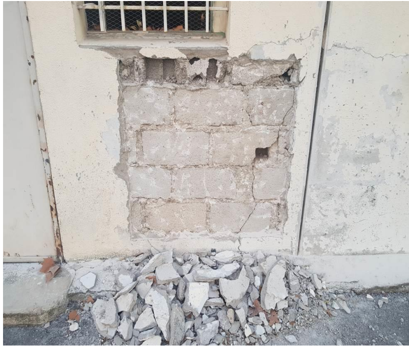
Murs de façades et de contreventements en moellons pleins - épaisseur 20cm
