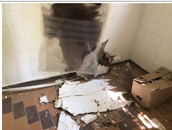
Prélèvement - P029 : BATIMENT ATELIER / GARAGE UPCA / Local annexe - Faux plafond- (Absence d'amiante)
