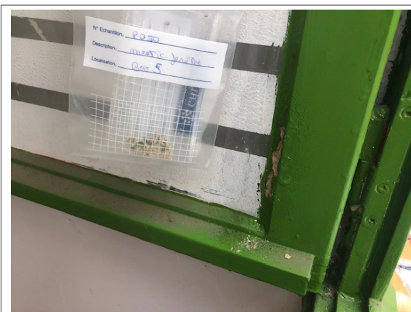
Prélèvement - P050 : BATIMENT ATELIER / Salle de sport / Vestiaires - Mastic- (Présence d'amiante)
