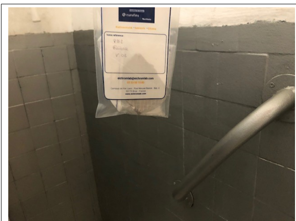
Prélèvement - P162 : BATIMENT ATELIER / Atelier bois 1 / Vestiaire 02 - Colle de faïence- (Absence d'amiante)
