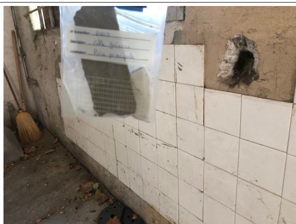
Prélèvement - P005 : BATIMENT ATELIER / GARAGE UPCA - Colle de faïence- (Absence d'amiante)
