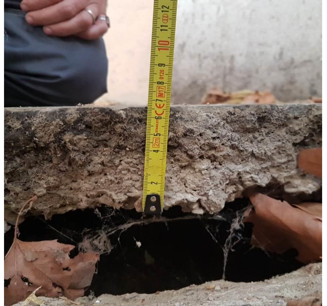
Epaisseur du dallage inférieure à 10 cm
