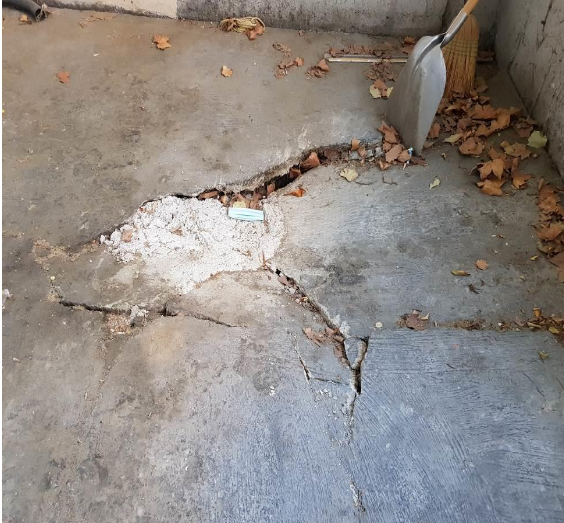
Côté Sud : dallage affaissé de plusieurs centimètres
