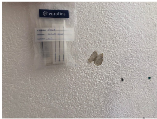
Prélèvement - P037 : BATIMENT ATELIER / GARAGE UPCA / WC - Enduit- (Absence d'amiante)
