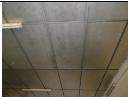
Photo n° A004 Localisation : Ensemble du bâtiment Ouvrage : Flocages, Calorifugeages, Faux plafonds Partie d'ouvrage : Faux plafonds Description : Panneaux de faux-plafond
