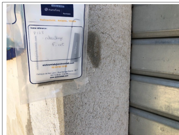
Prélèvement - P128 : BATIMENT ATELIER / Extérieur - Enduit- (Absence d'amiante)
