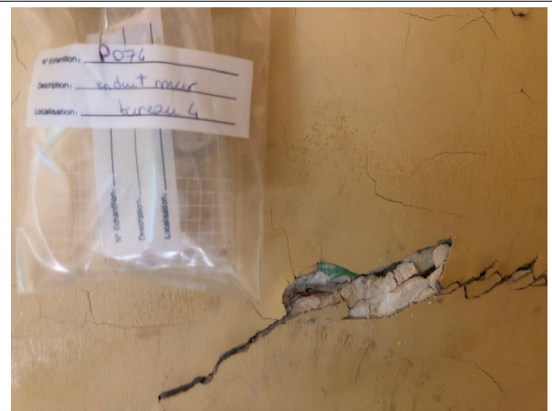
Prélèvement - P074 : BATIMENT ATELIER / Association / Bureau 4 - Enduit- (Absence d'amiante)
