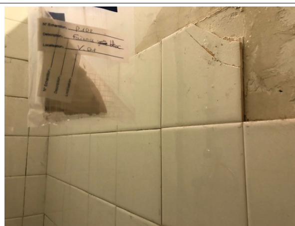
Prélèvement - P102 : BATIMENT ATELIER / Atelier bois 2 / Vestiaire 01 - Colle de faïence- (Absence d'amiante)
