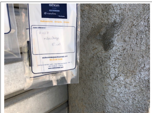
Prélèvement - P127 : BATIMENT ATELIER / Extérieur - Enduit- (Absence d'amiante)
