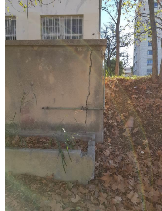
Fissure sur pignon et soutènement Sud
