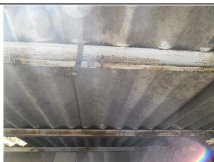
Photo n° A001 Localisation : Chaufferie - Local groupe - Abri ventilation - Abri cuve - Abri Ouvrage : Toitures Partie d'ouvrage : Plaques (fibres-ciment) Description : Couverture : Plaques ondulées en fibres-ciment
