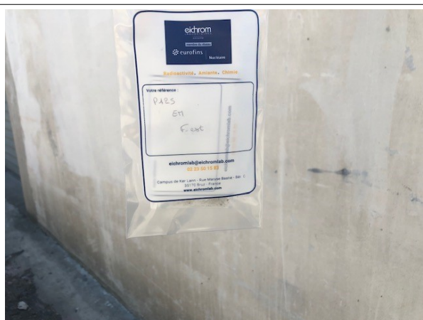
Prélèvement - P125 : BATIMENT ATELIER / Extérieur - Enduit- (Absence d'amiante)
