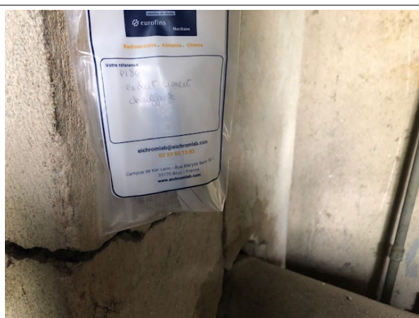
Prélèvement - P184 : BATIMENT ATELIER / Chaufferie - Enduit- (Absence d'amiante)
