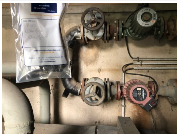
Prélèvement - P190 : BATIMENT ATELIER / Chauffage - Calorifugeage- (Absence d'amiante)
