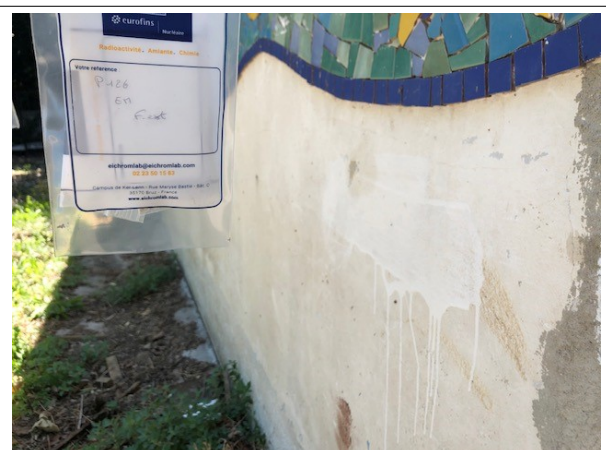
Prélèvement - P126 : BATIMENT ATELIER / Extérieur - Enduit- (Absence d'amiante)
