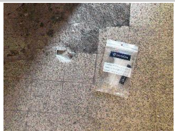
Prélèvement - P040 : BATIMENT ATELIER / Salle de sport - Colle de carrelage- (Absence d'amiante)
