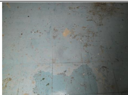
Photo n° A003 Localisation : Atelier menuiserie Ouvrage : Planchers Partie d'ouvrage : Dalles de sol Description : Dalles de sol bleues + colle + ragréage
