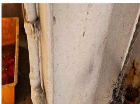
Matériaux : 05P Description : Peinture (bleue) Localisation : Poteau métallique intérieur Résultat : Concentration massique en plomb acido-soluble >1.5mg/g
