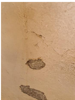
Matériaux : 09P Description : Peinture (blanche) Localisation : Local 051 – mur intérieur Résultat : Concentration massique en plomb acido-soluble <1.5mg/g
