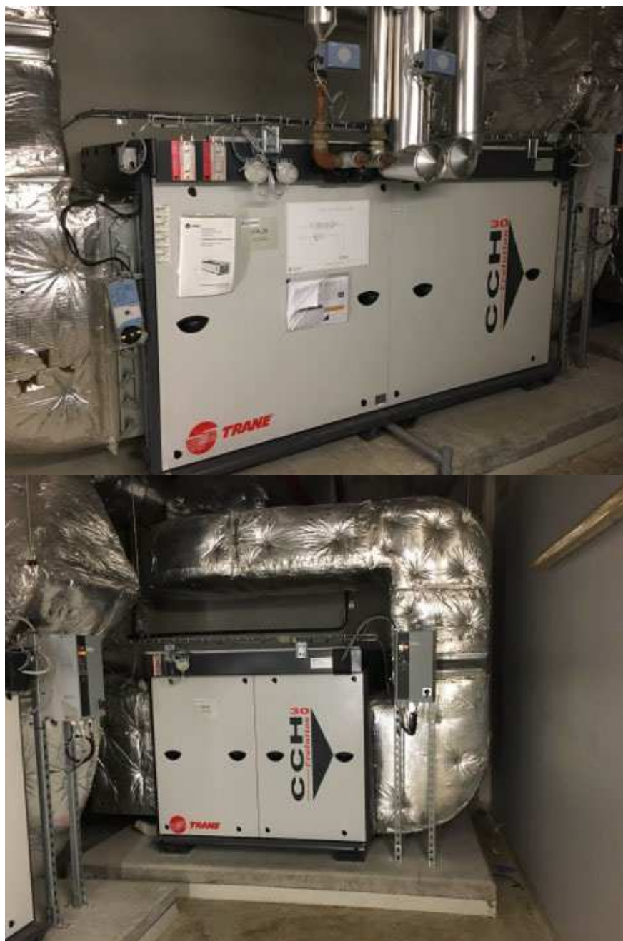
Figure 10 : Centrale de traitement d'air et extracteur 29 existants
