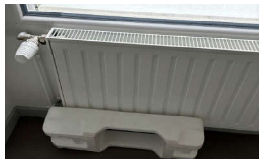
Ensemble des radiateurs à eau : - ensemble en bon état, attention au stockage d'élément.
