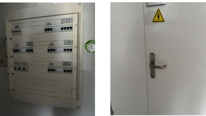
TGBT Bâtiment Principal : - Propre, prévoir une fermeture à clé du local
