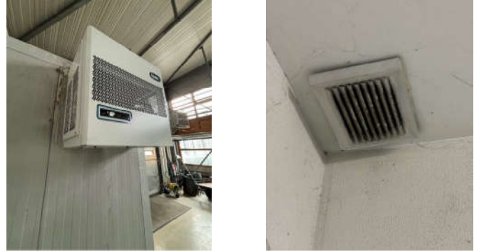
Chambre froide N°2 : Remplacement du compresseur effectué récemment, bouche de l'extracteur très sale
