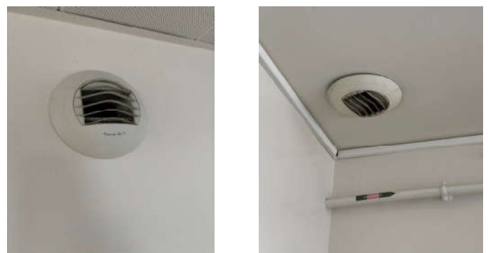
Ensemble des bouches d'extraction : Prévoir le nettoyage, bouches très sales
