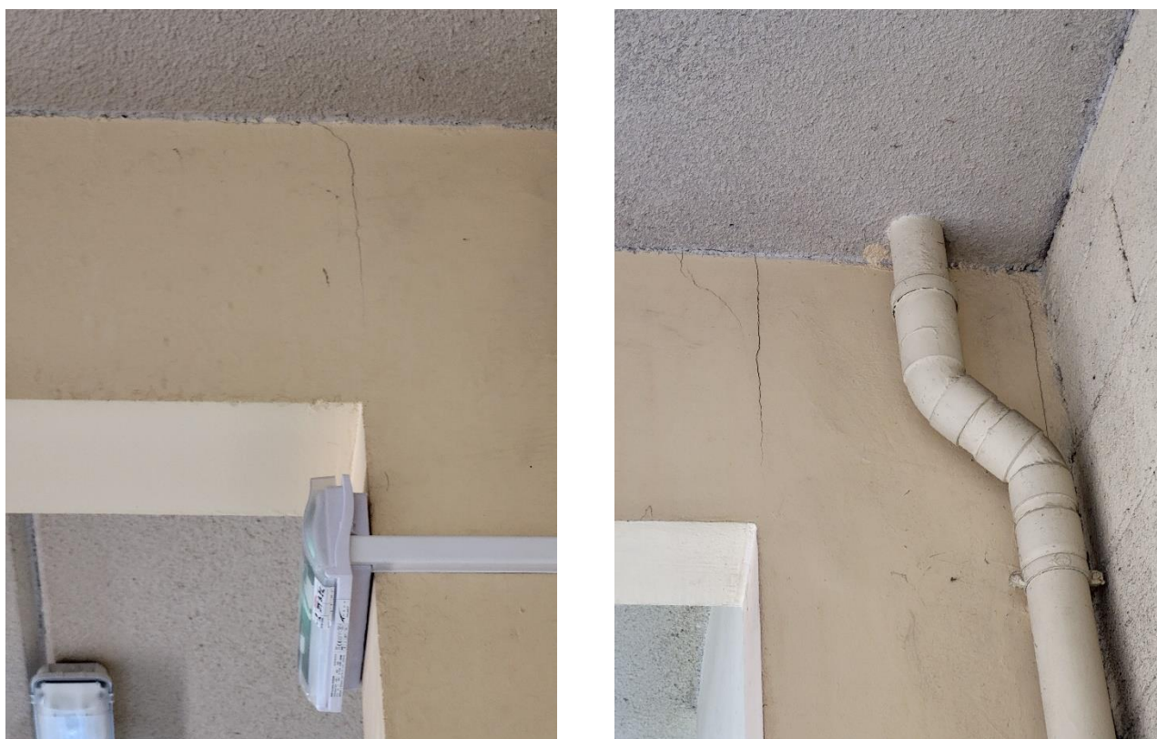
Photos des fissures de flexion au droit des poteaux
