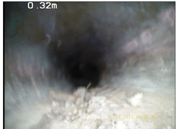
Photo: 7_2A, N° de bande vidéo: 0966 0.4m, Dépôts de matériau fin (sable, vase) sur le radier à 6 h. épaisseur des dépôts: 5 % / Terre etc...
