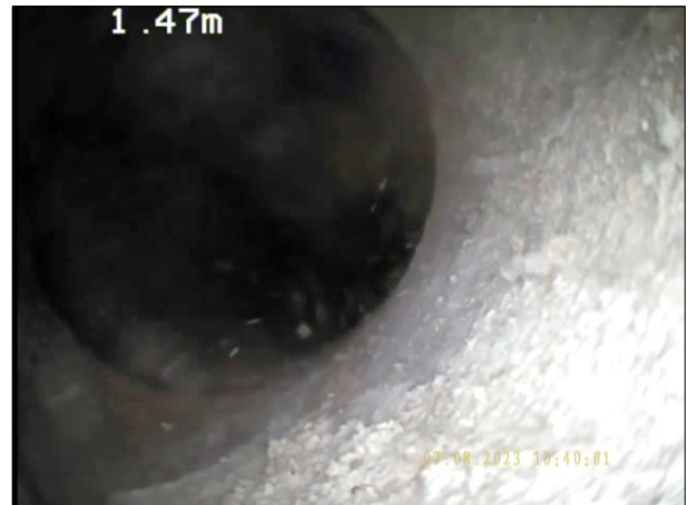
Photo: 29_4B, N° de bande vidéo: 0982 1.3m, Courbure du collecteur vers le bas, angle total de déviation: 90 ° / Colonne
