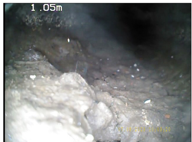
Photo: 27_2B, N° de bande vidéo: 0975 0.8m, Dépôts adhérents, encrassement de 5 à 7 h. réduction de la section transversale: 15 %
