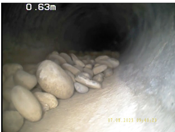
Photo: 1_3A, N° de bande vidéo: 0970 0.75m, Dépôts de matériau grossier (gravats, gravier) sur le radier de 5 à 7 h. épaisseur des dépôts: 10 %
