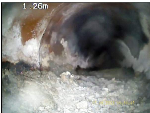
Photo: 17_2A, N° de bande vidéo: 0972 1.3m, Dépôts de matériau sur le radier, autre : Matéria atelier de 5 à 7 h. épaisseur des dépôts: 10 %
