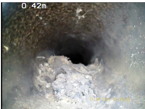
Photo: 18_2A, N° de bande vidéo: 0959 0.6m, Dépôts de matériau sur le radier, autre : Matériau atelier de 3 à 9 h. épaisseur des dépôts: 50 %
