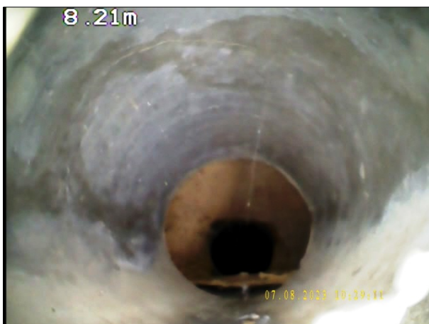
Photo: 4_2A, N° de bande vidéo: 0980 8.3m, Fissure fermée, complexe de 9 à 4 h. largeur de la fissure: 1 mm
