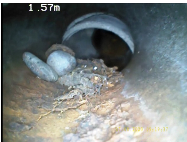
Photo: 26_2A, N° de bande vidéo: 0962 1.7m, Dépôts de matériau grossier (gravats, gravier) sur le radier de 6 à 8 h. épaisseur des dépôts: 15 %
