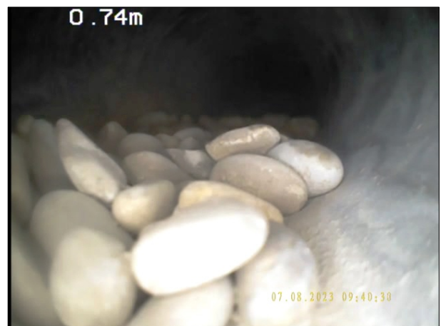
Photo: 1_3B, N° de bande vidéo: 0970 0.75m, Dépôts de matériau grossier (gravats, gravier) sur le radier de 5 à 7 h. épaisseur des dépôts: 10 %
