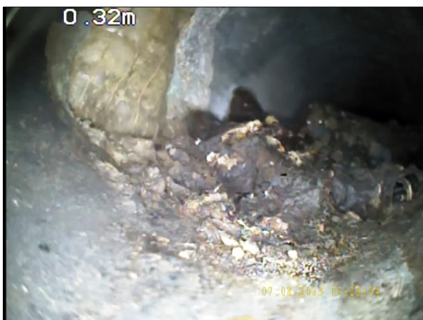
Photo: 24_2A, N° de bande vidéo: 0964 0.45m, Dépôts adhérents, encrassement de 5 à 8 h. réduction de la section transversale: 10 %
