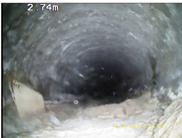
Photo: 8_2A, N° de bande vidéo: 0978 3m, Dépôts de matériau fin (sable, vase) sur le radier de 5 à 7 h. épaisseur des dépôts: 10 %
