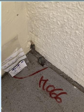
Photo n° PhA066 Localisation : MLU - MLU020 - NIVEAU : 02 - LOCAL : T304 - LABORATOIRE; Ouvrage : 5 - Planchers et planchers techniques - Revêtements de sols Partie d'ouvrage : Colle de carrelage Description : CARRELAGE SOL + COLLE
