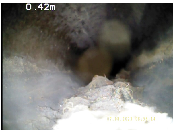
Photo: 14_2A, N° de bande vidéo: 0956 0.5m, Entrée de terre, tourbe à 6 h. réduction de la section transversale: 5 %
