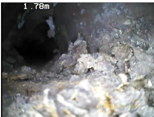
Photo: 25_2A, N° de bande vidéo: 0963 1.8m, Dépôts de matériau sur le radier, autre : Matériau atelier de 5 à 7 h. épaisseur des dépôts: 10 %
