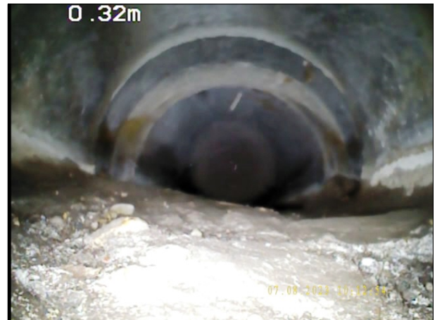
Photo: 10_2A, N° de bande vidéo: 0980 0.35m, Dépôts de matériau fin (sable, vase) sur le radier de 5 à 7 h. épaisseur des dépôts: 20 % / Terre, graviers etc...
