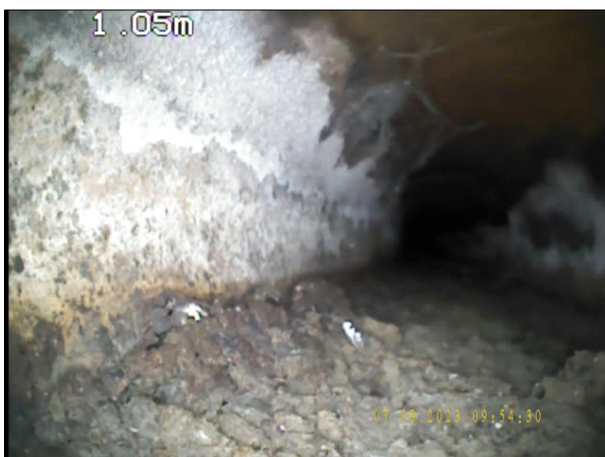
Photo: 21_2B, N° de bande vidéo: 0973 0.84m, Dépôts de matériau sur le radier, autre : Matériau atelier à 6 h. épaisseur des dépôts: 10 %
