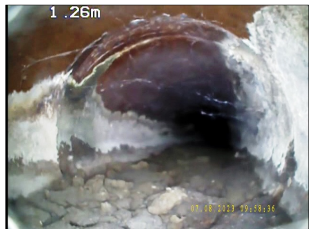
Photo: 23_2B, N° de bande vidéo: 0974 1.15m, Dépôts de matériau sur le radier, autre : Matériau atelier de 5 à 7 h. épaisseur des dépôts: 10 %
