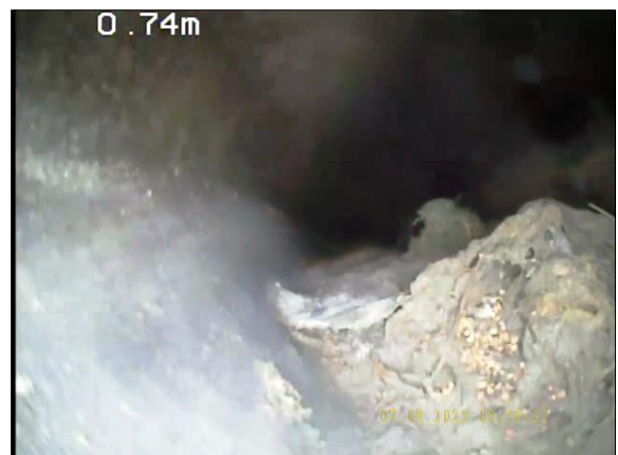
Photo: 14_3A, N° de bande vidéo: 0956 0.85m, Dépôts de matériau sur le radier, autre : Matériau atelier de 5 à 7 h. épaisseur des dépôts: 20 %
