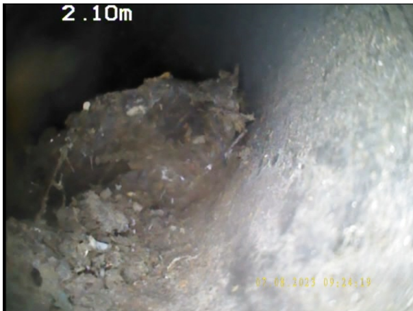
Photo: 24_4A, N° de bande vidéo: 0964 2.2m, Inspection abandonnée, obstruction. Inspection terminée avant d'avoir atteint le noeud d'arrivée
