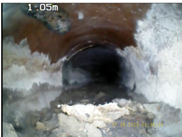
Photo: 23_2A, N° de bande vidéo: 0974 1.15m, Dépôts de matériau sur le radier, autre : Matériau atelier de 5 à 7 h. épaisseur des dépôts: 10 %
