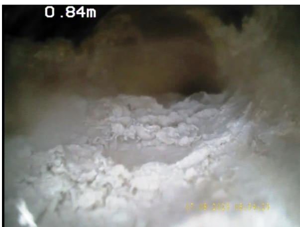
Photo: 15_2A, N° de bande vidéo: 0955 1m, Dépôts de matériau sur le radier, autre : Matériau atelier de 5 à 7 h. épaisseur des dépôts: 10 %
