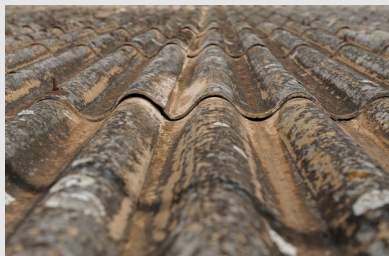
Toiture amiantée en fibrociment
