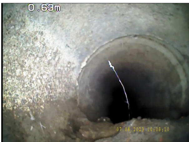
Photo: 27_2A, N° de bande vidéo: 0975 0.8m, Dépôts adhérents, encrassement de 5 à 7 h. réduction de la section transversale: 15 %
