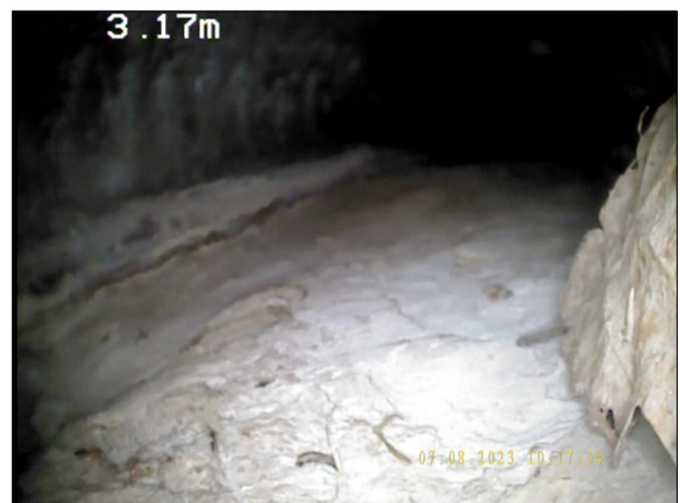
Photo: 8_2B, N° de bande vidéo: 0978 3m, Dépôts de matériau fin (sable, vase) sur le radier de 5 à 7 h. épaisseur des dépôts: 10 %
