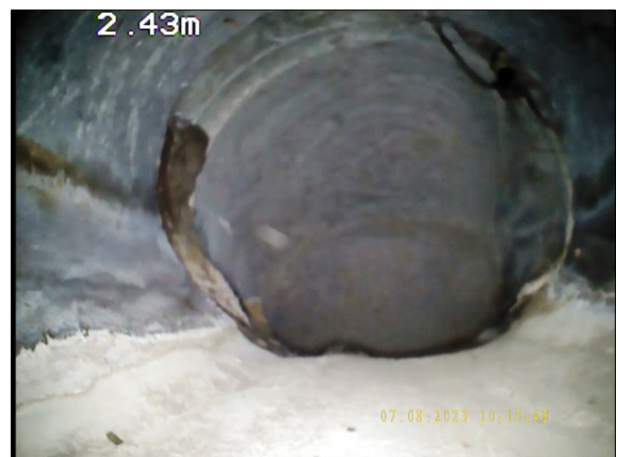
Photo: 10_3A, N° de bande vidéo: 0980 2.65m, Courbure du collecteur vers le bas, angle total de déviation: 90 °
