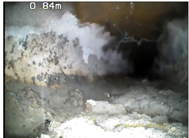
Photo: 21_2A, N° de bande vidéo: 0973 0.84m, Dépôts de matériau sur le radier, autre : Matériau atelier à 6 h. épaisseur des dépôts: 10 %
