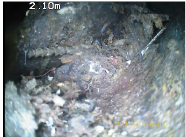
Photo: 24_4B, N° de bande vidéo: 0964 2.2m, Inspection abandonnée, obstruction. Inspection terminée avant d'avoir atteint le noeud d'arrivée
