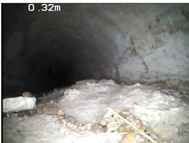
Photo: 6_2B, N° de bande vidéo: 0979 0.3m, Dépôts de matériau fin (sable, vase) sur le radier de 4 à 8 h. épaisseur des dépôts: 20 % / Début
