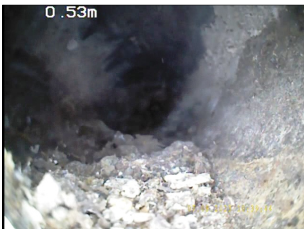
Photo: 29_2B, N° de bande vidéo: 0982 0.4m, Dépôts adhérents, encrassement de 5 à 7 h. réduction de la section transversale: 15 %
