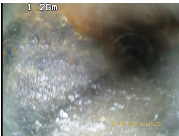
Photo: 13_2A, N° de bande vidéo: 0971 1.26m, Dépôts adhérents, encrassement de 3 à 9 h. réduction de la section transversale: 10 %
