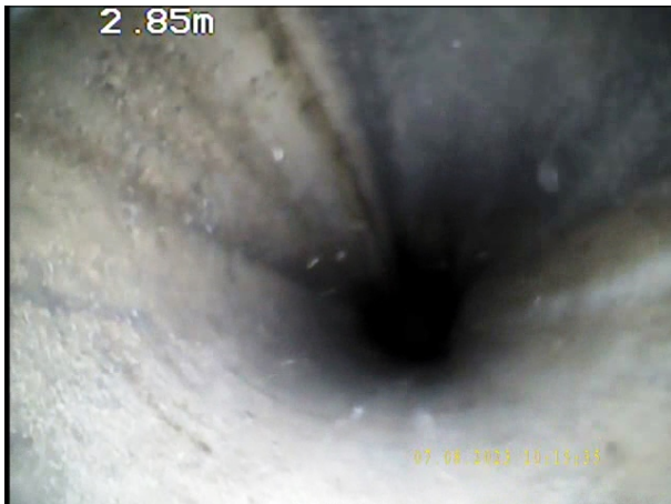
Photo: 10_3B, N° de bande vidéo: 0980 2.65m, Courbure du collecteur vers le bas, angle total de déviation: 90 °
