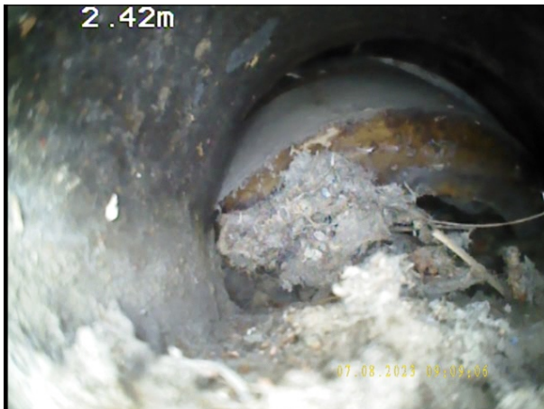
Photo: 18_3A, N° de bande vidéo: 0959 2.6m, Noeud d'arrivée, Siphon de sol, BR6 / Obstrué
