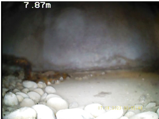
Photo: 2_3B, N° de bande vidéo: 0.981 7.9m, Noeud d'arrivée, Boîte d'inspection, REP1 / Dépôt de cailloux
