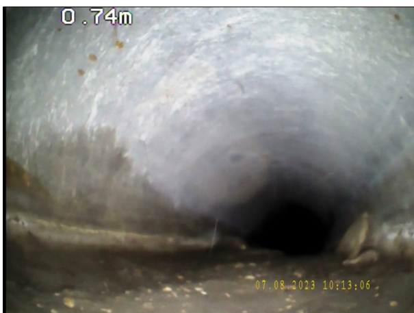
Photo: 10_2B, N° de bande vidéo: 0980 0.35m, Dépôts de matériau fin (sable, vase) sur le radier de 5 à 7 h. épaisseur des dépôts: 20 % / Terre, graviers etc...
