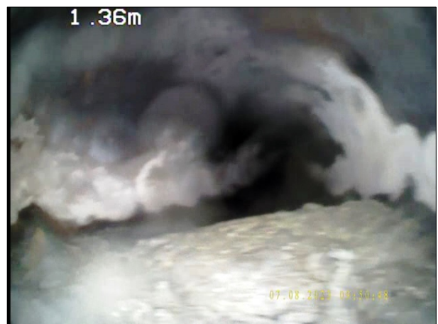
Photo: 17_2B, N° de bande vidéo: 0972 1.3m, Dépôts de matériau sur le radier, autre : Matéria atelier de 5 à 7 h. épaisseur des dépôts: 10 %
