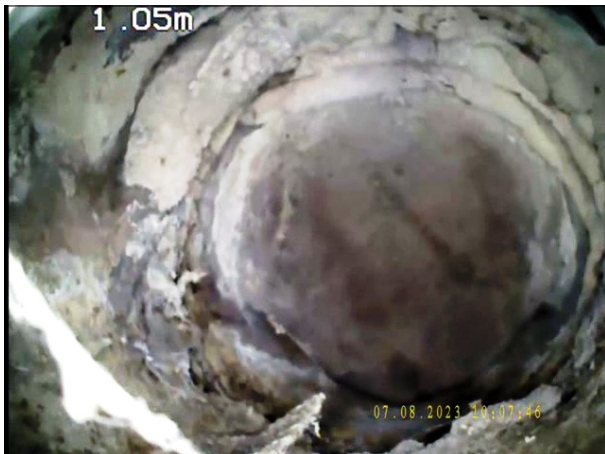
Photo: 29_4A, N° de bande vidéo: 0982 1.3m, Courbure du collecteur vers le bas, angle total de déviation: 90 ° / Colonne
