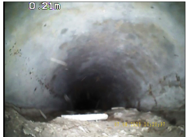
Photo: 6_2A, N° de bande vidéo: 0979 0.3m, Dépôts de matériau fin (sable, vase) sur le radier de 4 à 8 h. épaisseur des dépôts: 20 % / Début
