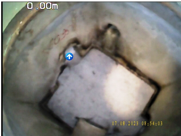
Photo: 15_1A, N° de bande vidéo: 0955 0m, Noeud de départ, Boîte d'inspection REU2
