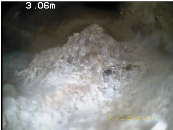
Photo: 15_3B, N° de bande vidéo: 0955 3.25m, Dépôts de matériau sur le radier, autre : Matériau atelier de 3 à 8 h. épaisseur des dépôts: 30 %
