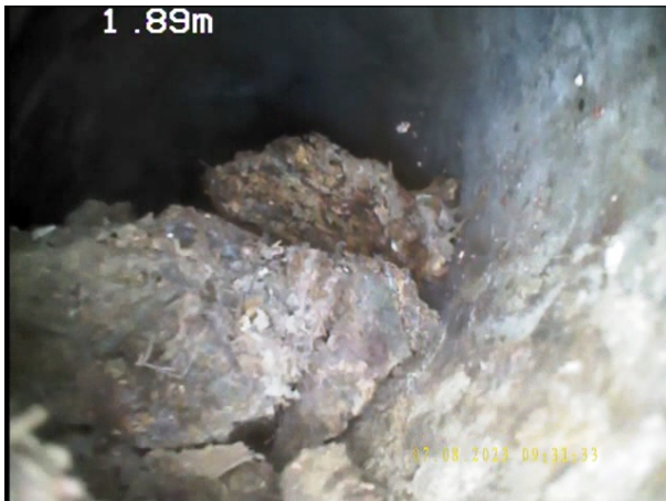
Photo: 7_3B, N° de bande vidéo: 0966 1.9m, Dépôts de matériau grossier (gravats, gravier) sur le radier de 3 à 9 h. épaisseur des dépôts: 40 %
