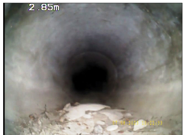
Photo: 6_3A, N° de bande vidéo: 0979 3.15m, Dépôts de matériau fin (sable, vase) sur le radier à 6 h. épaisseur des dépôts: 2 % / Fin
