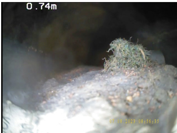
Photo: 14_3B, N° de bande vidéo: 0956 0.85m, Dépôts de matériau sur le radier, autre : Matériau atelier de 5 à 7 h. épaisseur des dépôts: 20 %
