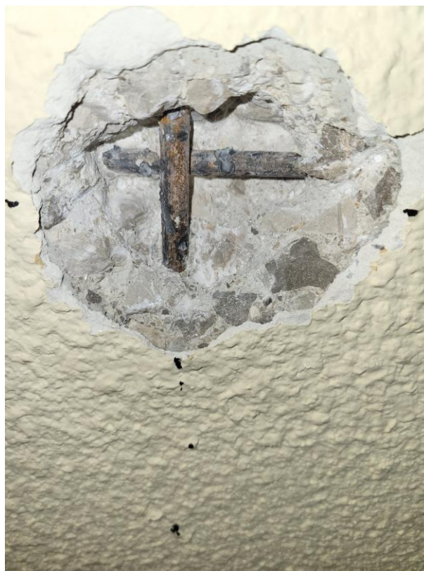
Photos de sondage sur dalle S4
