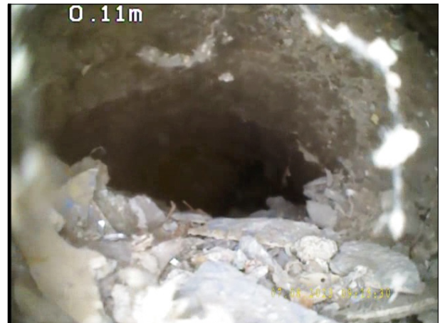
Photo: 22_2A, N° de bande vidéo: 0961 0.25m, Dépôts de matériau sur le radier, autre : Matériau atelier de 3 à 9 h. épaisseur des dépôts: 50 %
