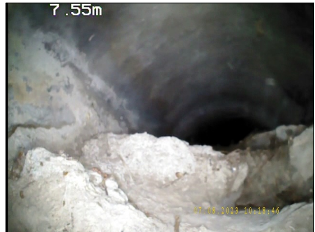
Photo: 8_4A, N° de bande vidéo: 0978 7.7m, Dépôts de matériau dur ou compacté sur le radier de 3 à 9 h. épaisseur des dépôts: 50 %
