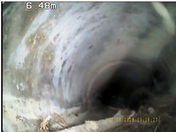
Photo: 8_3A, N° de bande vidéo: 0978 6.6m, Dépôts de matériau sur le radier, autre : Branches + feuilles de 5 à 7 h. épaisseur des dépôts: 10 %
