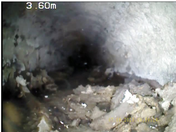
Photo: 23_3A, N° de bande vidéo: 0974 3.6m, Dépôts de matériau sur le radier, autre : Matériau atelier de 5 à 7 h. épaisseur des dépôts: 15 %
