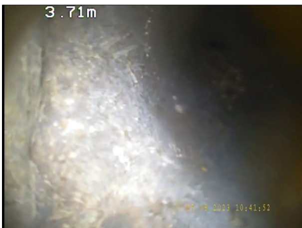
Photo: 29_5A, N° de bande vidéo: 0982 4m, Inspection abandonnée, obstruction. Inspection terminée avant d'avoir atteint le noeud d'arrivée / Pied de colonne
