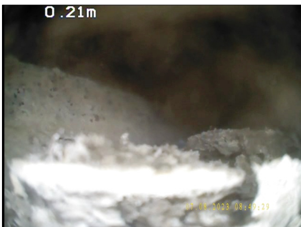
Photo: 12_2A, N° de bande vidéo: 0953 0.2m, Dépôts de matériau sur le radier, autre : Matériau atelier de 5 à 7 h. épaisseur des dépôts: 10 %
