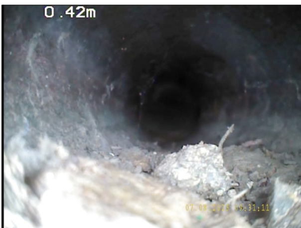
Photo: 7_2B, N° de bande vidéo: 0966 0.4m, Dépôts de matériau fin (sable, vase) sur le radier à 6 h. épaisseur des dépôts: 5 % / Terre etc...
