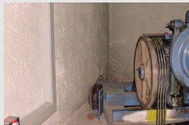
Machinerie d'ascenseur susceptible de contenir des matériaux amiantés (flocage, freins...)
