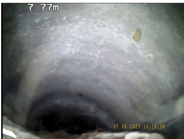
Photo: 8_5A, N° de bande vidéo: 0978 7.75m, Inspection abandonnée, obstruction. Inspection terminée avant d'avoir atteint le noeud d'arrivée
