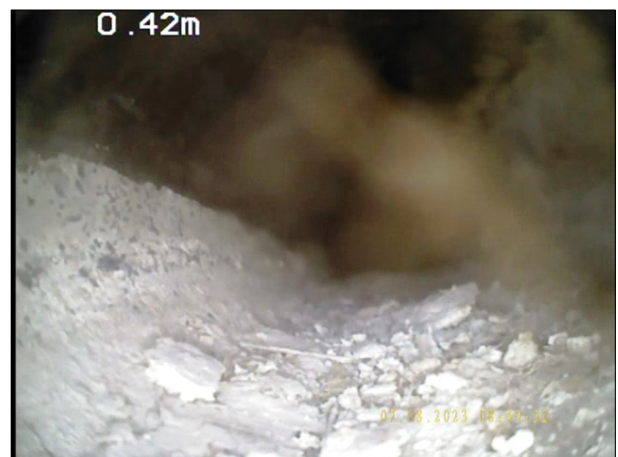
Photo: 12_2B, N° de bande vidéo: 0953 0.2m, Dépôts de matériau sur le radier, autre : Matériau atelier de 5 à 7 h. épaisseur des dépôts: 10 %
