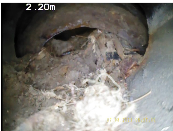
Photo: 14_5A, N° de bande vidéo: 0956 2.3m, Noeud d'arrivée, Siphon de sol, BR3 / Obstrué
