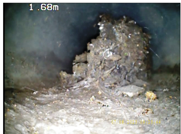
Photo: 24_3A, N° de bande vidéo: 0964 1.85m, Dépôts adhérents, encrassement de 12 à 9 h. réduction de la section transversale: 70 %
