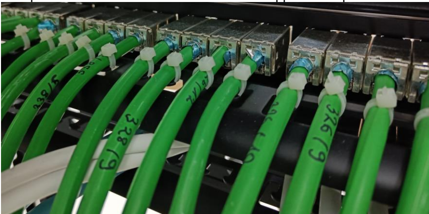
Panneau de brassage Panduit CP24WSBLY avec collier de maintien
