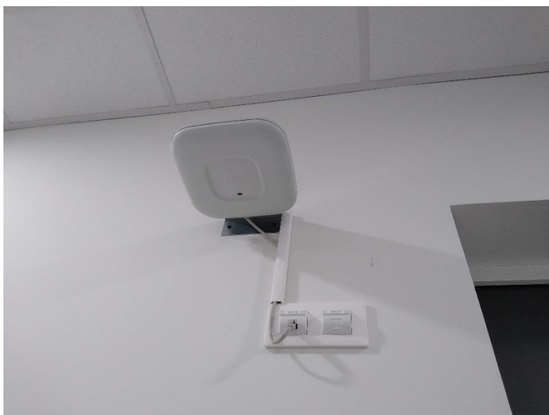
Fixation horizontale sur équerre
