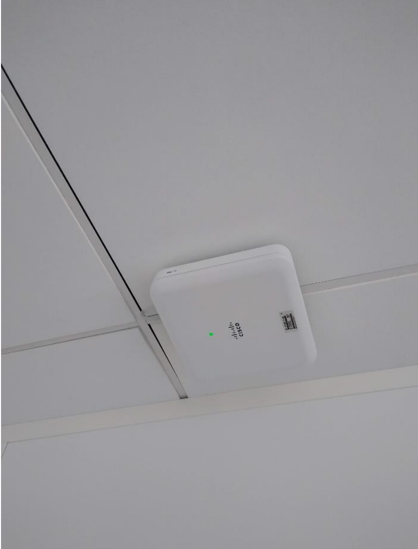
Fixation sur rail de faux-plafond
