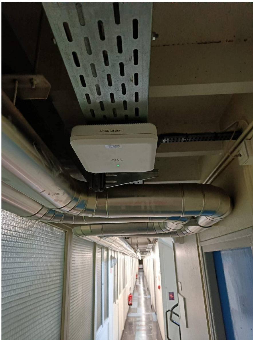
Fixation sur chemin de câbles
