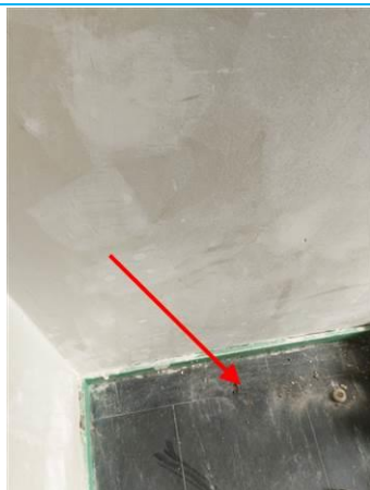
Matériaux : ZPSO-001 Prélèvement : P001 Description : Dalle de sol Localisation : INTERNAT / RDC - LOCAL MENAGE Résultat : Présence d'amiante
