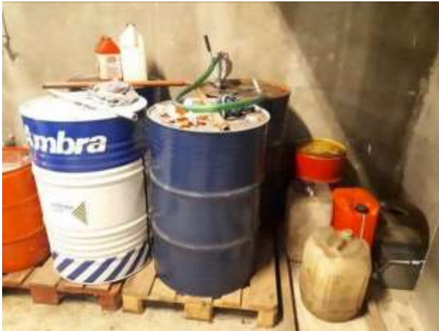
Vue d'un stockage de fûts et bidons d'huiles sans rétention
