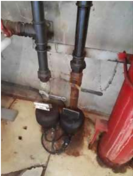
Vue de l'ancienne vanne d'arrivée de FOD au sud du bâtiment A
