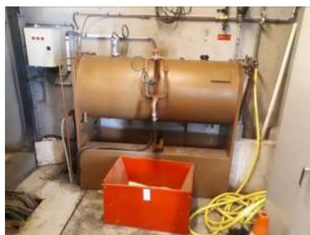
Vue de la seconde nourrice du groupe électrogène (cuve de 500 L de fioul domestique)
