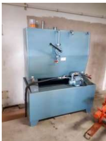
Vue d'une nourrice du groupe électrogène (cuve de 500 L de fioul domestique ou FOD)
