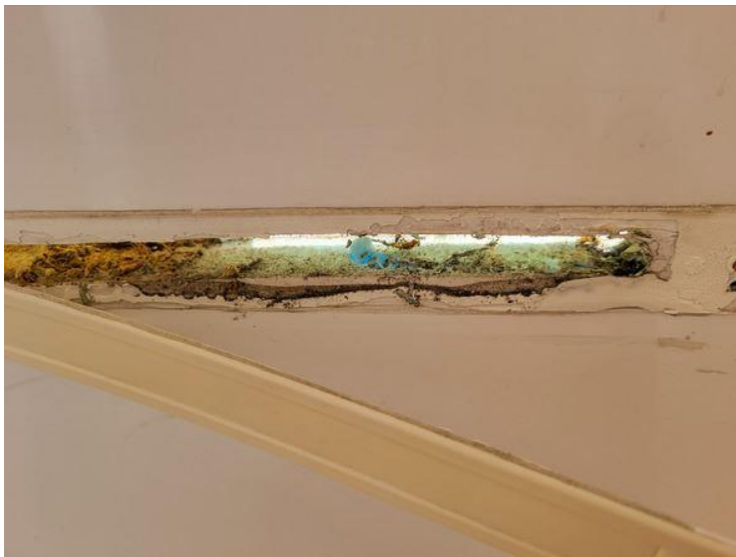
Sanitaires: Sondage dans les allèges PVC
