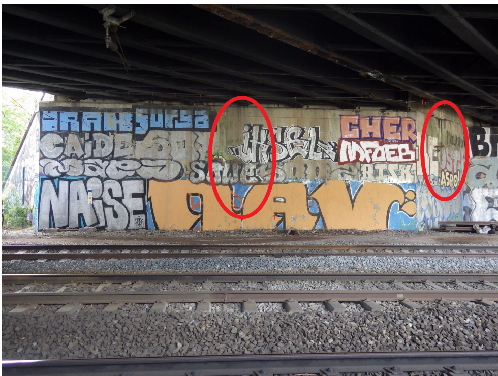
Photo 4 : Traces nouvelles d'écoulement Culée Ouest – C0 – Tablier B (sens Lyon Grenoble)
