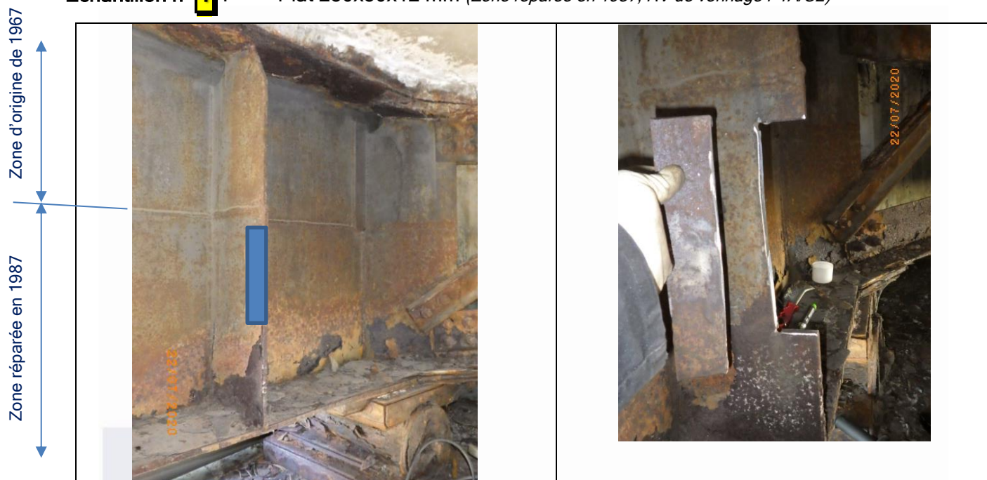
Echantillon n° 1 : Plat 250x50x12 mm (Zone réparée en 1987, RV de vérinage P1A/C2)
