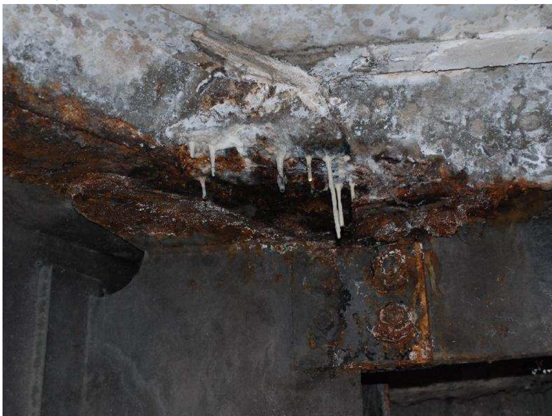
Photo 18 : Dégradation au droit de la liaison de la poutre P2A et l'entretoise en partie haute.
