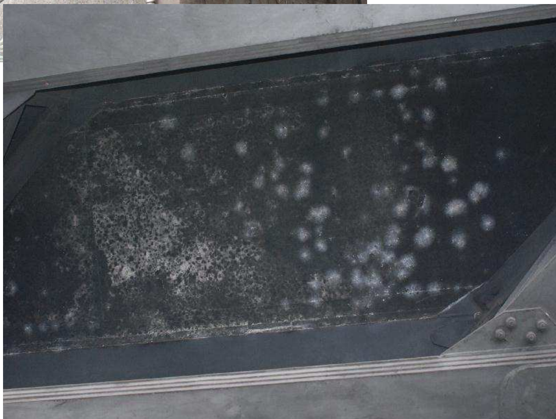
Photo 26 : « Pommelage » du à l'humidité en intrados de la dalle.
