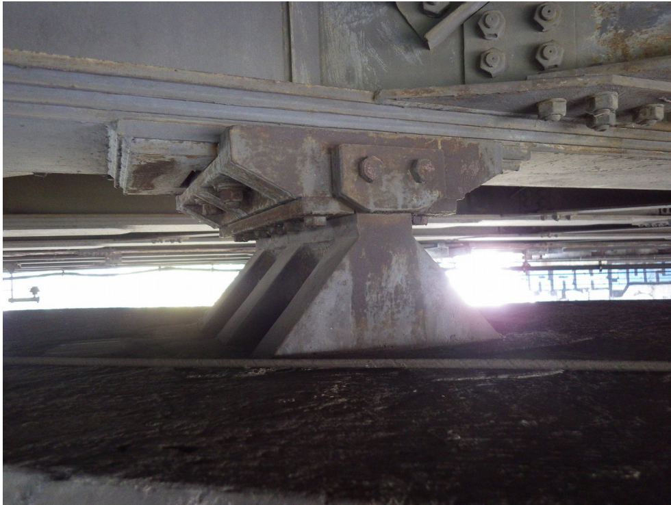
Photo 39 : Appareil d'appui P4A-P11A Pile P1 – Tablier A (sens Grenoble Lyon)
