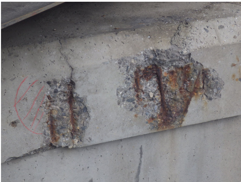
Photo 2 : Nouvelles zones sonnant le creux et éclats avec aciers apparents oxydés (après purge) Culée Est – C0– Tablier B (sens Lyon Grenoble) – côté Sud
