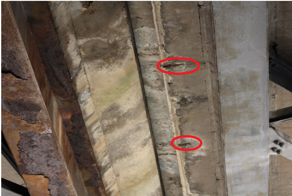
Photo 53 : Eclats de béton avec aciers apparents oxydés sous l'encorbellement au droit du TPC Tablier B (sens Lyon Grenoble)
