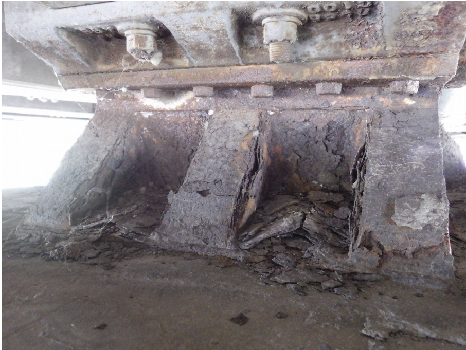
Photo 41 : Appareil d'appui P1B-P8B Pile P1 – Tablier B (sens Lyon Grenoble)
