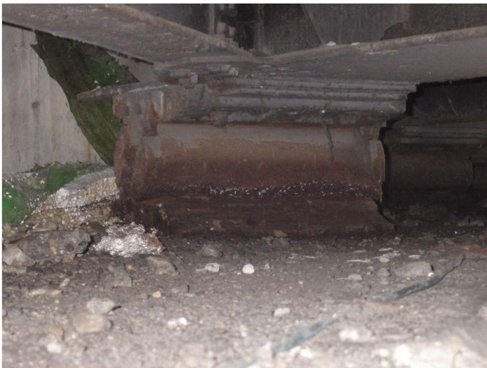
Photo 18 : Appareil d'appui P12A Culée Ouest – C0 – Tablier A (sens Grenoble Lyon)
