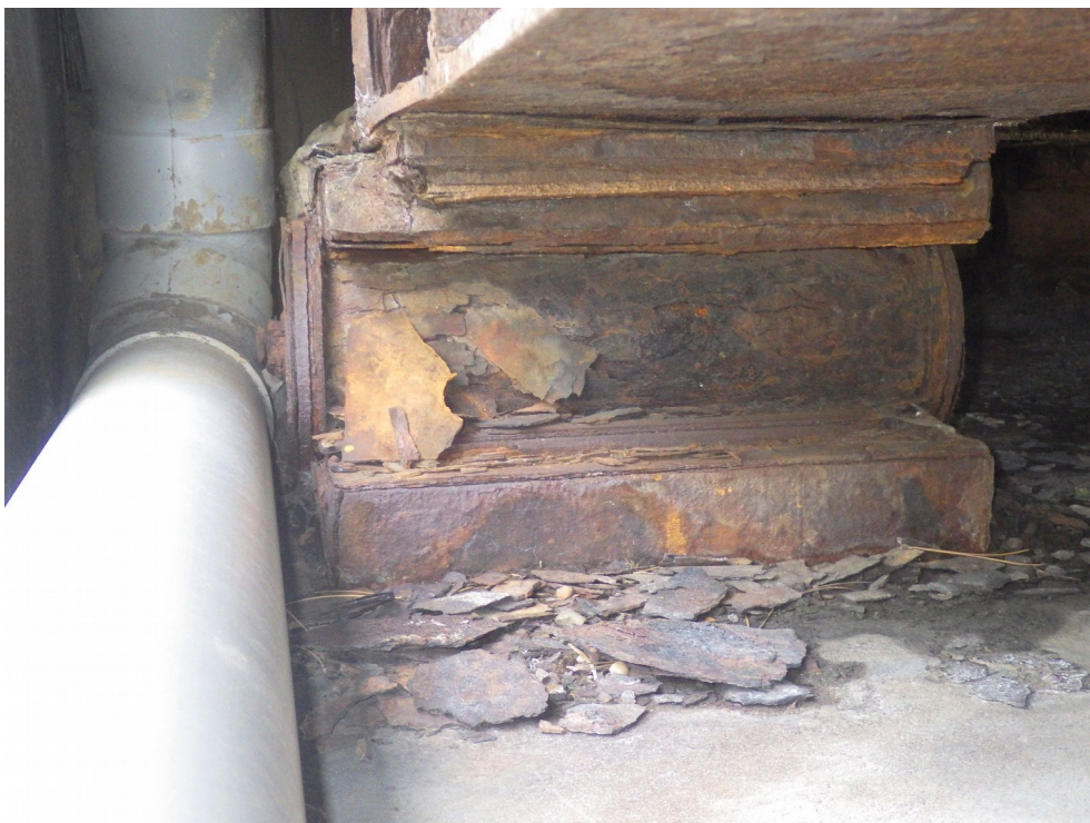
Photo 28 : Appareil d'appui P1A, rouleau corrodé Culée Est – C2 – Tablier A (sens Grenoble Lyon)
