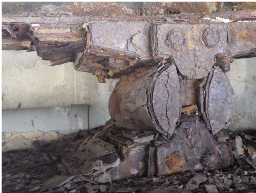
Photo 33 : Appareil d'appui P1B, rouleau fissuré en surface Culée Est – C2 – Tablier B (sens Lyon Grenoble)
