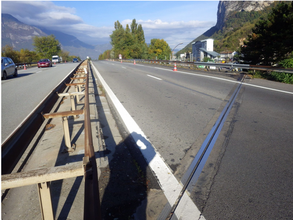
Photo 75 : Oxydation généralisée des glissières de sécurité
