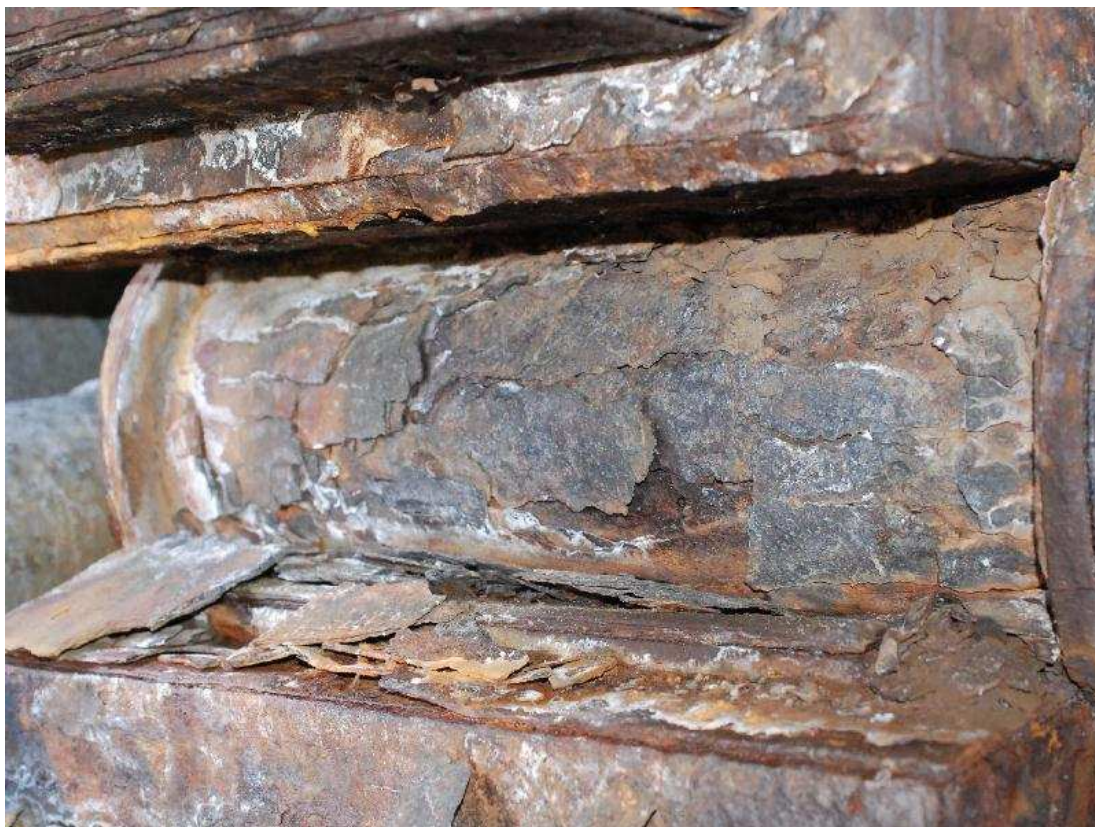
Photo n°1 : Appareil d'appui de P1A sur culée Est.
