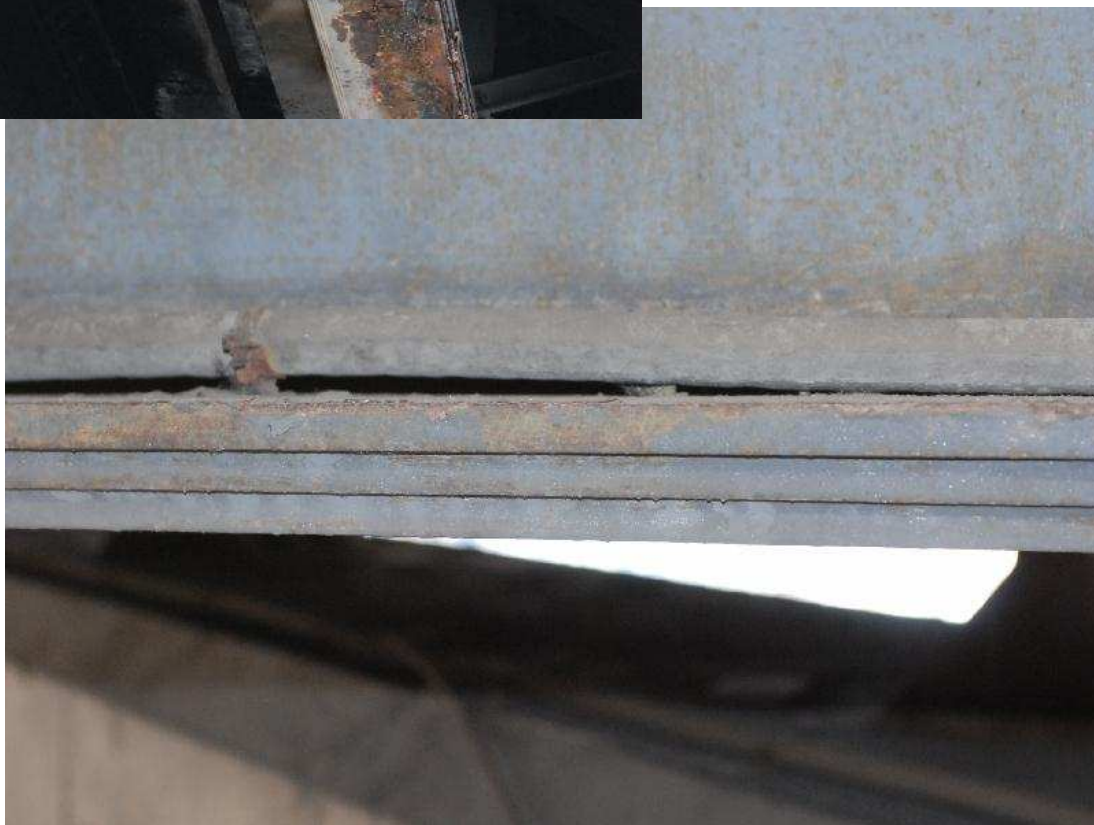
Photo 22 : Enrouillement au droit des arêtes des pièces métalliques.
