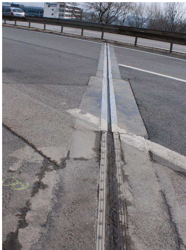
Photo 36 : joint de chaussée NE - Photo 37 : Joint de chaussée NO Photo 38 : Joint de chaussée SE – Joint de chaussée SO
