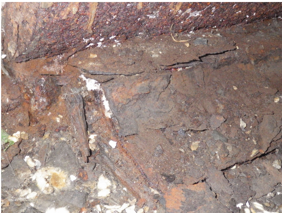
Photo 20 : Appareil d'appui P13A, platine inférieure corrodée Culée Ouest – C0 – Tablier A (sens Grenoble Lyon)
