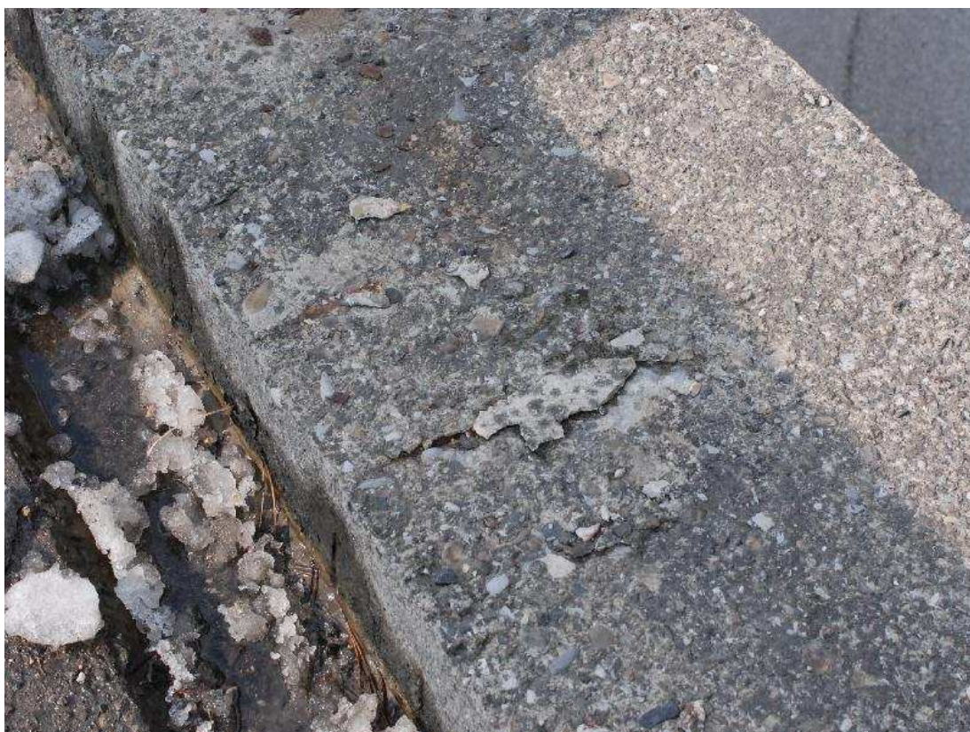
Photo 34 : Armatures apparentes en face supérieure des corniches.
