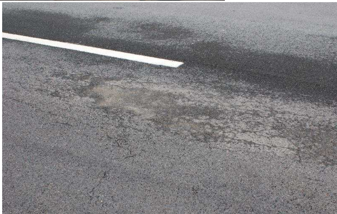
Photo 28 : Dégradation de la couche de roulement du tablier Sud avec remontée de laitance.
