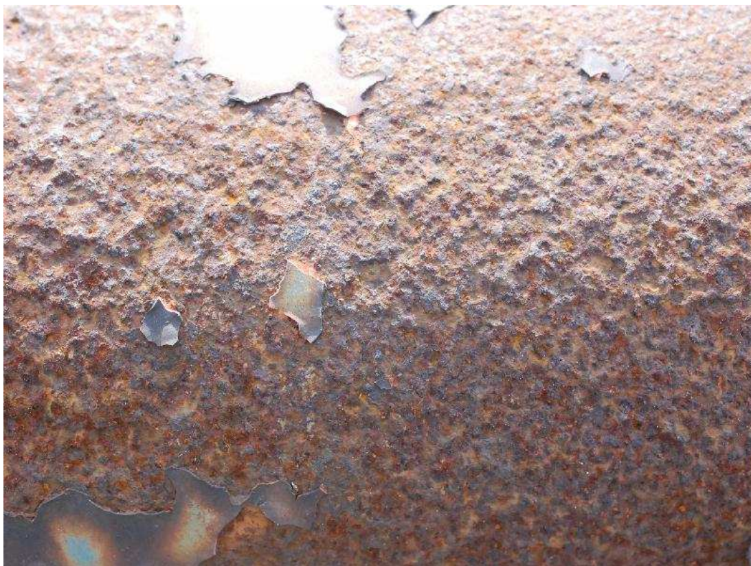
Photo 33 : Oxydation locale de la lisse supérieure du garde corps.
