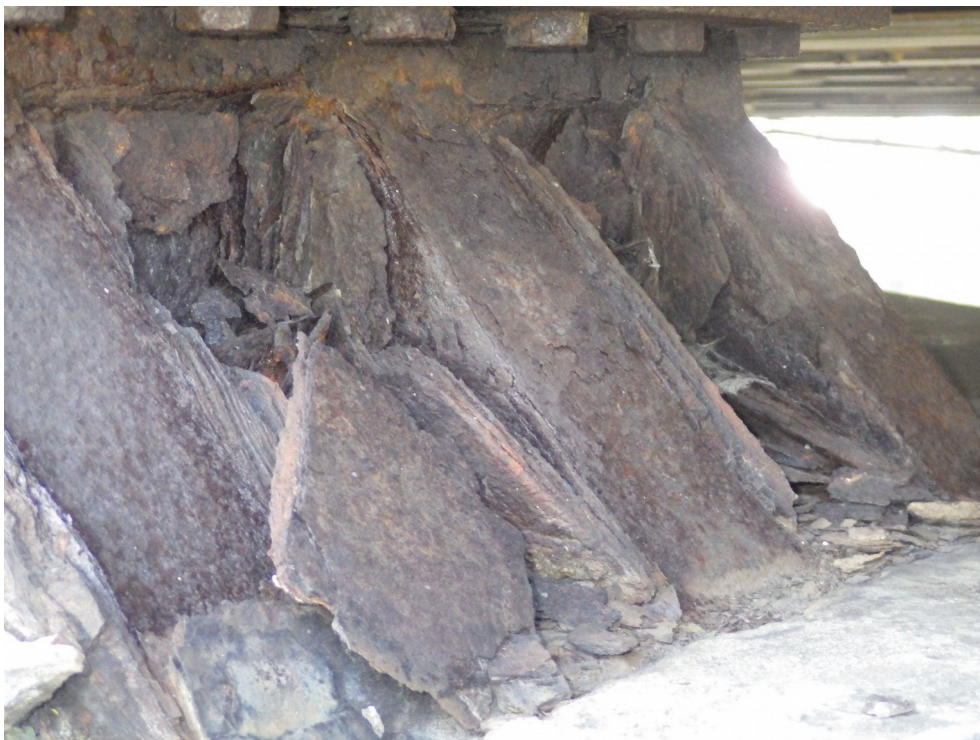
Photo 38 : Appareil d'appui P1A-P8A Pile P1 – Tablier A (sens Grenoble Lyon)
