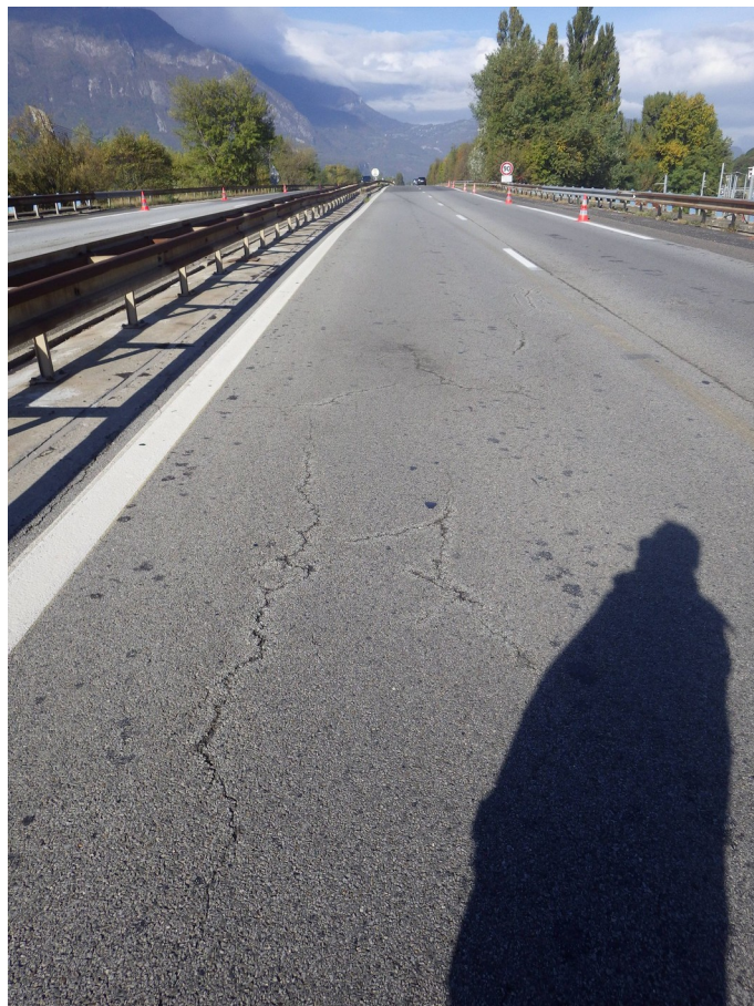
Photo 58 : Faïençage de la couche de roulement en voie rapide sens Grenoble Lyon
