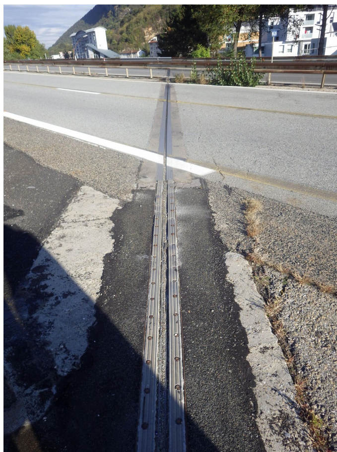
Photo 66 : Vue générale du joint de chaussée, côté Grenoble – Tablier B
