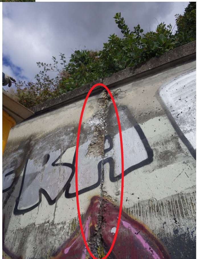
Photo 8 : Eclats le long du joint de bétonnage des plots 2 et 3 Déversement intérieur du plot 3 par rapport au plot 2 Culée Est – C2 – Mur en aile Sud
