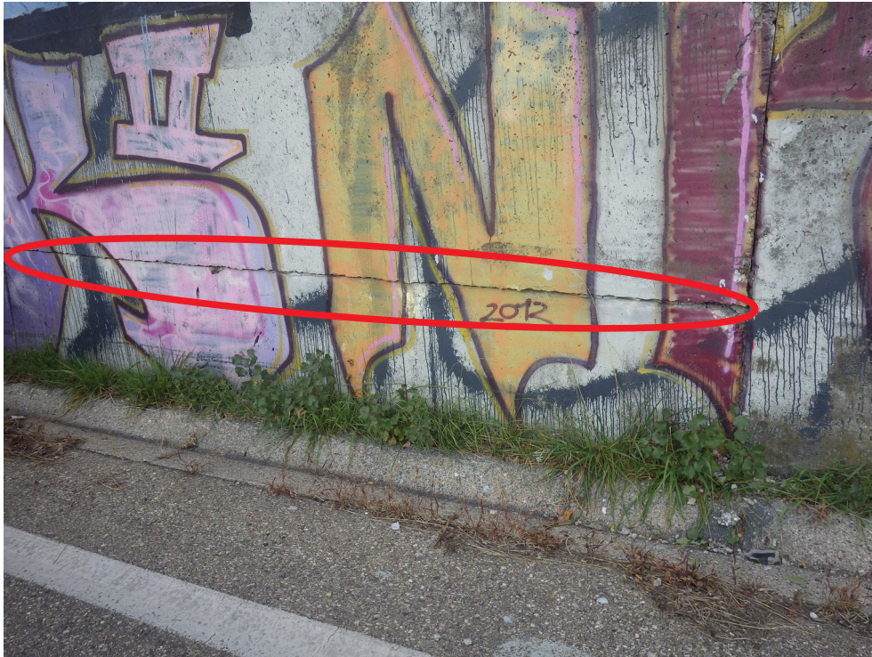
Photo 11 : Fissuration horizontale de la partie basse du plot 2 Culée Est – C0 – Mur en aile Sud
