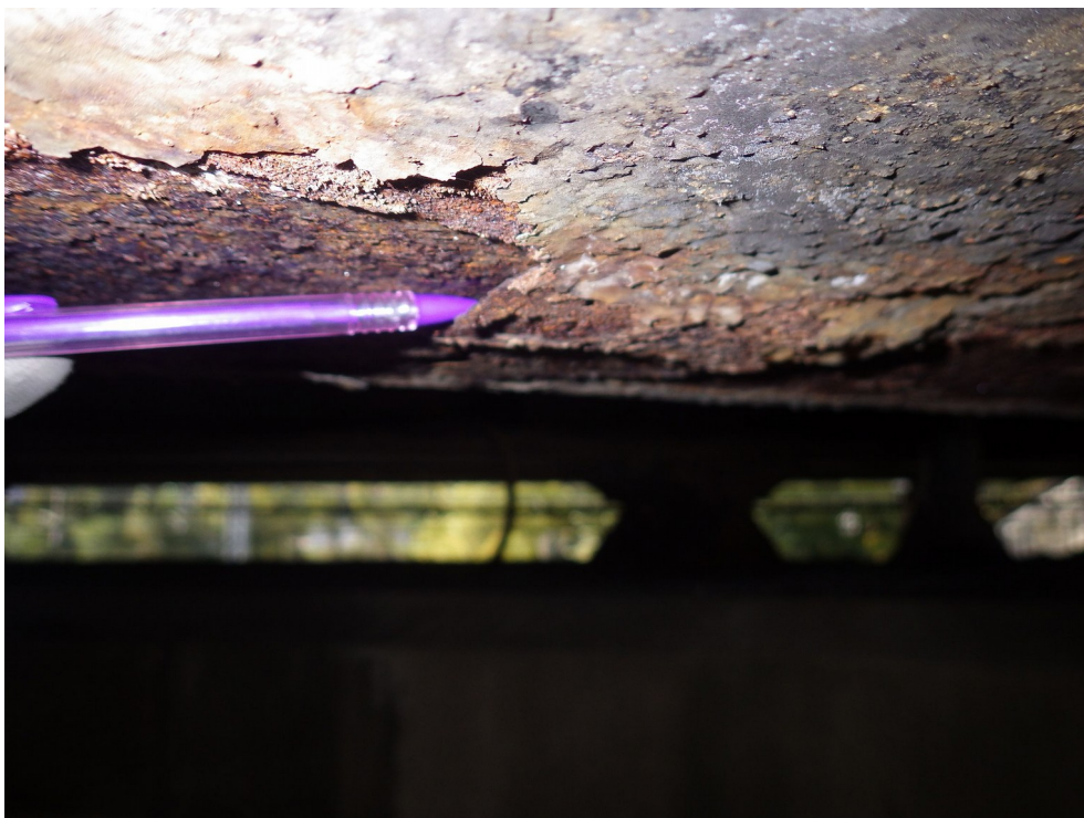
Photo 46 : Feuilletage localisé en sous-face sur poutre P7A Tablier A (sens Grenoble Lyon)
