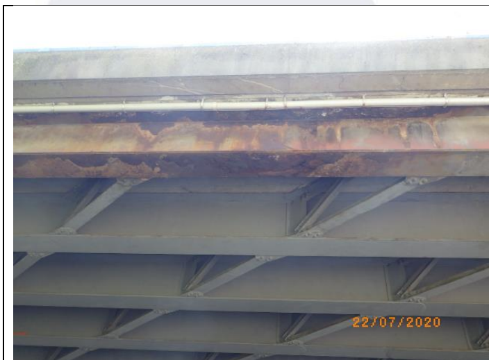
Localisation Désignation About de P1A Enrouillement
