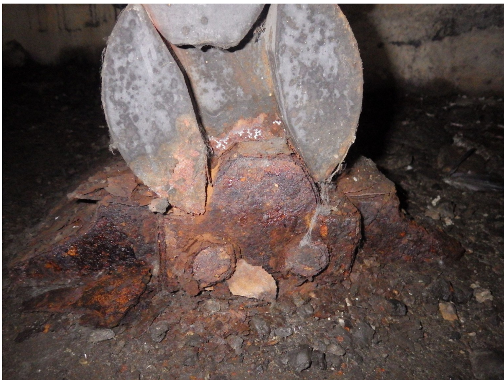
Photo 24 : Appareil d'appui P10B, platine et dent inférieures corrodées Culée Ouest – C0 – Tablier B (sens Lyon Grenoble)
