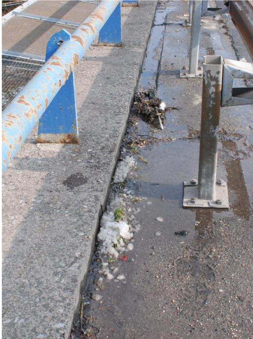
Photo 35 : Encrassement de la cunette de drainage en bordure du tablier Nord.
