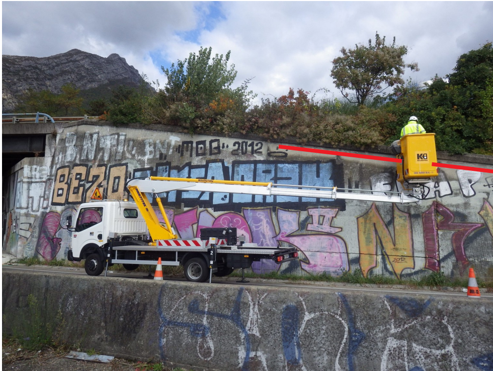
Photo 5 : Fissure sous couronnement du mur en aile Culée Est – C2 – Mur en aile Sud
