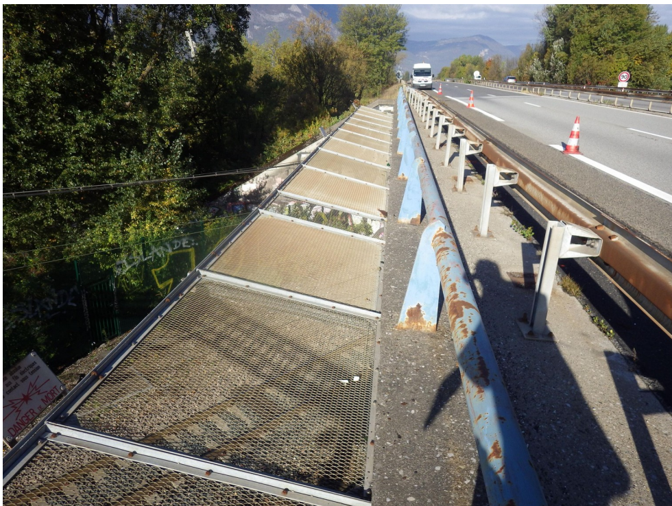
Photo 80 : Enrouillement de la boulonnerie du système de protection des voies SNCF
