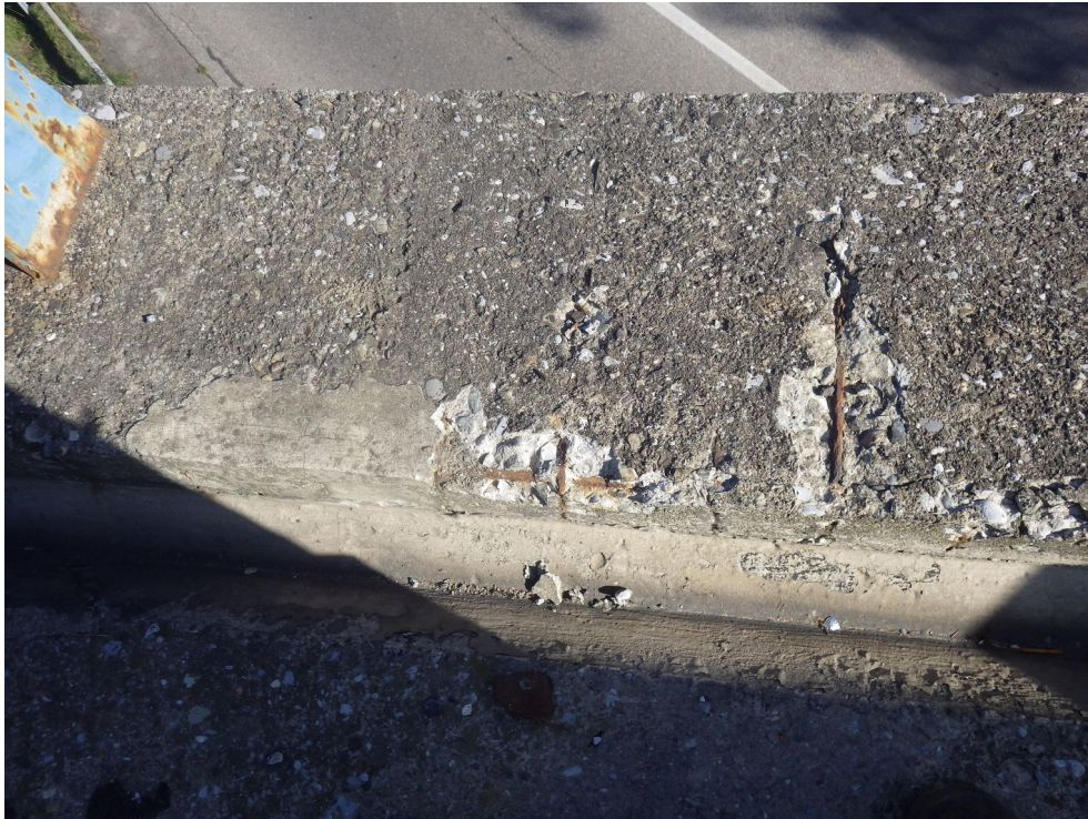
Photo 77 : Eclats avec aciers apparents oxydés sur éléments de corniches
