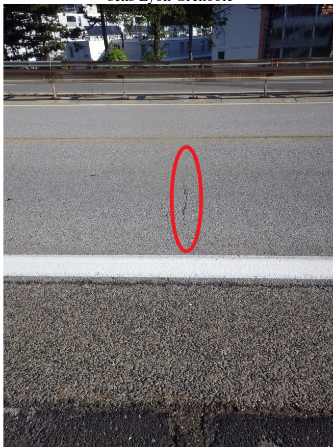
Photo 60 : Fissuration transversale en voie lente – PM 49 – sens Lyon Grenoble
