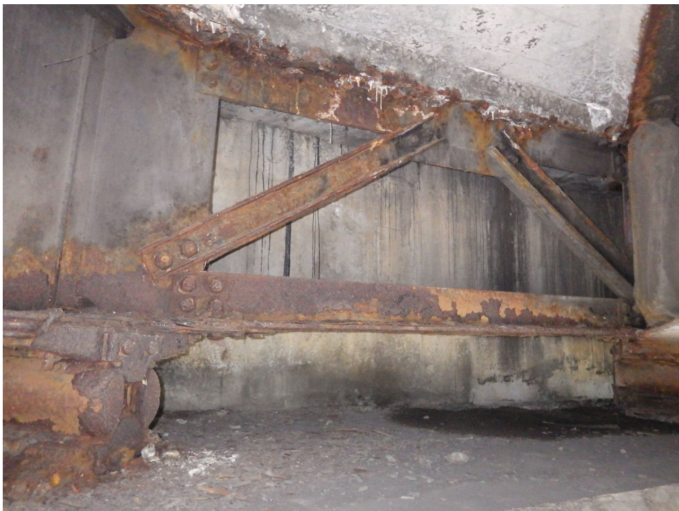
Photo 48 : Corrosion de l'entretoise entre les poutres 1A et 3A Culée Est – C2 – Tablier A (sens Grenoble Lyon)
