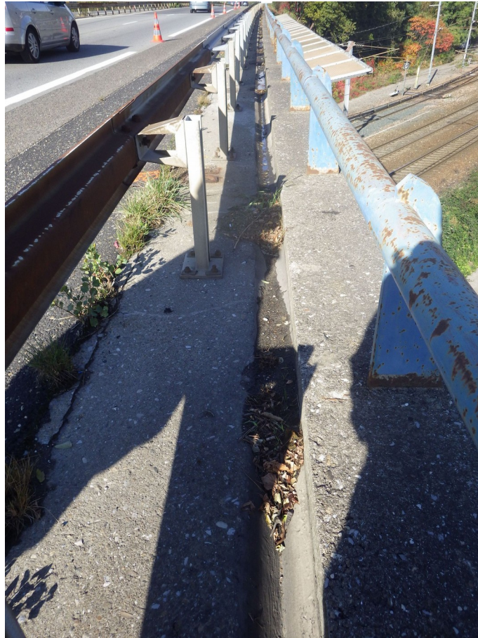
Photo 73 : Fil d'eau bouché par des matériaux – Tablier A (sens Grenoble Lyon)
