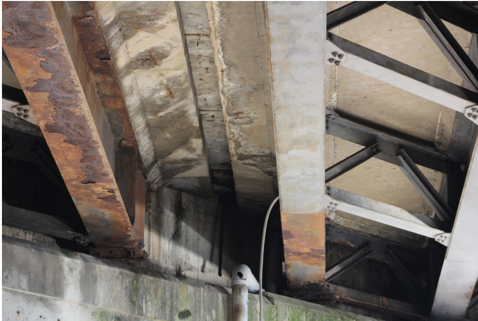
Photo 49 : zone oxydée en sous-face de la membrure inférieures Poutre 1B – Tablier B (sens Lyon Grenoble)
