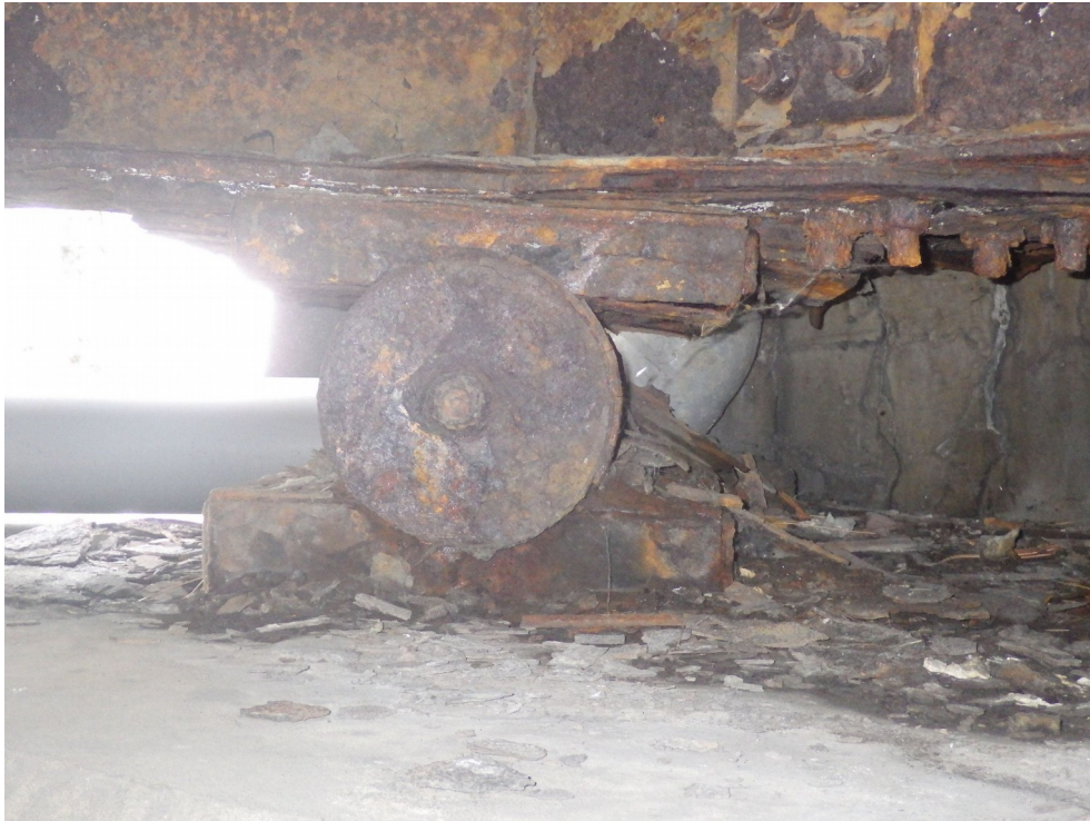
Photo 27 : Appareil d'appui P1A, platines corrodées Culée Est – C2 – Tablier A (sens Grenoble Lyon)
