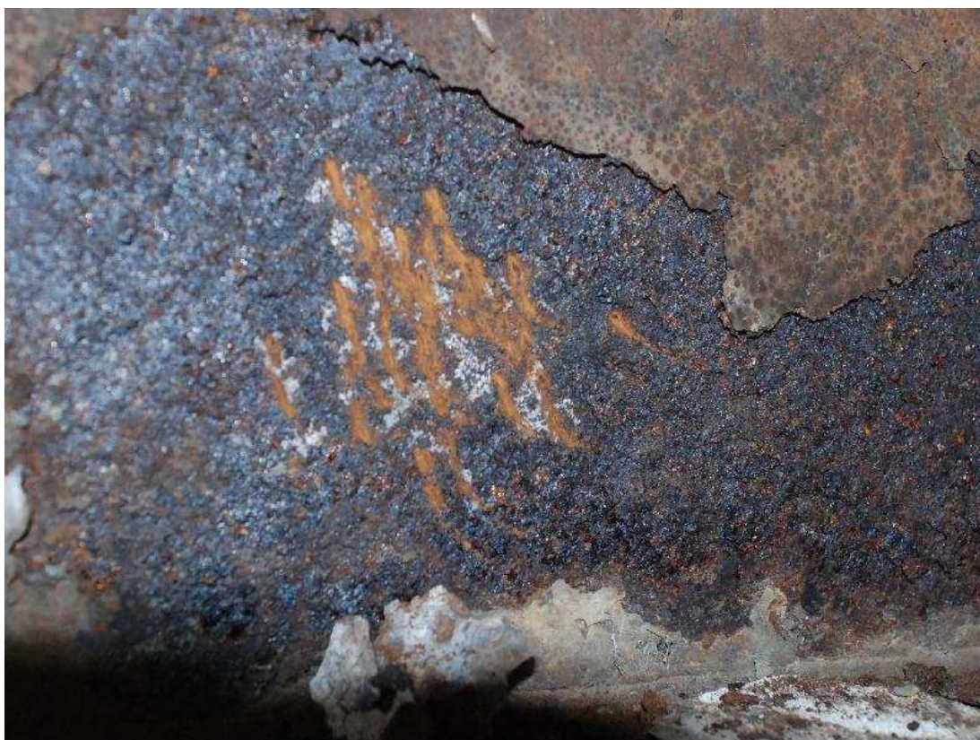
Photo 20 : Vue de détail de l'oxydation du bas de l'âme de la poutre P7A côté Sud.
