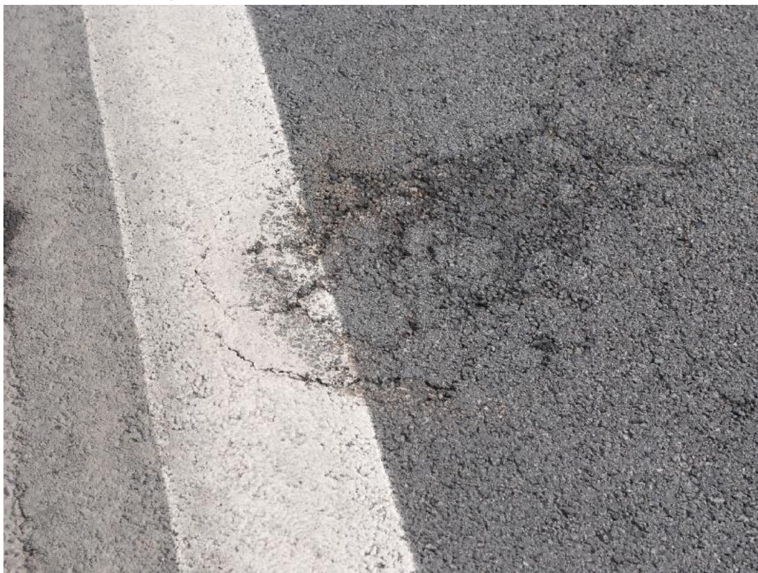
Photo 29 : Dégradation de la couche de roulement du tablier Sud à l'about Est. Photo 30 : Nid de poule en formation en bordure de la voie lente du tablier Nord.
