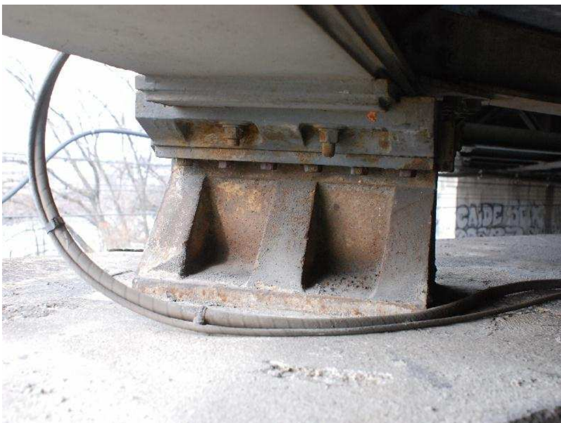
Photo n°3 : Appareil d'appui de P2A sur culée Est. Photo n°4 : Appareil d'appui de P7B-P14B sur pile.
