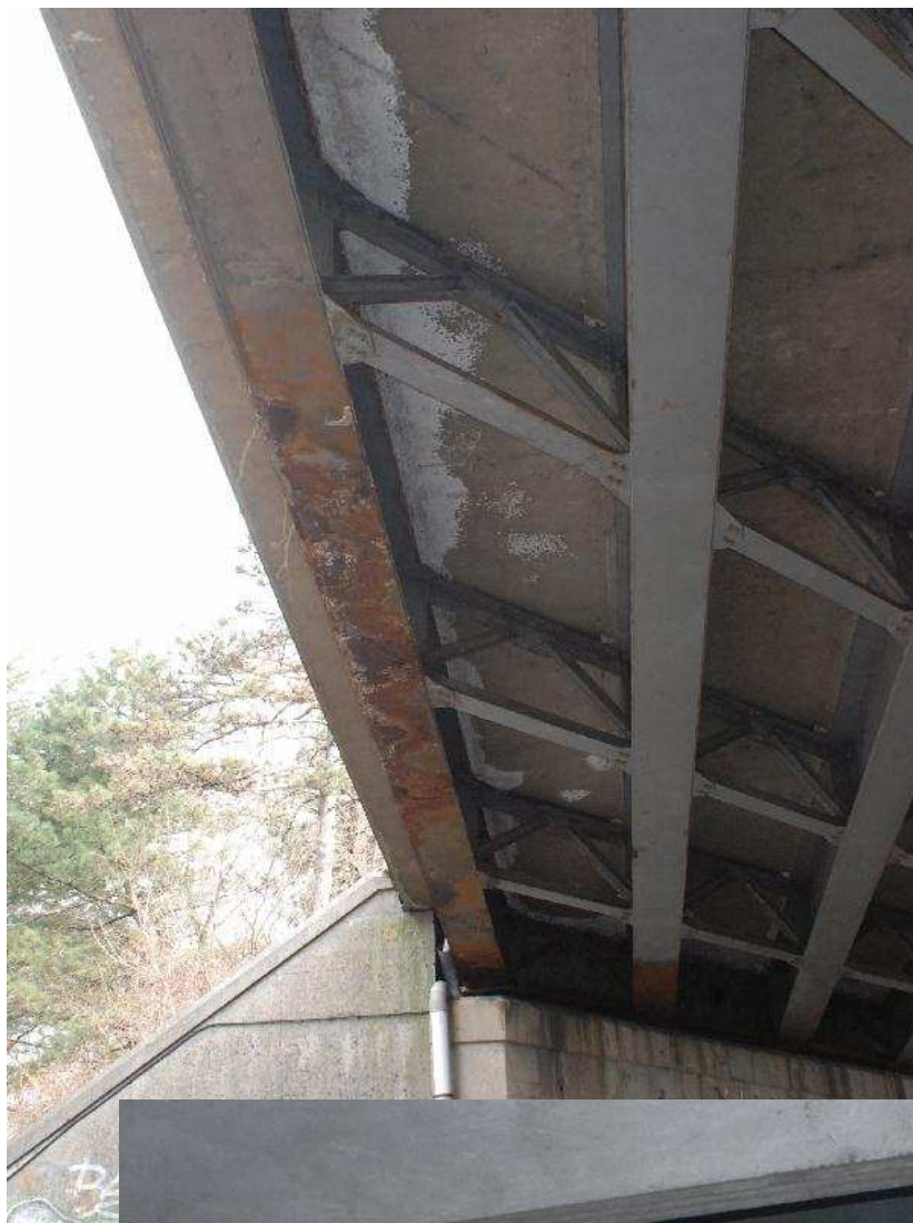
Photo n°25 : Intrados de la dalle , traces de passage d'eau en périphérie des tabliers, le long des poutres et entretoises.
