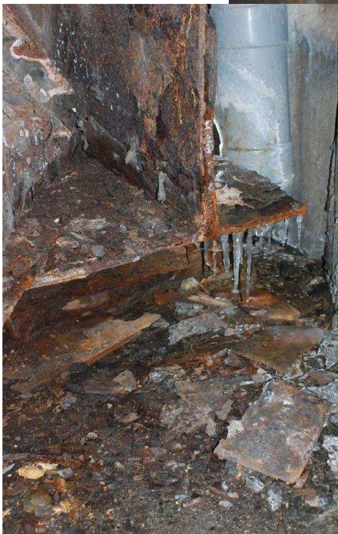
Photo n°16 : Détail de l'oxydation du bas de l'âme et de la semelle de la poutre P1A.
