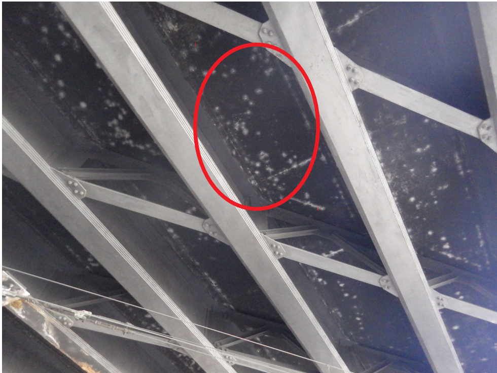
Photo 54 : Pommelage de type efflorescence Tablier B (sens Lyon Grenoble)
