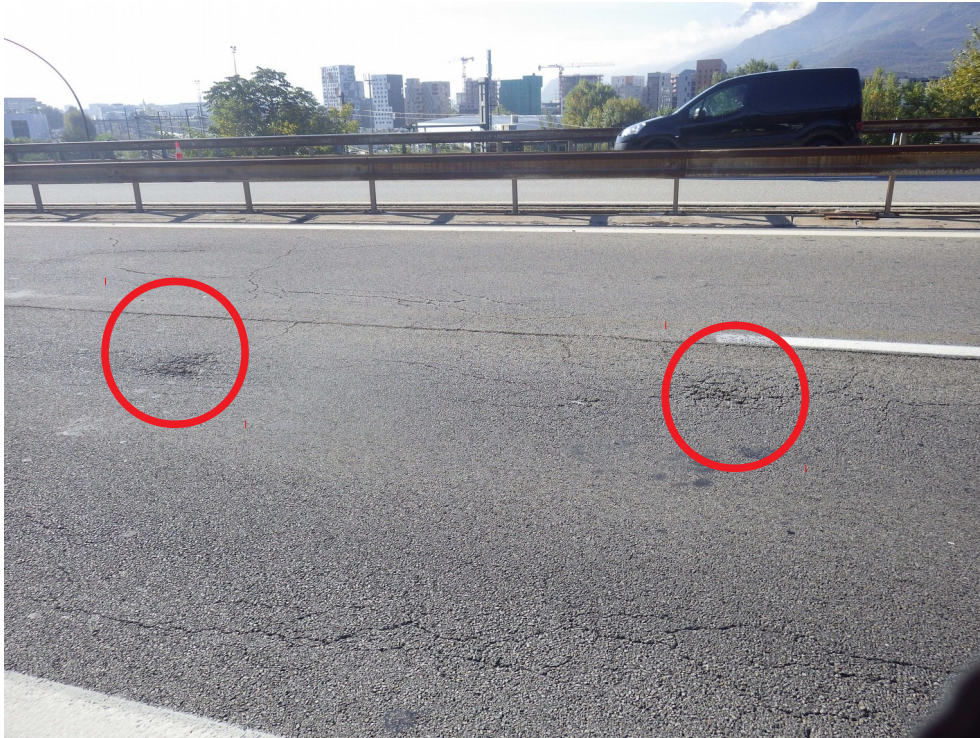
Photo 61 : Nids de poule en formation – PM 15 et 33 – sens Grenoble Lyon
