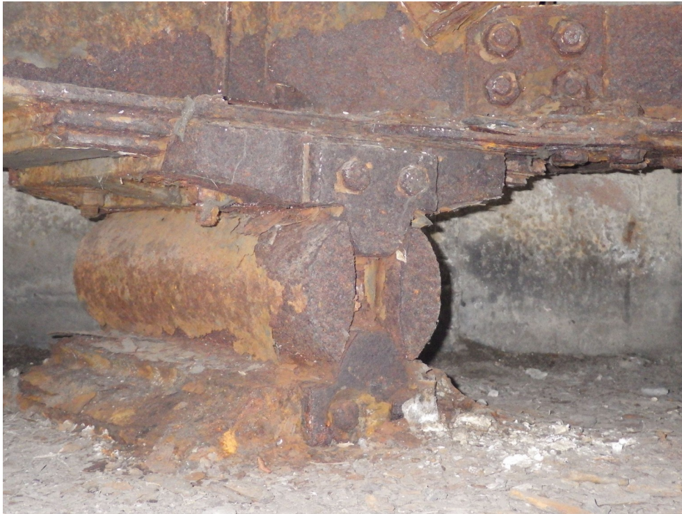
Photo 29 : Appareil d'appui P2A Culée Est – C2 – Tablier A (sens Grenoble Lyon)
