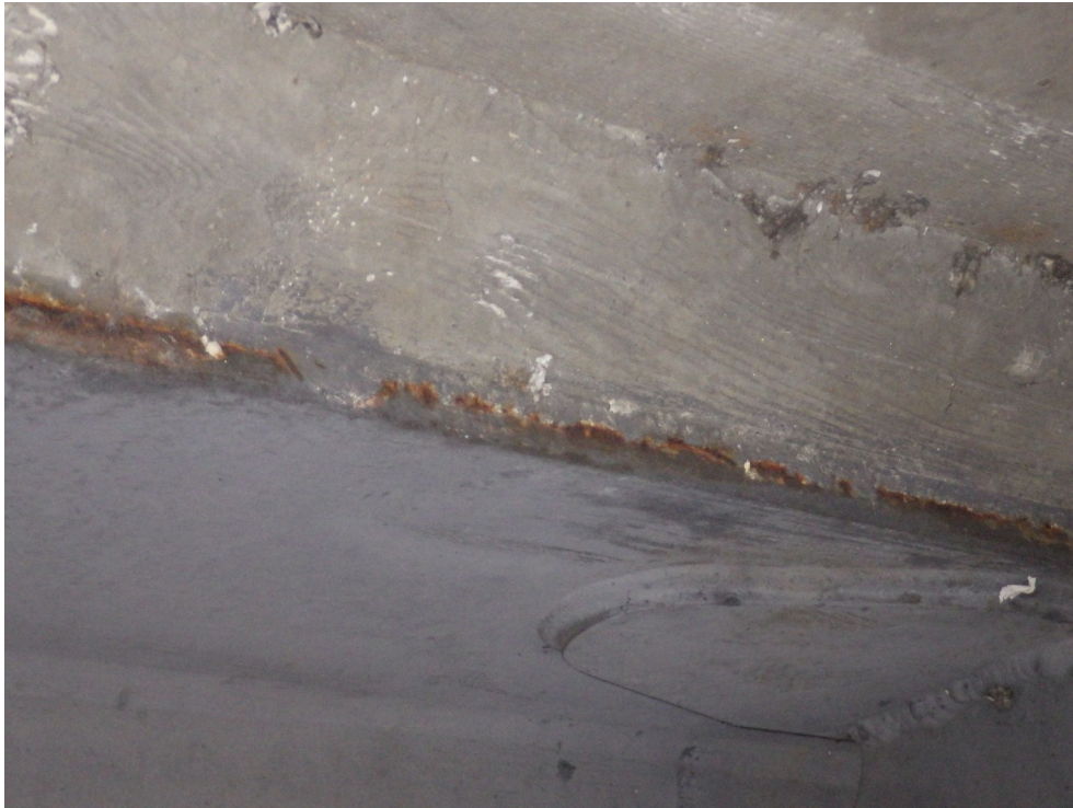
Photo 47 : Oxydation localisée sur arêtes des membrures supérieures des poutres
