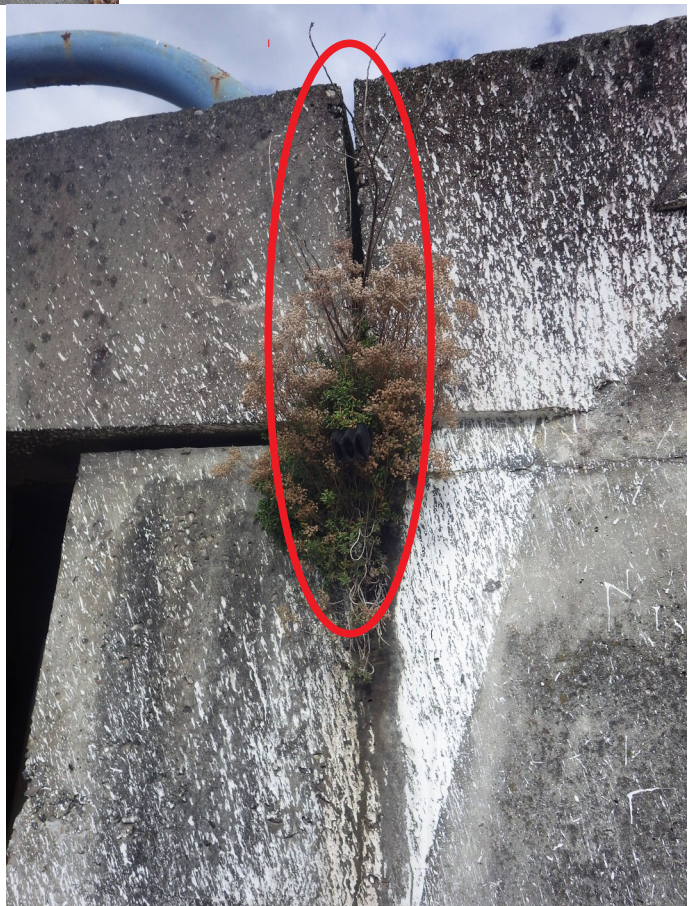
Photo 10 : Déversement extérieur du premier plot du mur en aile par rapport au mur de front Culée Est – C2 – Mur en aile Sud
