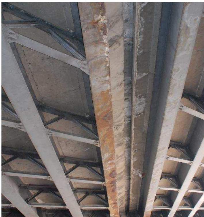
Vue générale des assemblages poutres/entretoises (pièces de pont) Photo prise au droit du TPC de la travée routière.
