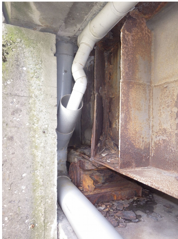
Photo 42 : About Est de la poutre P1A corrodé Tablier A (sens Grenoble Lyon)
