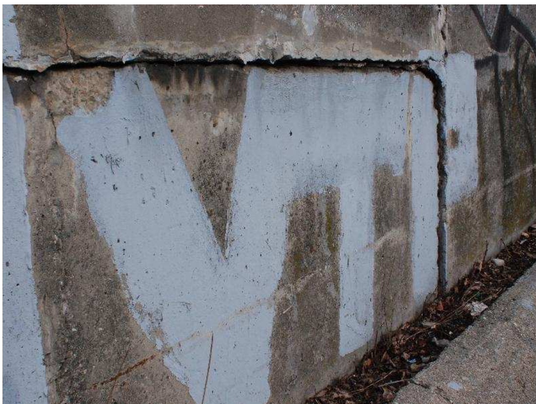
Photo n°10 : Tassement et déversement d'un élément de mur en aile Sud Est.
