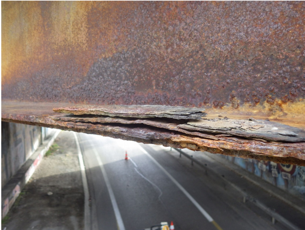
Photo 43 : Feuilletage localisé en membrure inférieure sur poutre P1A Tablier A (sens Grenoble Lyon)
