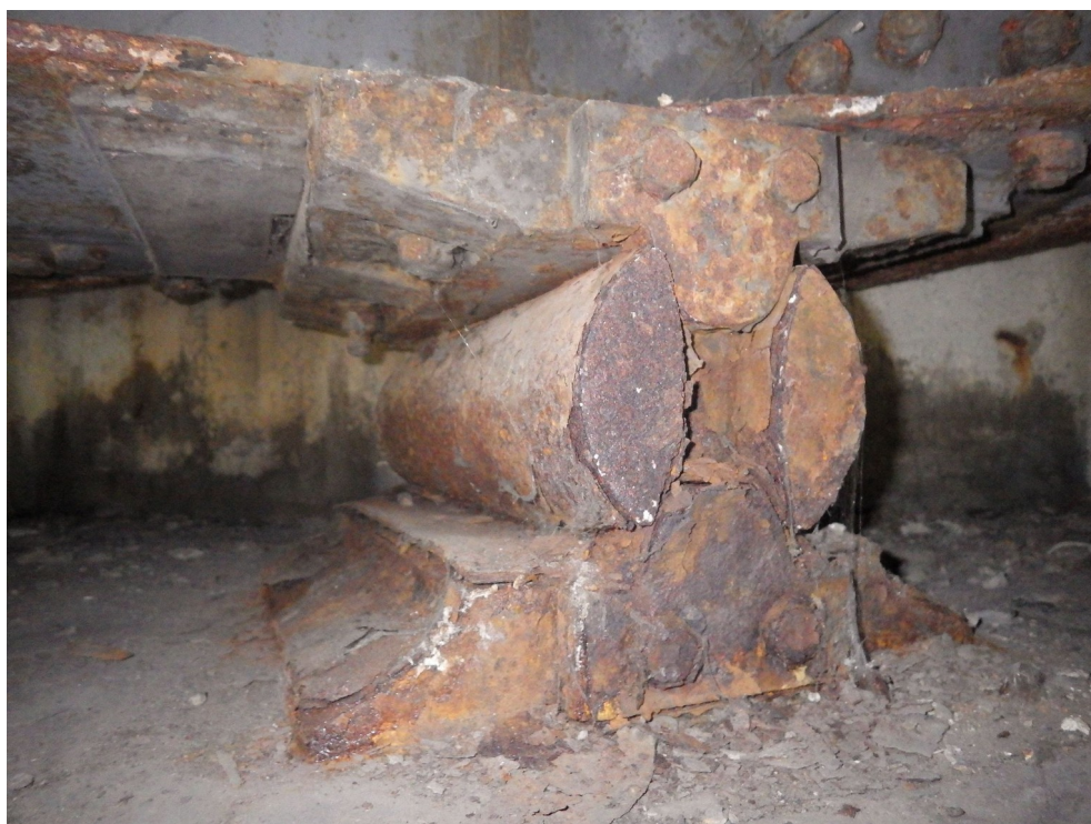
Photo 34 : Appareil d'appui P2B Culée Est – C2 – Tablier B (sens Lyon Grenoble)
