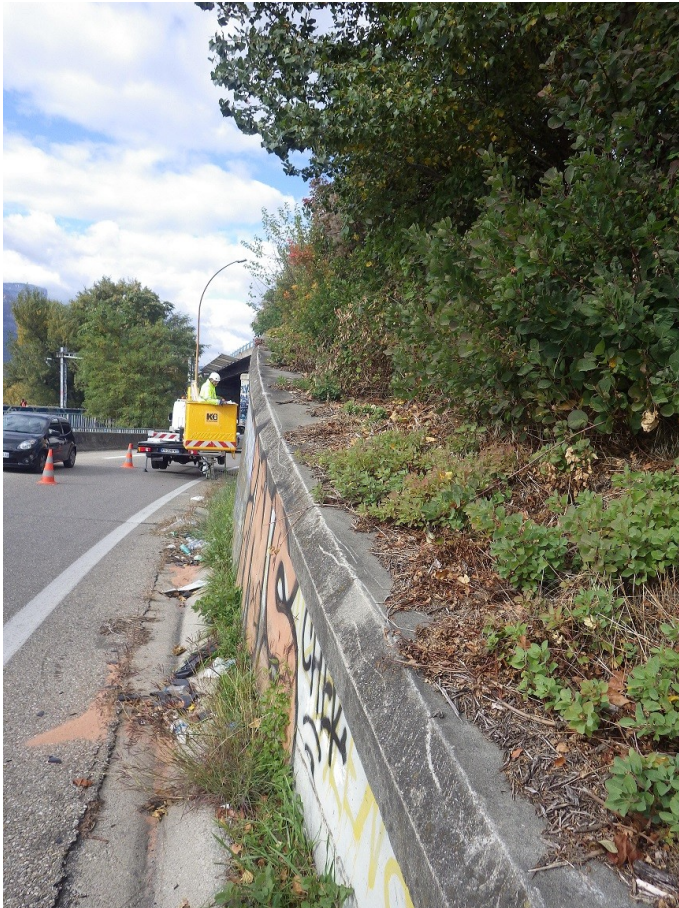
Photo 9 : Végétation envahissante en tête de mur Culée Est – C2 – Mur en aile Sud
