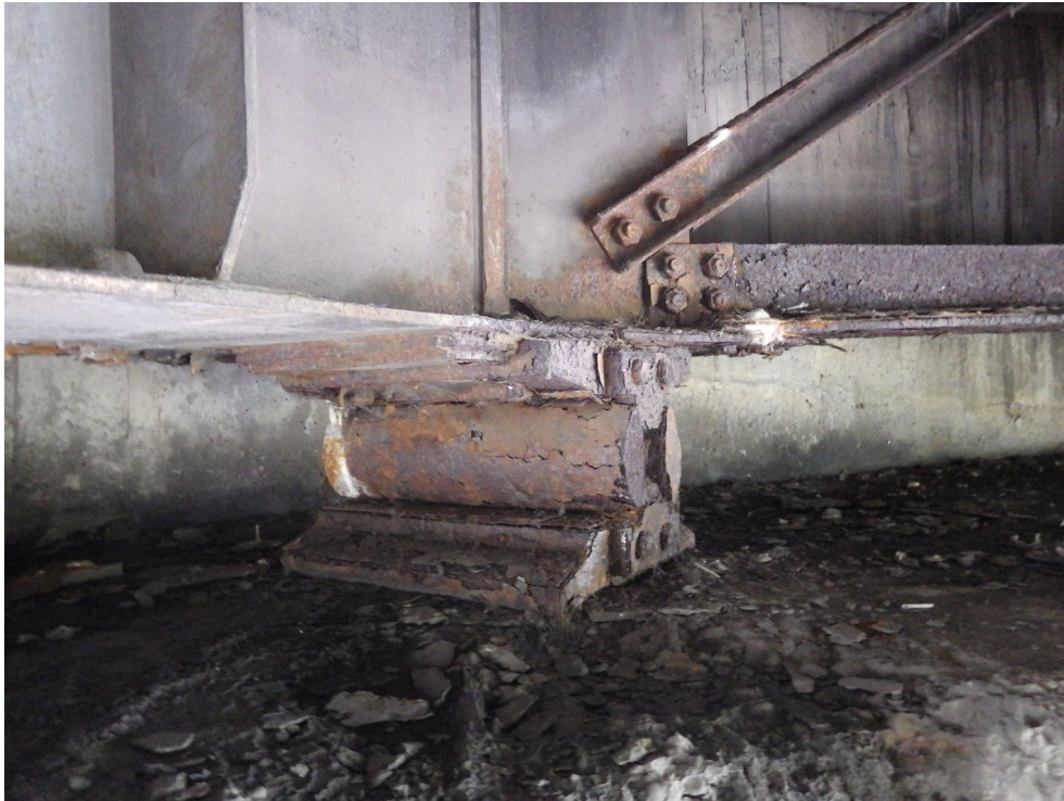
Photo 31 : Appareil d'appui P4A Culée Est – C2 – Tablier A (sens Grenoble Lyon)
