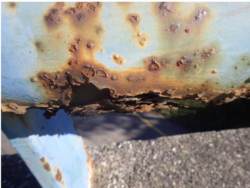
Photo 74 : Corrosion locale prononcée des garde-corps
