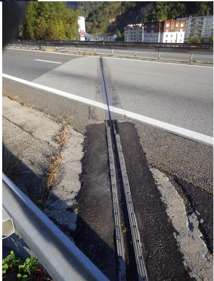
Photo 64 : Défaut d'alignement entre VL et VR joint côté Lyon – Tablier B (sens Lyon Grenoble)
