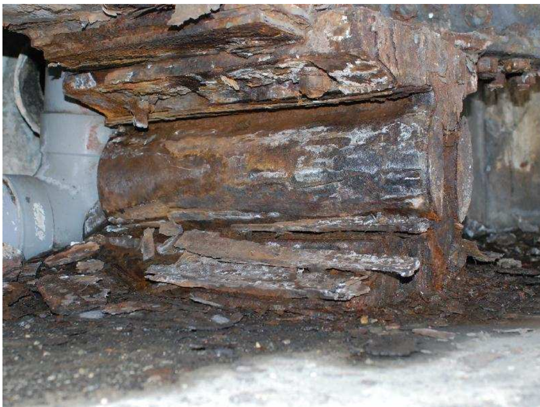
Photo n°2 : Appareil d'appui de P1B sur culée Est.
