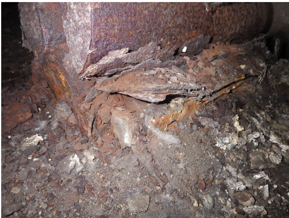
Photo 22 : Appareil d'appui P14A, platine inférieure corrodée Culée Ouest – C0 – Tablier A (sens Grenoble Lyon)
