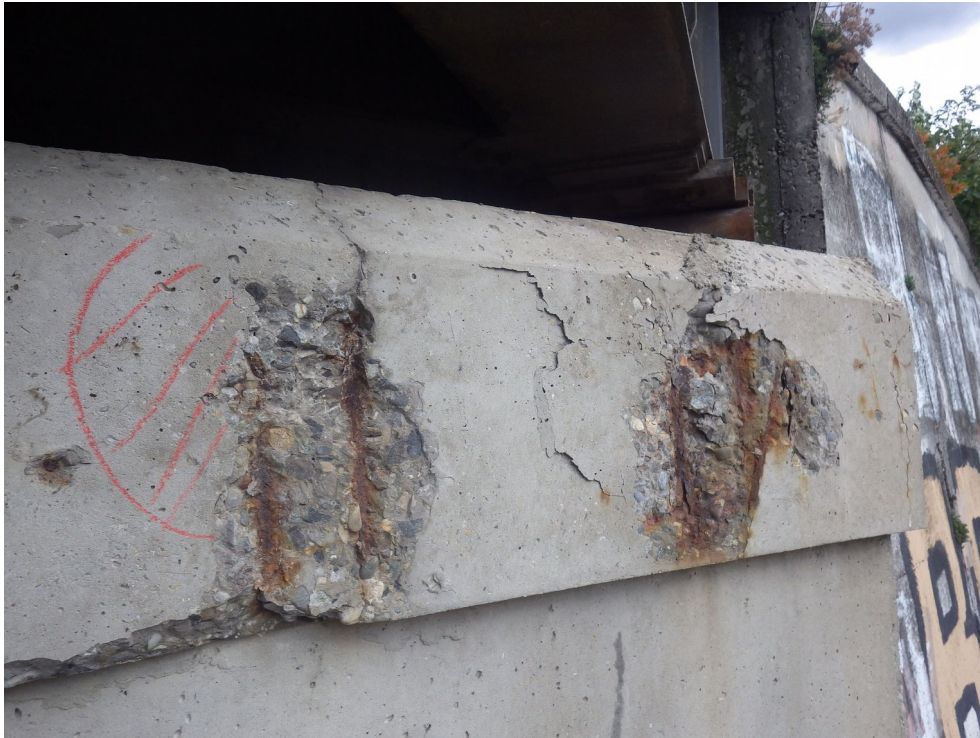
Photo 1 : Nouvelles zones sonnant le creux et éclats avec aciers apparents oxydés (avant purge) Culée Est – C0 – Tablier B (sens Lyon Grenoble) – côté Sud
