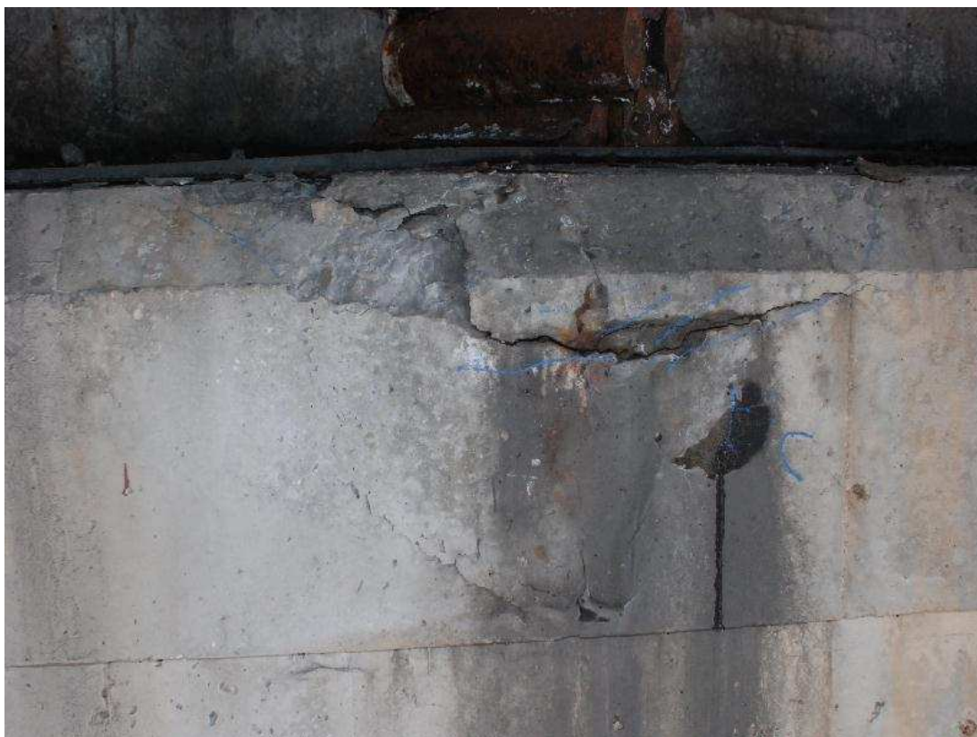
Photo n°8 : Eclat de béton sur culée Est avant dégagement du béton instable.
