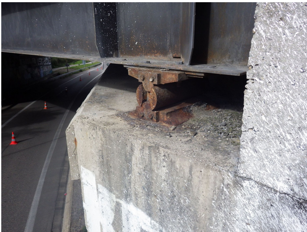
Photo 36 : Appareil d'appui P7B Culée Est – C2 – Tablier B (sens Lyon Grenoble)
