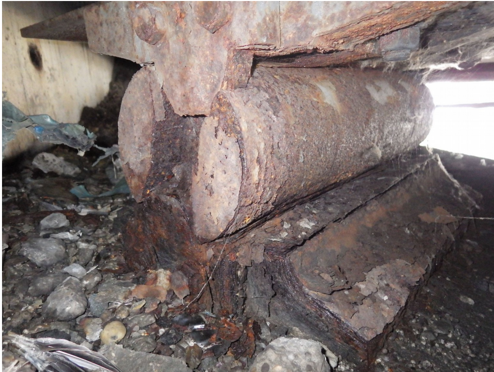
Photo 23 : Appareil d'appui P9B, platine et dent inférieures corrodées Culée Ouest – C0 – Tablier B (sens Lyon Grenoble)
