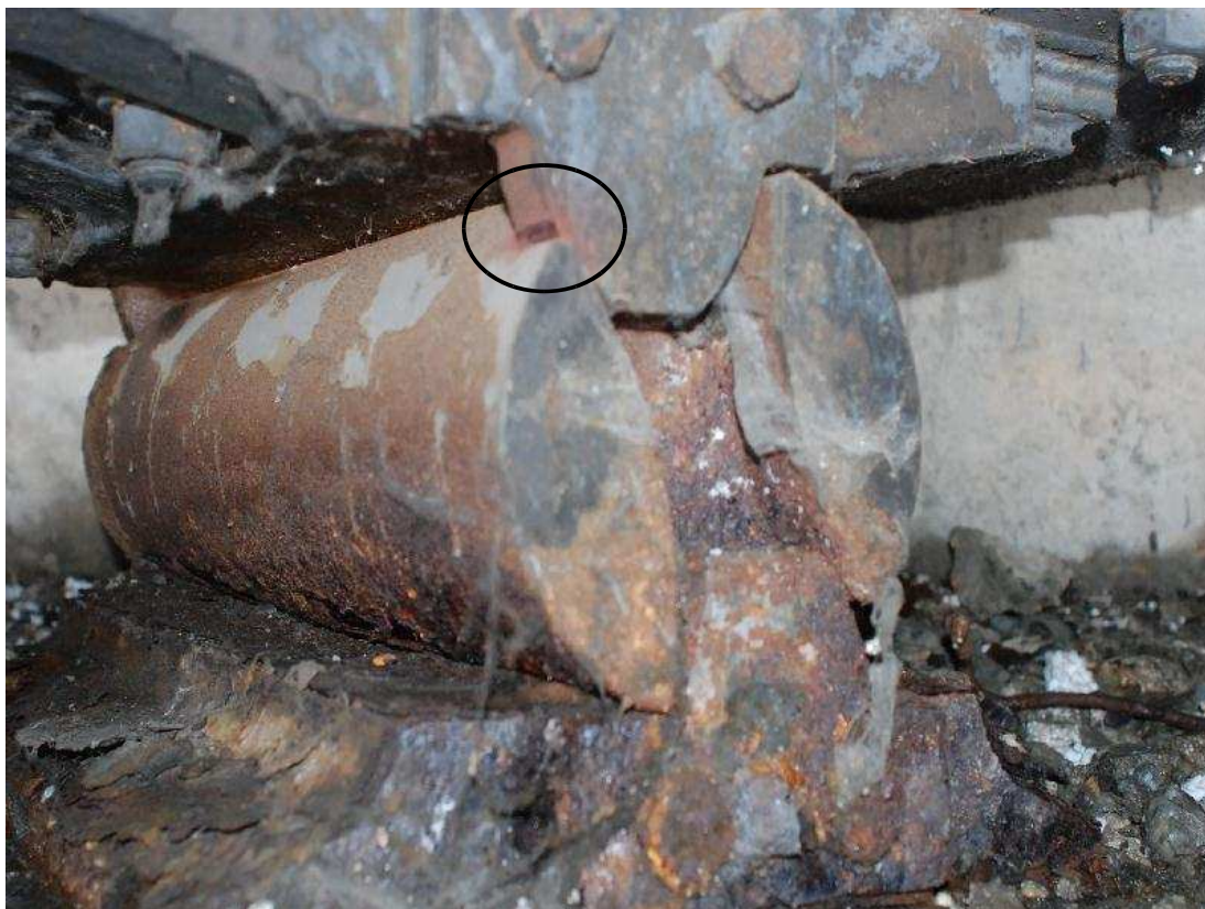
Photo n°7 : Appareil d'appui de P14A sur culée Ouest (traces de fonctionnement visible).
