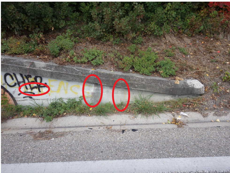
Photo 6 : Présence de calcite sur les fissures du dernier plot du mur en aile Culée Est – C2 – Mur en aile Sud
