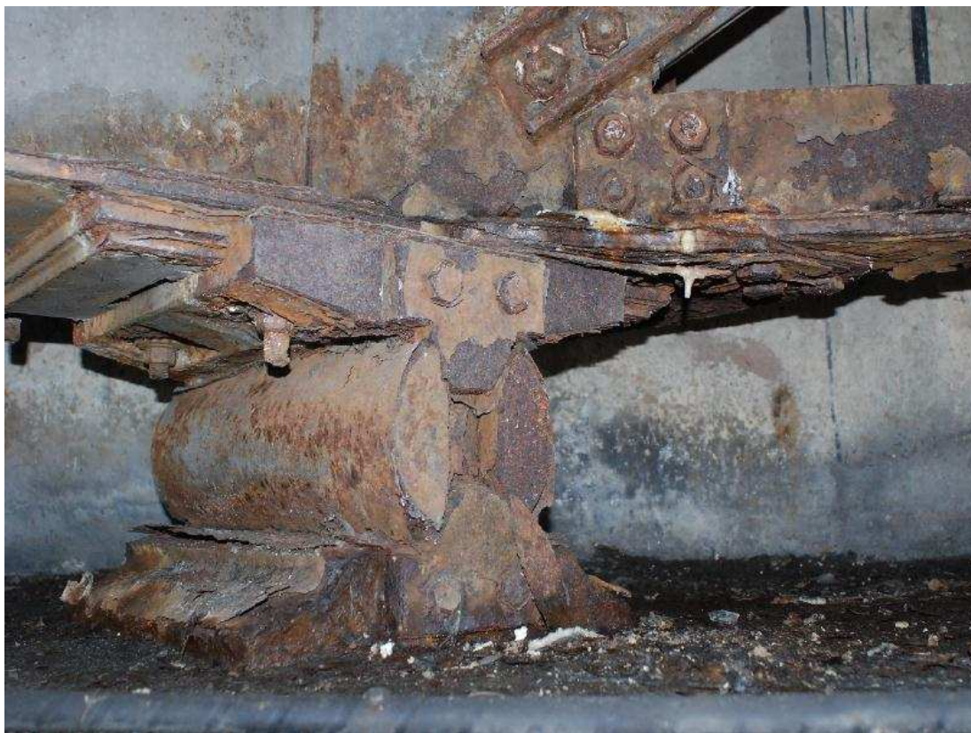
Photo n°3 : Appareil d'appui de P2A sur culée Est. Photo n°4 : Appareil d'appui de P7B-P14B sur pile.
