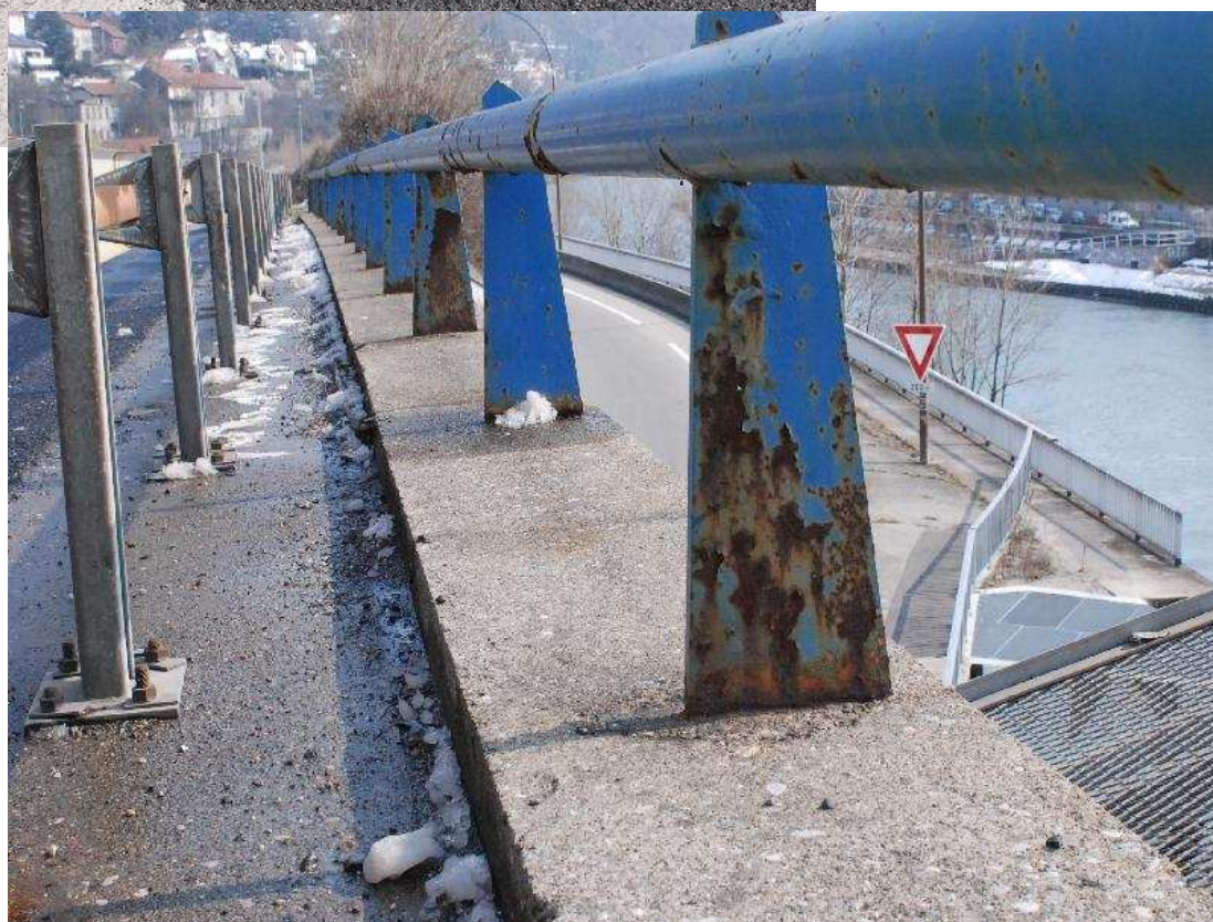
Photo 32 : Garde corps avec protection anticorrosion détruite.
