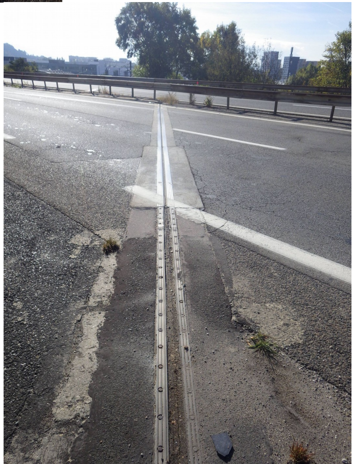
Photo 68 : Vue générale du joint de chaussée, côté Grenoble – Tablier A
