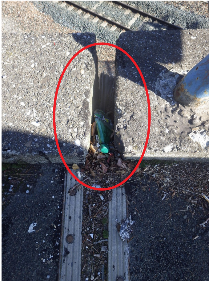
Photo 63 : Absence de relevé de joint au droit de la longrine Tablier B (sens Lyon Grenoble)
