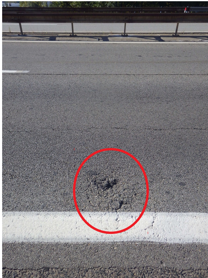
Photo 62 : Nid de poule en formation – PM 50 – sens Grenoble Lyon
