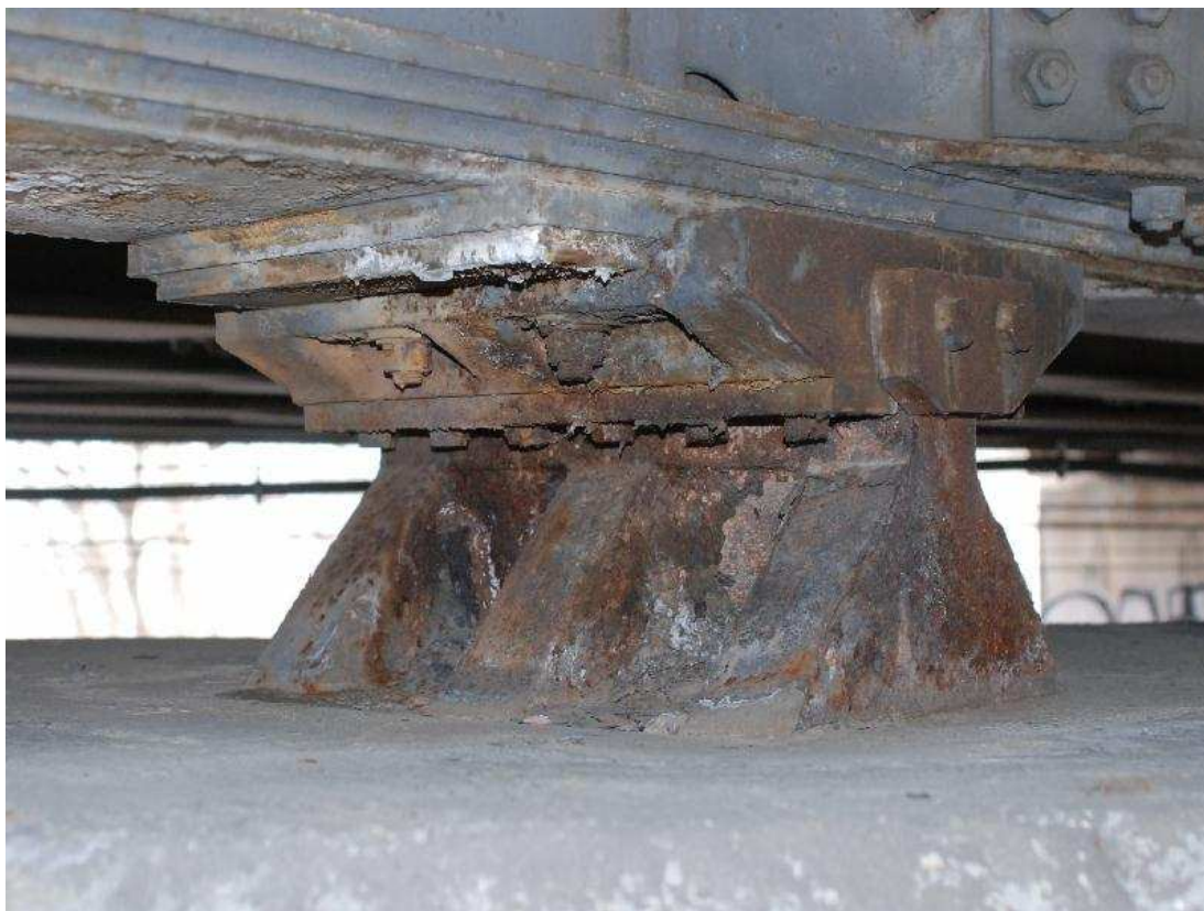
Photo n°5 : Appareil d'appui de P7A-P14A sur culée Est. Photo n°6 : Appareil d'appui de P13B sur culée Ouest
