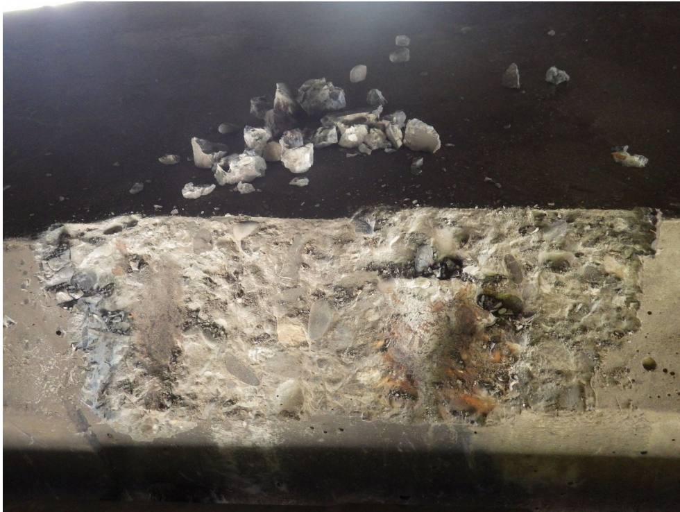
Photo 13 : Eclat avec acier apparent oxydé sur couronnement Pile P1 – about Nord
