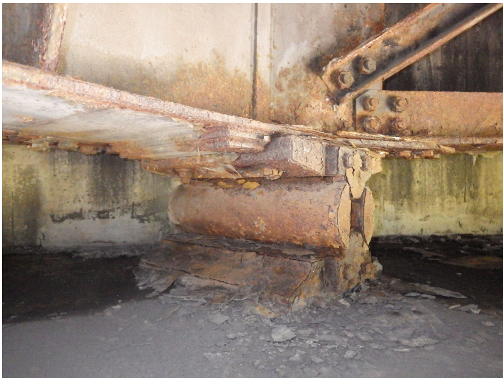
Photo 30 : Appareil d'appui P3A Culée Est – C2 – Tablier A (sens Grenoble Lyon)
