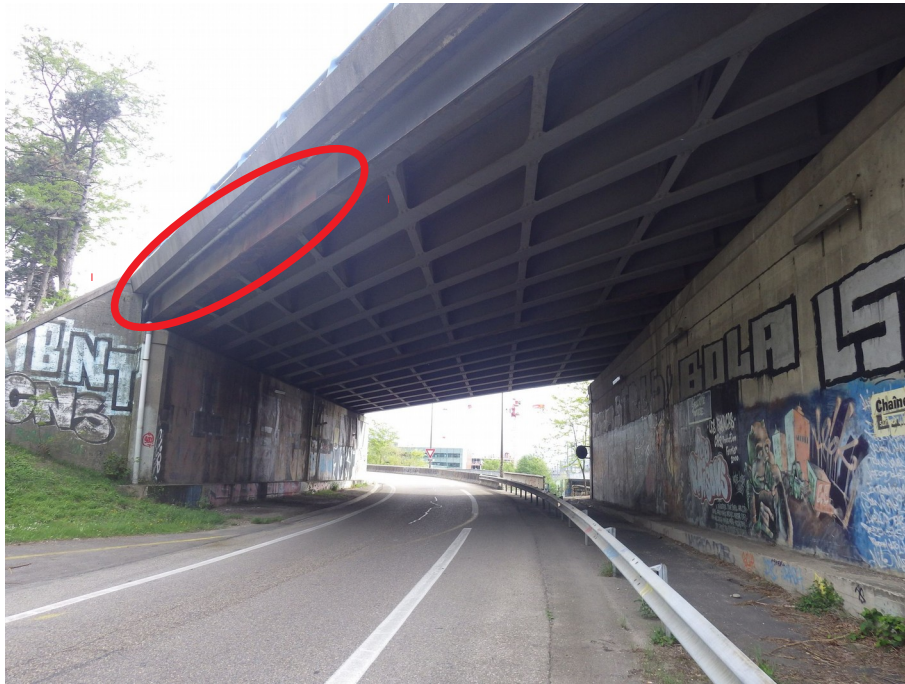
Photo 71 : Chêneau longeant la poutre P1A – Tablier A (sens Grenoble Lyon)
