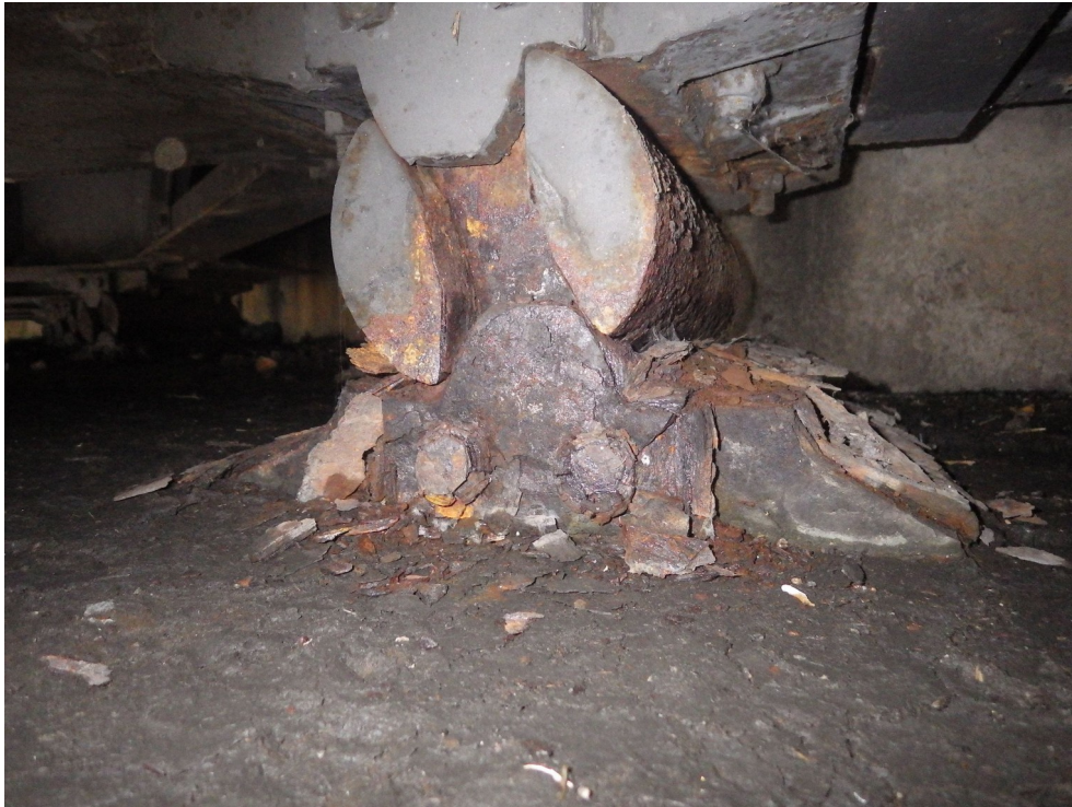
Photo 15 : Appareil d'appui P9A Culée Ouest – C0 – Tablier A (sens Grenoble Lyon)
