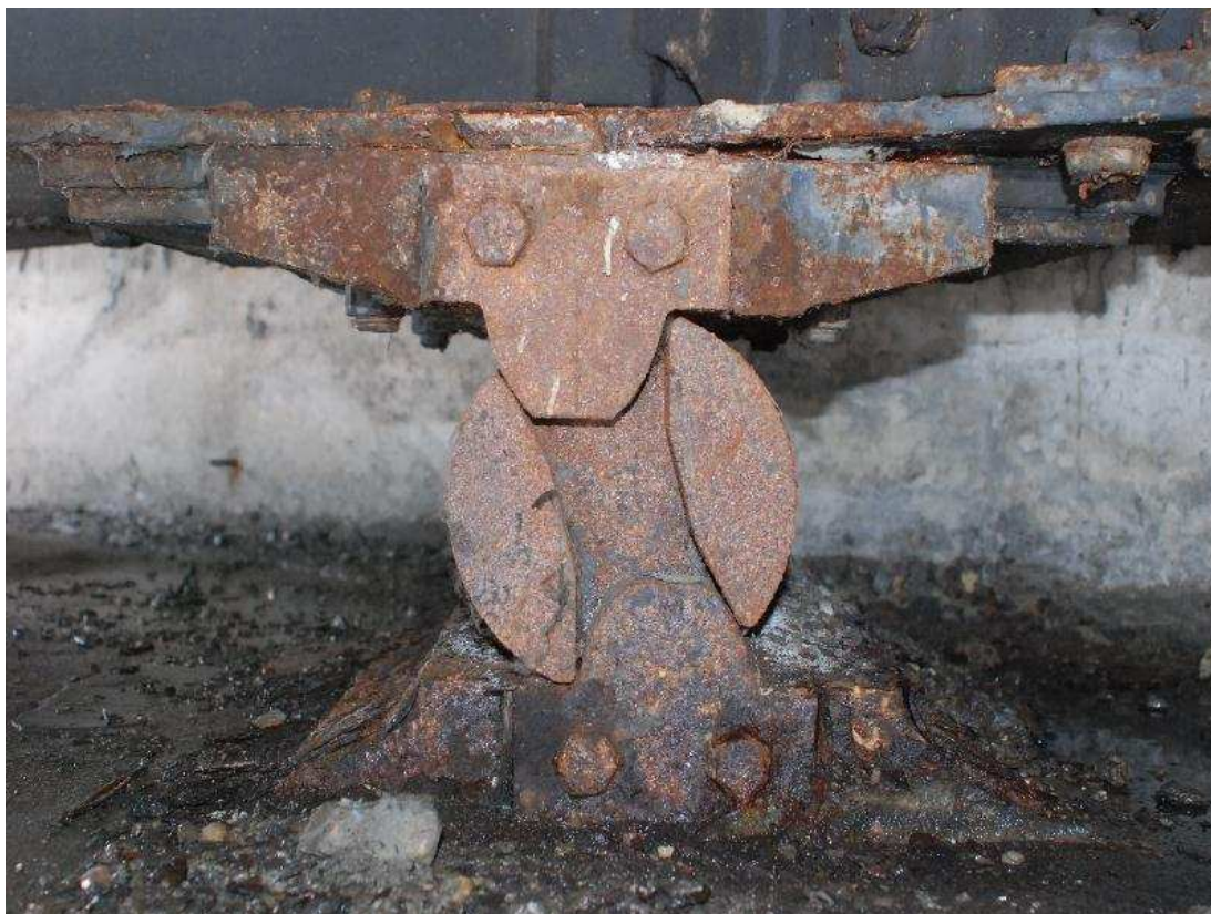
Photo n°5 : Appareil d'appui de P7A-P14A sur culée Est. Photo n°6 : Appareil d'appui de P13B sur culée Ouest
