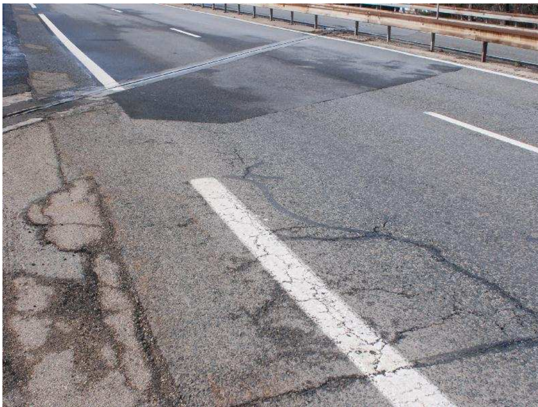
Photo 29 : Dégradation de la couche de roulement du tablier Sud à l'about Est. Photo 30 : Nid de poule en formation en bordure de la voie lente du tablier Nord.
