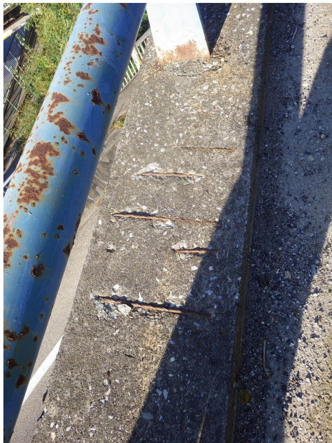
Photo 76 : Aciers apparents oxydés dus à un faible enrobage des éléments de corniches
