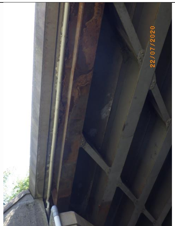
Localisation Désignation About de P1A Enrouillement
