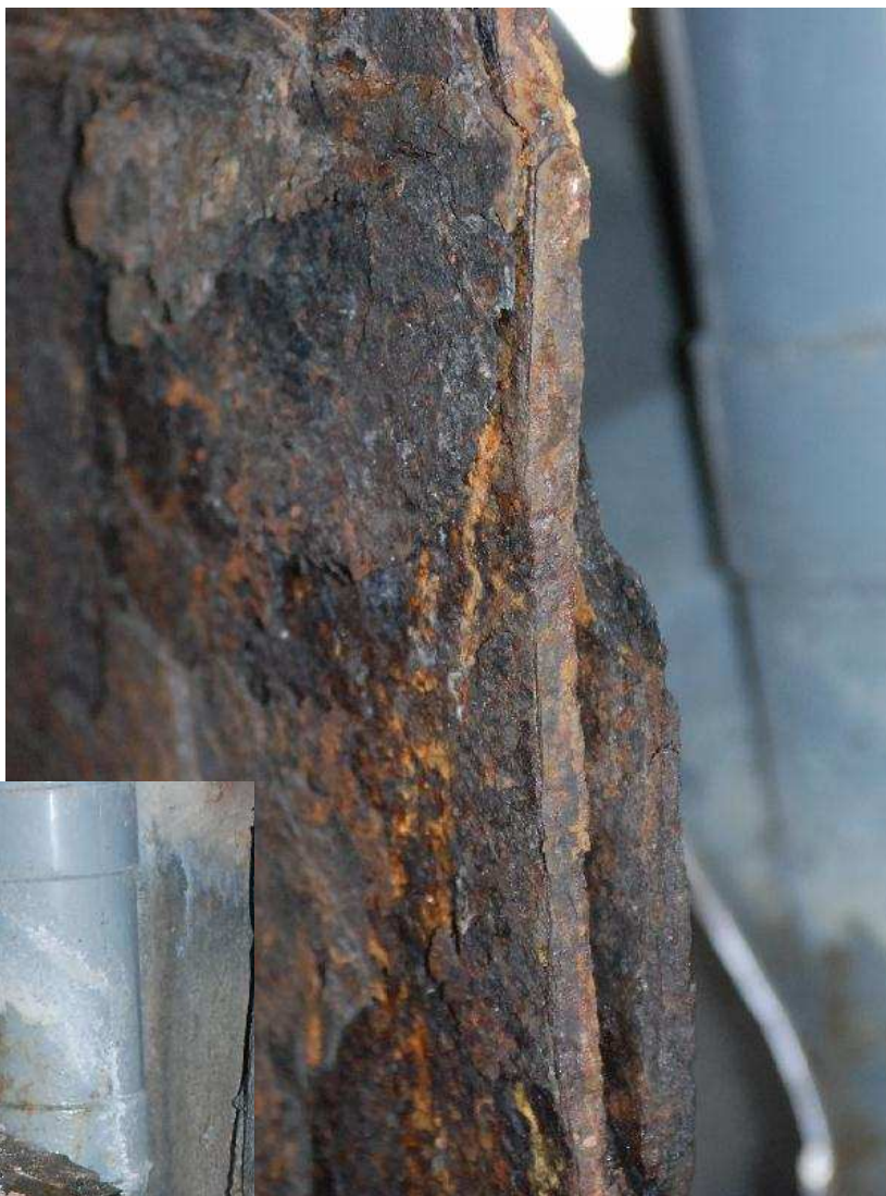
Photo n°15 : Détail de l'oxydation en about de l'âme de P1A.
