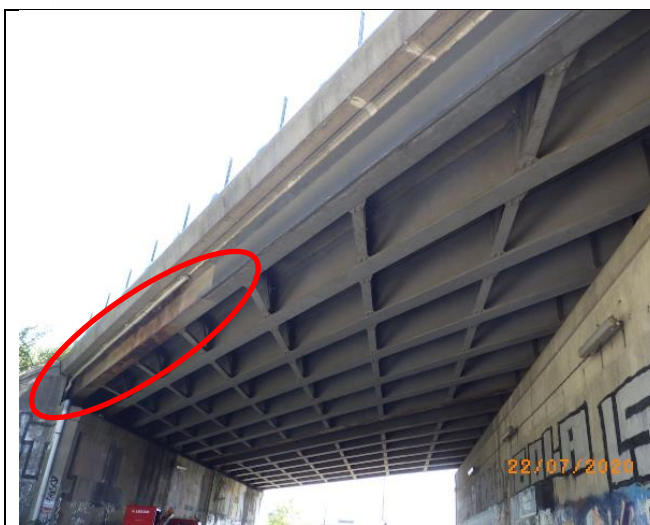
Localisation Désignation About de P1A Enrouillement
