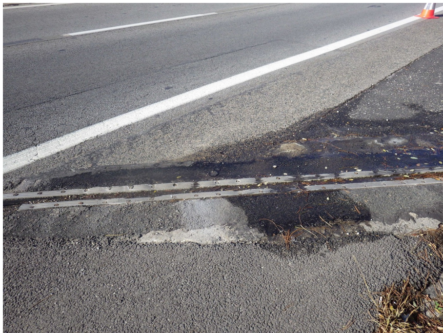
Photo 72 : Défaut de planéité sur BAU avec stagnation d'eau sur le joint de chaussée
