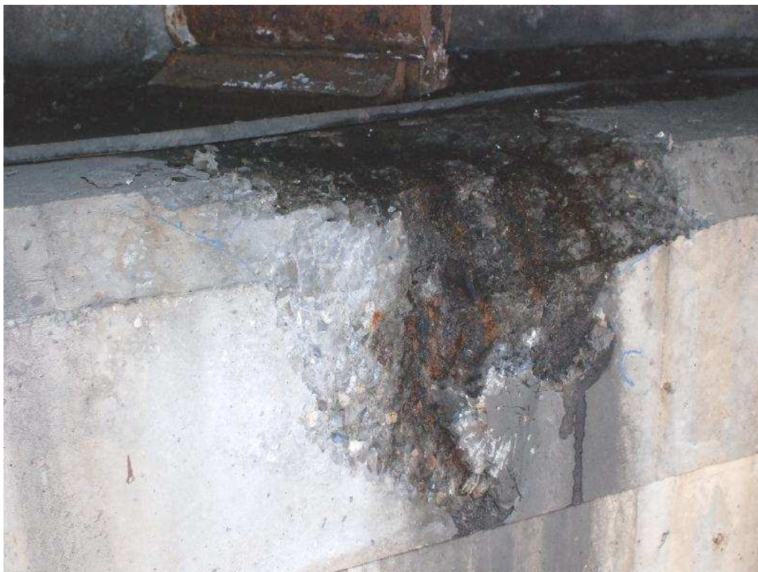
Photo n°9 : Eclat de béton sur culée Est après dégagement du béton instable.
