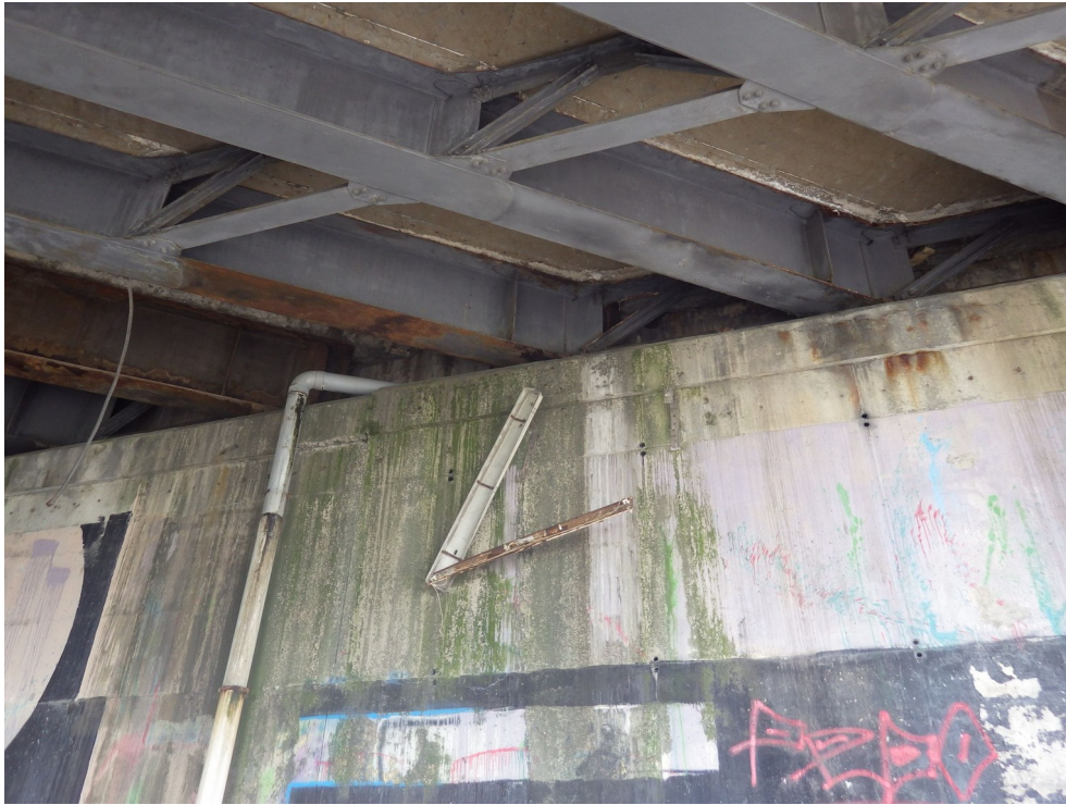
Photo 79 : Système d'éclairage cassé – Culée Est – C2
