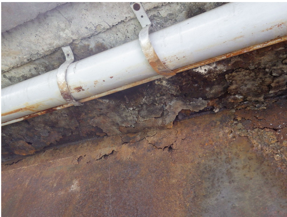
Photo 44 : Feuilletage localisé sur l'âme de la poutre P1A Tablier A (sens Grenoble Lyon)
