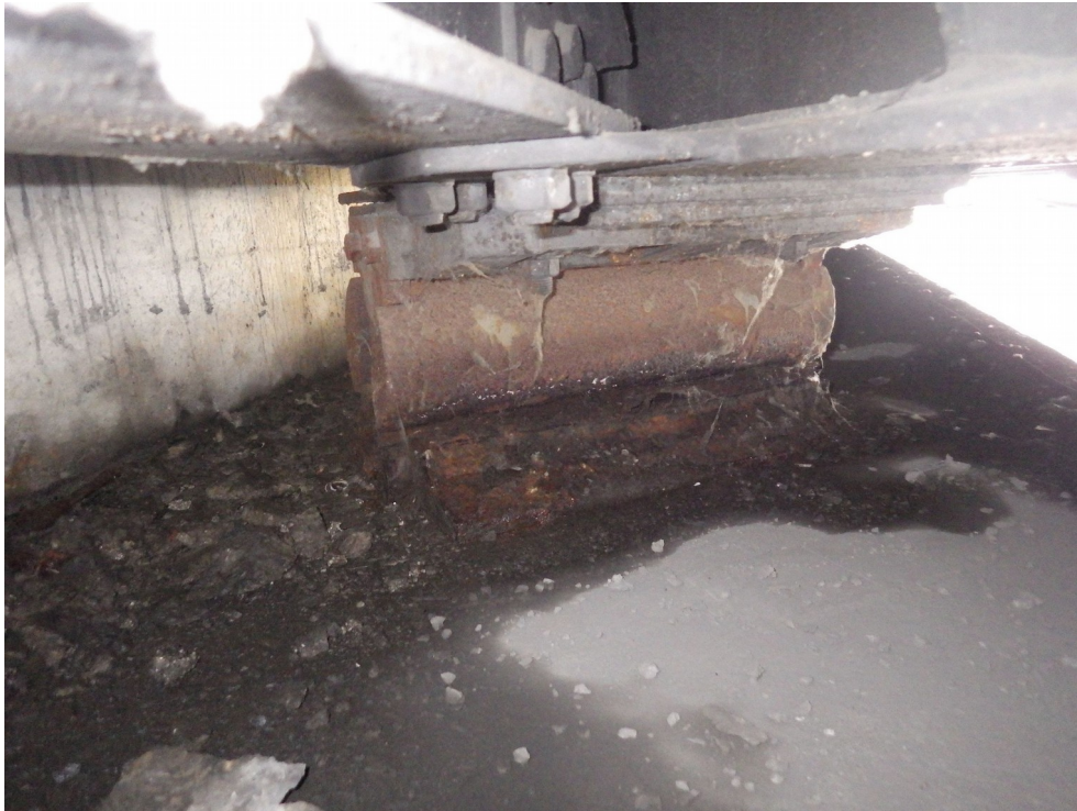
Photo 25 : Appareil d'appui P11B, platine inférieure corrodée, humidité présente Culée Ouest – C0 – Tablier B (sens Lyon Grenoble)
