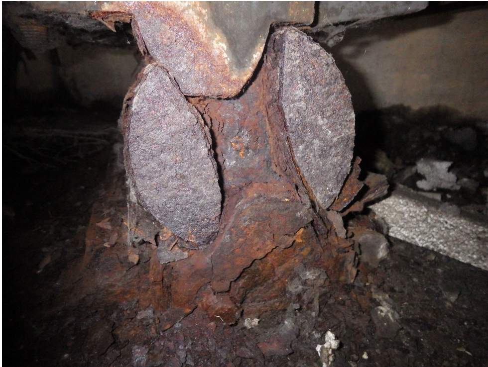
Photo 21 : Appareil d'appui P14A, dent inférieure corrodée Culée Ouest – C0 – Tablier A (sens Grenoble Lyon)
