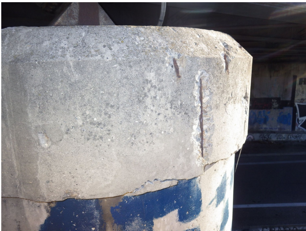
Photo 12 : Eclat avec acier apparent oxydé sur couronnement Pile P1 – about Sud
