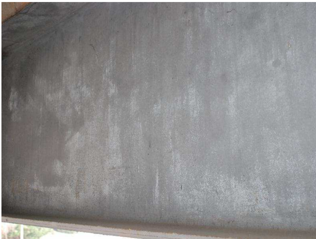
Photo n°23 : Aspect du système général en âme d'une poutre hors zones de ruissellements.
