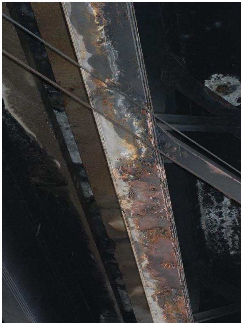
Photo n°21 : Destruction de protection anticorrosion dans les zones de ruissellements ; ici la sous-face d'une semelle de poutre.
