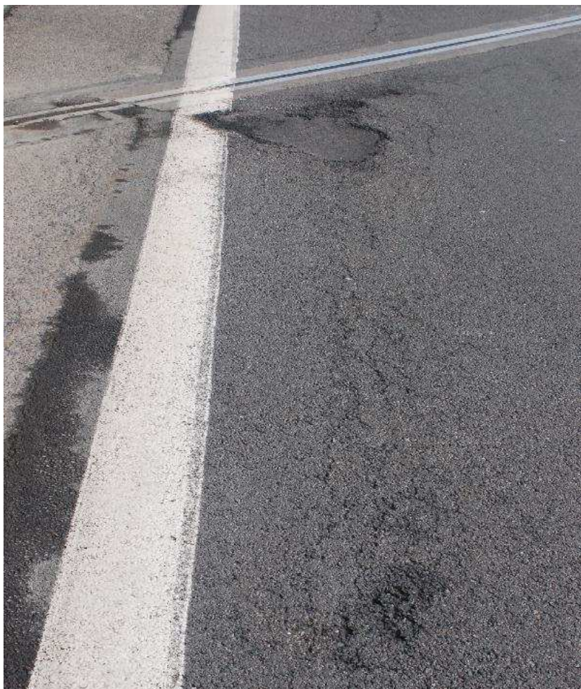
Photo 31 : Dégradation de la couche de roulement du tablier Nord près du joint Est.
