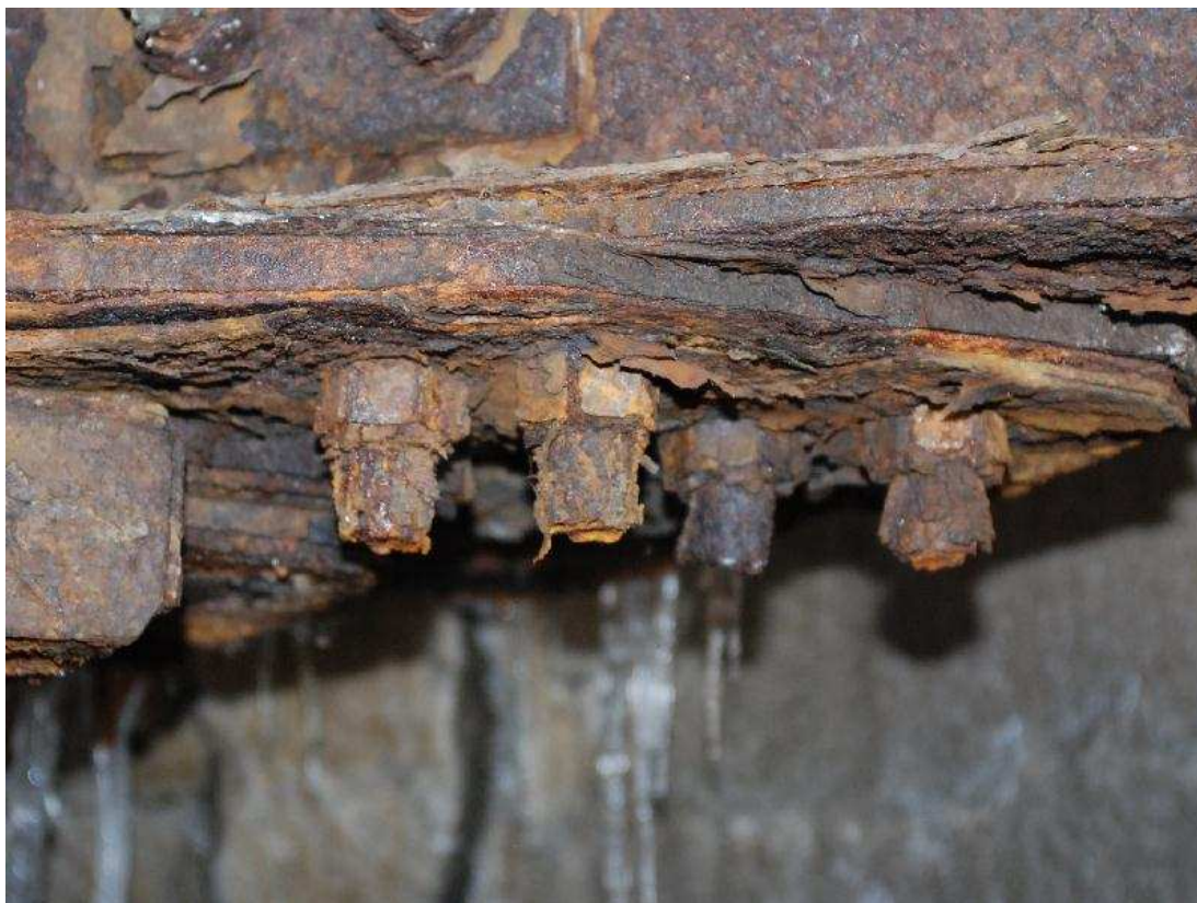
Photo n°17 : Détail de l'oxydation de la boulonnerie de liaison du mouchoir entre poutre P1A et entretoise.
