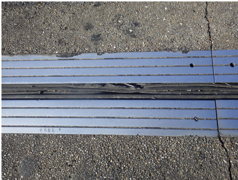
Photo 65 : Bande élastomère du joint déclipsée – Tablier A
