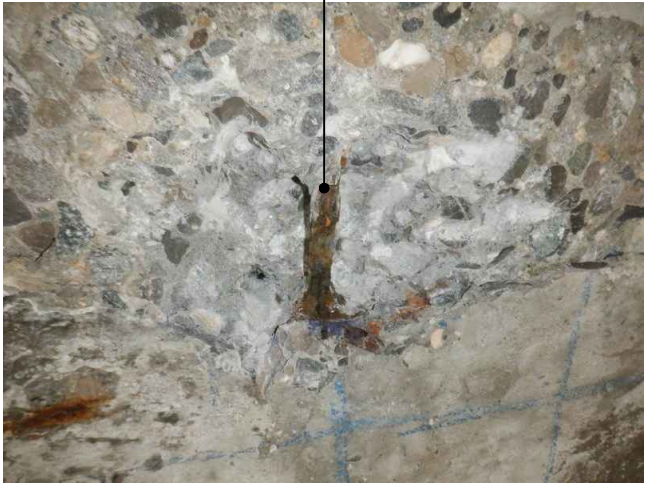
- Photographie du sondage destructif sur le tablier Grenoble -
