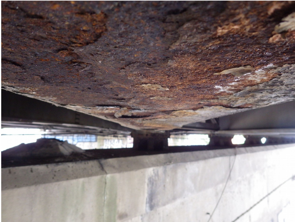
Photo 45 : Feuilletage localisé en sous-face sur poutre P7A Tablier A (sens Grenoble Lyon)
