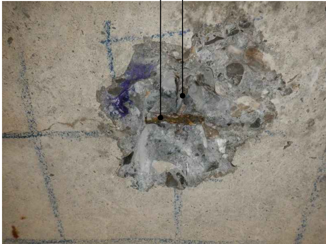
- Photographie du sondage destructif sur le tablier Lyon -
