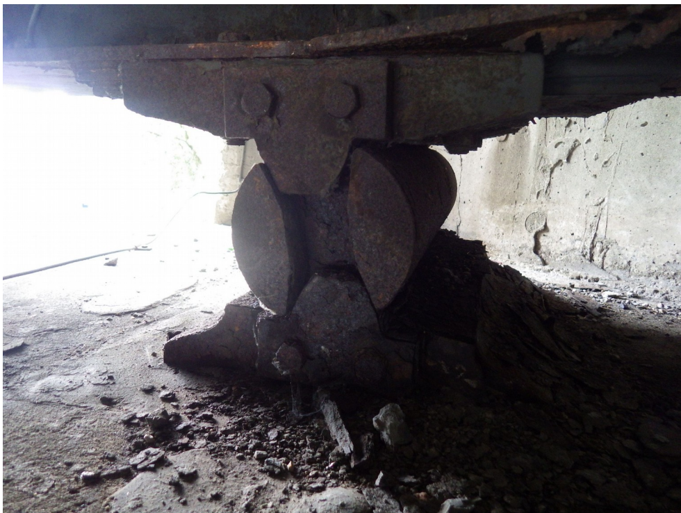
Photo 26 : Appareil d'appui P14B, platine inférieure corrodée Culée Ouest – C0 – Tablier B (sens Lyon Grenoble)
