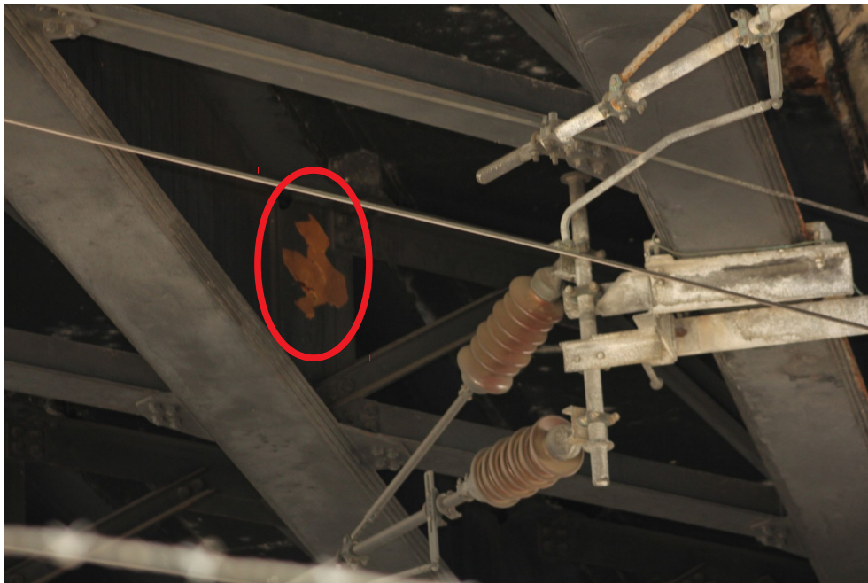
Photo 50 : Ecaillage local de la protection anti-corrosion Tablier A (sens Grenoble Lyon)
