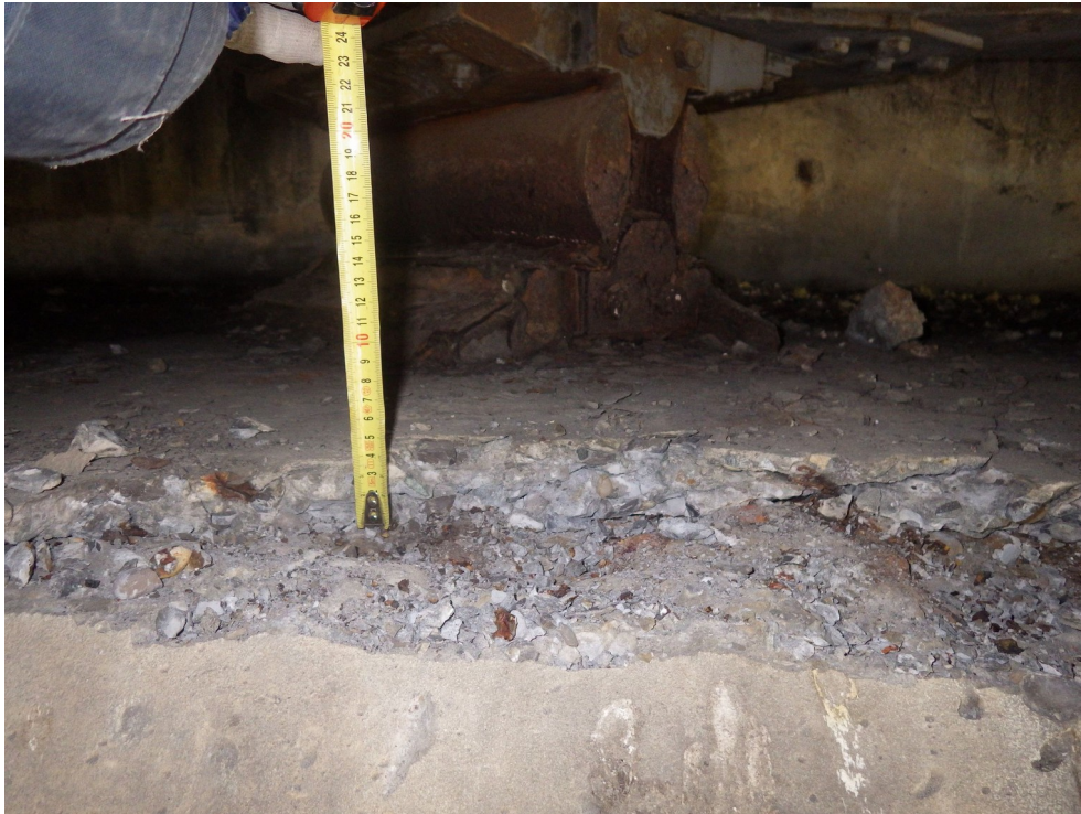
Photo 3 : Eclats sur sommier sur 4 cm de profondeur Culée Est – C2– Tablier A (sens Grenoble Lyon) – poutre P5A
