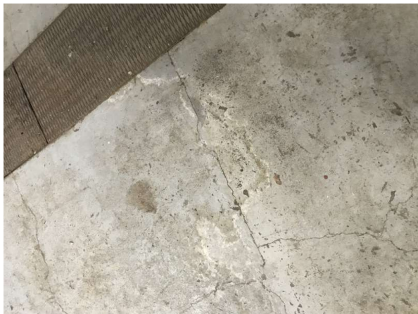
Prélèvement - P1 : CHAUFFERIE - Peinture sur béton- (Absence d'amiante)
