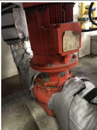
Prélèvement - P11 : CHAUFFERIE - Joint de bride- (Absence d'amiante)
