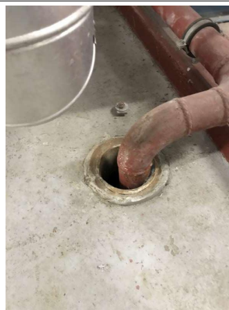
Prélèvement - P12 : CHAUFFERIE - Conduit- (Présence d'amiante)
