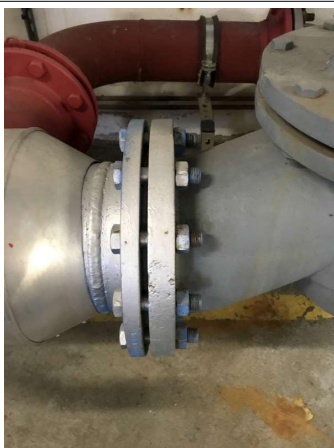
Prélèvement - P15 : CHAUFFERIE - Joint de bride- (Absence d'amiante)
