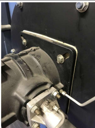
Prélèvement - P7 : CHAUFFERIE - Joint- (Absence d'amiante)
