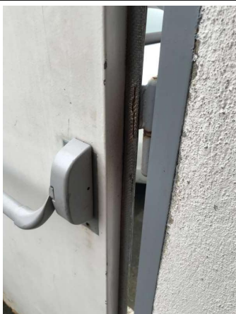
Prélèvement - P9 : CHAUFFERIE - Joint coupe-feu- (Absence d'amiante)
