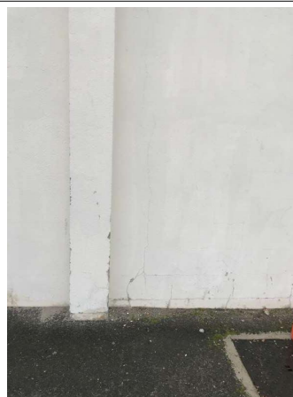
Prélèvement - P16 : CHAUFFERIE - Peinture sur béton- (Absence d'amiante)
