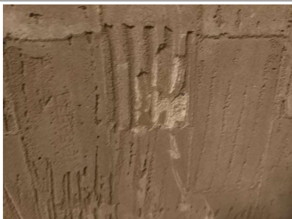
Prélèvement - P01 : R+5 / Cage d'escalier - Colle de carrelage- (Présence d'amiante)
