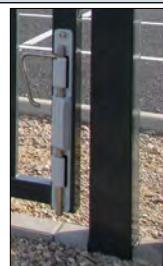
Verrouillage bas anti soulèvement
