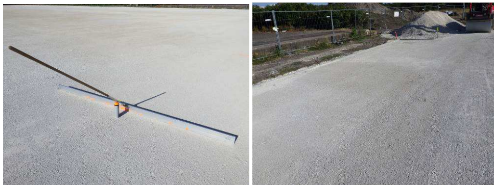
Vue sur règle de 3 m – Vue sur reprise d'un défaut
