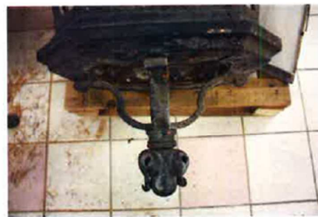
Feuillages et éléments en fer forgé : zone de rouille, Peinture dégradée, cuivre apparent
