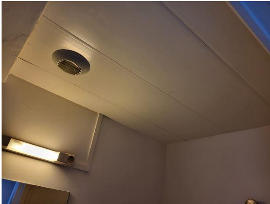
Salles de bains R+4; Faux-plafond lambris PVC non démontable
