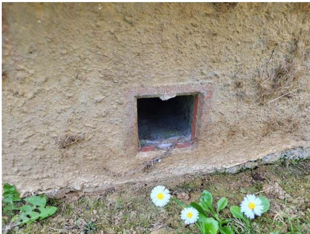
Vides sanitaires: bouche d'aération en terre cuite
