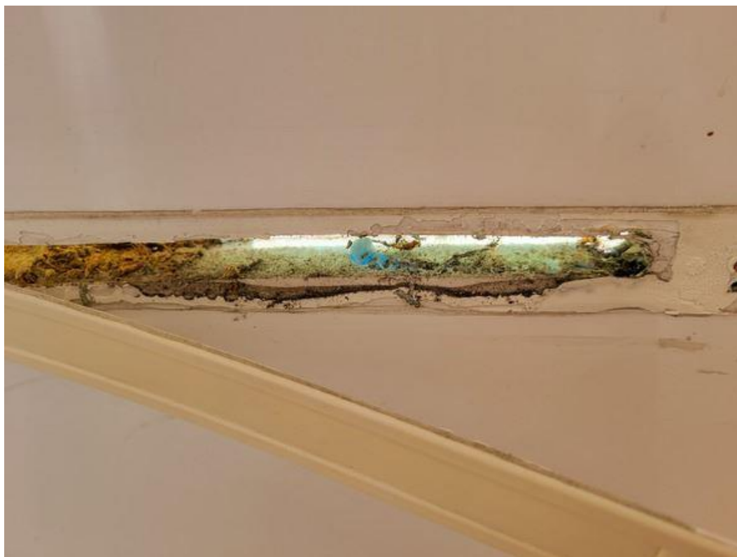
Sanitaires: Sondage dans les allèges PVC
