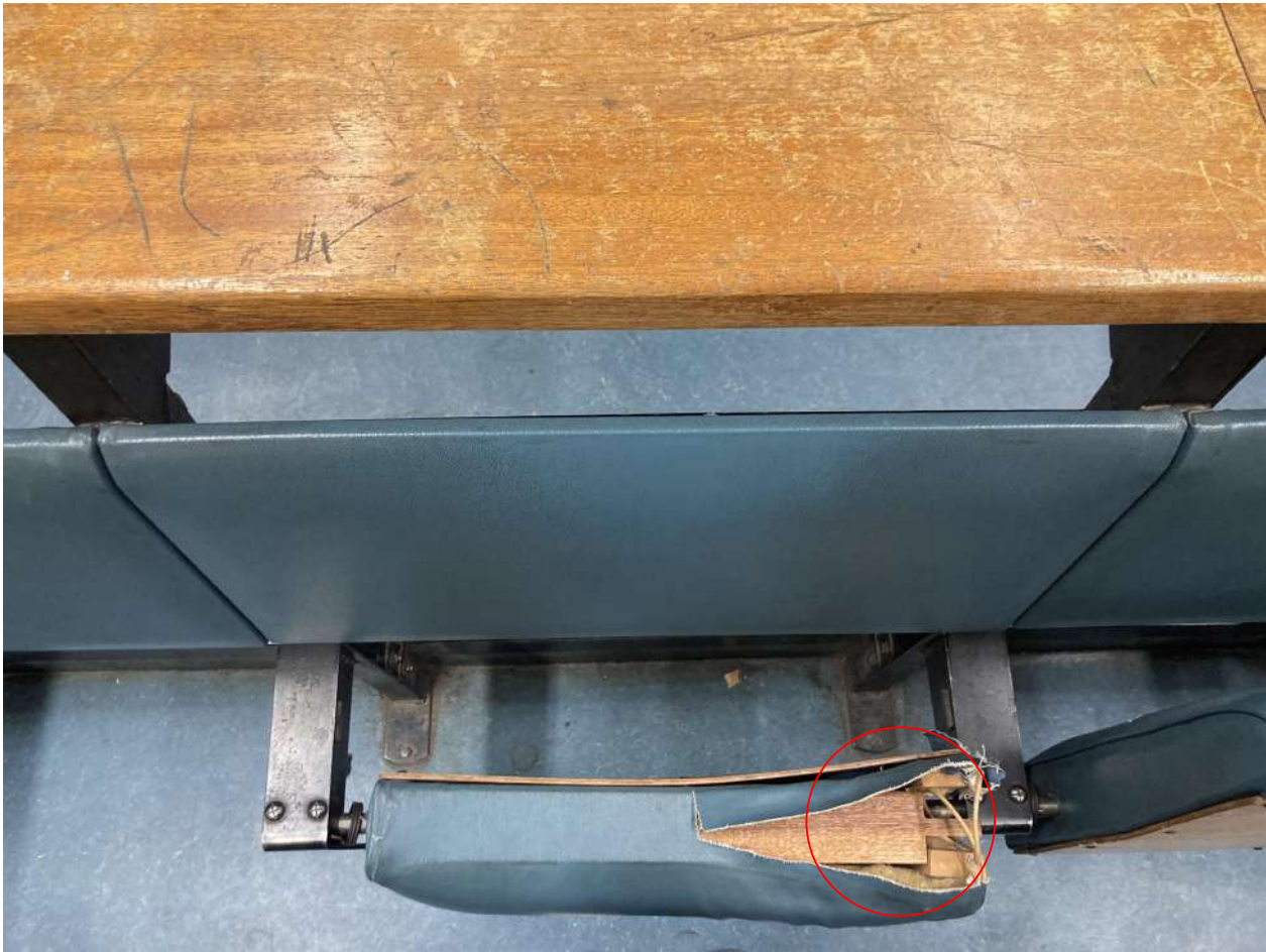
Assises déchirées/détériorées
