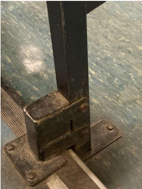
Système de fixation de l'ossature métallique
