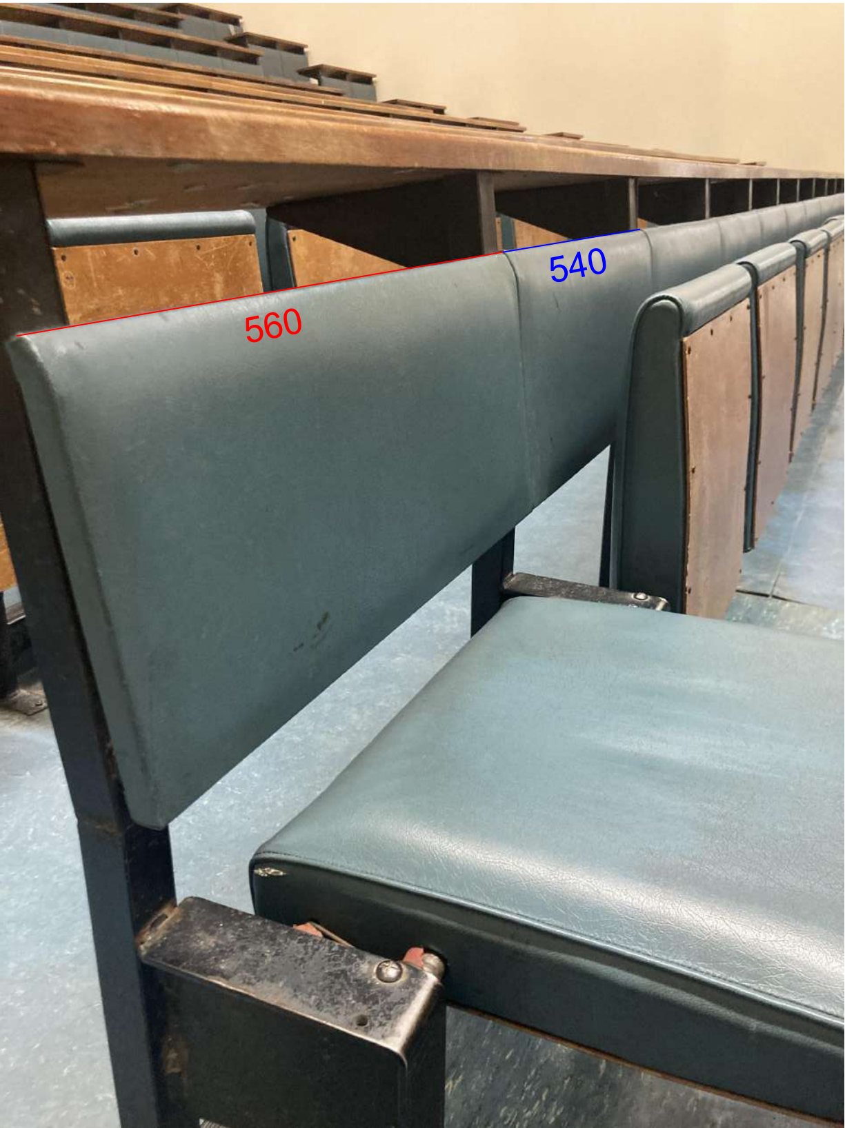
Différences de largeurs de dossiers entre ceux aux extrémités et en milieu de rangée
