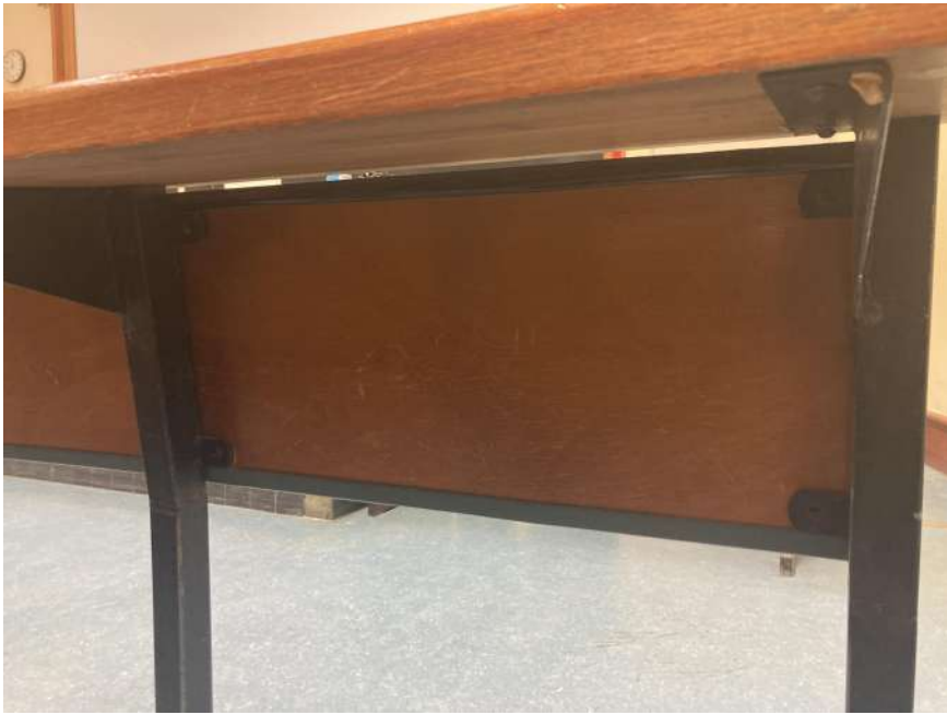
Système de fixation des dossiers et tablettes sur ossature métallique
