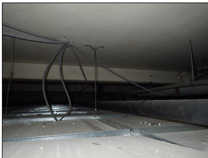
Vue de dessous du PH-R+3 – Absence d'encoffrement de la poutre métallique
