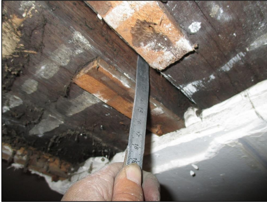
Photo N°1 : Fente longitudinale importante en sous-face de la Poutre chêne N°1 - Travée 1/2
