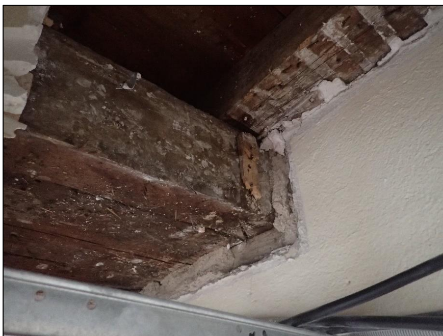
Photo N°3 : Appui poutre principale
