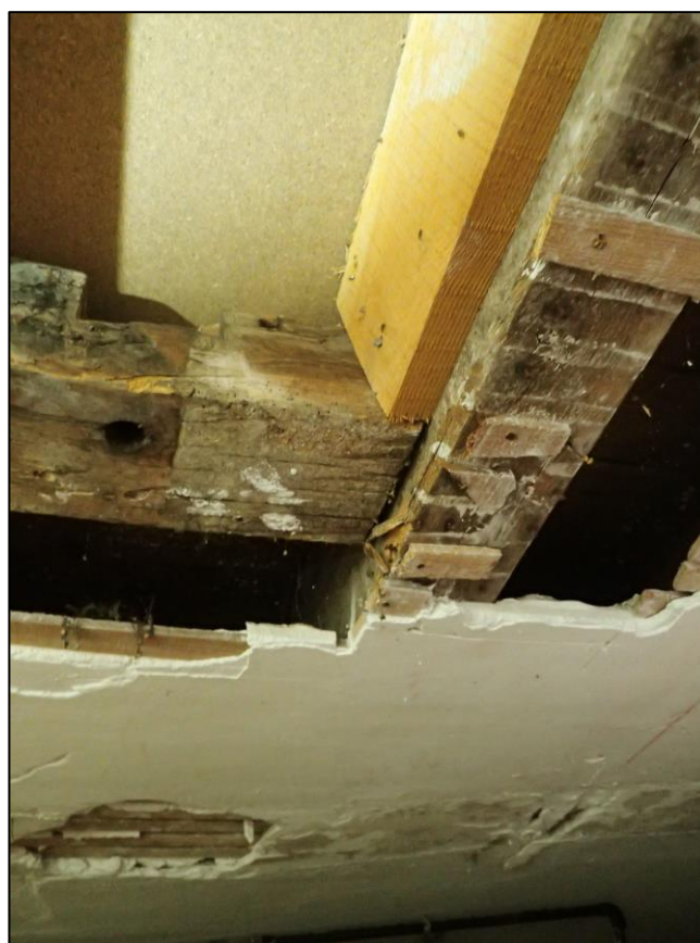
Photo N°2 : Entaille sur le chevron – Assemblage chevron / Enchevêtrement
