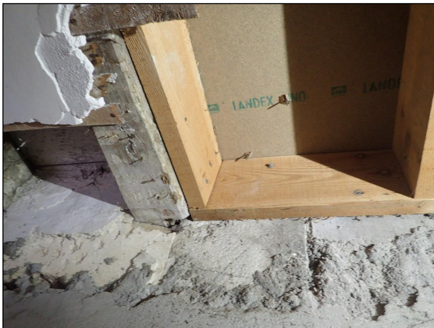
Photo N°1 : Entaille a l'appui de la solive d'enchevêtrement
