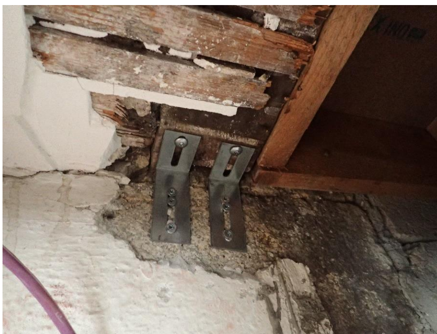
PH-R+1 : Appui solive d'enchevêtre avec mesures conservatoires
