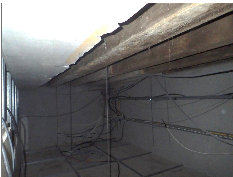
Vue de dessous du PH RDC - Sondage n°3 – Absence de latis plâtre au niveau du couloir
