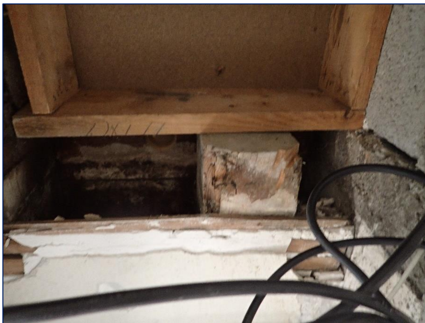
Photo N°7 : Assemblage solive boiteuse / chevêtre résineux
