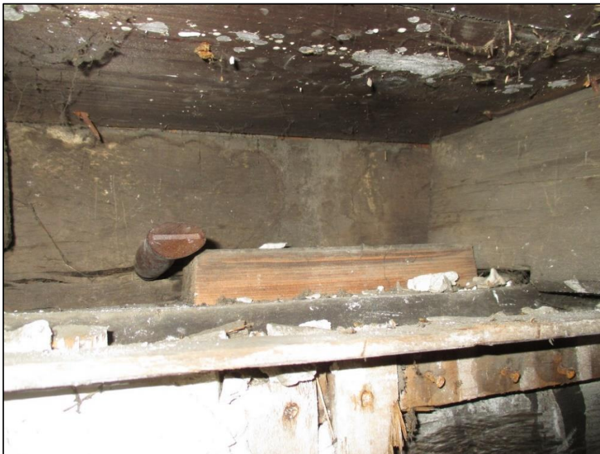
Photo N°2 : Fente latérale sur la Poutre chêne N°1 - Travée 1/2
