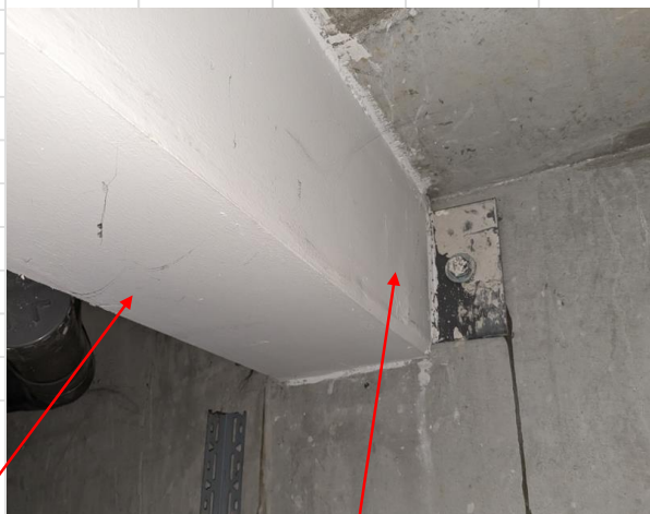
Poutre métallique chevillée sur voile béton
