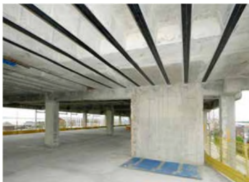
Figure 12: Exemple de plats carbone sous dalle
