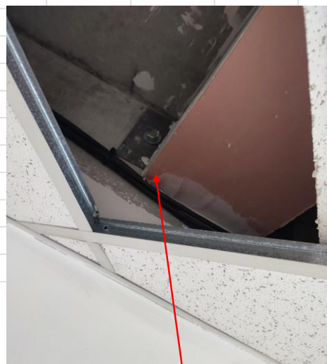
Poutre métallique chevillée sur voile béton
