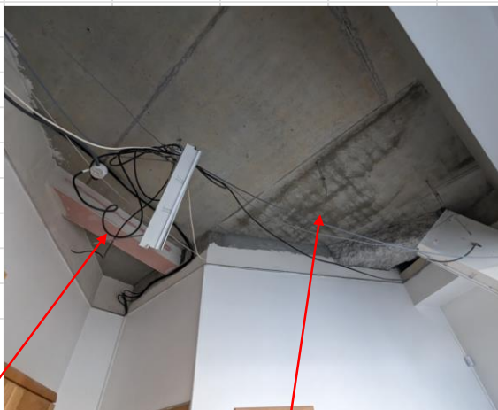
Dalle coulée en place avec spectre de ferrailage
