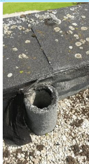
Matériaux : ZPSO-015 Description : Conduit en Fibrociment Localisation : Toiture Salle Conférence Présence d'Amiante (Suivant documentation consultée) Rapport N° 12000/15/3337 du 12/05/2015
