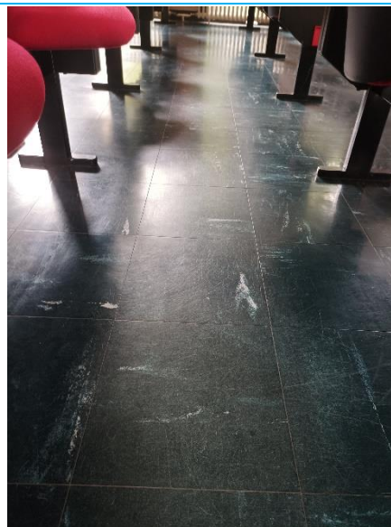
Matériaux : ZPSO-007 Prélèvement : P001 Description : Dalle de sol Vert Foncé + Colle Bitumineuse Localisation : RDC - Salle Conférence et Salle Patio Absence d'amiante (Suivant documentation consultée) Rapport N° 2112CGEDIBC1019542 du 13/01/2022
