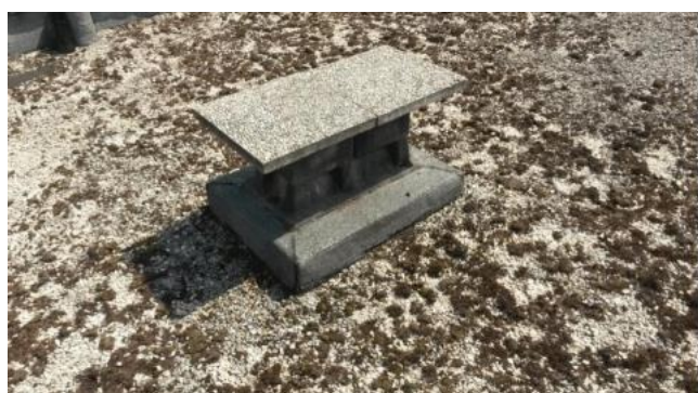
Matériaux : ZPSO-014 Description : Conduit en Fibrociment Localisation : Toiture Salle Conférence Présence d'Amiante (Suivant documentation consultée) Rapport N° 12000/15/3337 du 12/05/2015
