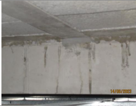
SALLE DE CONSULTATION Photo n°5 Vue du plancher haut poutre et poutrelle-hourdis, investigation n°5
