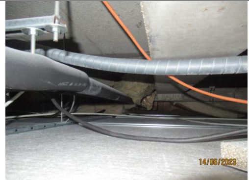
SALLE DE SOIN Photo n°6 Vue du plancher haut poutre et poutrelle-hourdis, investigation n°7
