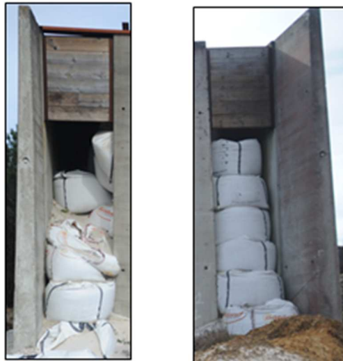
Figure 6 : obturation des vides du réceptacle à gauche et à droite de l'axe du réceptacle
