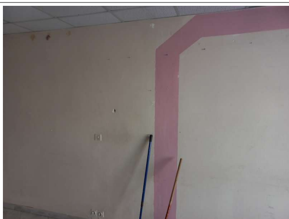
Prélèvement - P039 : Bâtiment le Saint Henri / Rez-de-chaussée Gauche / Local 2 - Enduit- (Absence d'amiante)
