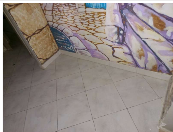
Prélèvement - P016 : Bâtiment le Saint Henri / Rez-de-chaussée droit / Dégagement - Colle de plinthe- (Absence d'amiante)
