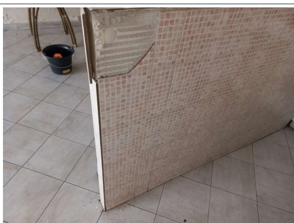
Prélèvement - P041 : Bâtiment le Saint Henri / Rez-de-chaussée Gauche / Local 2 - Colle de faïence- (Absence d'amiante)
