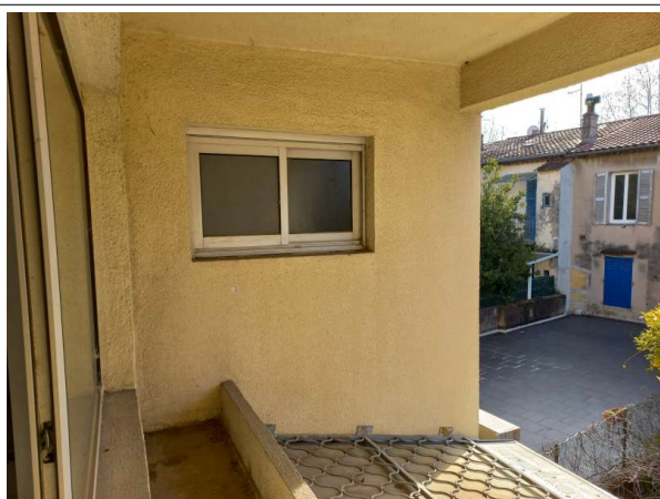
Prélèvement - P063 : Bâtiment le Saint Henri / 1er étage / Façades cuisine - Enduit- (Absence d'amiante)
