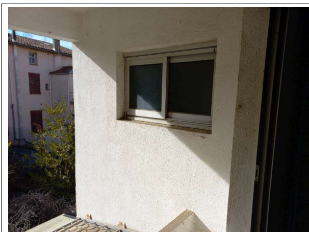
Prélèvement - P051 : Bâtiment le Saint Henri / 1er étage / Façades bureau 7 - Enduit- (Absence d'amiante)
