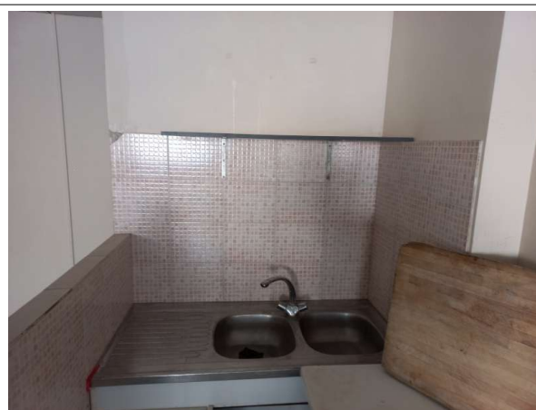
Prélèvement - P040 : Bâtiment le Saint Henri / Rez-de-chaussée Gauche / Local 2 - Colle de faïence- (Absence d'amiante)
