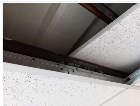
Déclaré - : Bâtiment le Saint Henri / Rez-de-chaussée Gauche / Local 2 - Calorifugeage- (Absence d'amiante)
