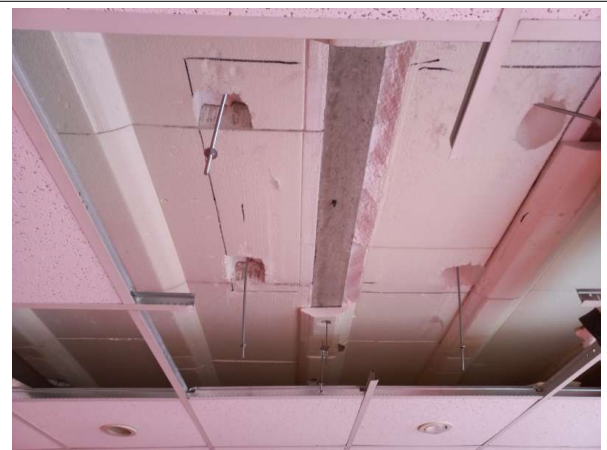
Prélèvement - P010 : Bâtiment le Saint Henri / Rez-de-chaussée droit / Local 1 - Enduit- (Absence d'amiante)
