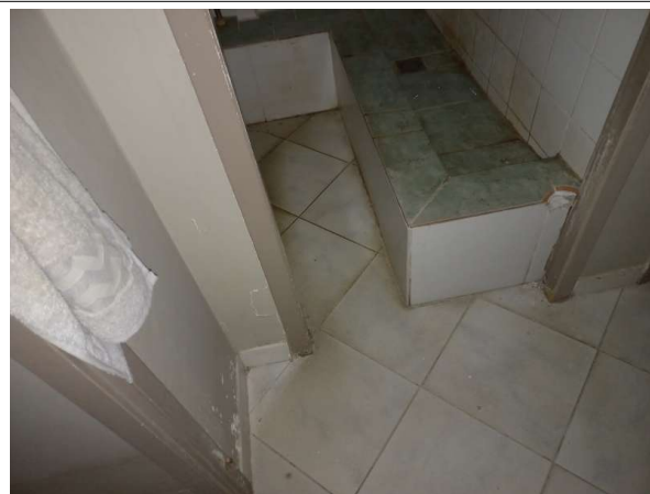
Prélèvement - P020 : Bâtiment le Saint Henri / Rez-de-chaussée droit / Sanitaire / Pédiluve - Colle de faïence- (Absence d'amiante)
