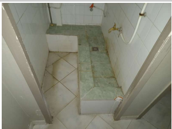
Prélèvement - P021 : Bâtiment le Saint Henri / Rez-de-chaussée droit / Sanitaire / Pédiluve - Colle de faïence- (Absence d'amiante)
