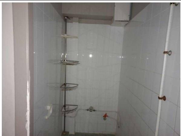
Prélèvement - P019 : Bâtiment le Saint Henri / Rez-de-chaussée droit / Sanitaire / Pédiluve - Colle de faïence- (Absence d'amiante)
