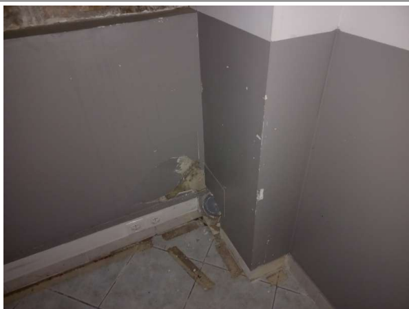
Prélèvement - P031 : Bâtiment le Saint Henri / Rez-de-chaussée droit / Bureau 4 - Plaque- (Absence d'amiante)
