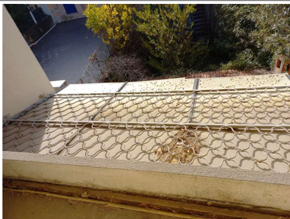
Prélèvement - P065 : Bâtiment le Saint Henri / 1er étage / Façades cuisine - Mastic- (Présence d'amiante)
