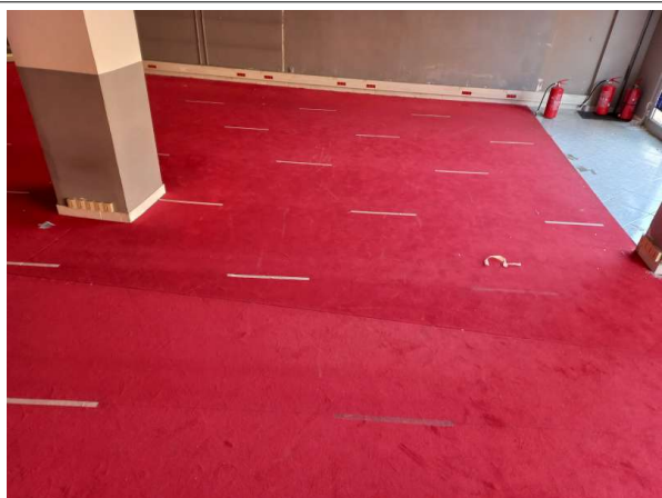
Prélèvement - P001 : Bâtiment le Saint Henri / Rez-de-chaussée droit / Local 1 - Moquette avec sous couche- (Absence d'amiante)
