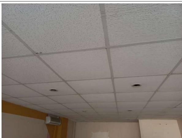
Déclaré - : Bâtiment le Saint Henri / Rez-de-chaussée Gauche / Local 2 - Faux plafond- (Absence d'amiante)
