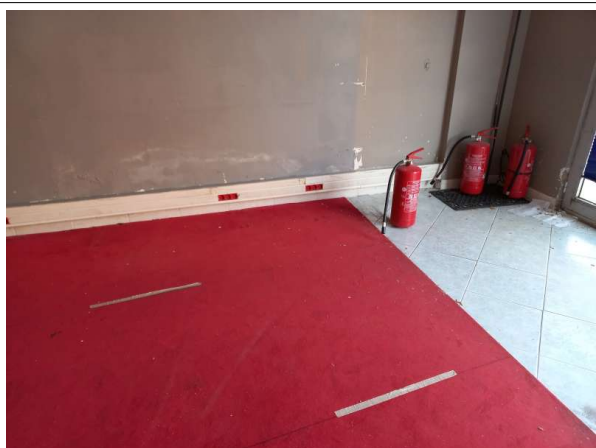
Prélèvement - P003 : Bâtiment le Saint Henri / Rez-de-chaussée droit / Local 1 - Colle de plinthe- (Absence d'amiante)
