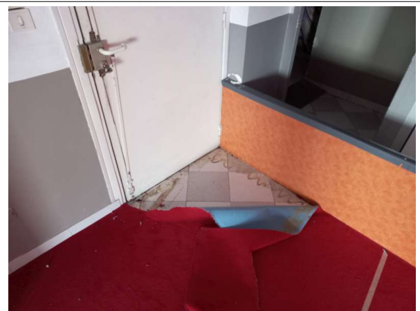
Prélèvement - P012 : Bâtiment le Saint Henri / Rez-de-chaussée droit / Local 1 - Chape maigre- (Absence d'amiante)
