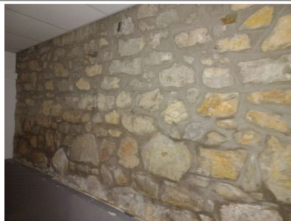
Prélèvement - P032 : Bâtiment le Saint Henri / Rez-de-chaussée droit / Bureau 4 - Joint d'assemblage- (Absence d'amiante)
