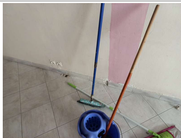
Prélèvement - P038 : Bâtiment le Saint Henri / Rez-de-chaussée Gauche / Local 2 - Colle de plinthe- (Absence d'amiante)
