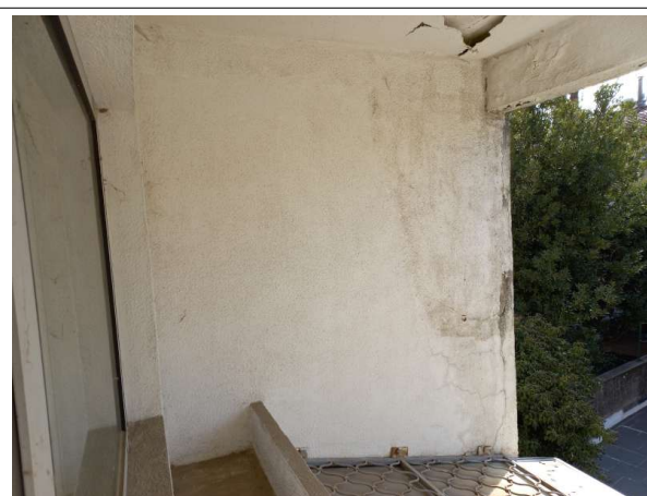
Prélèvement - P050 : Bâtiment le Saint Henri / 1er étage / Façades bureau 7 - Enduit- (Absence d'amiante)
