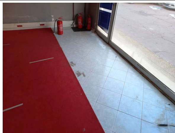
Prélèvement - P002 : Bâtiment le Saint Henri / Rez-de-chaussée droit / Local 1 - Chape maigre- (Absence d'amiante)
