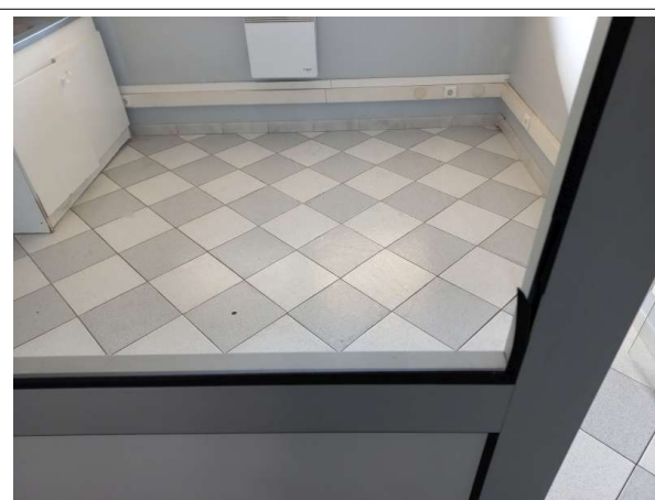
Prélèvement - P059 : Bâtiment le Saint Henri / 1er étage / Cuisine - Mastic- (Absence d'amiante)
